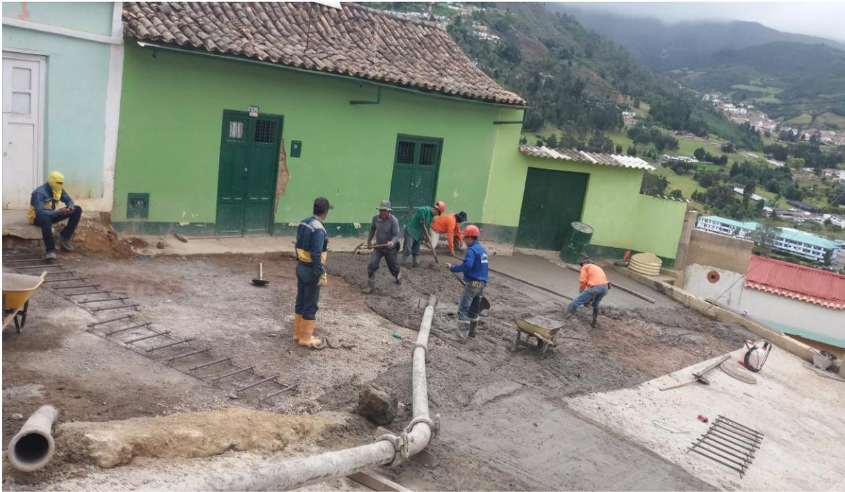
*Imagen 46. Reposicion de pavimento en concreto hidraulico.*
