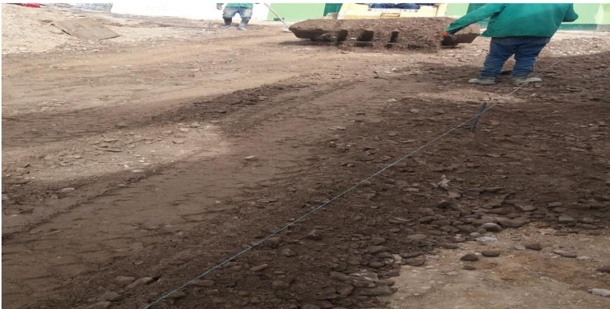
**Imagen 43.** *Relleno con material de sub-base.*
