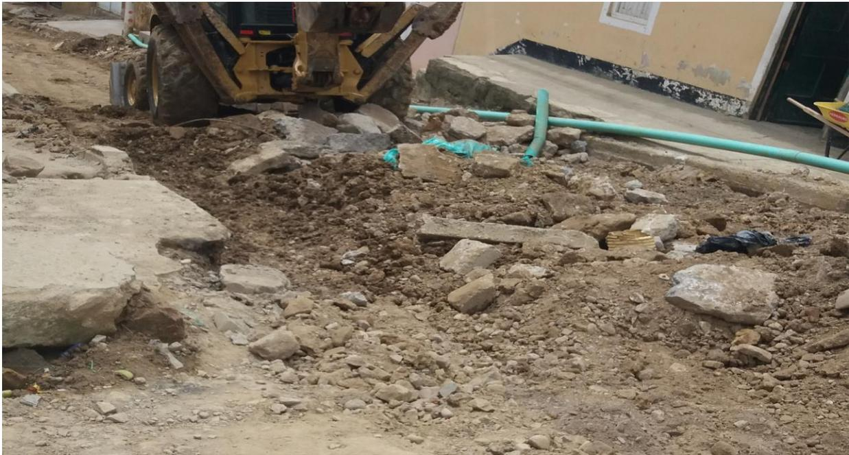
*Imagen 38. Demolicion de pavimento en concreto.*
