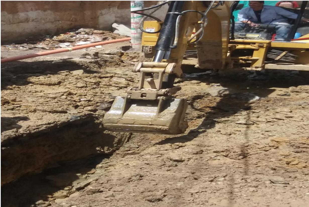
**Imagen 42.** *Excavacion mecanica en suelo sin clasificar.*
