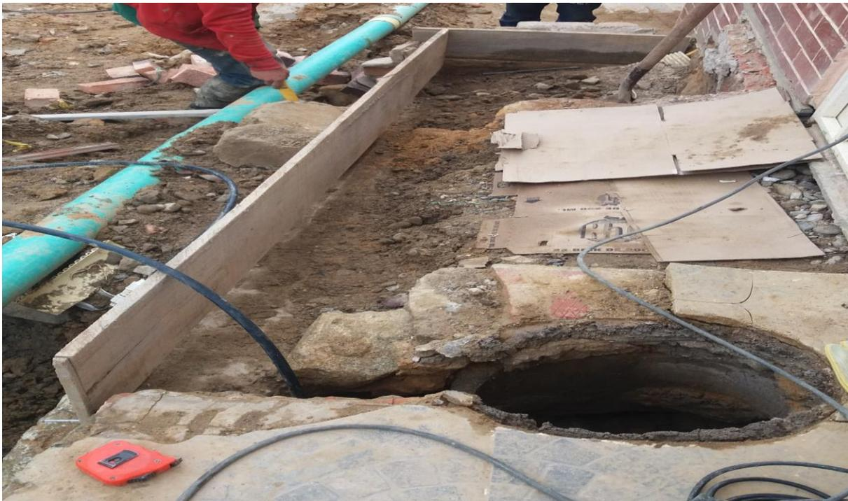
*Imagen 51. Reposicion de anten en concreto.*
