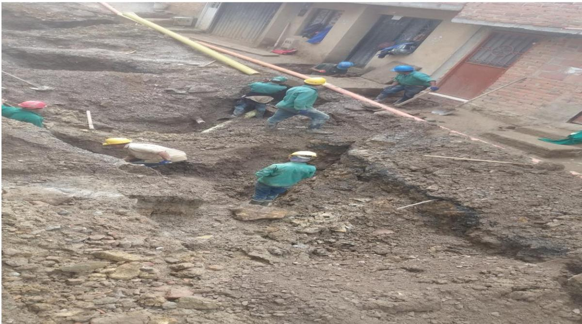
*Imagen 41. Excavacion manual en suelo sin clasificar.*
