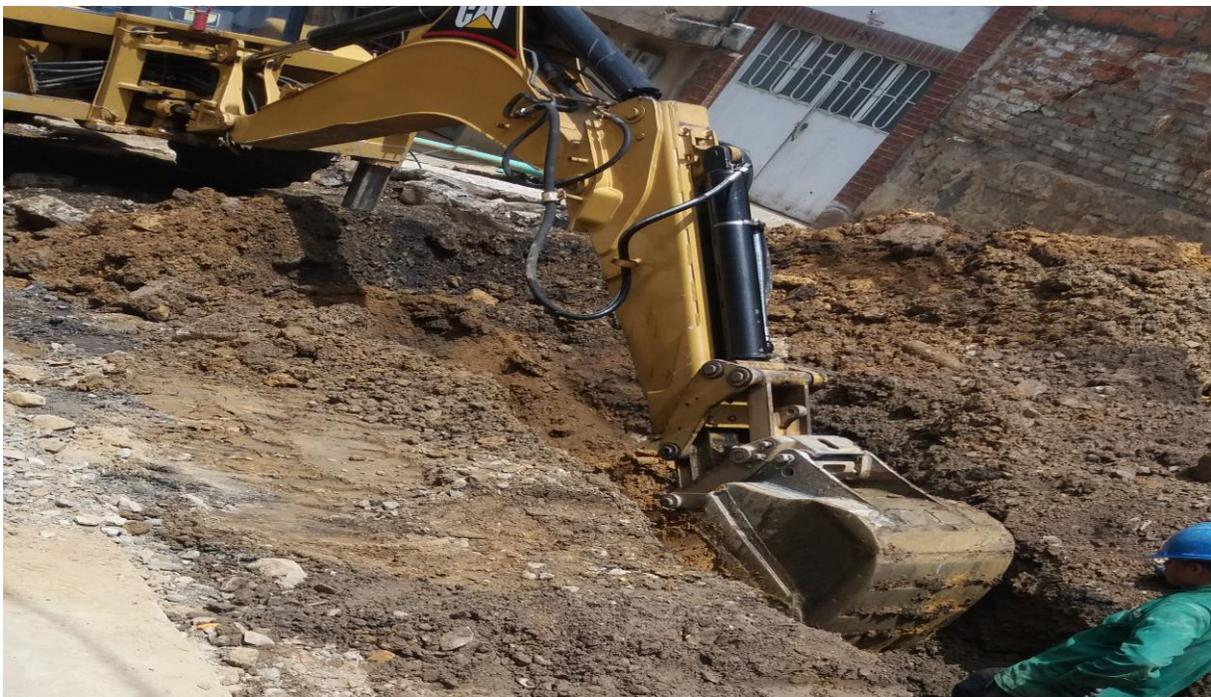
*Imagen 37. Demolicion y retiro de tuberia de gres existente.*
