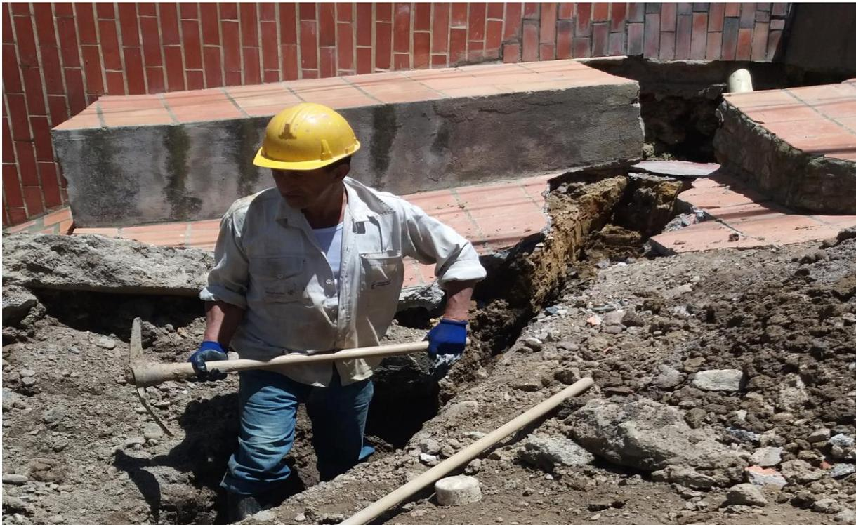
*Imagen 39. Excavacion para tuberia domiciliar y cajas de inspeccion.*
