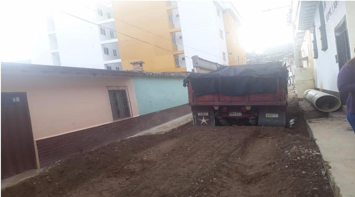
*Imagen 48. Transporte de material de sub-base.*
