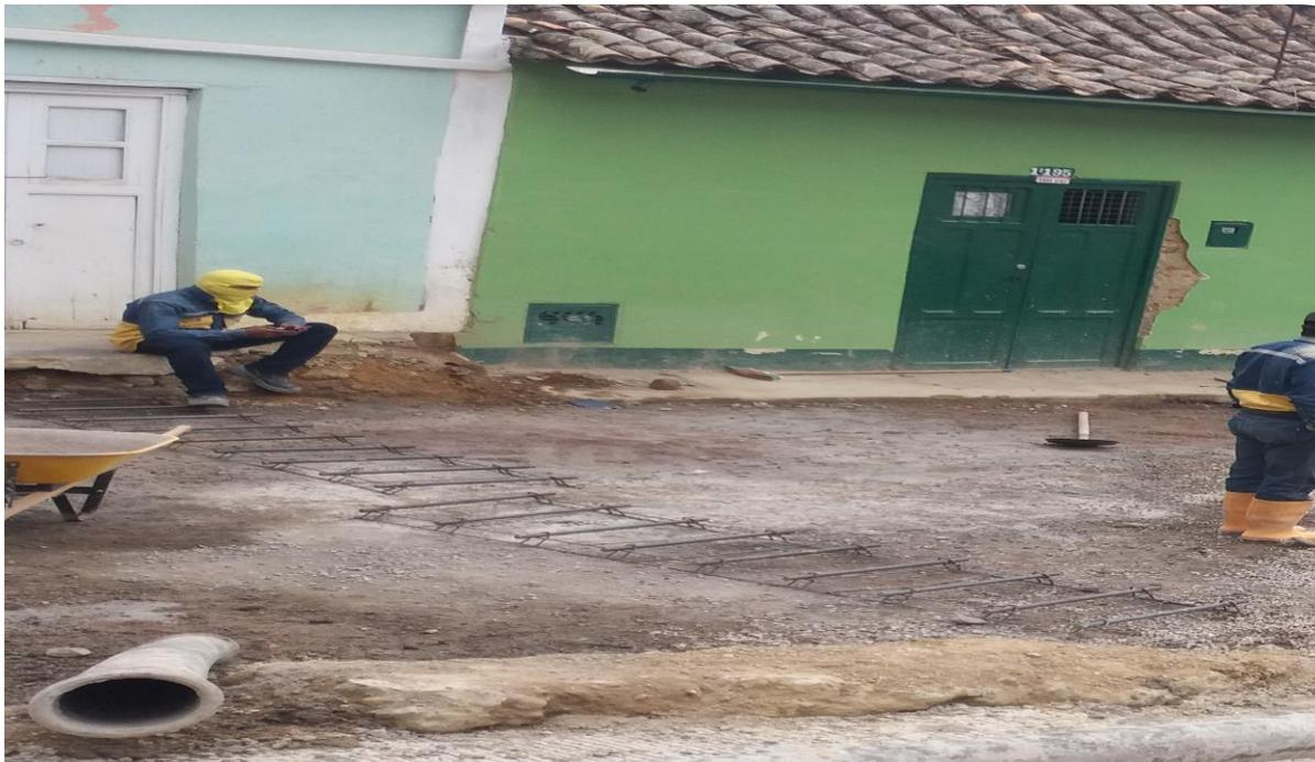
*Imagen 47. Instalacion de barras para juntas, incluye canastillade apoyo de dovelas.*
