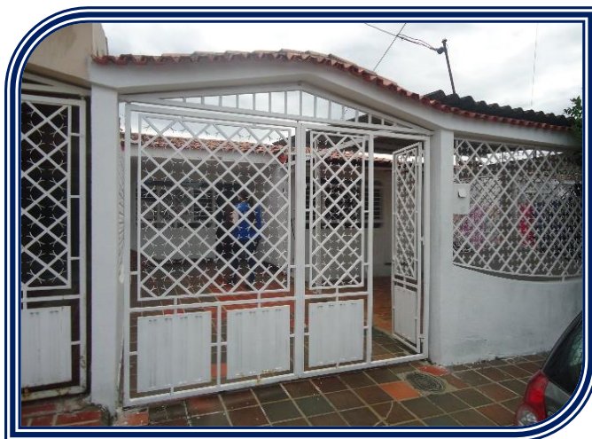
Figura 32. Edificación ubicada fuera del alcance del movimiento en masa.
