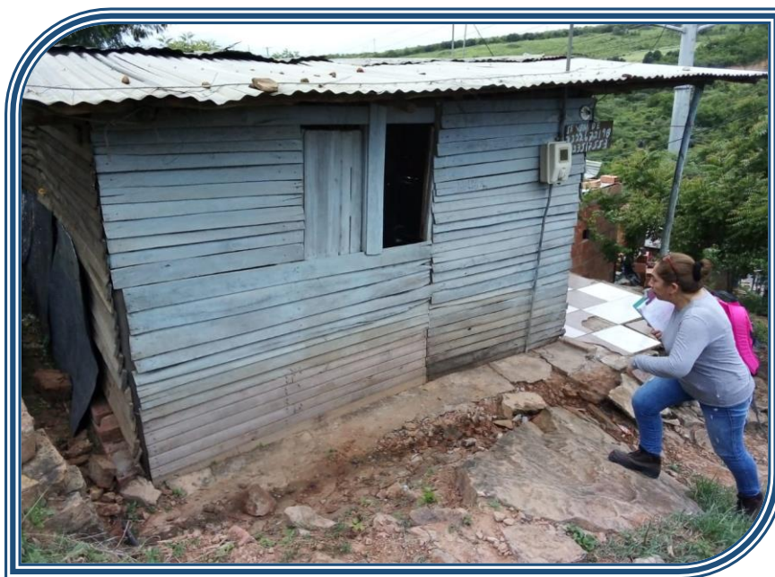
Figura 40. Hongos en muro de fachada.
