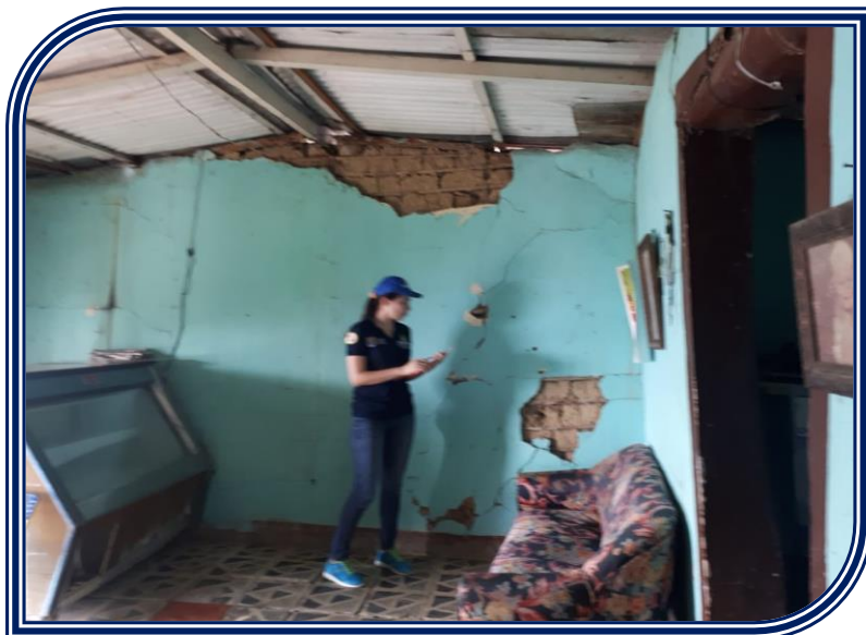
Figura 16. Edificación en bahareque.
