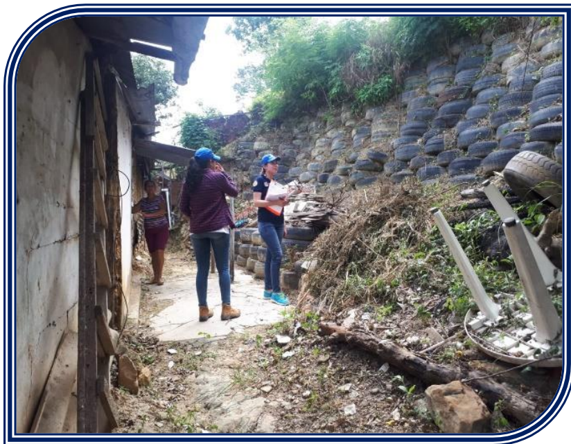
Figura 33. Talud inestable estabilizado con neumáticos.
