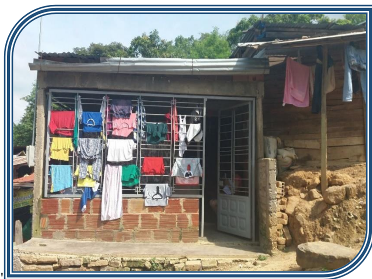
Figura 45. Edificación tipo del barrio Virgilio Barco.
