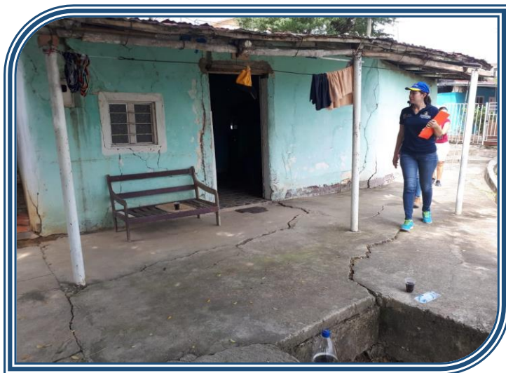
Figura 41. Edificación grietada.
