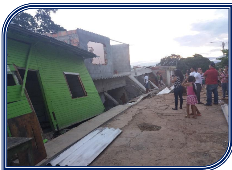
Figura 20. Edificaciones colapsadas en el Barrio Brisas del Aeropuerto-Cúcuta.
