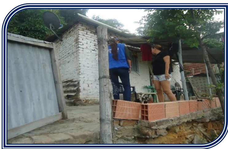
Figura 28. Edificación ubicada sobre zona inestable.
