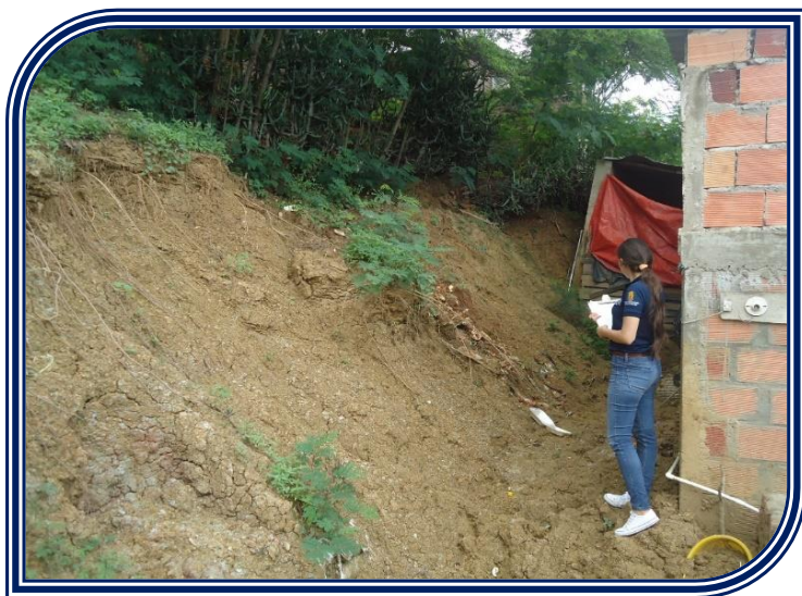
Figura 21. Deslizamiento de talud en la zona posterior de la edificación.
