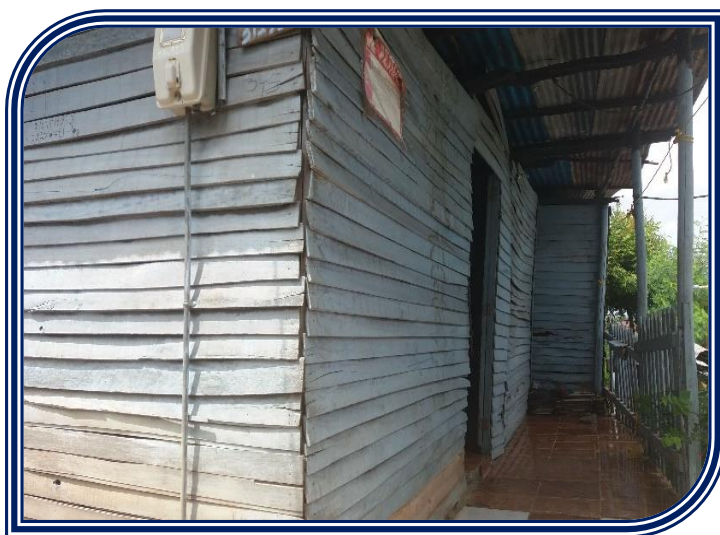
Figura 18. Sistema de pórtico y paneles en madera.
