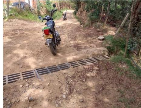
*Ilustración 22:* Fotografías de las obras de drenaje de la vía monteadentro..
