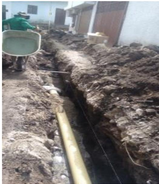
*Ilustración 7: Instalación de tubería principal 8" de alcantarillado.*
