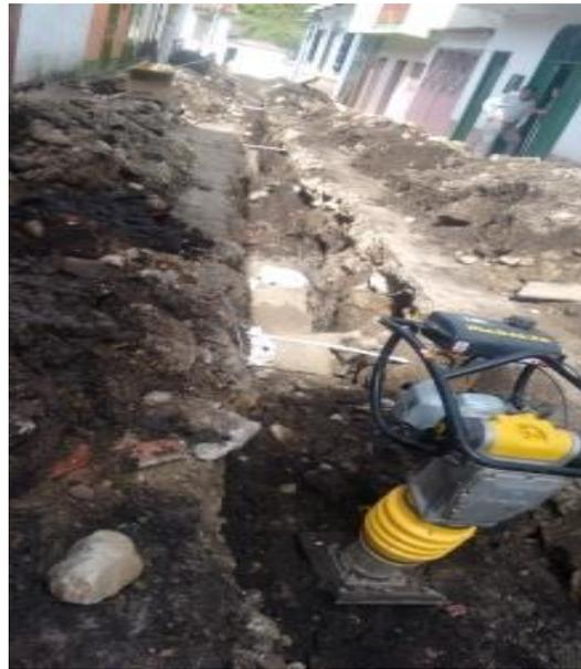
*Ilustración 9: Relleno y compactación para sistema de alcantarillado.*
