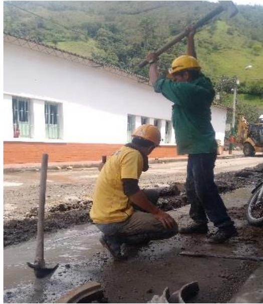
*Ilustración 10: Demolición de pavimento para red de acueducto.*
