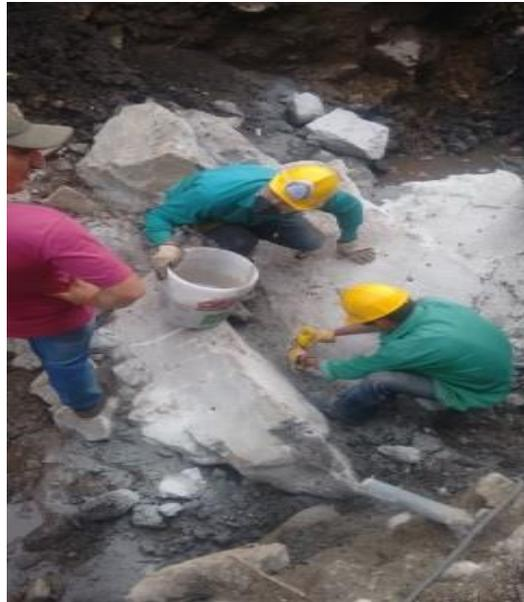
*Ilustración 15: Uso de cemento expansivo*
