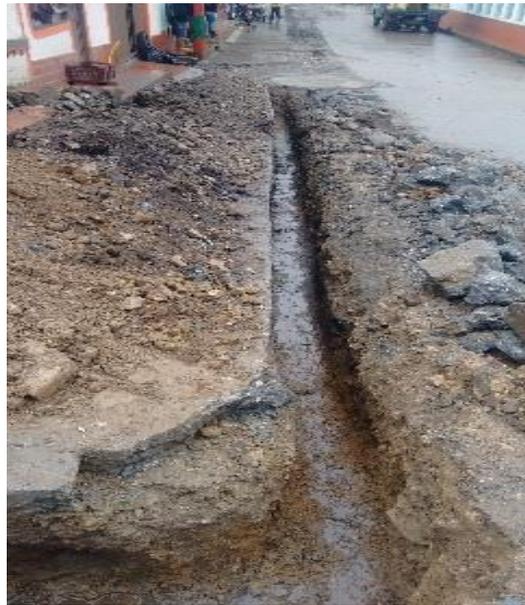
*Ilustración 11: Excavación manual*
