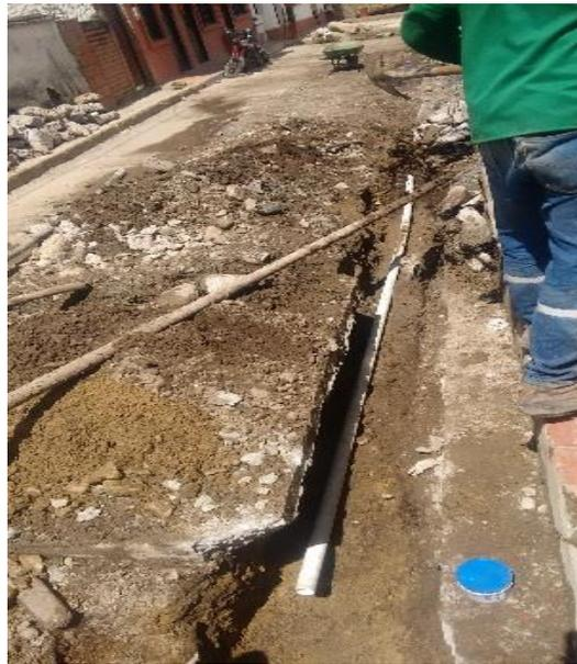
*Ilustración 12: Instalación de Tubería principal de acueducto.*
