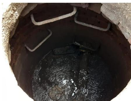
*Figura 22.* Pozo con desgaste de cañuela.
