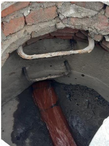
*Figura 21.* Pozo de inspección con profundidad menor a 1.40 m.
