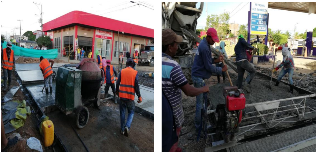
Ilustración 21. Losa en concreto e=20 cm en concreto hidráulico
