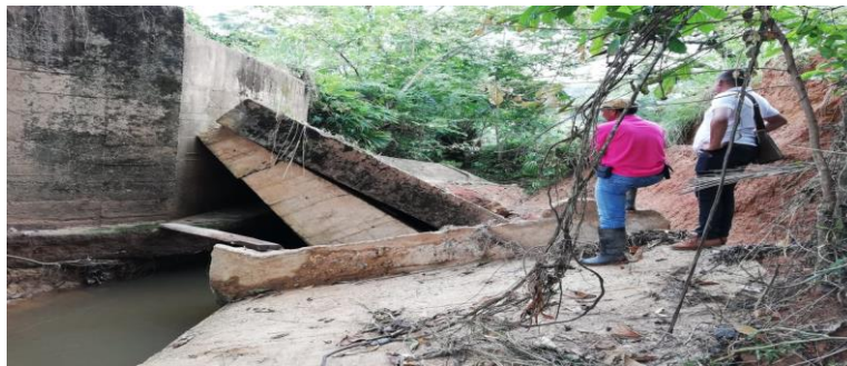
Ilustración 8. Nueva visita de inspección al punto crítico en el puente el loro, en la zona rural del municipio de Tierralta. Fuente: Practicante (2019).
