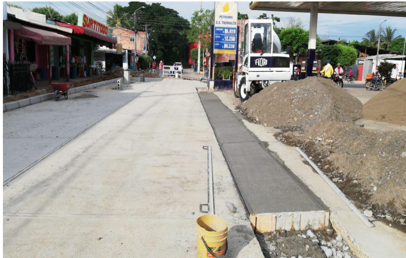
Ilustración 24. Andén en concreto clase C.
