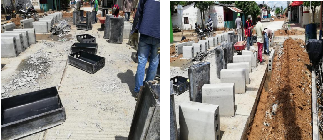
Ilustración 23. Bordillo sardinel en concreto prefabricado en obra.
