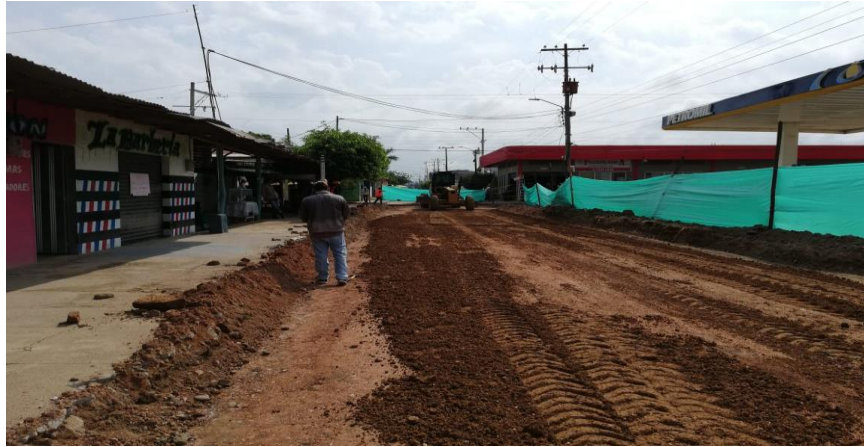
Ilustración 14. Localización y replanteo topográfico.
