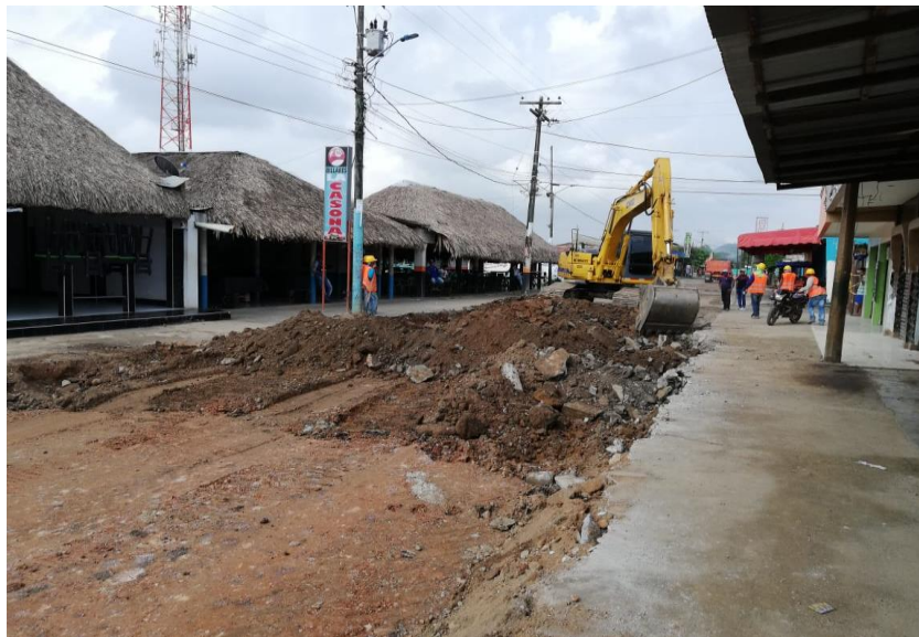
Ilustración 16. Demolición mecánica de pavimento y andenes existente.
