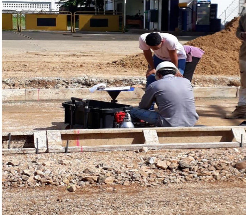
Ilustración 25. Ensayo de densidad con el cono de arena - in situ.
