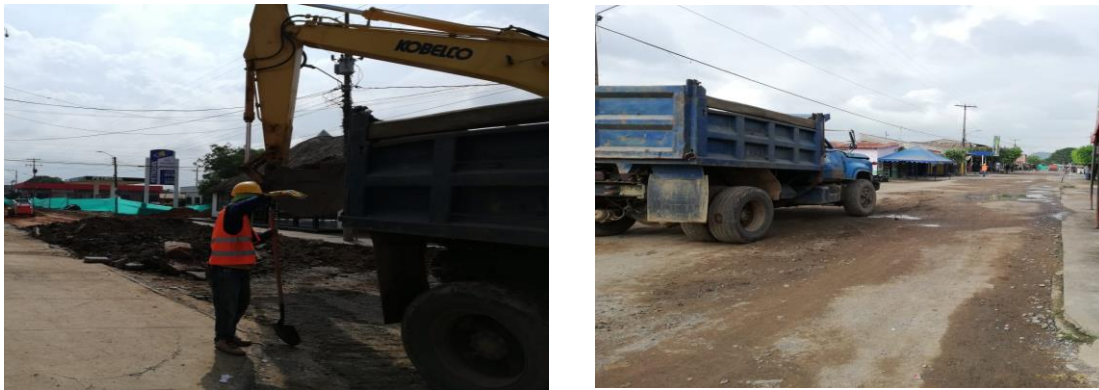
Ilustración 20. Transporte de materiales provenientes de excavación y demolición.
