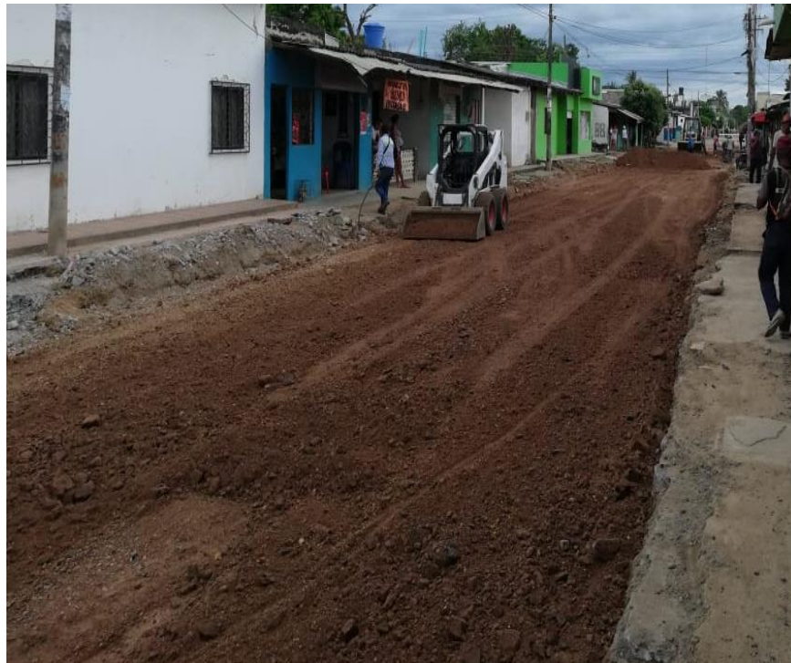
Ilustración 17. Mejoramiento de la subrasante con material seleccionado
