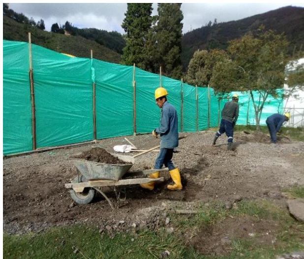
Ilustración 3. Cerramiento en Tela Verde con Altura de 2,80 mts.
