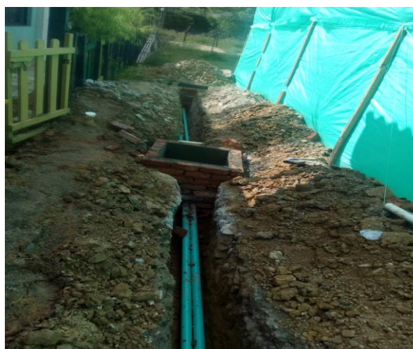
Ilustración 8. Ubicación de Nuevas Cajas Eléctricas.
