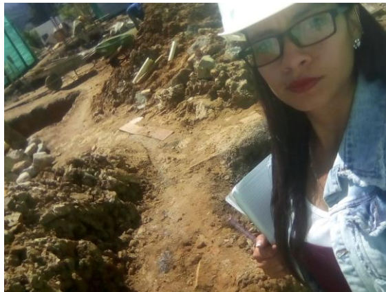
Ilustración 18. Verificación de Cumplimiento de Actividad Retiro de Material.
