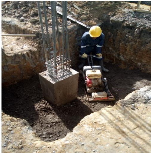
Ilustración 22. Compactación manual con el uso de una vibro compactadora (Rana)
