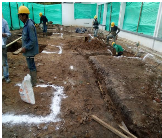
Ilustración 5. Marcaación de Zapatas Plano Modificado
