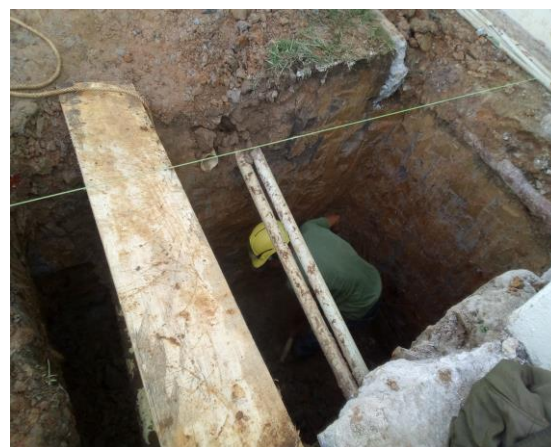
Ilustración 17. Zapata Excéntrica, Z7 Eje 2E.
