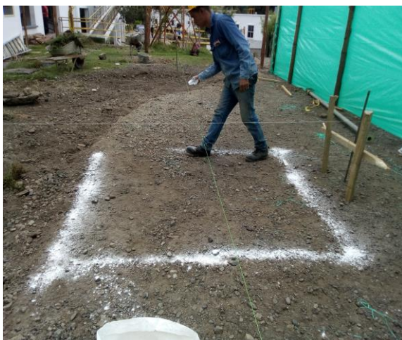
Ilustración 4. Marcaación Zapatas
