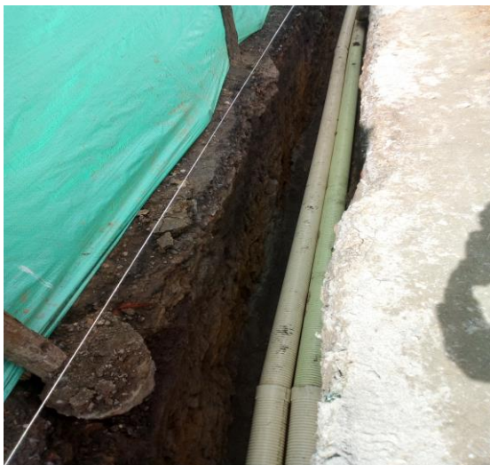
Ilustración 9 Reubicación Tubería Sanitaria.
