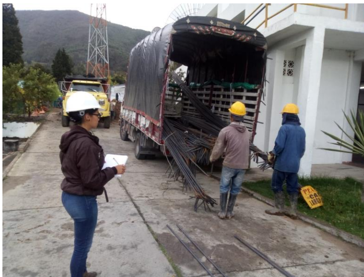
Ilustración 35. Control y Verificación de Acero.
