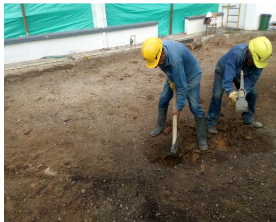
Ilustración 11. Nivelación del Terreno para la Construcción del Edificio
