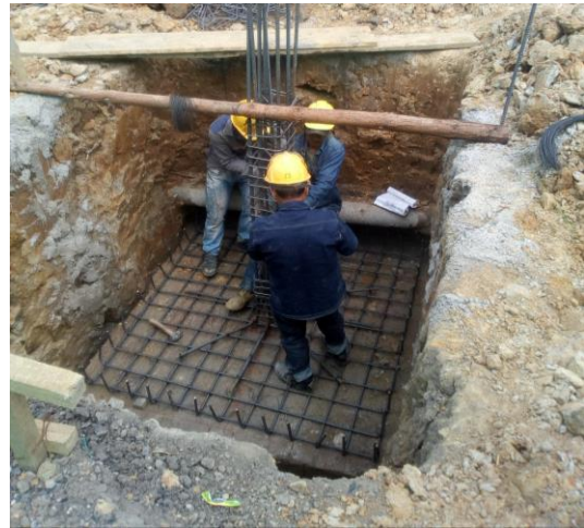
Ilustración 20. Armado de Malla y Columna
