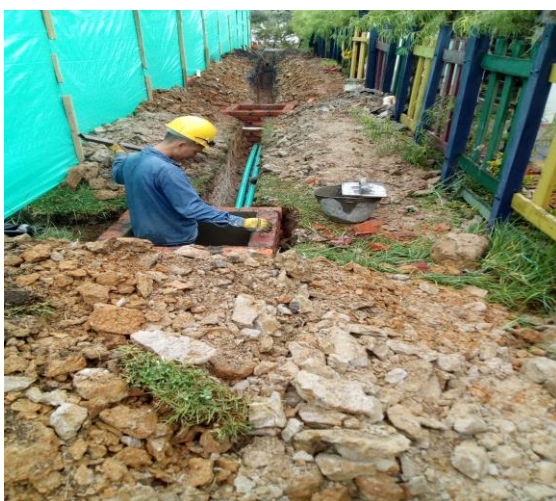
Ilustración 8. Ubicación de Nuevas Cajas Eléctricas.
