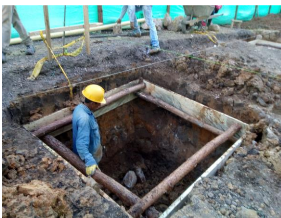
Ilustración 16, Inicio Proceso de Entibación
