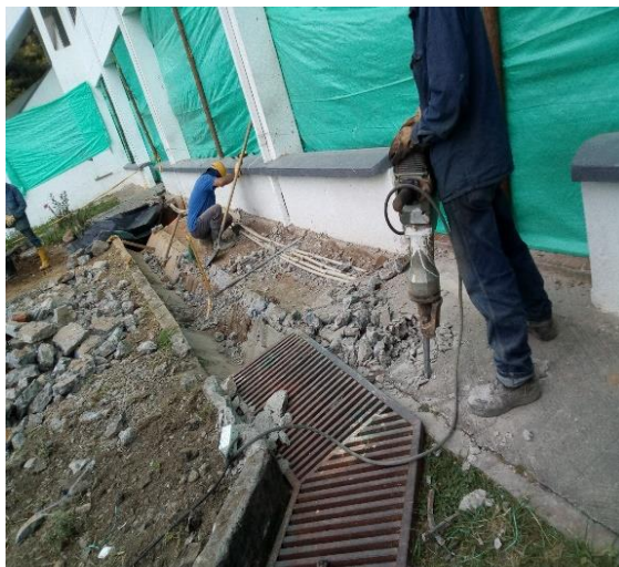
Ilustración 6. Demolición de Concreto.
