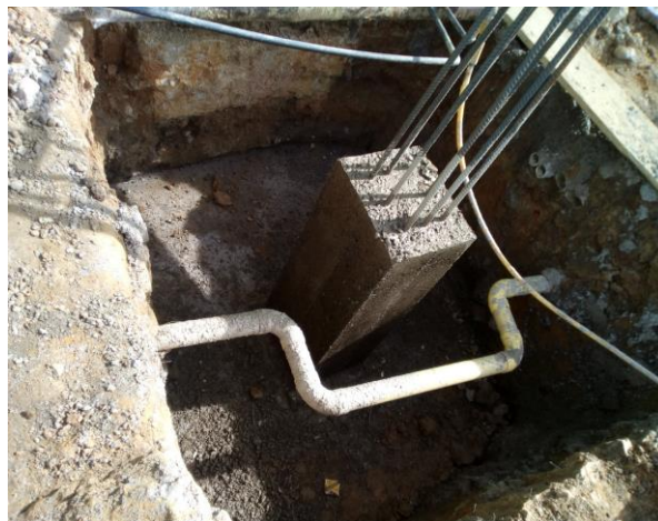
Ilustración 21. Cambio de Dirección de Tubería para Fundir Columna.
