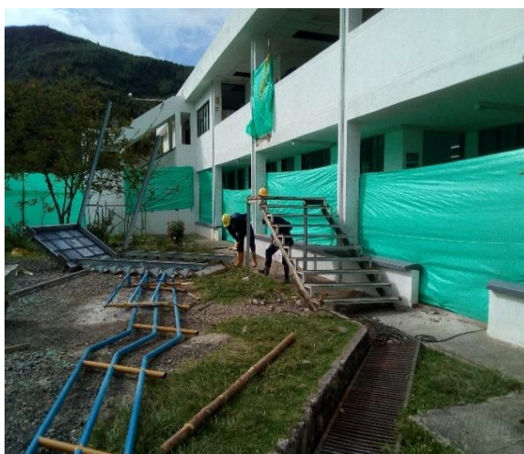
Ilustración 7. Desmante de Escalera Metálica.
