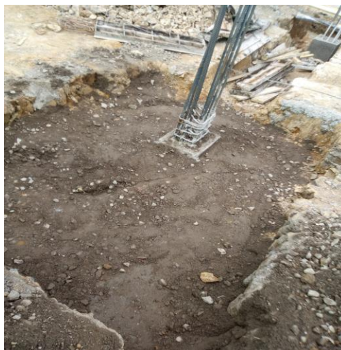
Ilustración 23. Compactación Terminada a Nivel de Pedestal.
