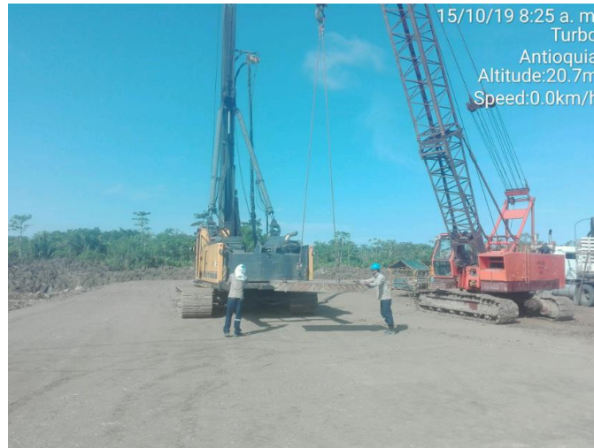
Ilustración 36. Colocado del contra peso.
