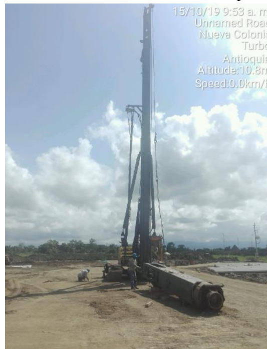
Ilustración 37. Colocado del martillo.
