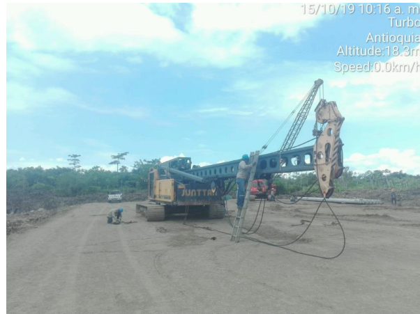
Ilustración 38. Armado y ajuste de la piloteadora.
