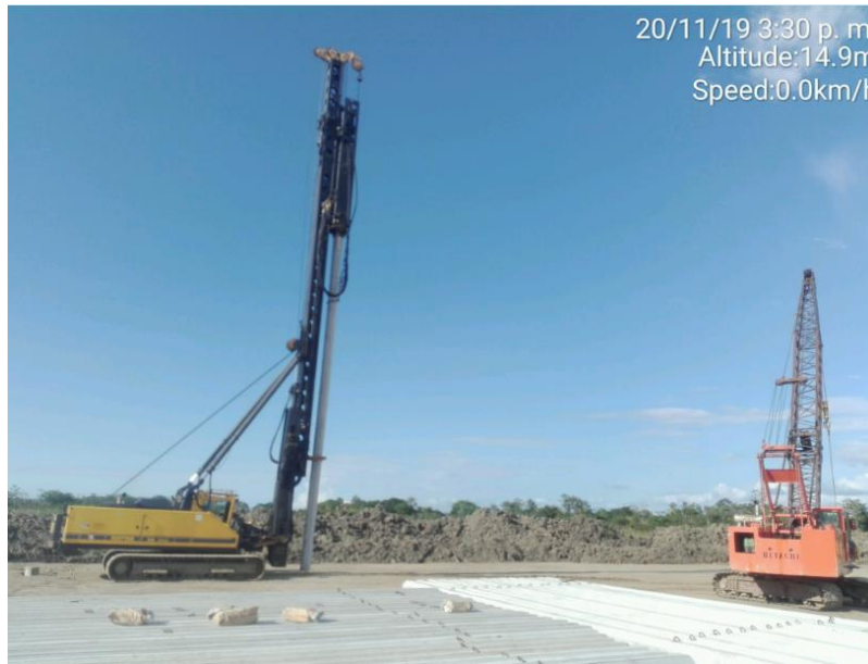
Ilustración 40. Fijación del pilote en la máquina.
