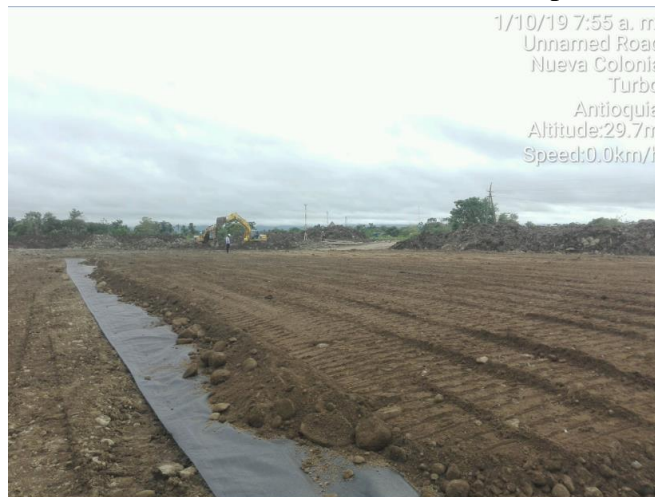
Ilustración 27. Lleno de primera capa sobre el geotextil.
