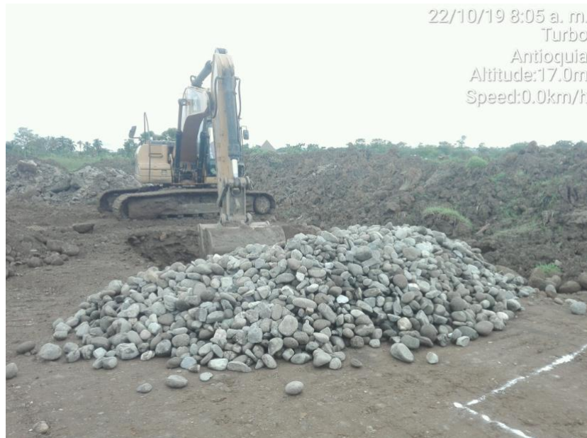
Ilustración 13. Rocas para el reemplazo del material del dado.
