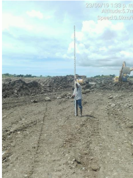
Ilustración 24. Verificación de cotas.
