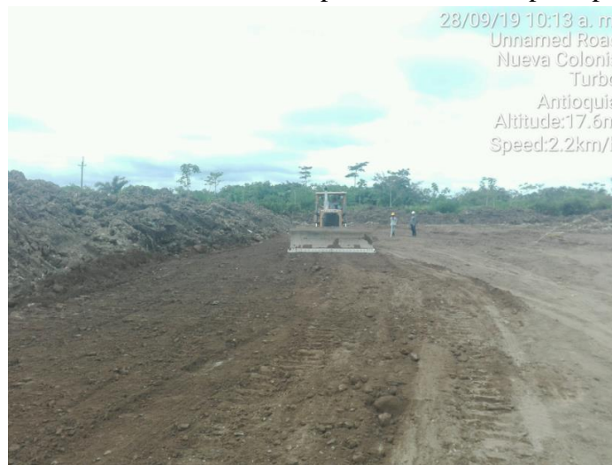
Ilustración 23. Lleno en crudo sello del pedraplén y cota de geotextil.
