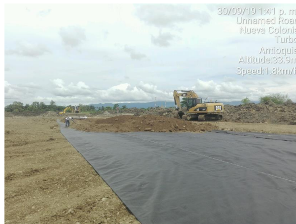
Ilustración 25. Instalación de geotextil traslapo min 30 cm.
