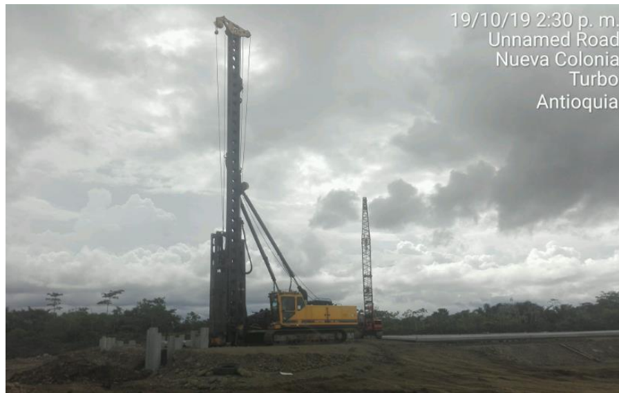
Ilustración 30. Maquina piloteadora JUNNTAN.
