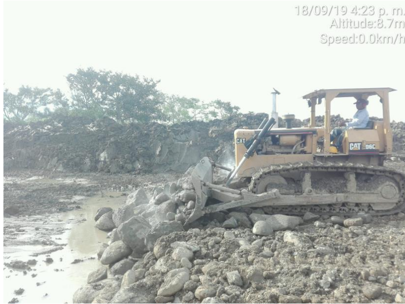
Ilustración 22 Lleno con roca para conformar el pedraplén.
