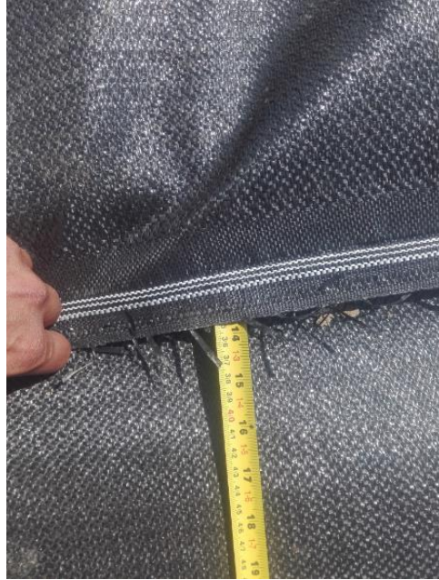
Ilustración 26. Verificación de traslapo.
