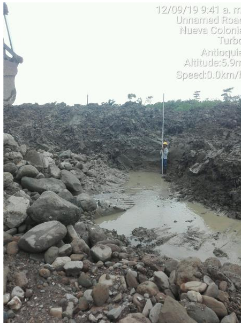
Ilustración 21. Verificación de cota de excavación.
