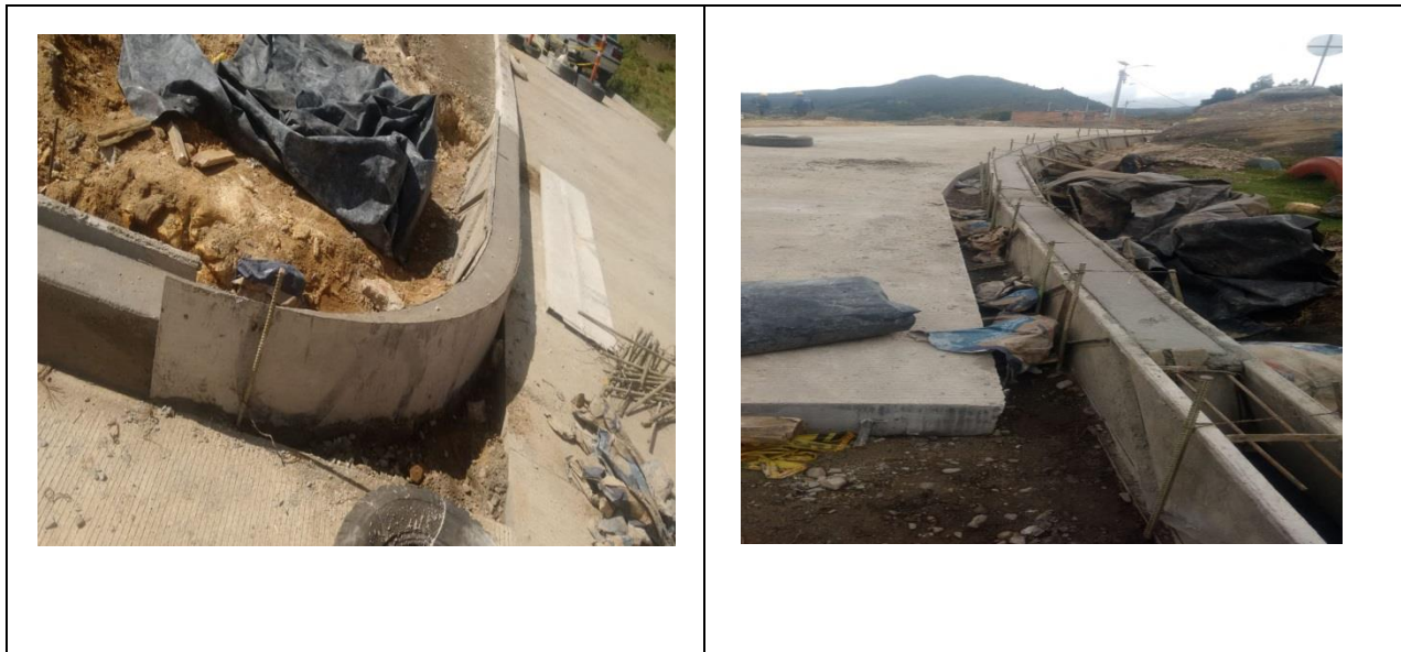
Ilustración 3.Método constructivo sardinel
