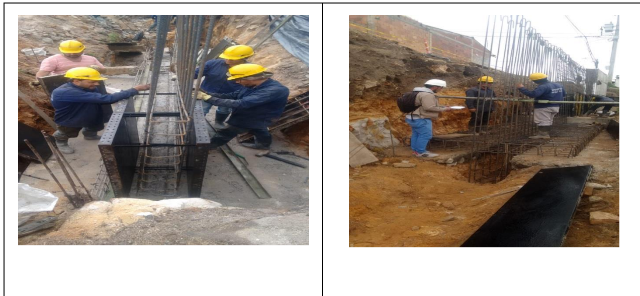
Ilustración 6.Método constructivo muro de contención
