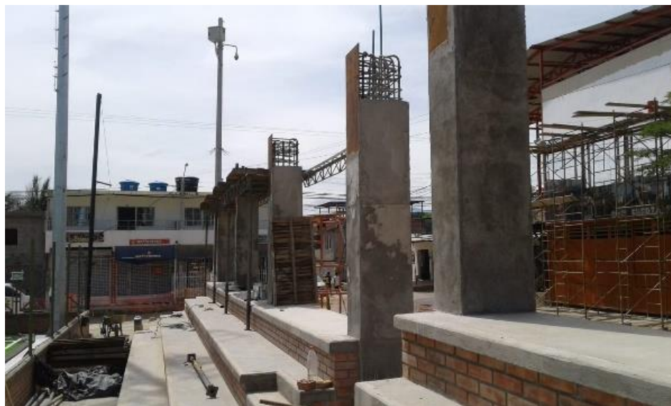
Figura 31. Fundida de columnas módulos de gradería
