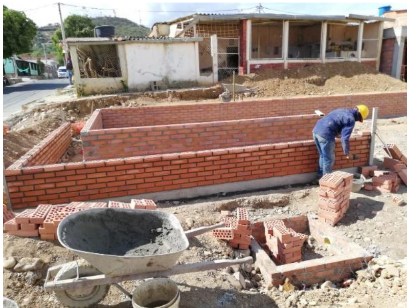
Figura 21. Levantamiento muro para jardineras
