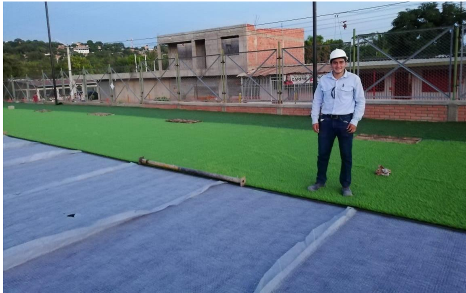
Figura 30. Supervisión de instalación de geodren y grama sintética.
