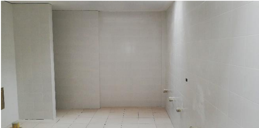
Figura 28. Enchapado modulo administrativo
