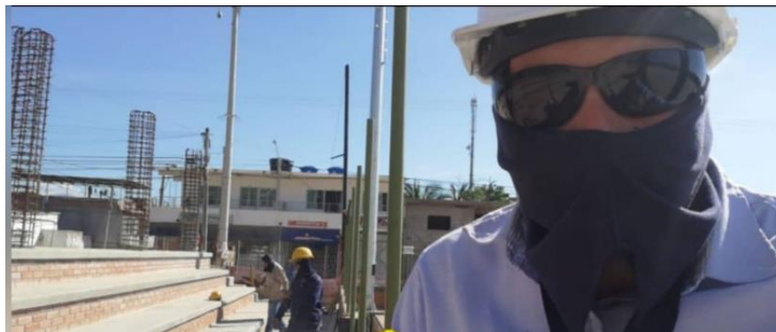
Figura 23. Supervisión construcción módulos de gradería
