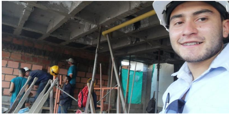
Figura 20. Supervisión levantamiento de muros en el módulo administrativo.
