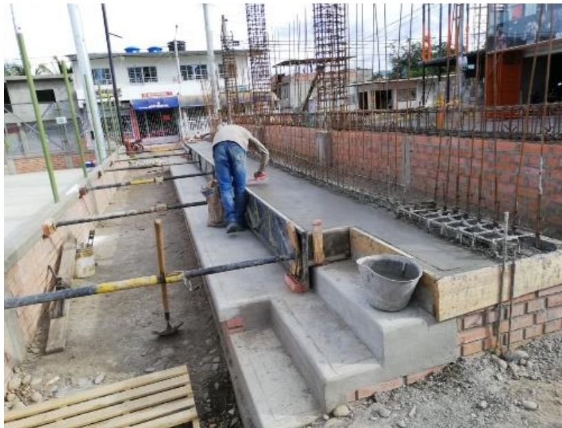
Figura 22. Fundida huellas módulo de gradería.
