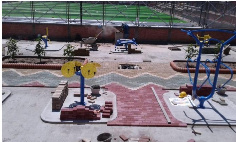
Figura 32. Instalación de adoquín y juegos Bio-saludables
