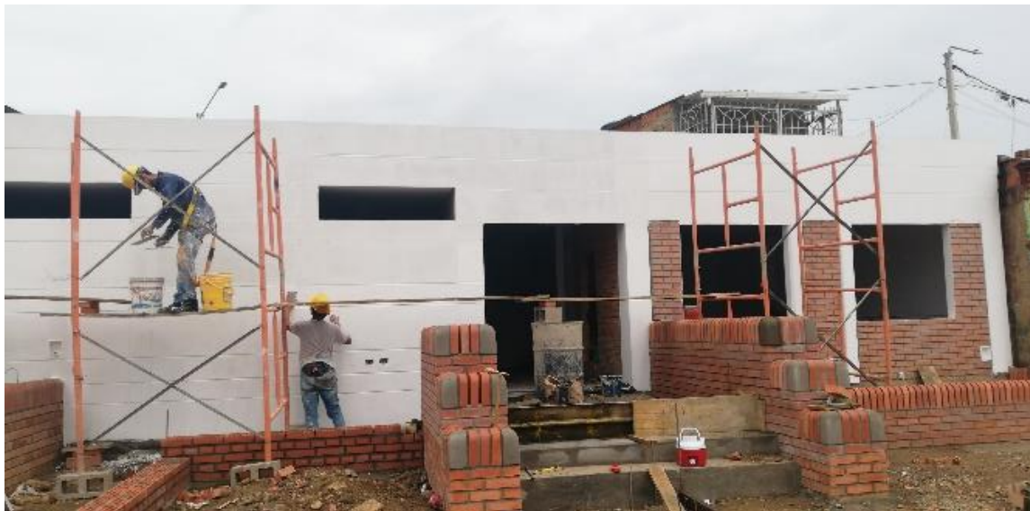
Figura 27. Empastado modulo administrativo
