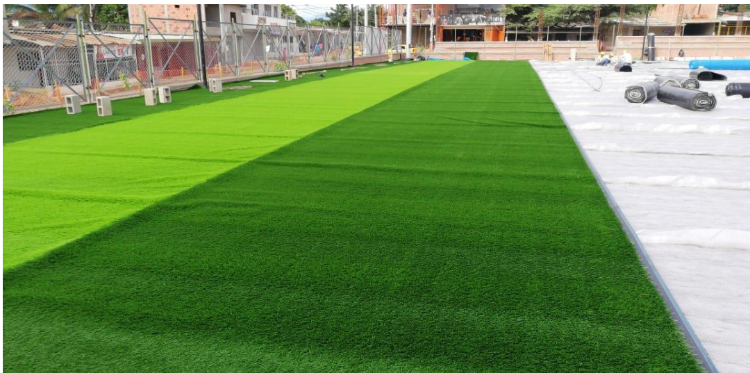
Figura 29. Instalación de geodren y grama sintética.
