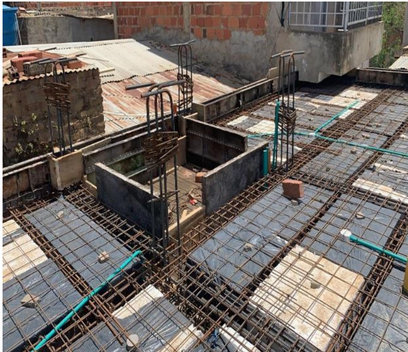
Figura 12. Armado acero de refuerzo placa modulo administrativo
