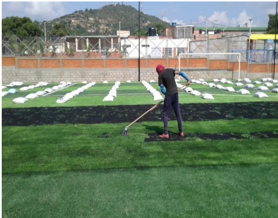
Figura 37. Instalación de caucho en grama sintética.
