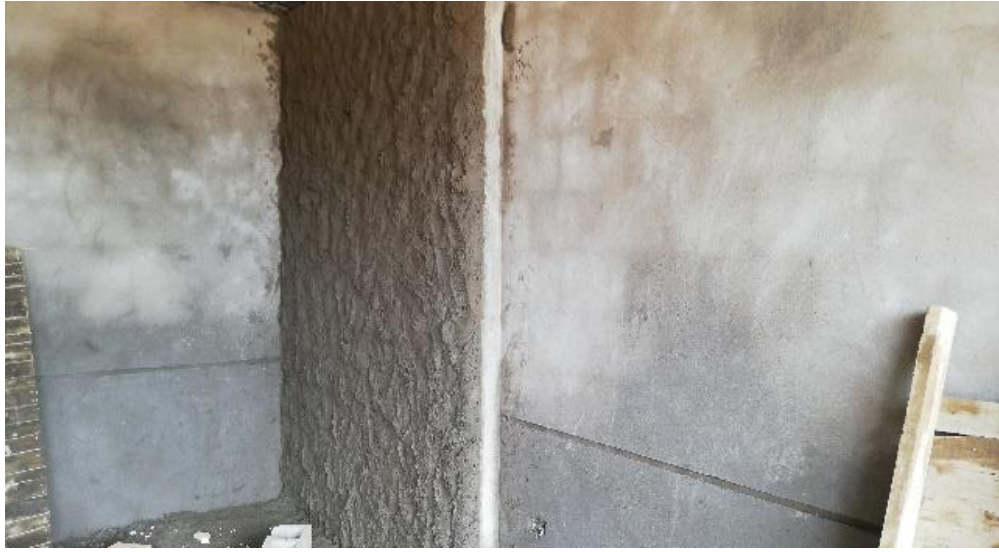
Figura 24. Pañete en muros de mampostería.
