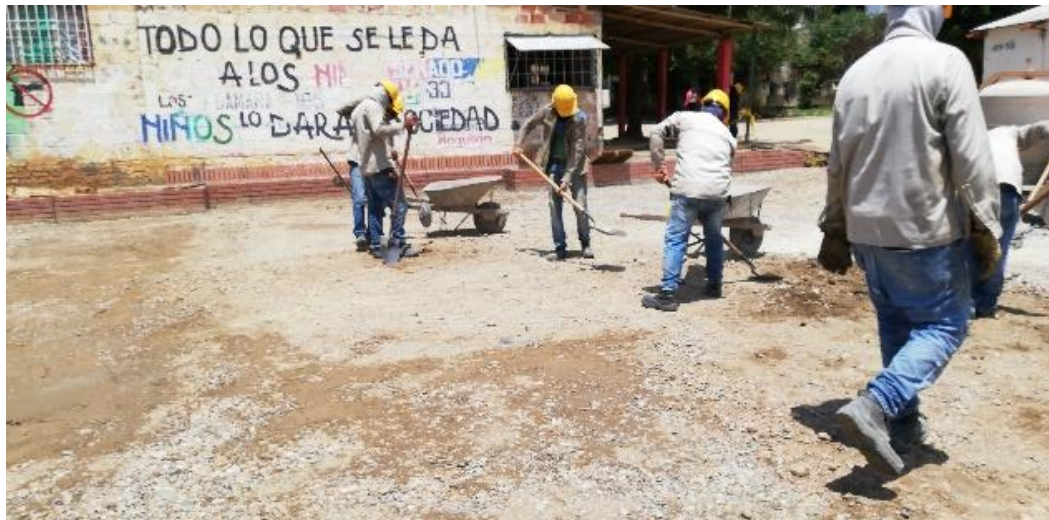
Figura 26. Escarificación y nivelación parque.
