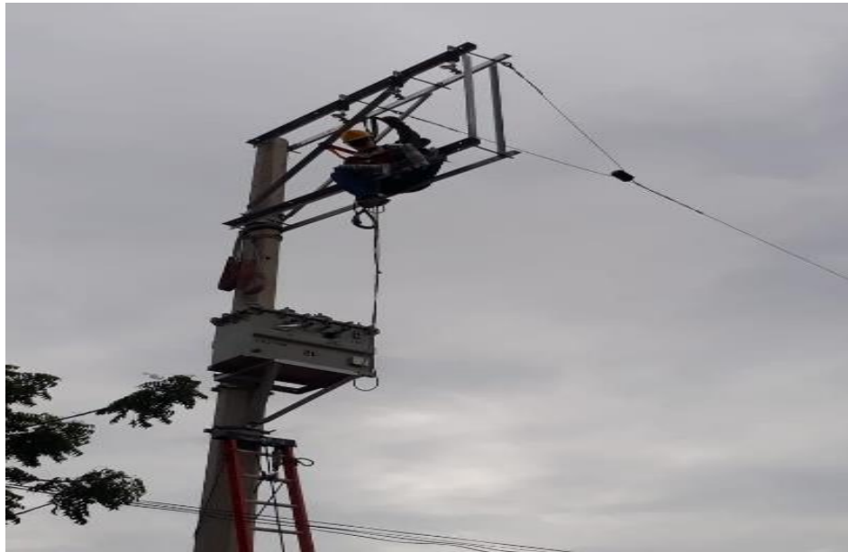
Figura 36. Instalación de red media tensión
