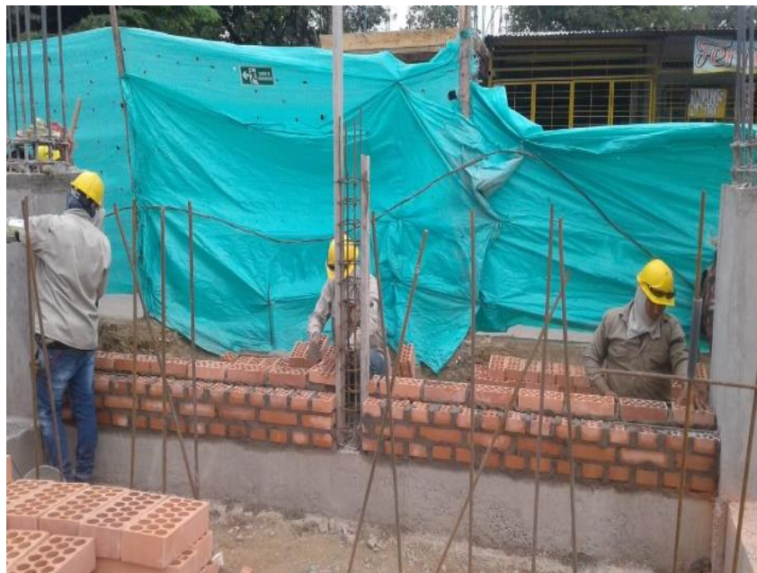
Figura 11. Mampostería de módulo de gradería
