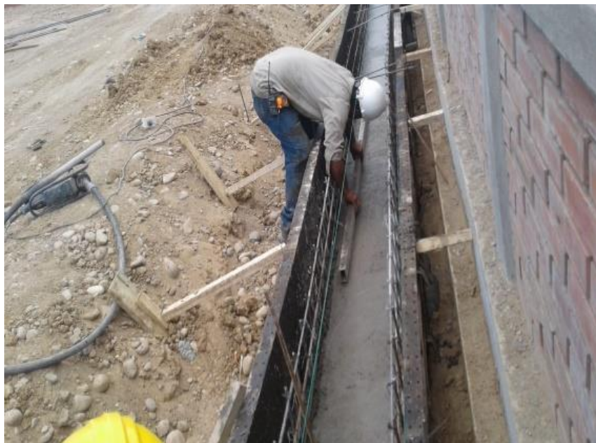
Figura 13. Fundida canal de desagüe campo de juego
