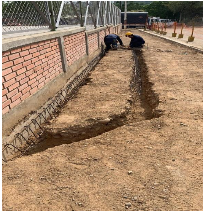
Figura 16. Excavación y armado acero de refuerzo para bordillo de jardineras.
