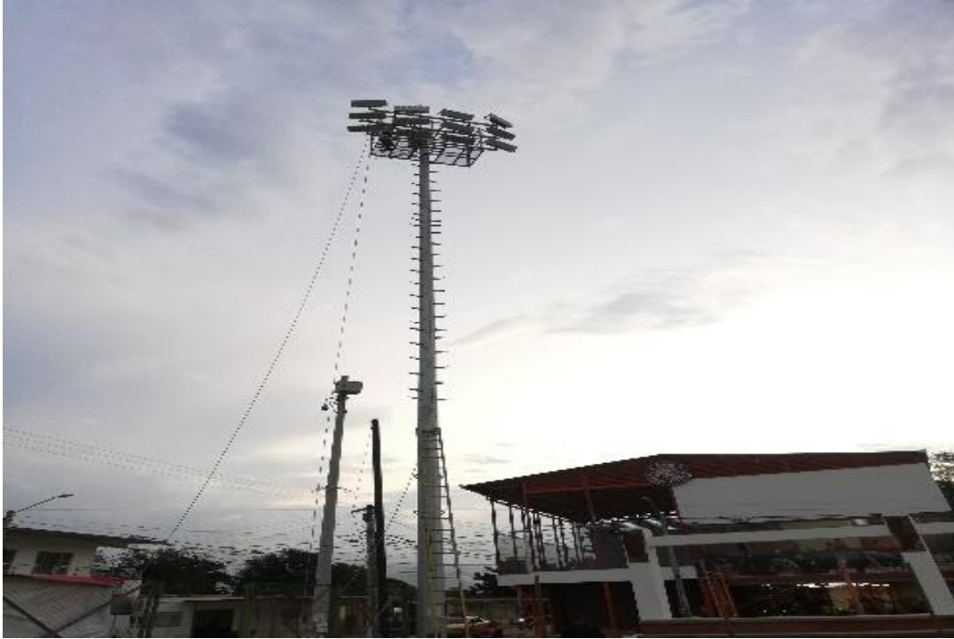
Figura 38. Instalación de luminarias para campo de juego.
