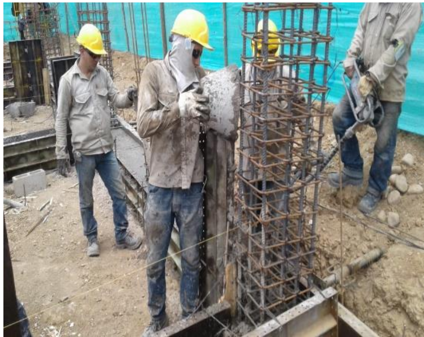
Figura 10. Vaciado concreto vigas de cimentación módulo de gradería
