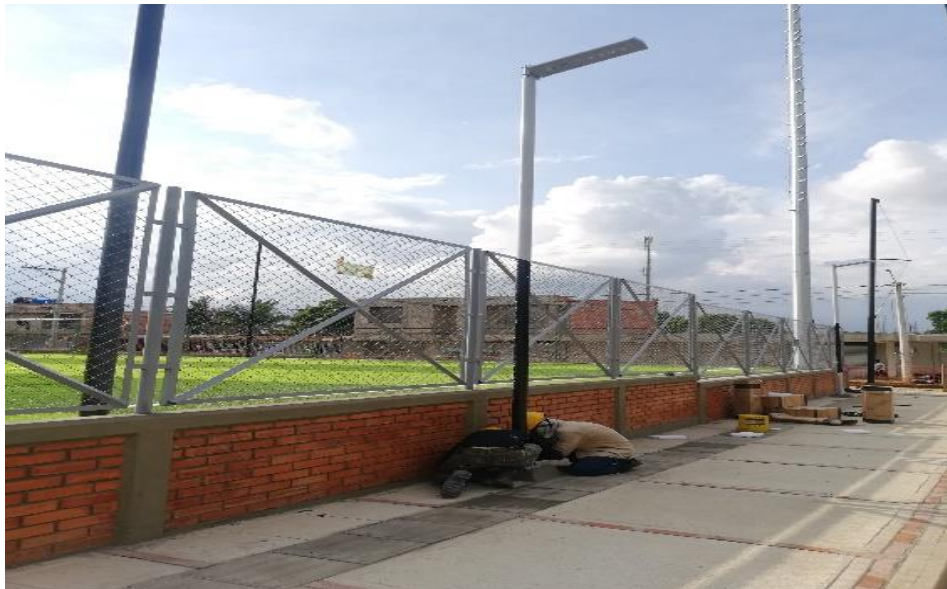
Figura 35. Instalación de iluminarias fotovoltaicas.
