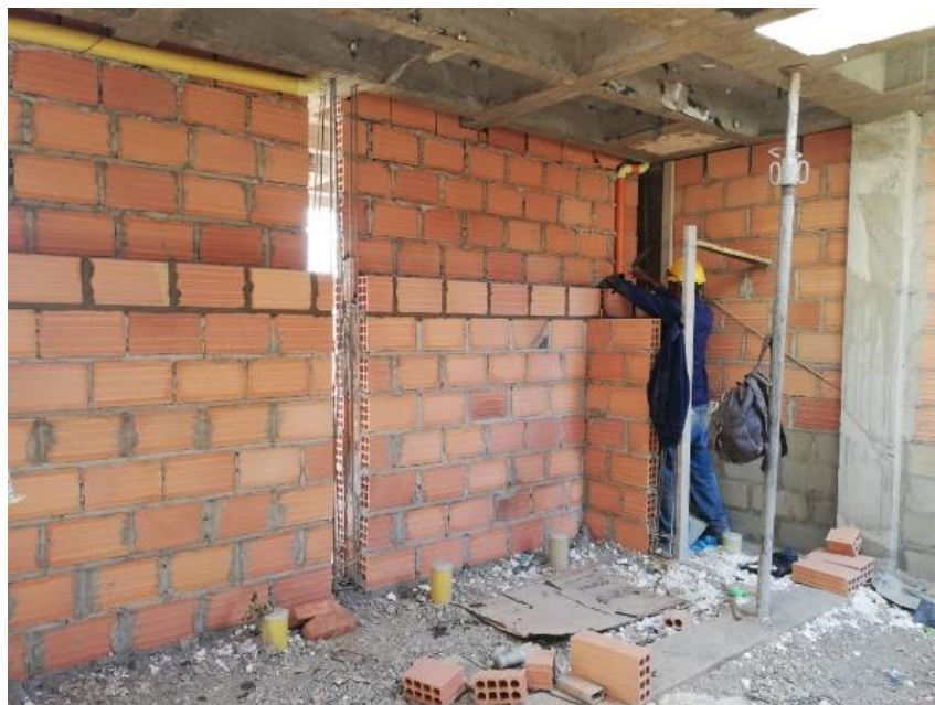
Figura 19. Levantamiento de muros en el módulo administrativo.
