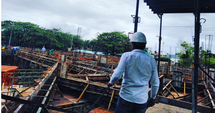
Figura 14. Verificación y supervisión de los trabajos realizados
