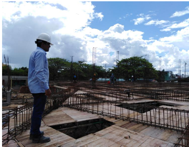
Figura 18. Procesos de control en obra
