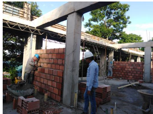
Revisión de los trabajos realizados por parte de los oficiales para su correcta instalación
