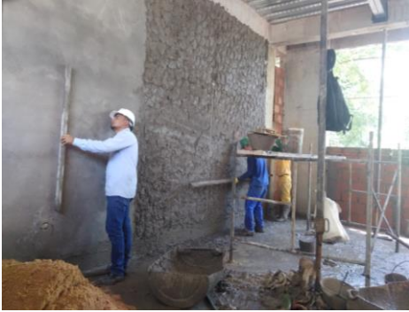
Comprobación de alineamiento de pañetes
