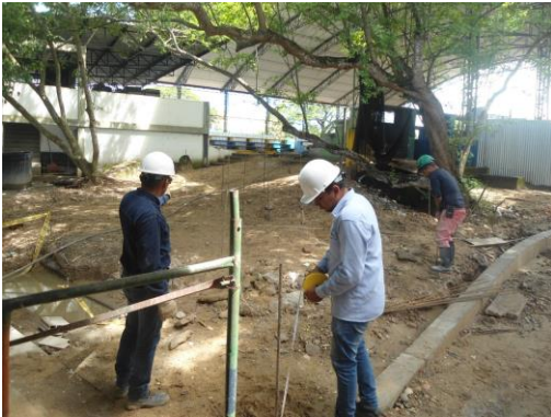
Localización y replanteo en rampa de acceso polideportivo
