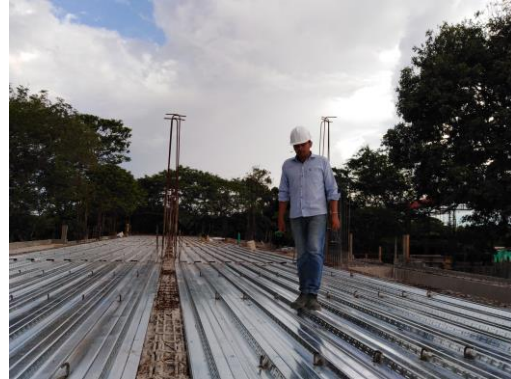
Inspección soldadura de pasadores de cortante entre perfil metálico y metaldeck
