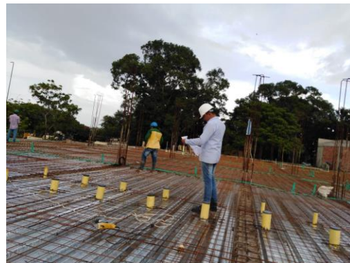
Verificación de la instalación de lo bajantes de tubería sanitaria en placa de entre piso
