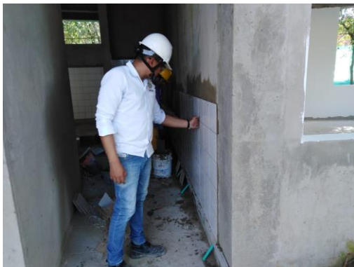
Verificación de instalación de baldosas para muros de baños
