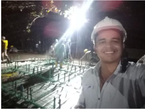
Acompañamiento y verificación en fundida placa de entre piso
