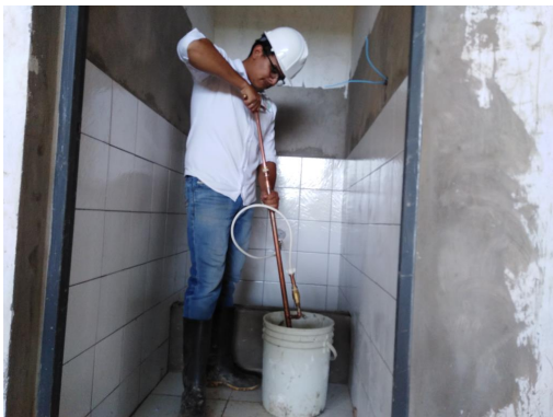
Ejecución prueba de presión en red de agua potable
