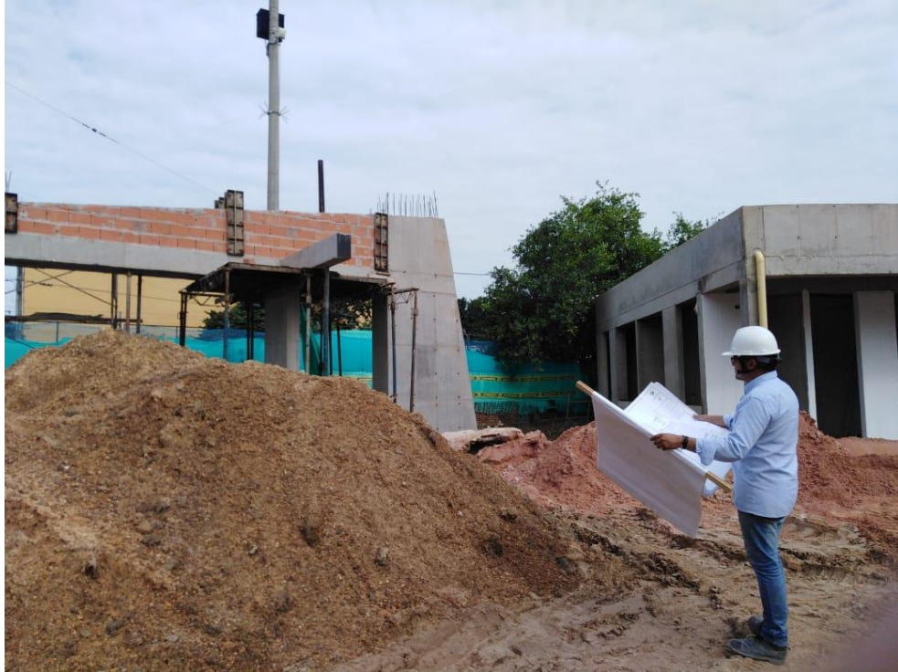
Figura 21. comprobación planos de diseño y obra ejecutada
