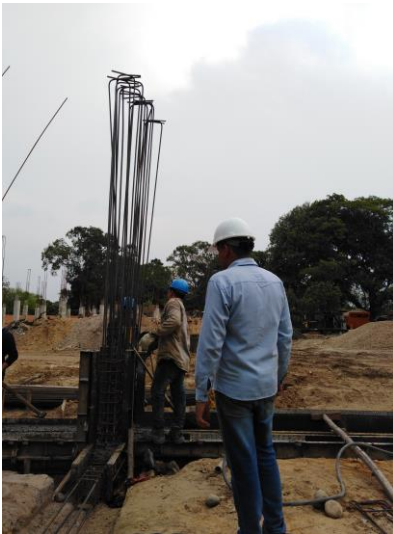
Verificación instalación de acero de refuerzo en muro estructural
