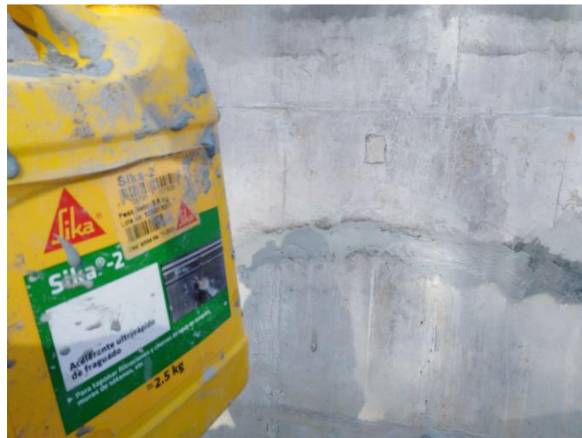
Figura 30. Reparación de fisuras con Sika-2
