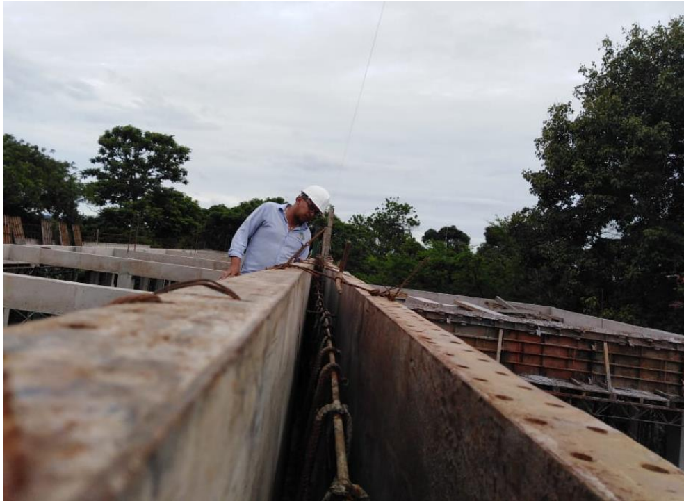
Figura 20. Verificaciones conforme a lo establecido en los diseños
