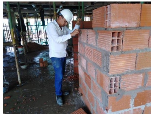
Revisión plomo muros divisorios
