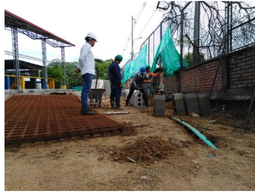
Control en la instalación de sardineles en el área de parqueadero
