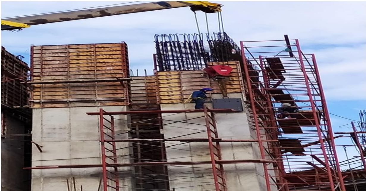
Ilustración 35 Izado de Flanche
