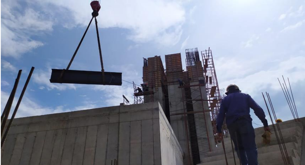
Ilustración 36 Izaje de Vigas IPE
