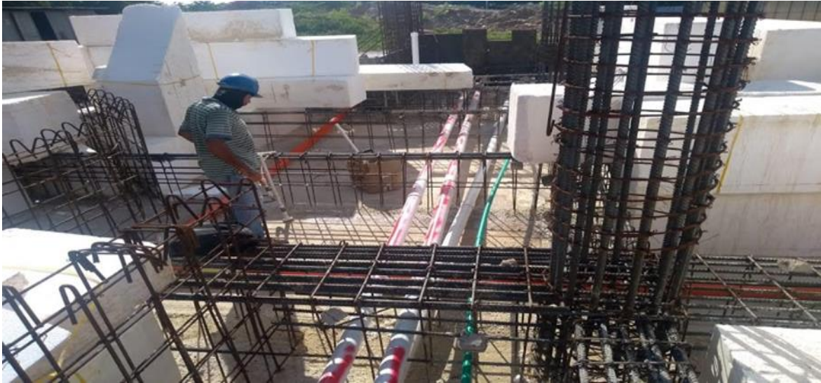
Ilustración 10 Instalación de Redes Hidrosanitarias, Red Eléctrica y Red Contra Incendio
