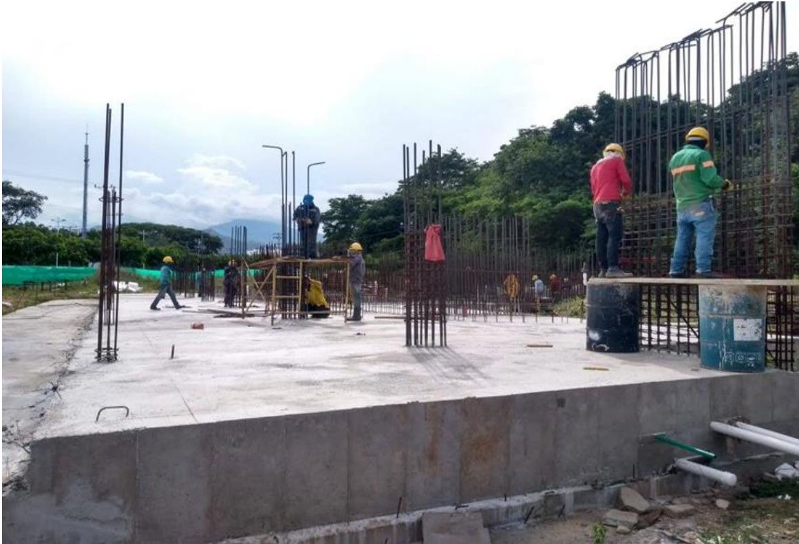
Ilustración 13 Armado de Acero Para Columnas y Pantallas
