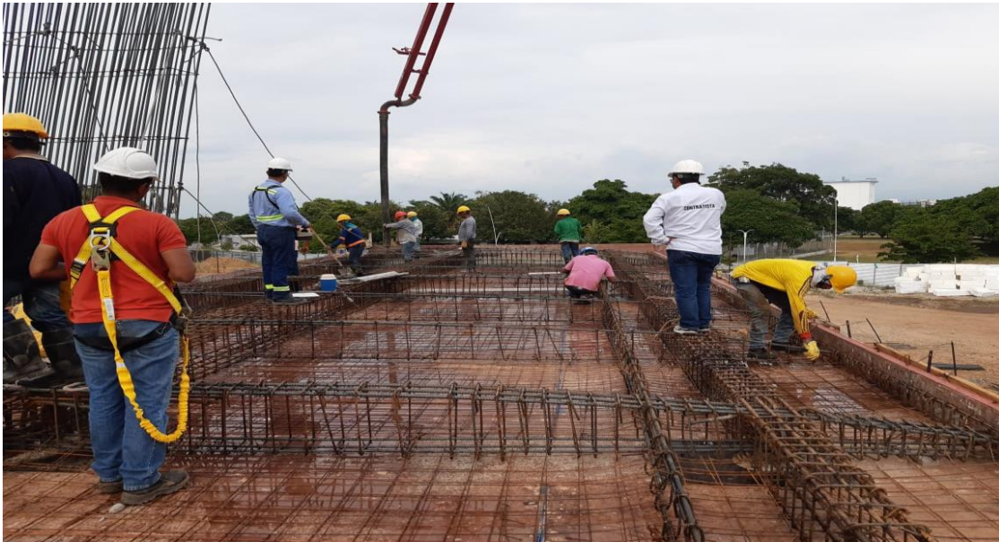
Ilustración 20 Fundida de Placa N+3,40, Torta inferior
