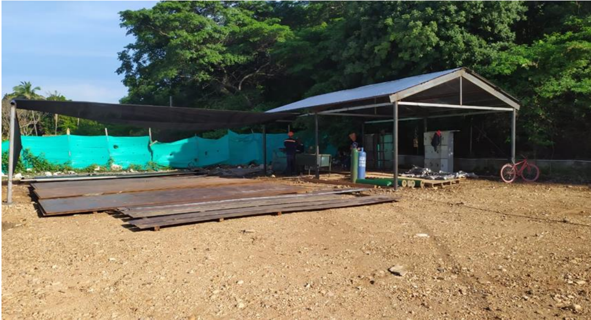
Ilustración 30 Laminas Para la Construcción de Vigas IPE
