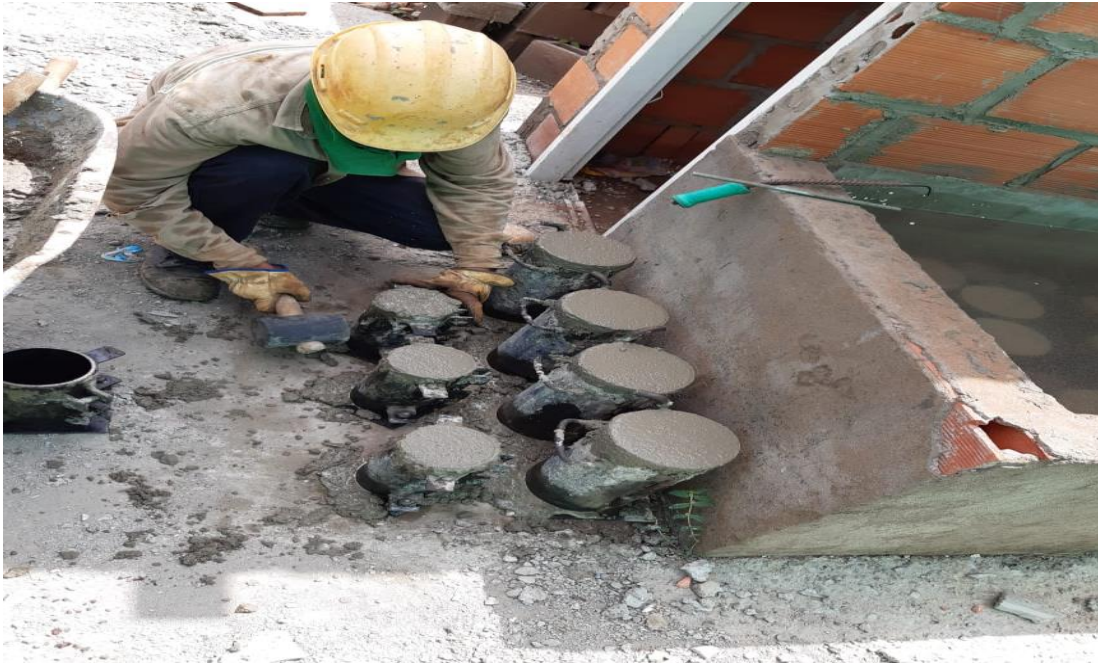
Ilustración 12 Toma de Cilindros para Prueba de Resistencia
