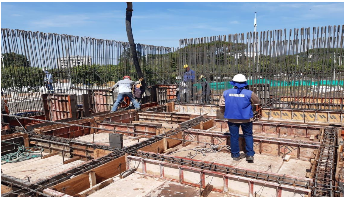
Ilustración 22 fundida de Vigas Para Placa N+3,40 Sin Torta Inferior
