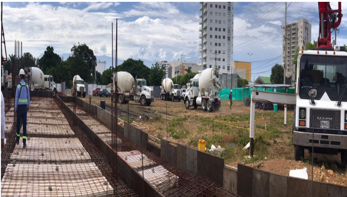
Ilustración 11 fundida de placa de cimentación
