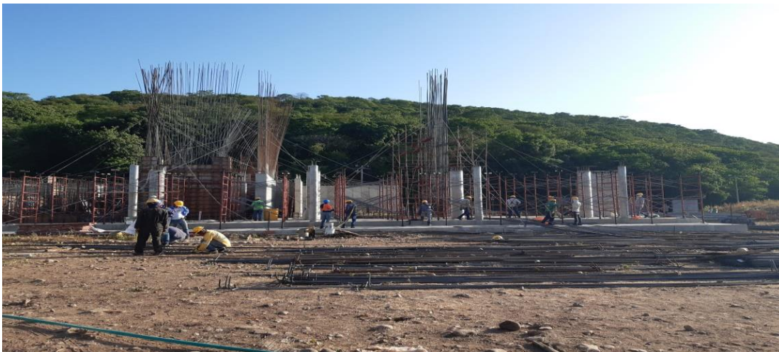
Ilustración 17 Ubicación de Andamios Para el Armado de la Placa N+3,4
