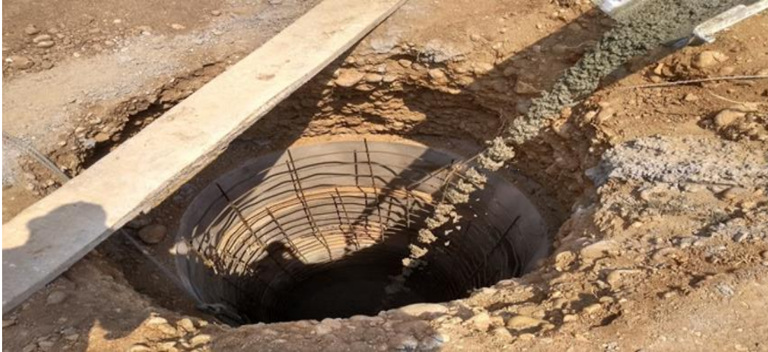
Ilustración 6 llenado de caisson en concreto
