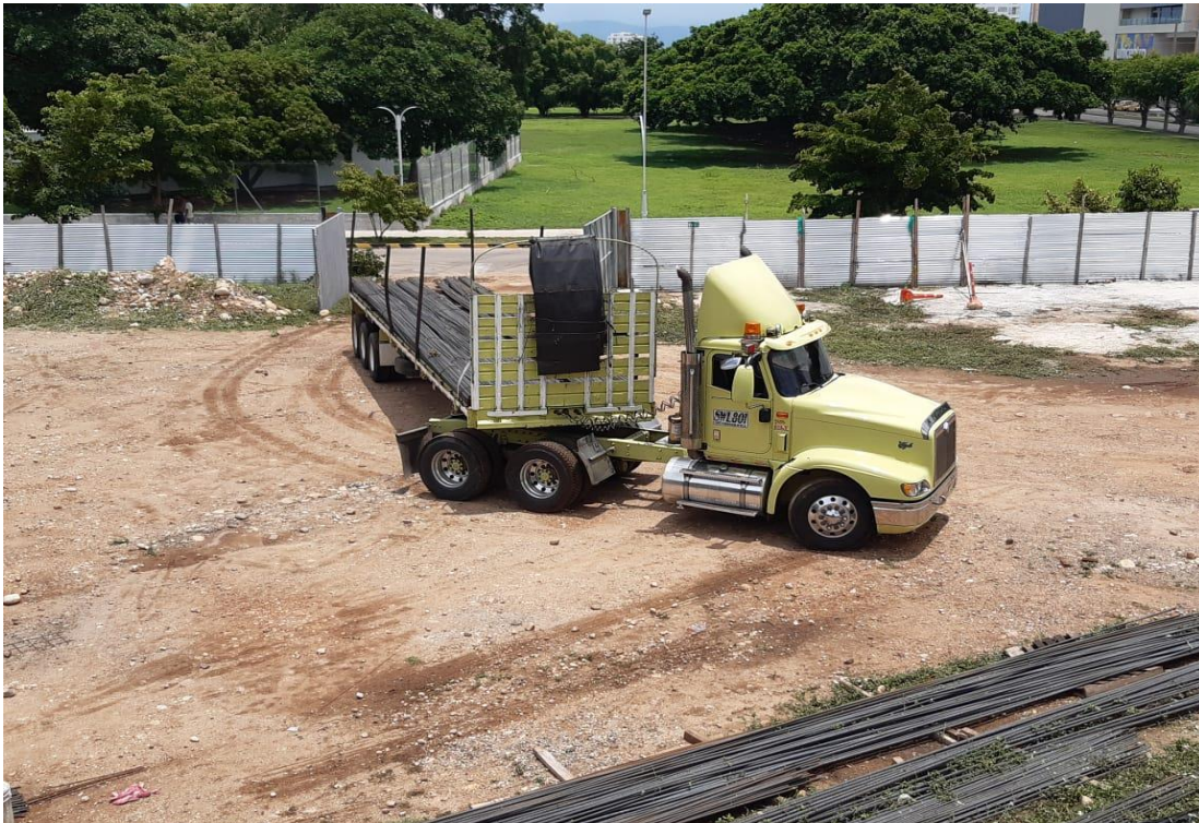
Ilustración 4 Ingreso de material acero de refuerzo
