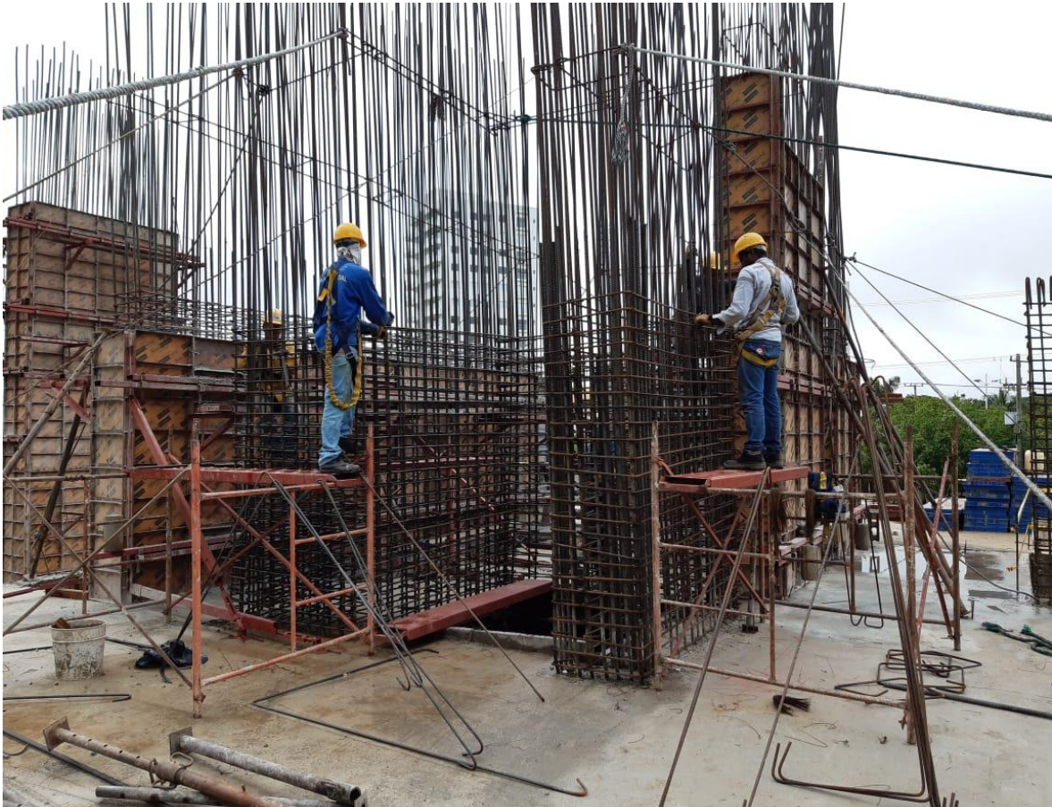
Ilustración 24 Armado de Acero Para Muro Tipo 1
