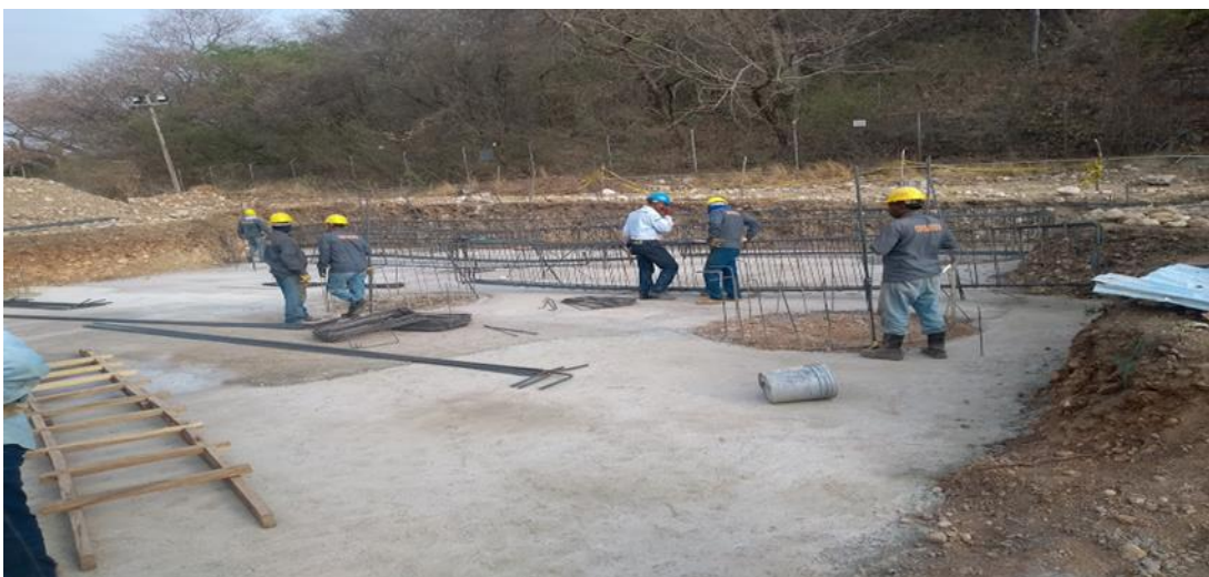
Ilustración 7 solado y armado de vigas de cimentación
