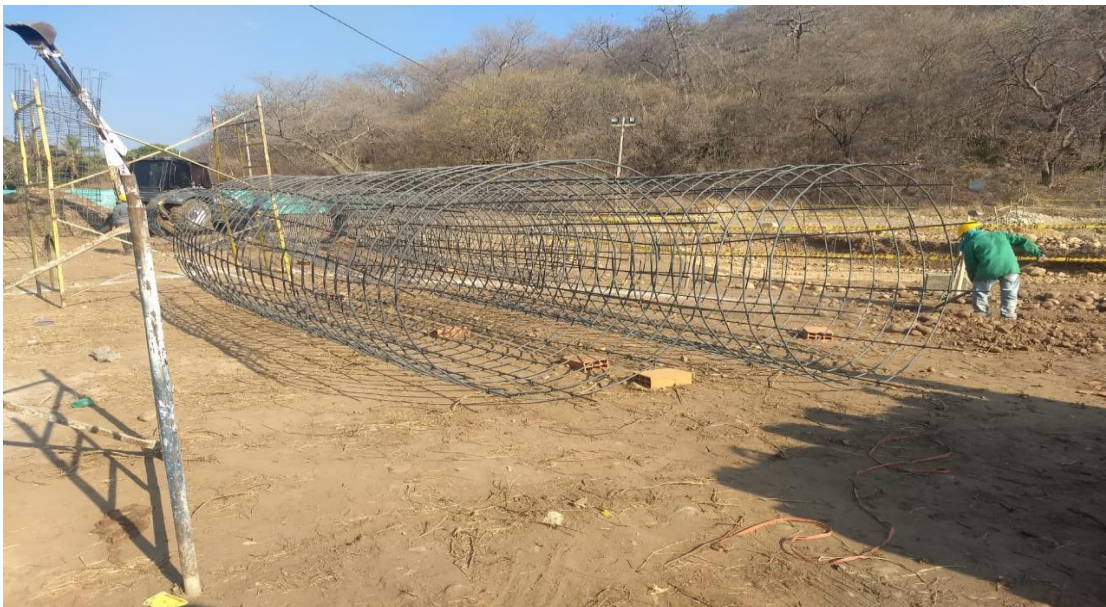
Ilustración 5 Armado de acero para caisson
