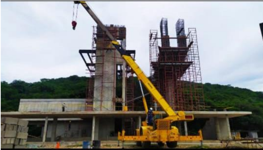
Ilustración 38 imagen representativa de como quedo la obra al finalizar las practicas
