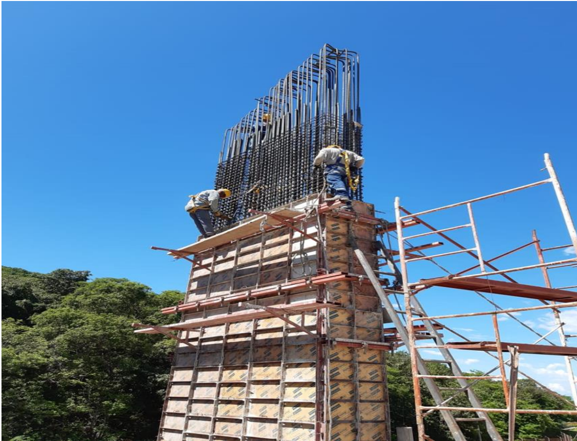
Ilustración 26 Armado de Acero Columna Tipo 1
