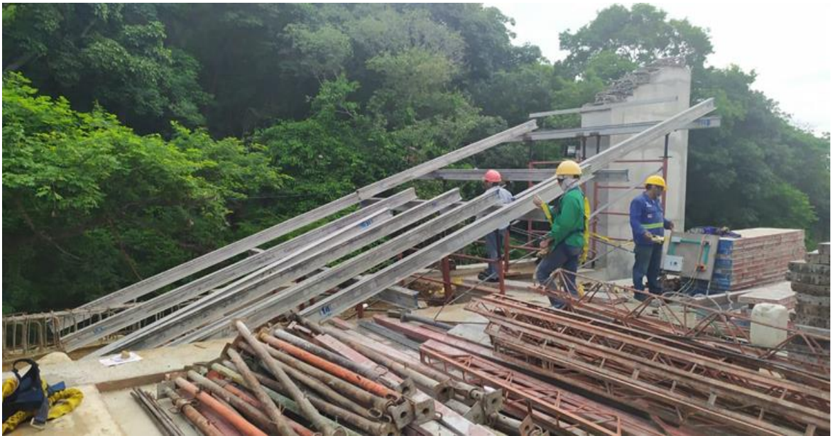
Ilustración 28 Armado de Plataforma para Escaleras de Túnel
