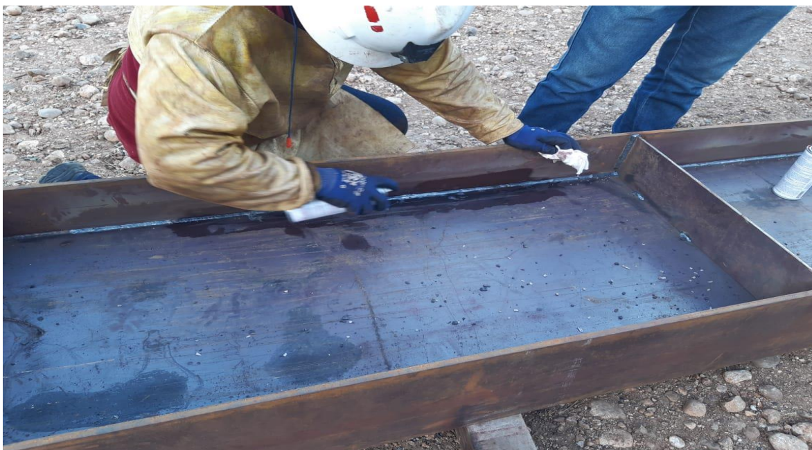
Ilustración 31 Prueba no Destructiva de Tinta para el Cordón de Soldadura (Limpiador)
