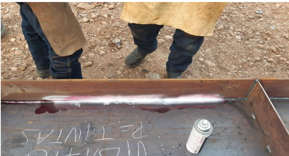
Ilustración 33 Prueba no Destructiva de Tinta Para el Cordón de Soldadura (Revelador)
