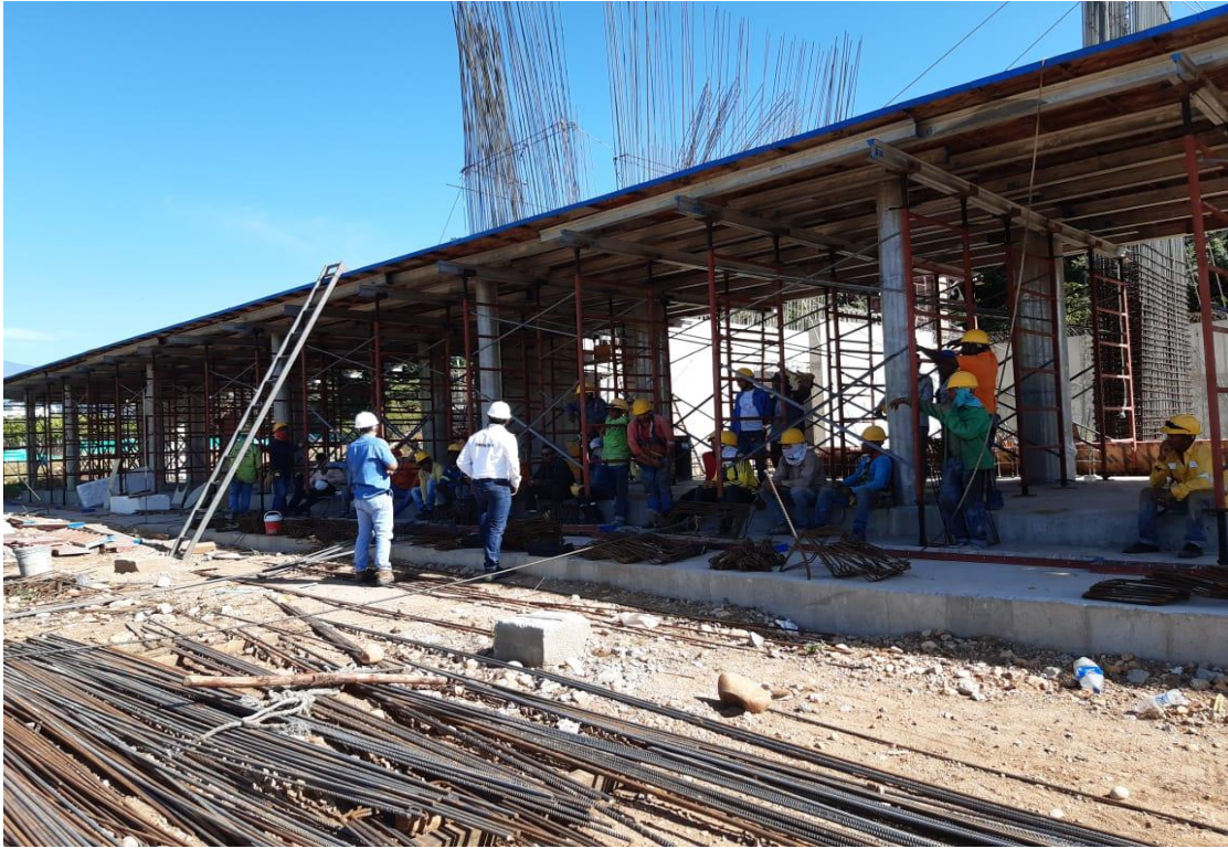
Ilustración 19 Charla de Seguridad Para Trabajos en Altura
