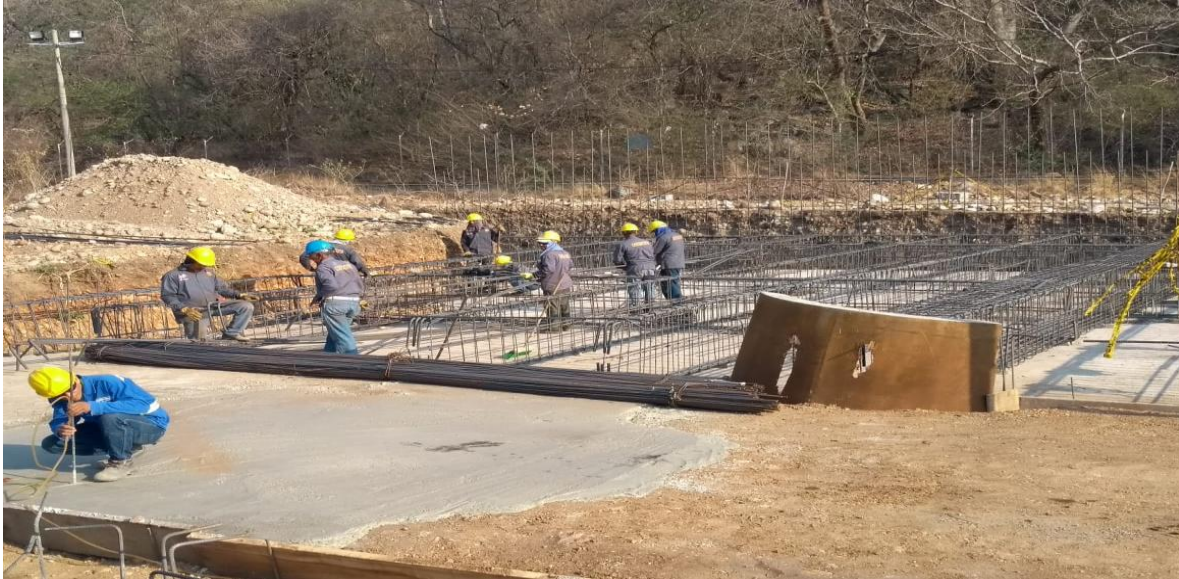
Ilustración 8 Armado de vigas de cimentación
