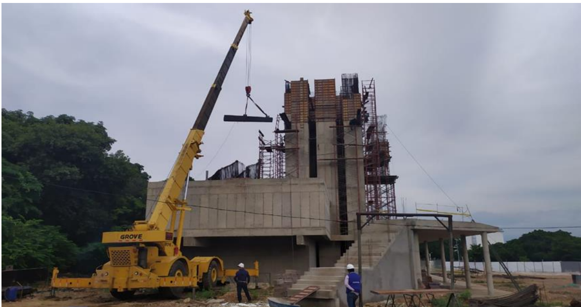
Ilustración 37 Izaje de Viga Cajón
