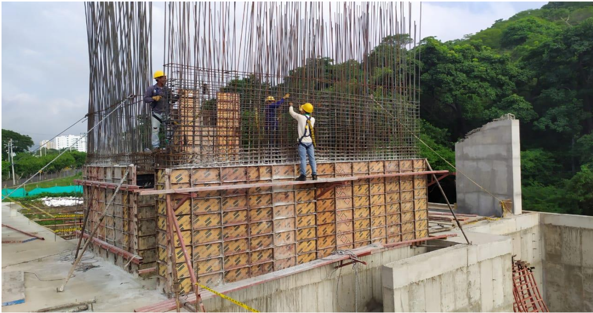
Ilustración 23 Armado de Acero Para Muro Tipo 2
