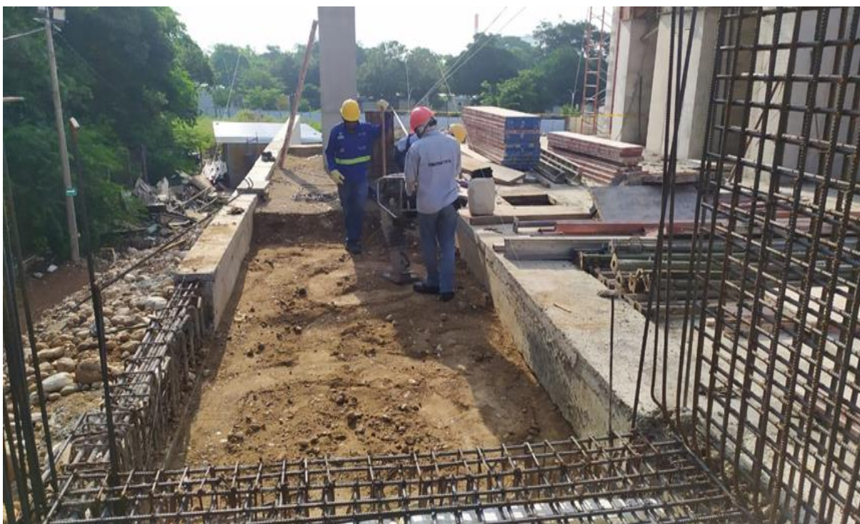
Ilustración 27 Compactación de Relleno
