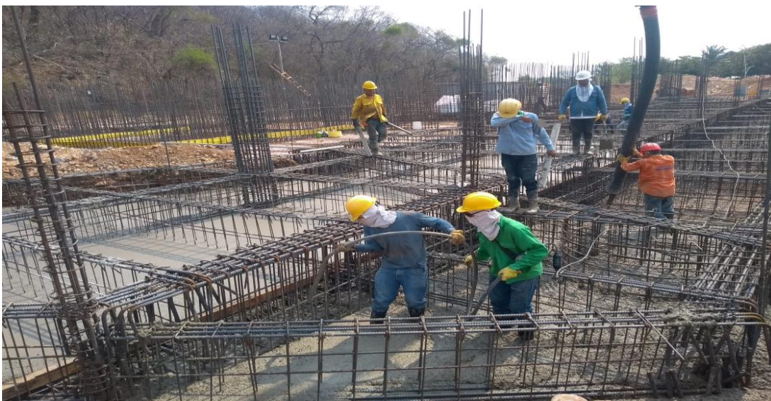
Ilustración 9 Fundida de placa de cimentación
