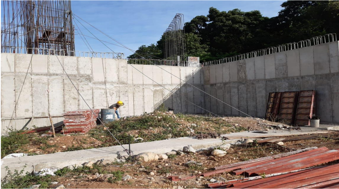
Ilustración 16 Muro de Contención Vista Frontal
