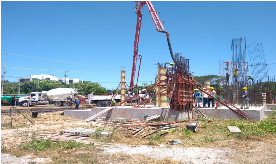
Ilustración 14 fundida de pantallas y columnas circulares
