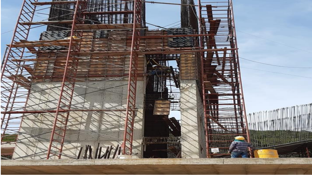
Ilustración 29 Instalación de Pernos
