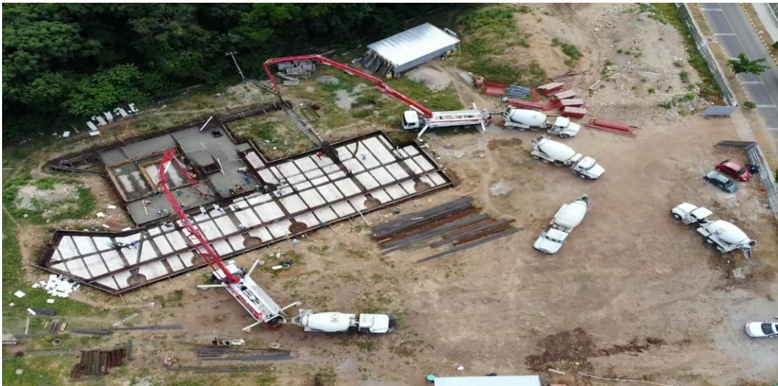
Ilustración 3 Fundida de placa de cimentación
