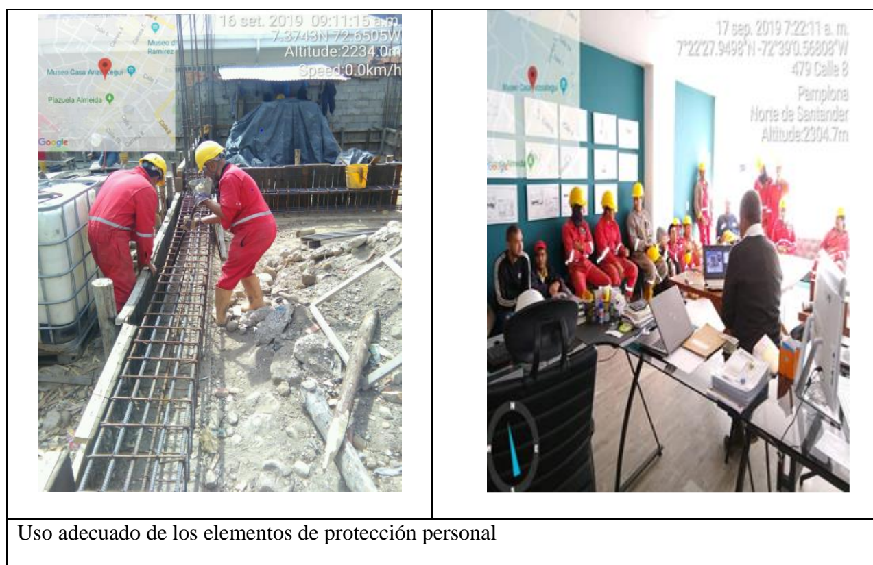
Ilustración 16. Registro fotográfico sobre elementos de protección personal.
