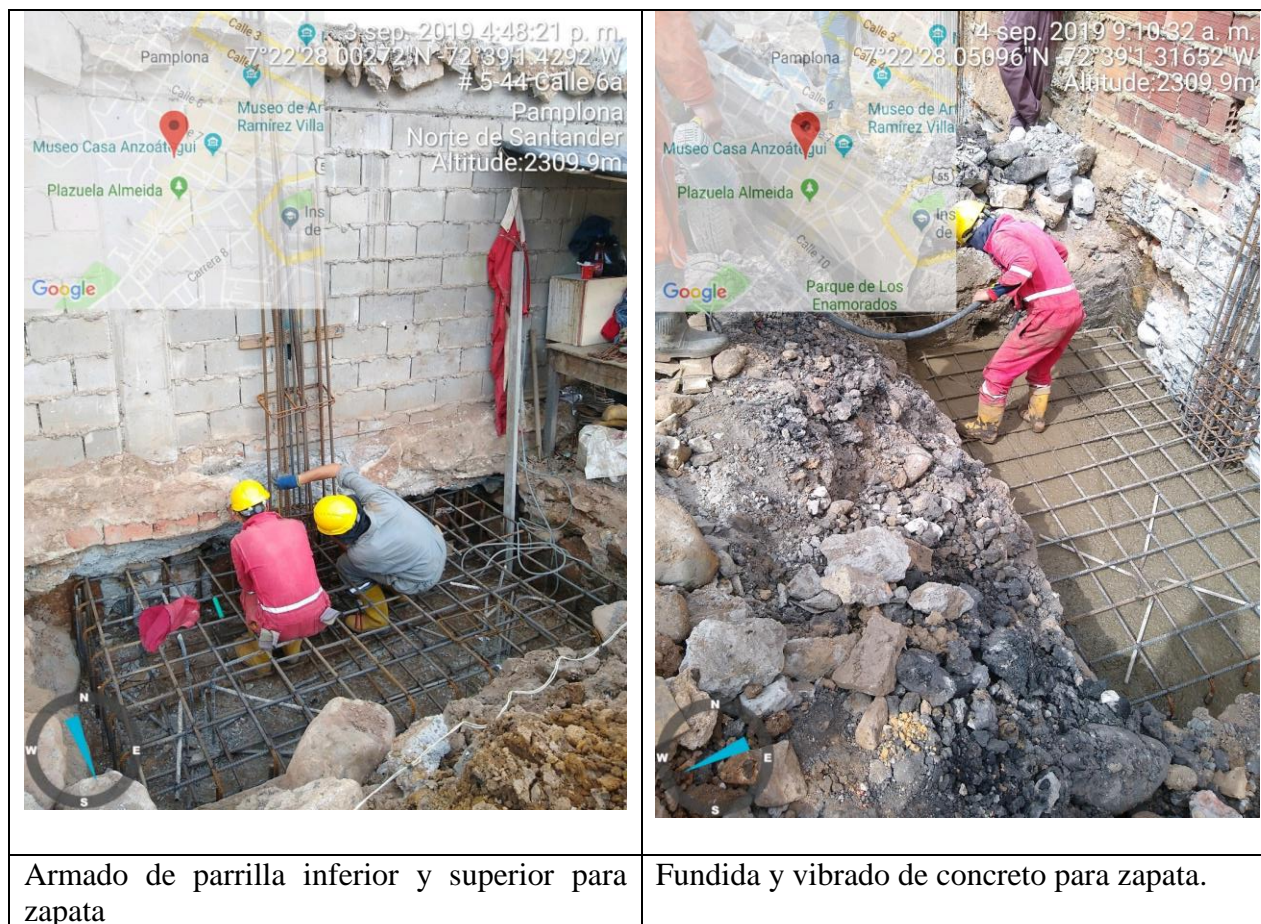
Ilustración 17. Registro fotográfico sobre el proceso de construcción de zapatas
