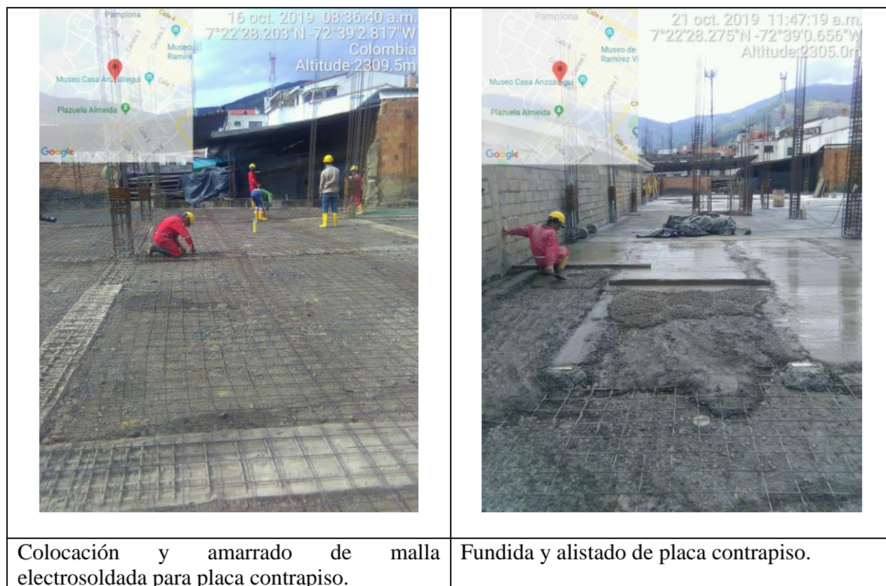
Ilustración 20. Proceso de construcción de placa contrapiso.
