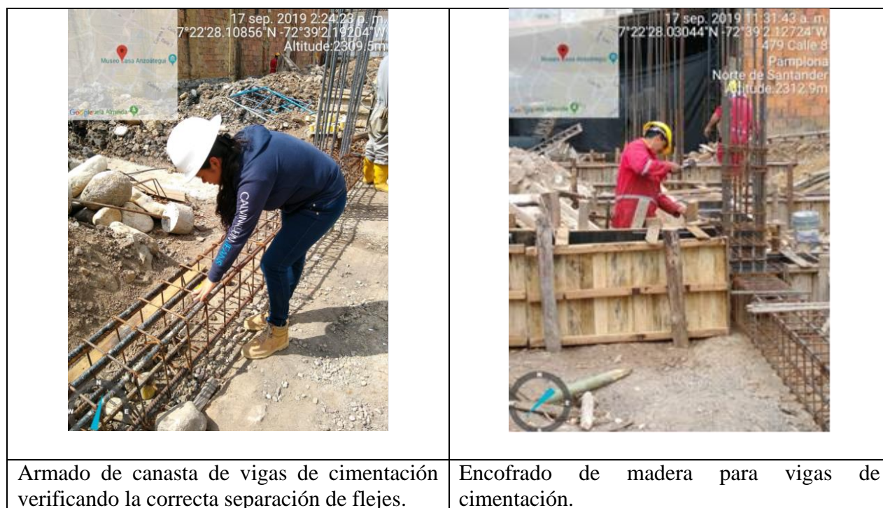
Ilustración 18. Proceso constructivo de vigas de cimentación.
