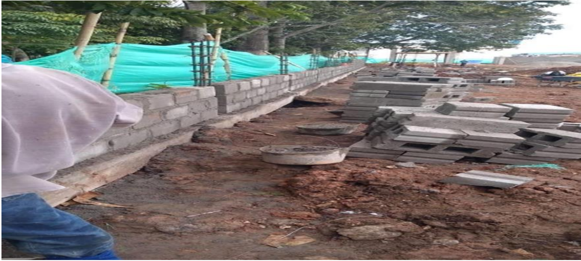
Ilustración 30. Mampostería cerramiento perimetral estadio de Puerto Wilches.
