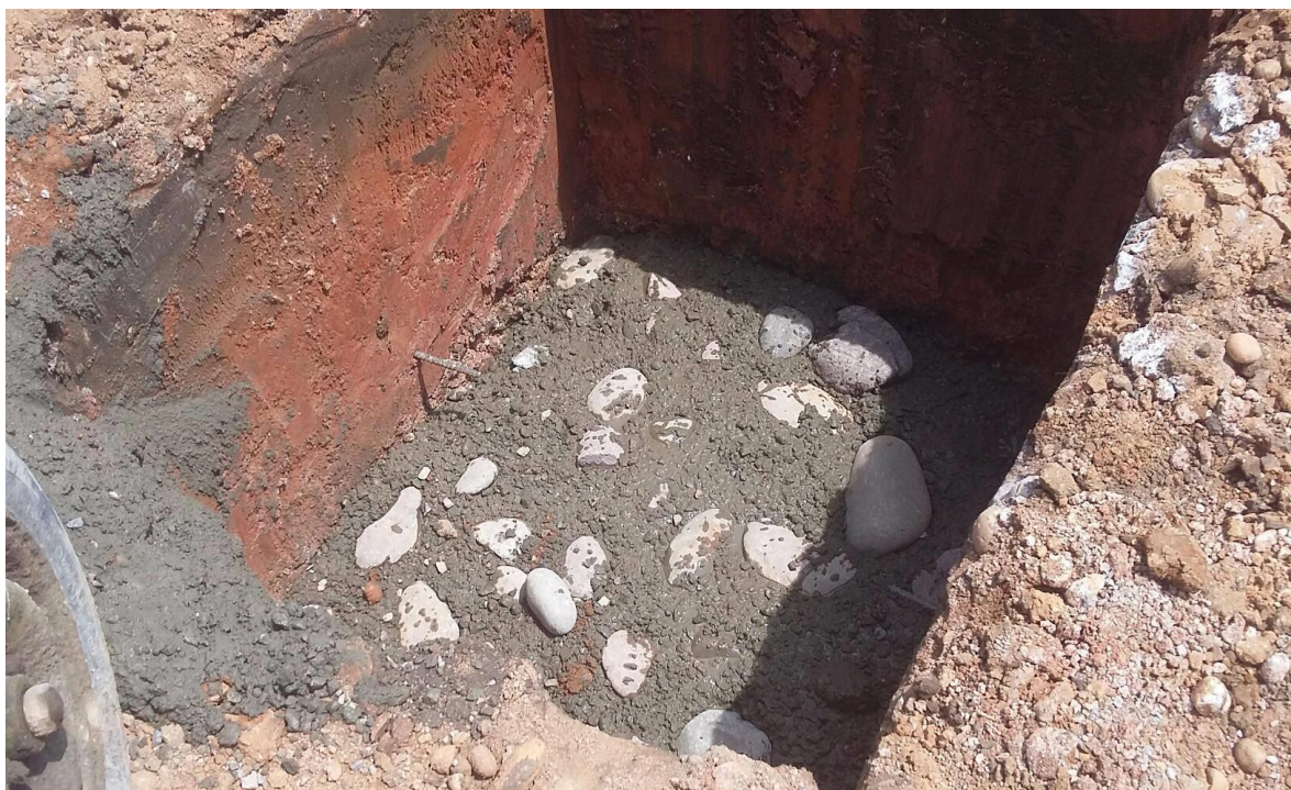
Ilustración 27. Concreto ciclópeo zapata de gradería estadio de Puerto Wilches.
