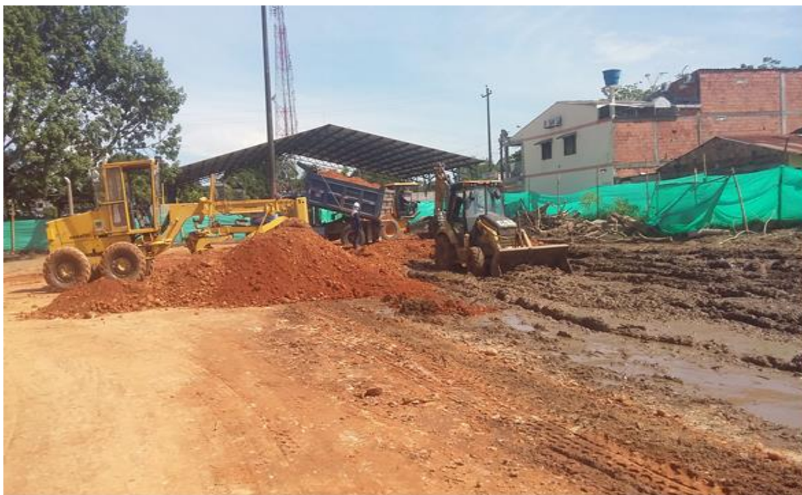
Ilustración 13. Relleno con material seleccionado y retiro de material vegetal.
