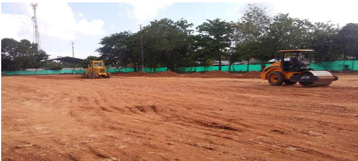
Ilustración 12. Relleno con material seleccionado y compactado.
