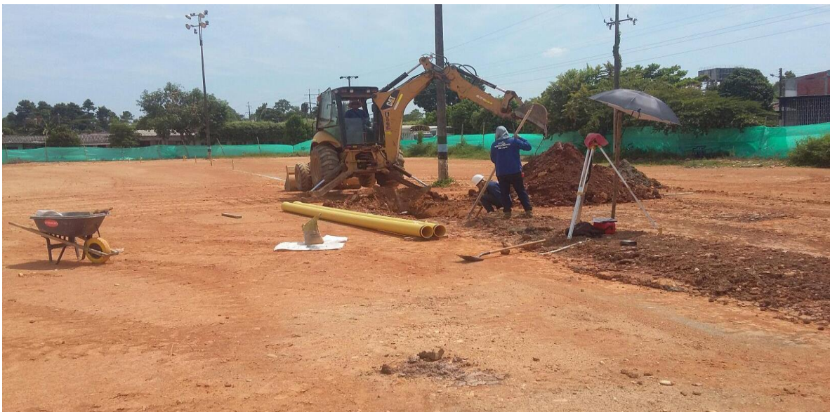
Ilustración 25. Instalación red de drenaje estadio de Puerto Wilches.
