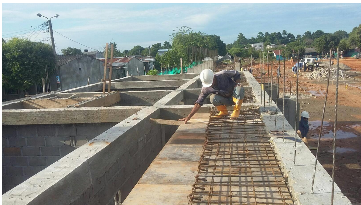
Ilustración 29. Armado viga canal zona de oficinas estadio de Puerto Wilches.
