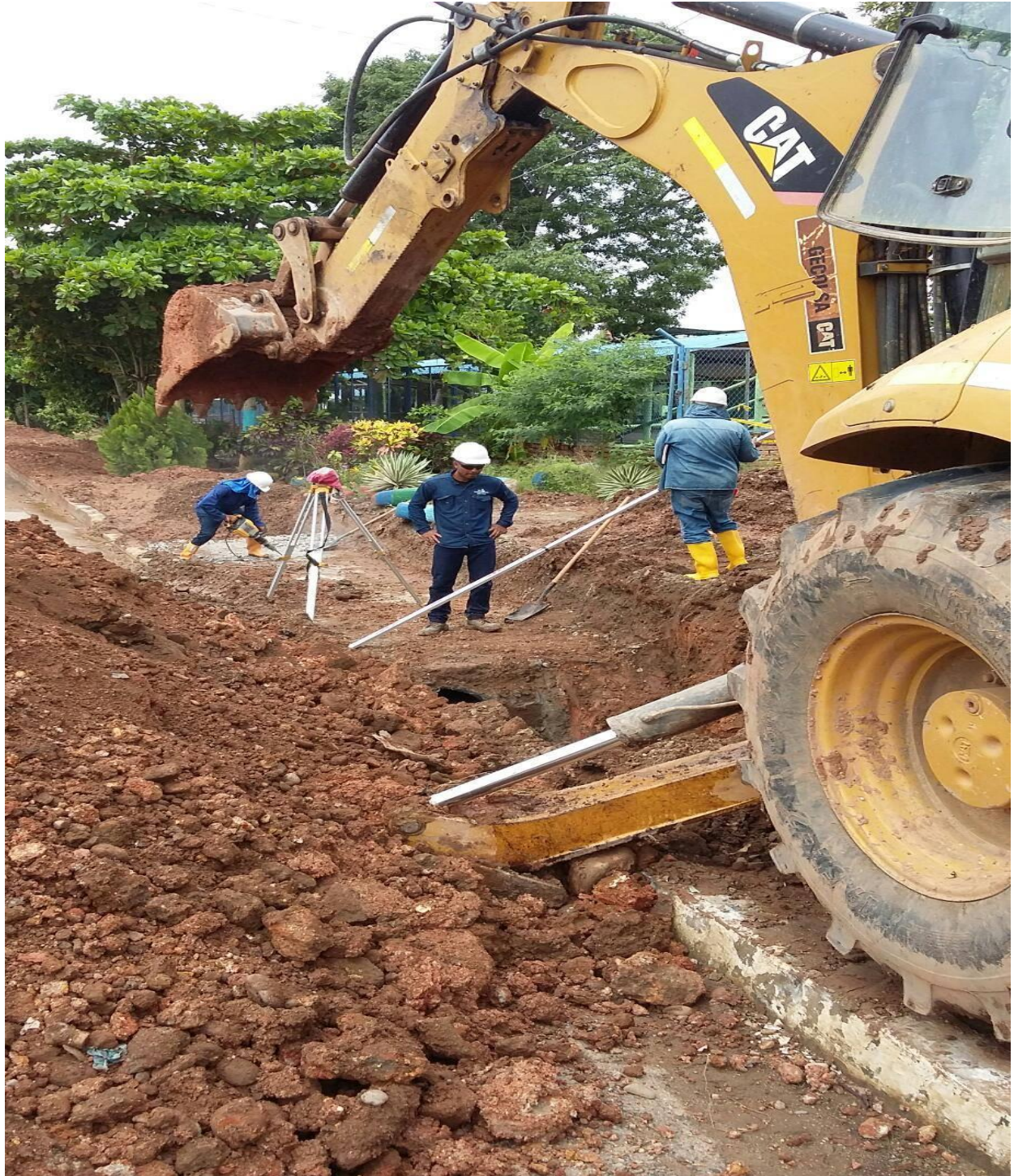
Ilustración 15 excavación para tubería de alcantarillado pluvial
