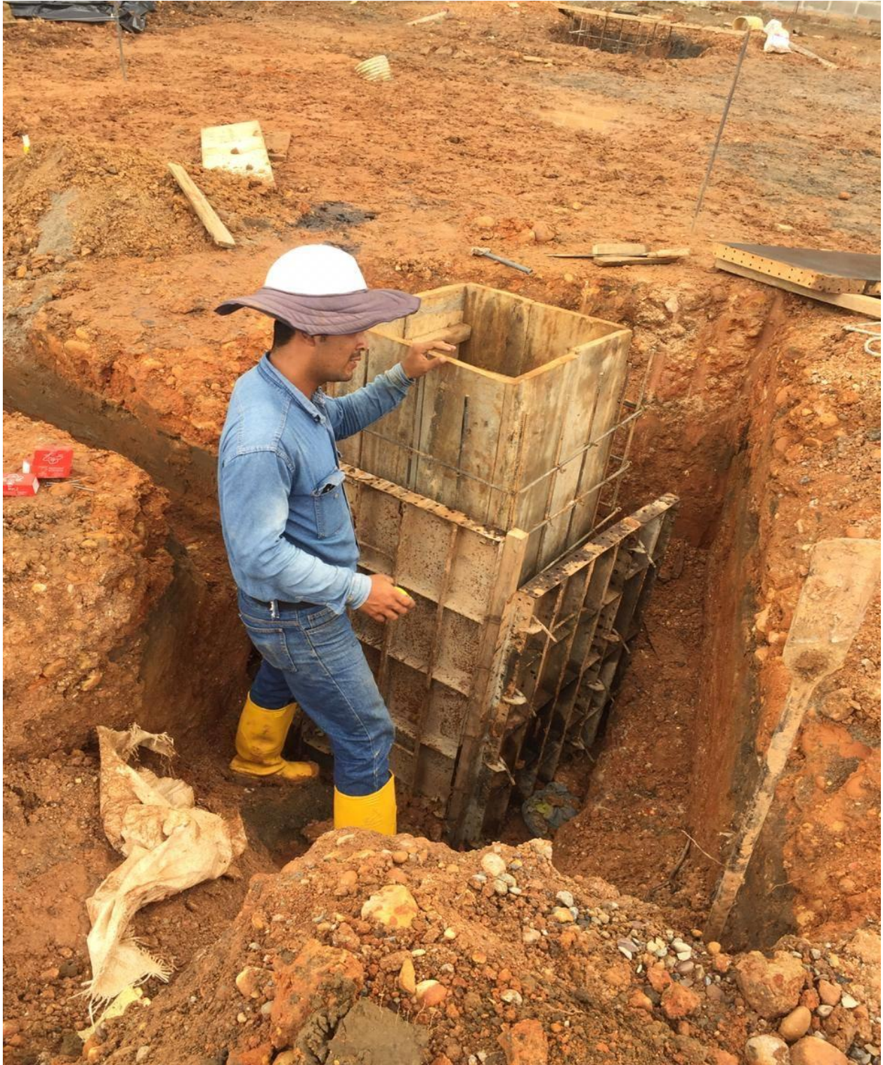
Ilustración 28 control sobre encofrado de pozo de inspección red de drenaje
