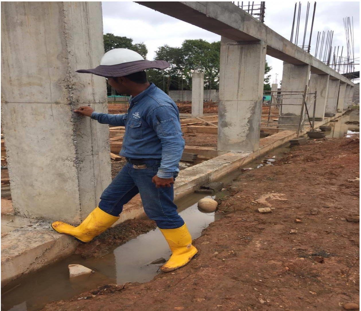
Ilustración 33 Hormigoneo de concreto en columna de gradería
