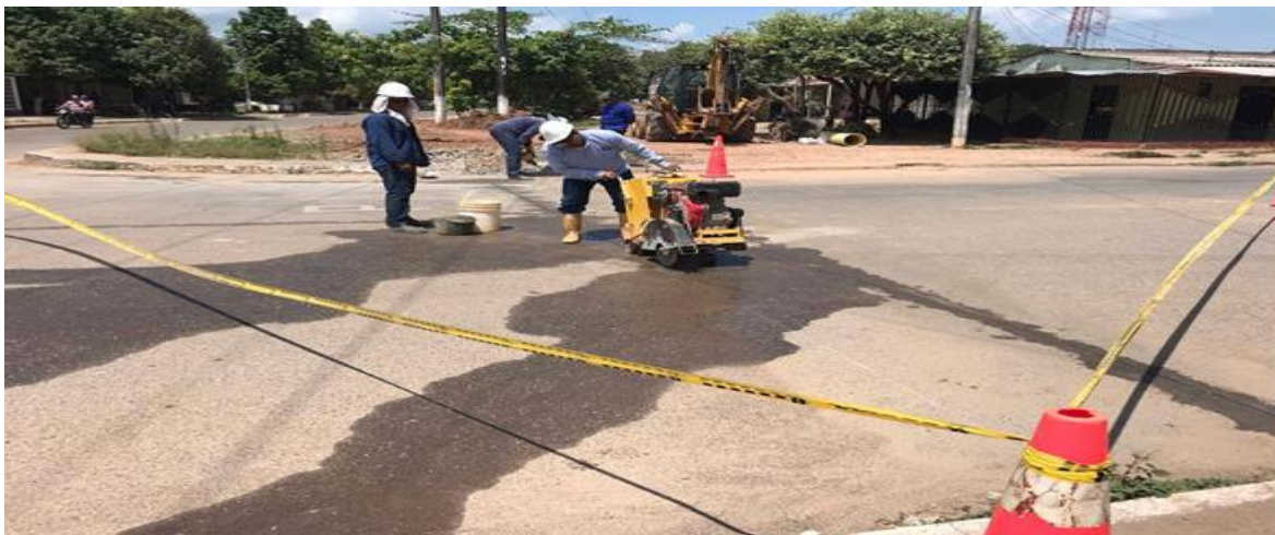
Ilustración 18. Corte de pavimento flexible.
