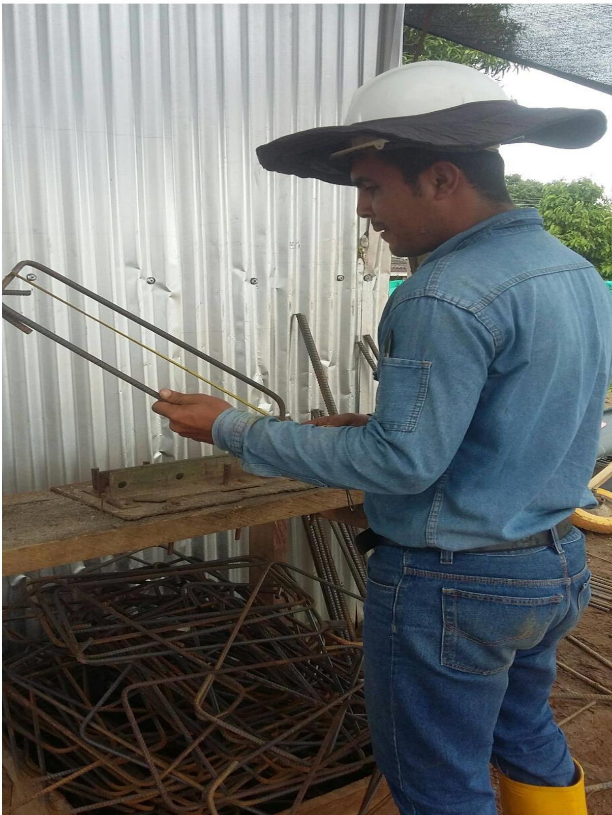
Ilustración 22 control sobre el figurado de acero
