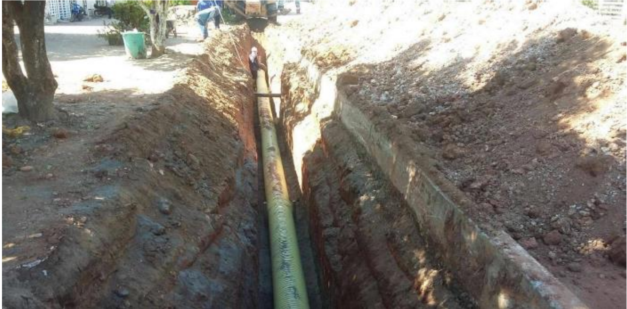
Ilustración 17. Instalación de alcantarillado pluvial a la altura del barrio la ceiba.
