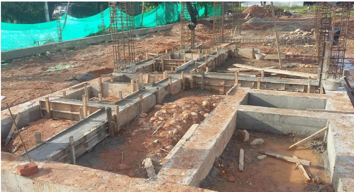
Ilustración 31. Viga de cimentación de muros zona de gradería estadio de Puerto Wilches.
