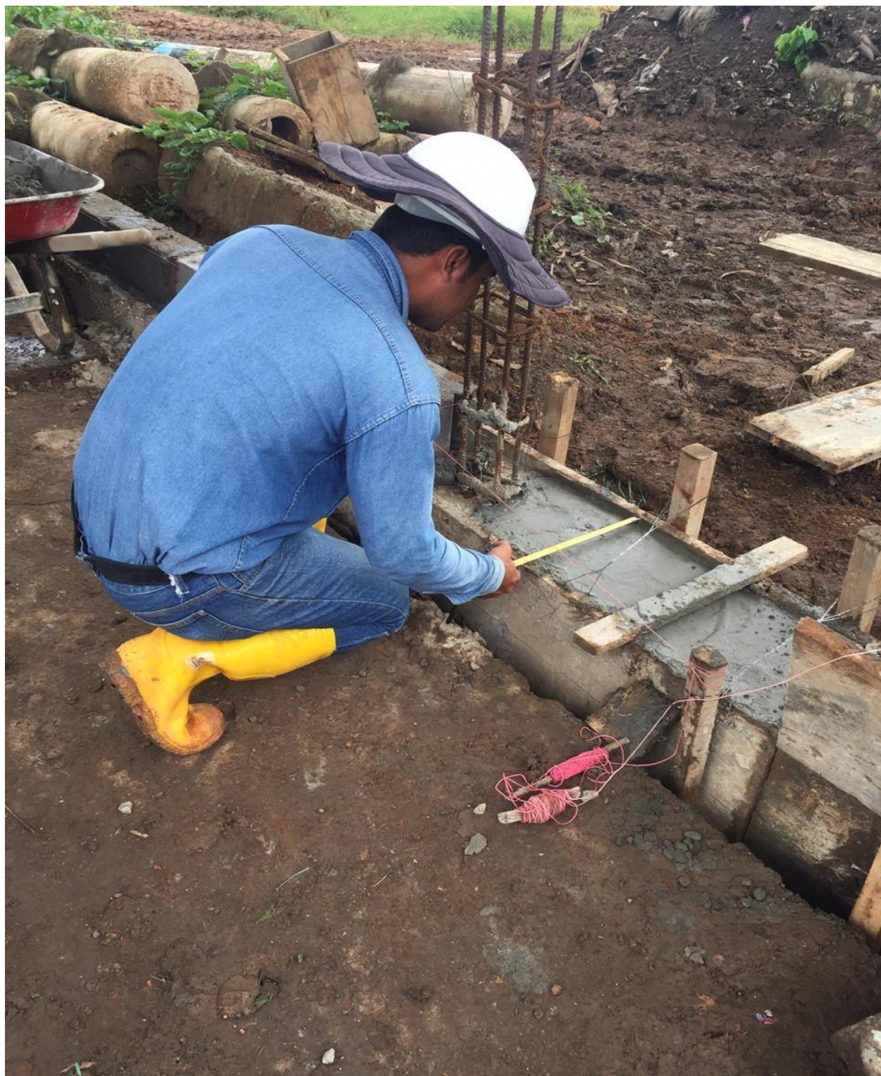
Ilustración 32 control sobre viga de cimentación cerramiento
