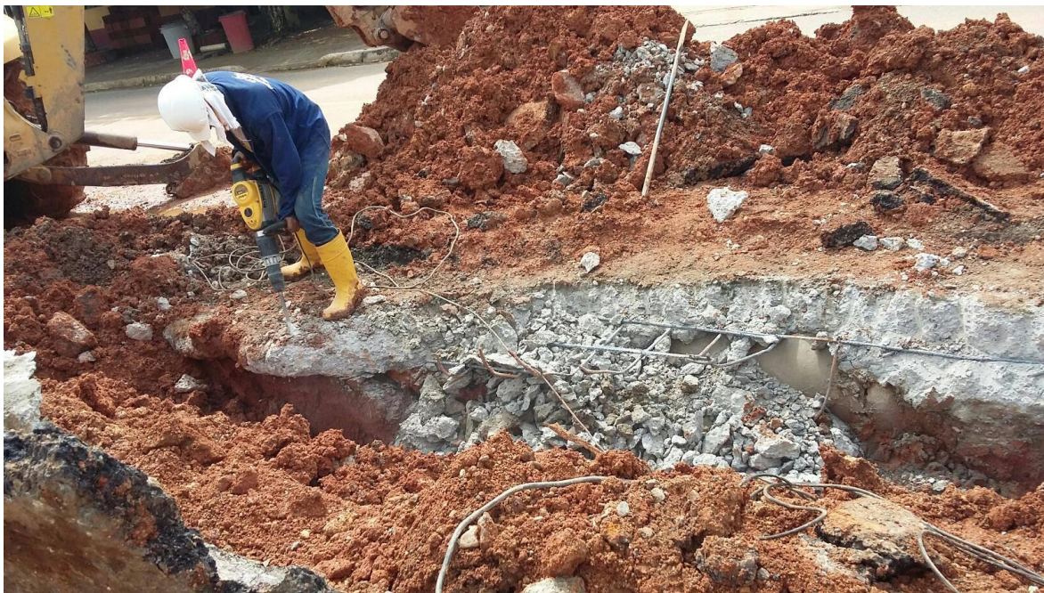
Ilustración 16. Demolición placa de concreto reforzado.
