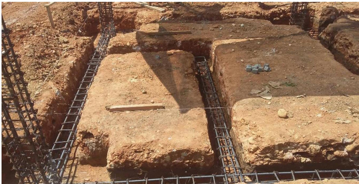
Ilustración 26. Cimentación zona de portería.
