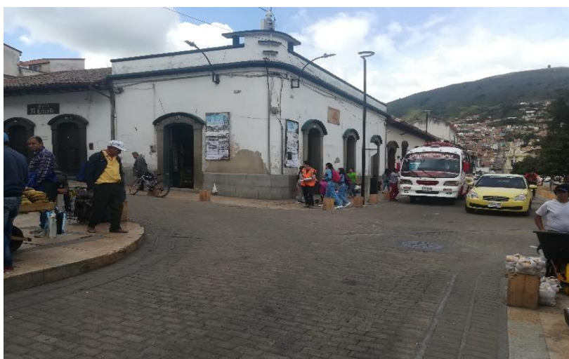
Figura 17. Estado actual de la intersección calle 6 con carrera 5.
