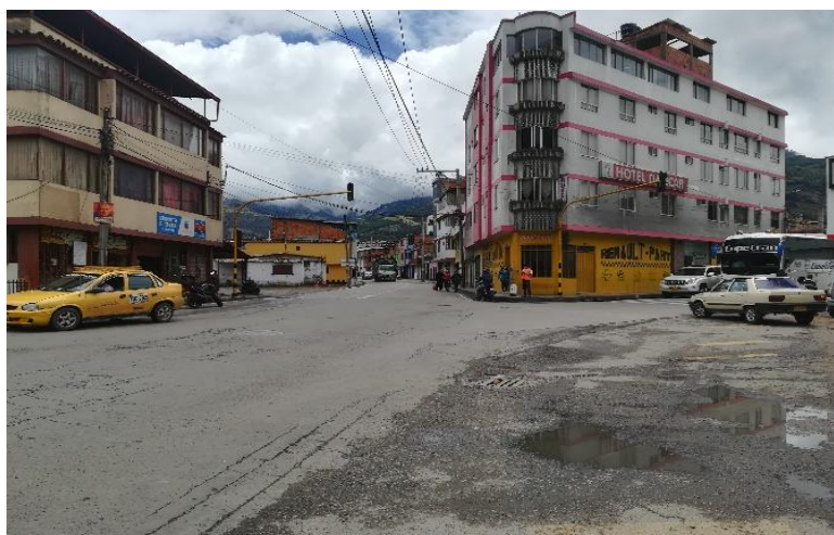
Figura 21. Estado actual intersección calle 4 con carrera 9, sector Norte - Sur.
