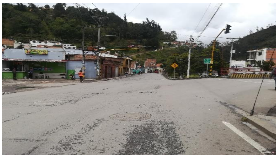
Figura 22. Estado actual de la intersección calle 4 con carrera 9, sentido Oeste – Este.
