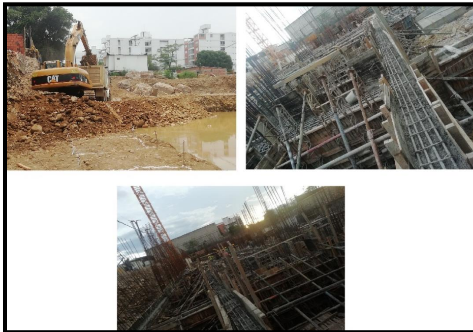
Ilustración 8 Muestra la etapa de cimentación y fundida de vigas.
