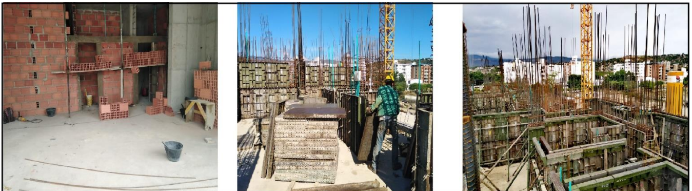
Ilustración 4 Muestra el proceso llevado a cabo para el sistema de industrializado y mampostera.
