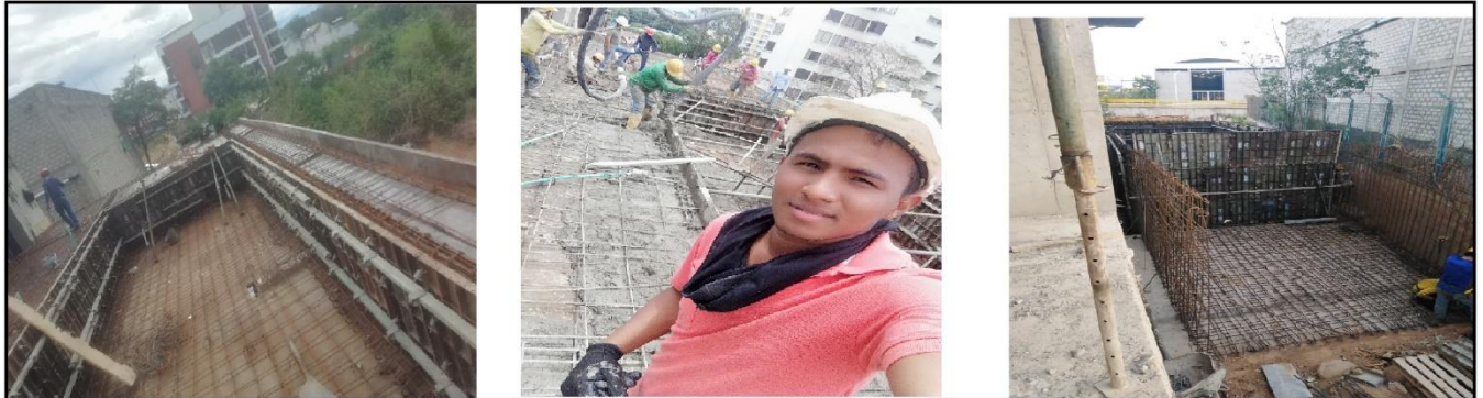
Ilustración 3 Muestra el proceso llevado a cabo de elaboración de áreas comunes, como son piscinas, tanque de almacenamiento de agua, cuarto hidroneumático y zonas de recreación.
