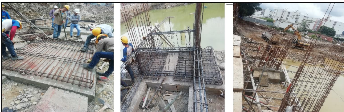
Ilustración 1 Detalles de elaboración de zapatas en cimentación. Fuente: Elaboración propia del autor.
