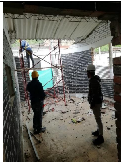
Ilustración 23. Transporte horizontal de cubierta.
