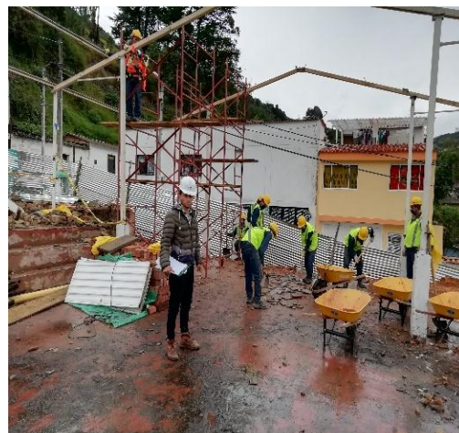
Ilustración 17. Demolición de piso.
