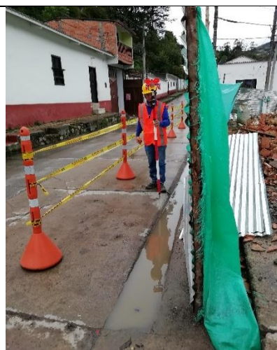
Ilustración 25. Localización y replanteo de ejes.
