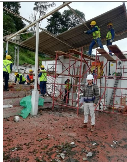
Ilustración 15. Demolición de cubierta.
