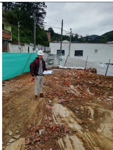
Ilustración 16. Demolición de piso.
