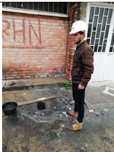
Ilustración 18. Demolición de caja de inspección aguas negras.
