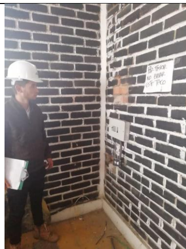
Ilustración 19. Demolición de caja de inspección eléctrica.
