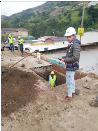
Ilustración 38. Excavación manual.
