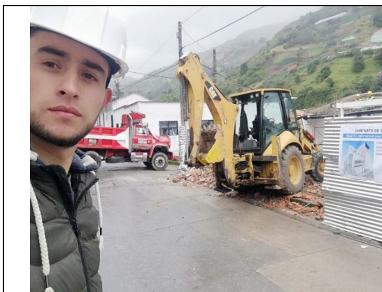
Ilustración 20. Retiro mecánico de escombros.
