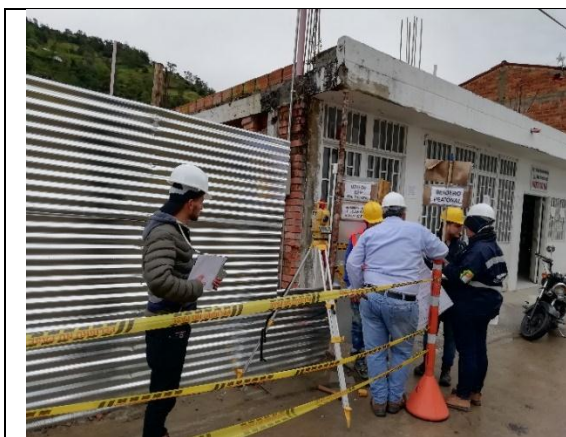
Ilustración 24. Localización y replanteo de ejes.
