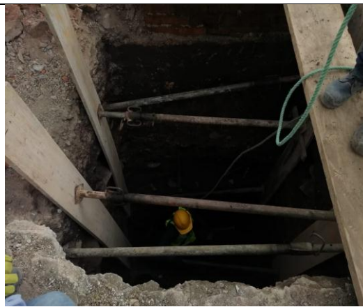
Ilustración 39. Entibación de la excavación.
