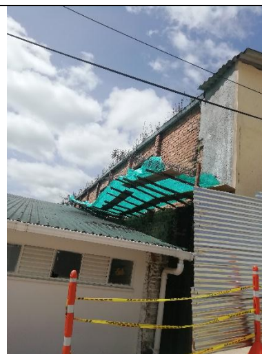
Ilustración 37. Muro de protección (palomera).
