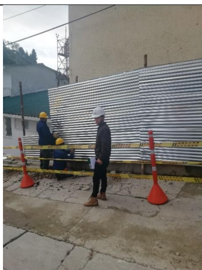
Ilustración 26. Cerramiento en zinc.
