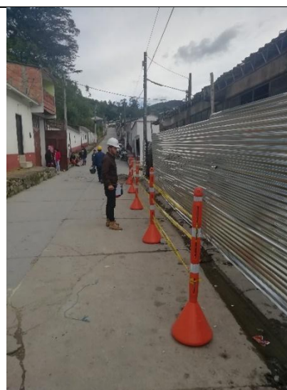
Ilustración 27. Cerramiento en zinc.
