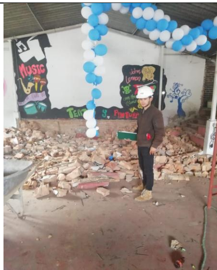
Ilustración 14. Demolición de muros.
