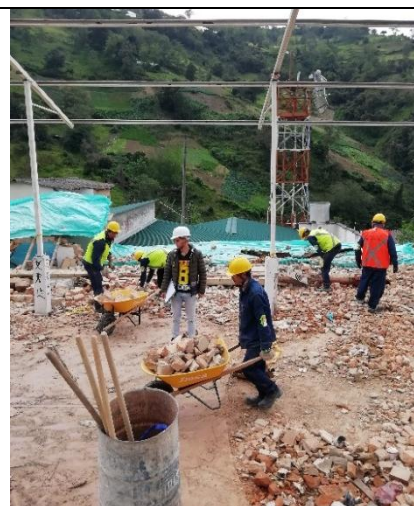
Ilustración 21. Retiro manual de escombros.
