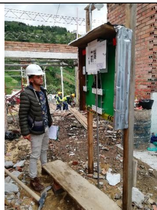
Ilustración 33. Provisional de línea de energía.
