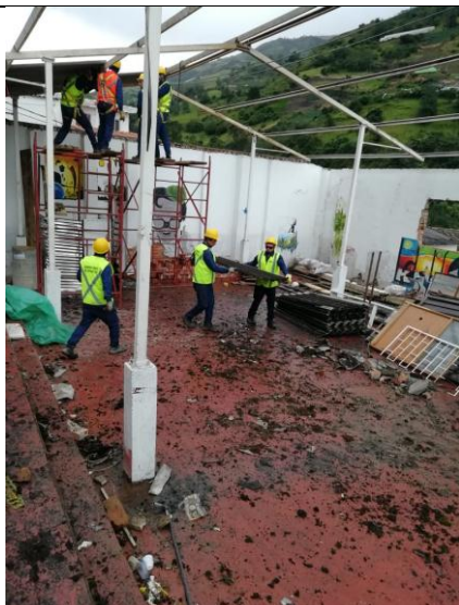
Ilustración 22. Transporte horizontal de cubierta.
