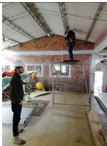
Ilustración 31. Desconexión de línea de energía.
