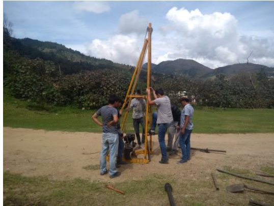
Figura 17: Ensamblaje del equipo de SPT. Fuente: Foto in situ.
