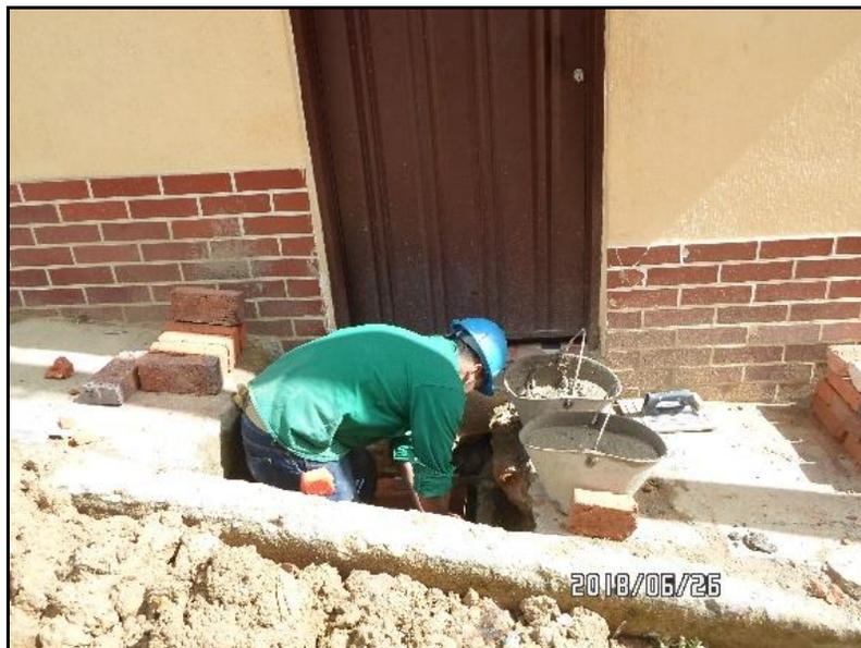
**Figura 21.** Cajas de inspección final.
