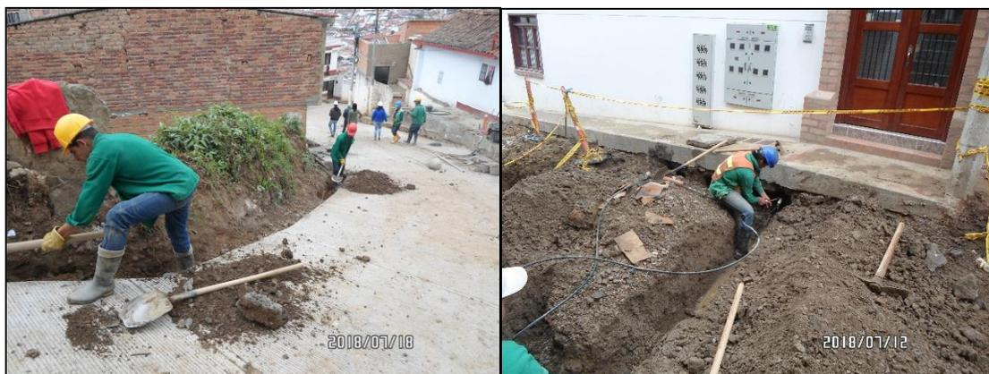
**Figura 39.** Ejemplo de indumentaria para Obrero y Señalización con cinta peligro.
