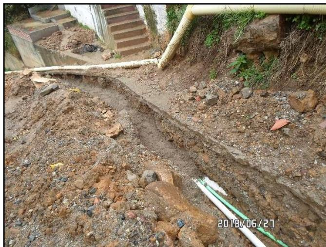
**Figura 17.** Suministro e instalación tubo 3" y 2" UM RDE 21, para agua potable.
