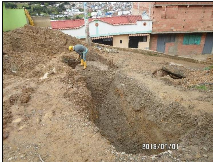
**Figura 11.** Subrasante con material de excavación.
