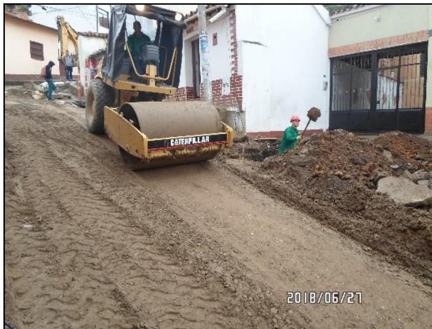
**Figura 18.** Sub base granular compactada.
