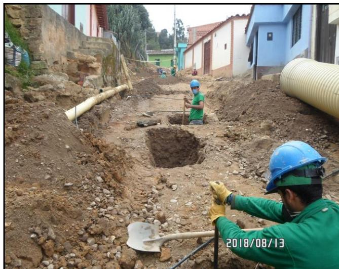
**Figura 8.** Excavación manual.
