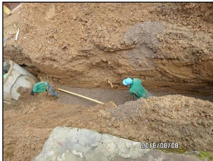
**Figura 12.** Base Cimentación De Tubería.
