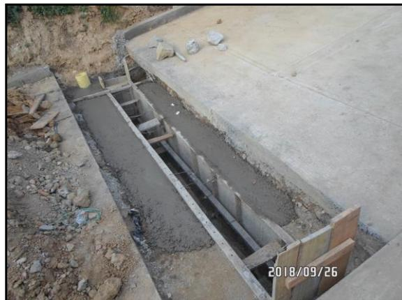
**Figura 22.** Concreto reforzado  $f_c=21$  mpa (sumideros).
