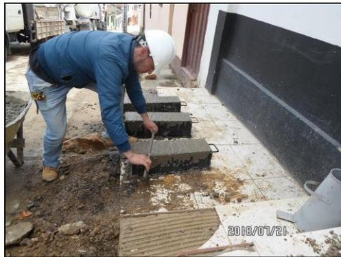
**Figura 37.** Muestreo para ensayos de flexión en vigas.
