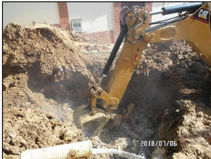
Figura 9. Excavación mecánica.
