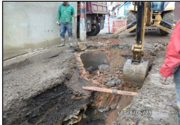
**Figura 6.** Demolición de pozos de inspección existentes.
