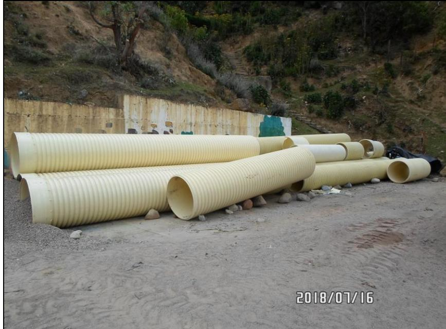
**Figura 30.** Almacenamiento de tubería madre en espacios abiertos.
