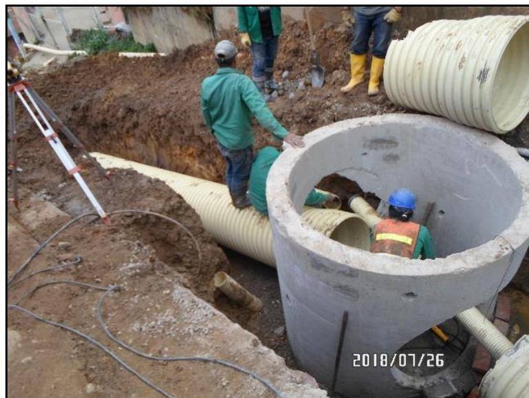
**Figura 13.** Tendido de tubería madre (24", 27", 30" y 33").
