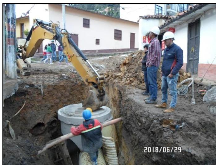
**Figura 14.** Instalación de pozos de inspección prefabricados.
