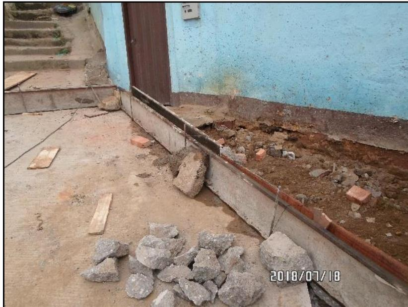
**Figura 20.** Sardinel en concreto vaciado in situ.
