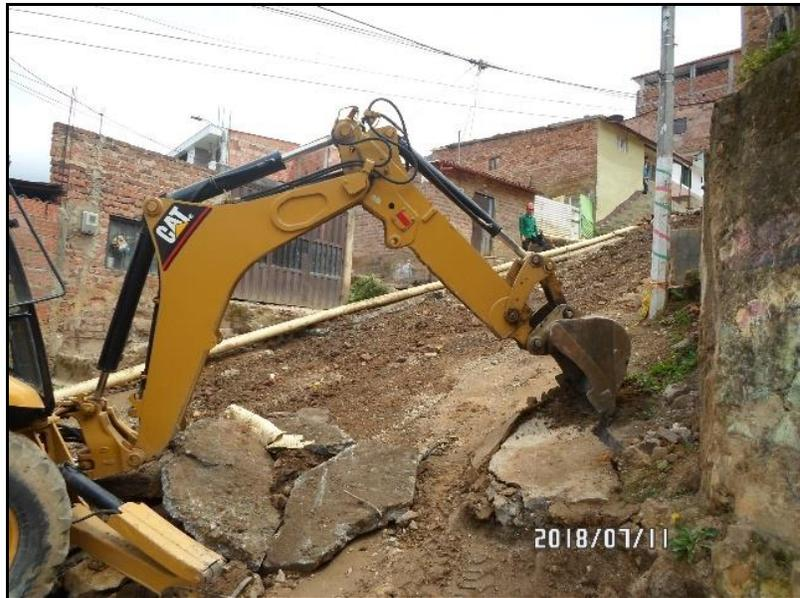
**Figura 10.** Demolición de pavimento existente.
