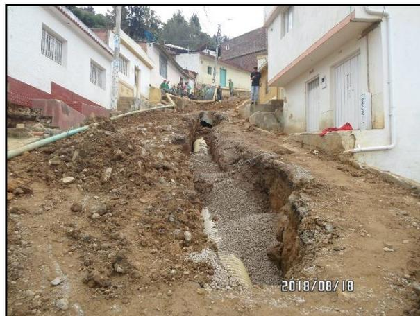
**Figura 7.** Tendido de tubería adicional para redireccionamiento de aguas residuales.
