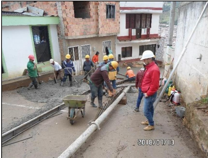
Figura 19. Pavimento de concreto hidráulico MR-41  $e=0.15\text{mt}$ , incluye junta.
