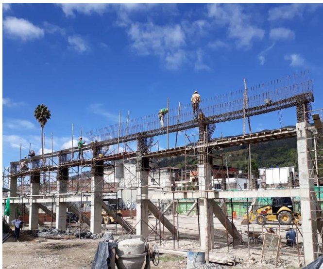
Ilustración 47 viga canal
