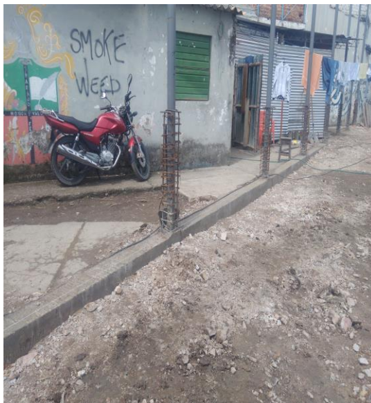
Ilustración 75 viga de cimentación
