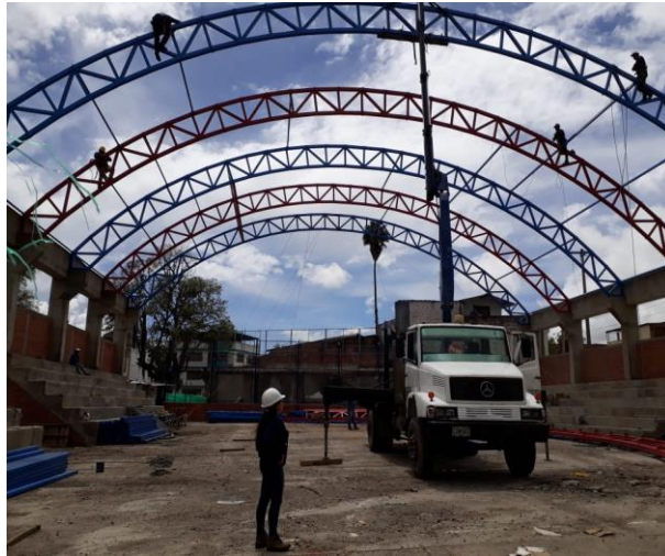
Ilustración 85 izado de estructura
