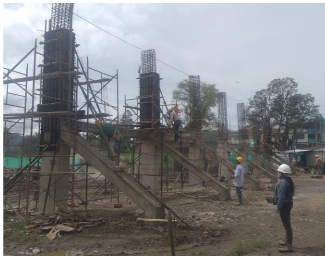
Ilustración 38 formaletas columnas
