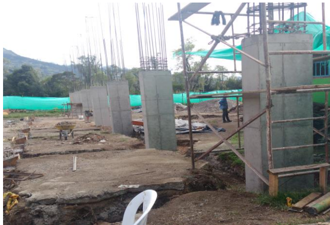
Ilustración 23 desencofrado de columnas
