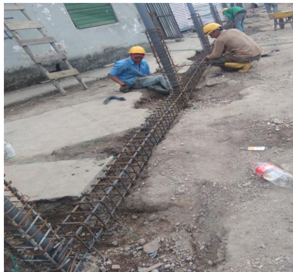
Ilustración 72 acero viga de cimentación
