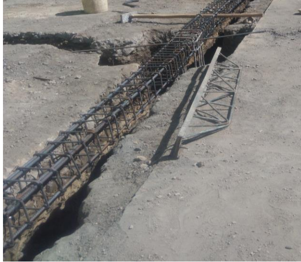
Ilustración 12 acero de viga de cimentación tipo 3
