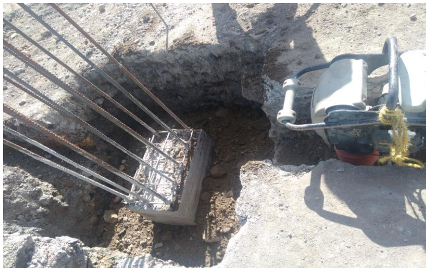
Ilustración 5 relleno con material seleccionado
