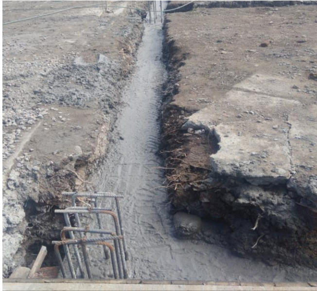
Ilustración 13 concreto de vigas de cimentación
