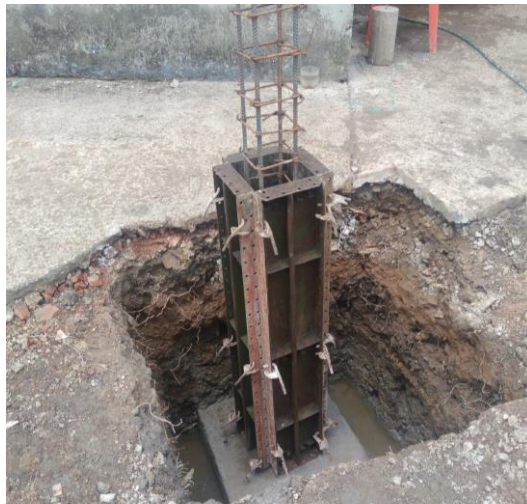
Ilustración 74 zapata y pedestal de muro
