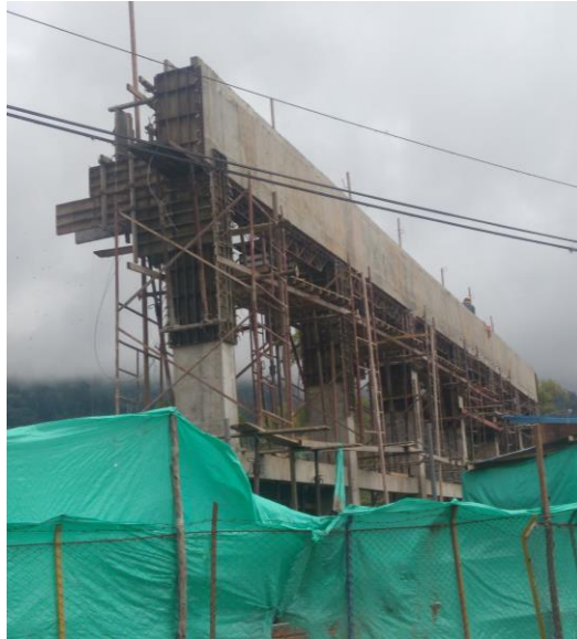
Ilustración 51 concreto viga canal
