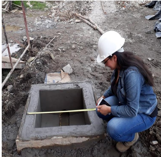
Ilustración 93 verificación de dimensiones
