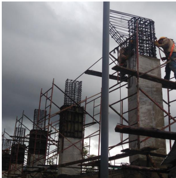
Ilustración 43 armado de acero ménsula
