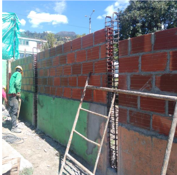
Ilustración 65 acero columnetas muro
