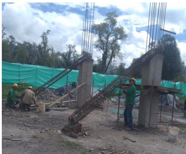
Ilustración 28 acero de vigas inclinadas
