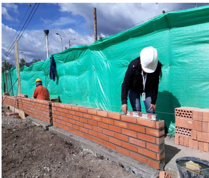
Ilustración 77 verificación de nivel de muro
