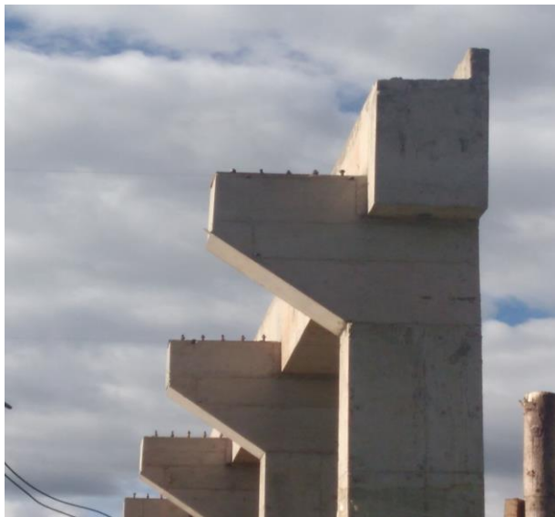
Ilustración 52 concreto ménsulas
