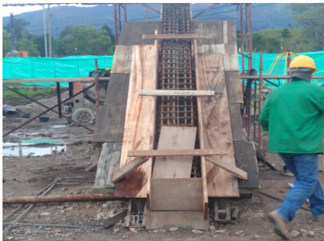
Ilustración 31 encofrado de viga inclinada
