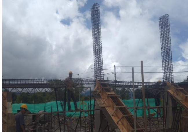
Ilustración 33 armado de acero viga aérea
