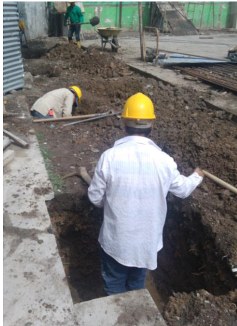
Ilustración 68 excavación para zapatas muro ladrillo a la vista
