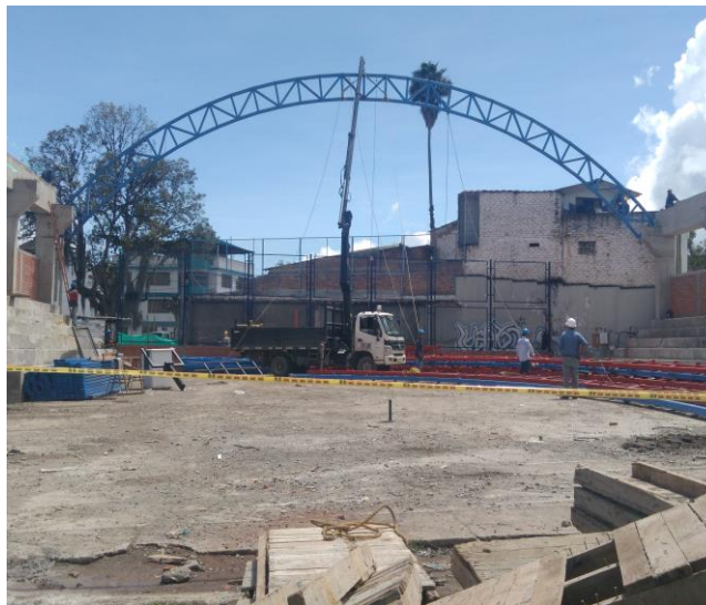
Ilustración 82 izado de estructura
