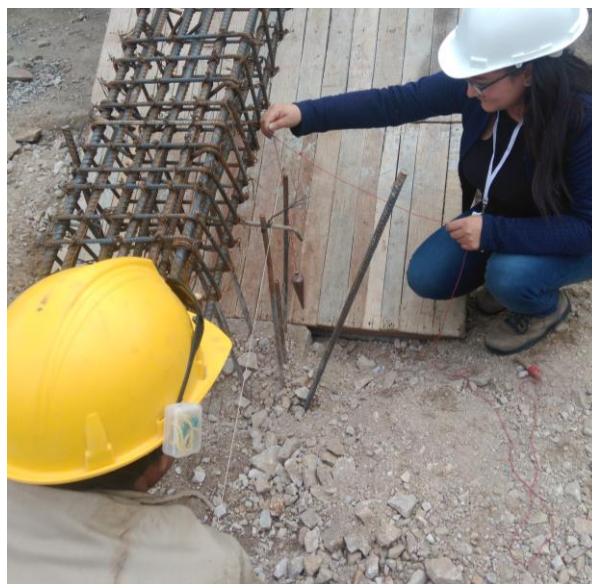
Ilustración 30 verificación de verticalidad
