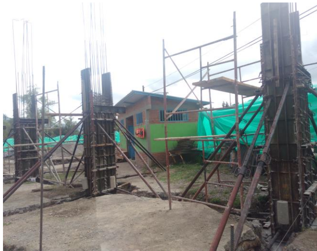
Ilustración 22 fundida de columnas ejes 1 y 2
