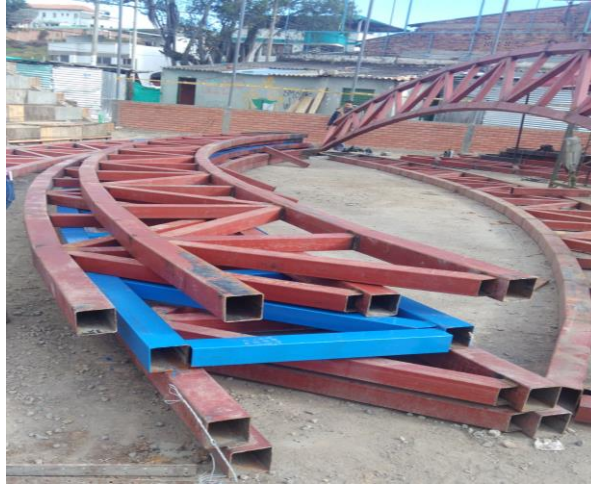
Ilustración 81 estructura metálica armada
