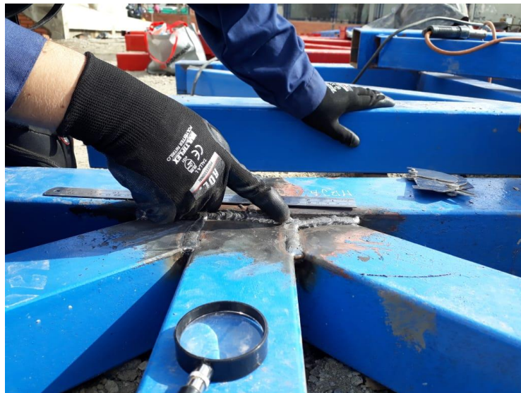
Ilustración 111 prueba de inspección visual a estructura metálica
