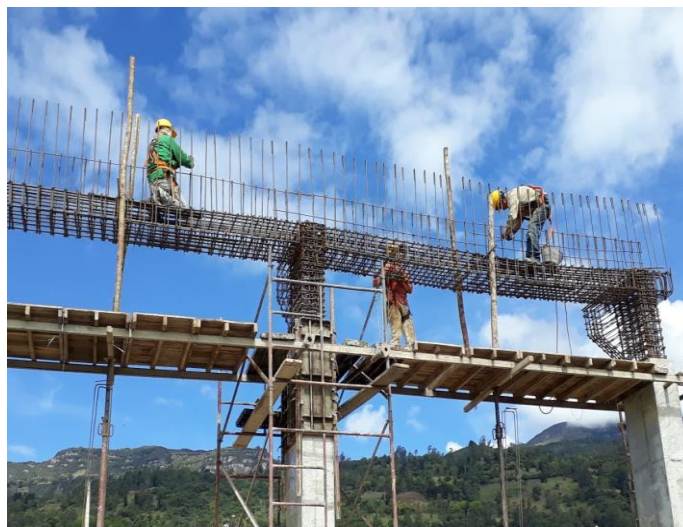
Ilustración 46 acero de viga canal
