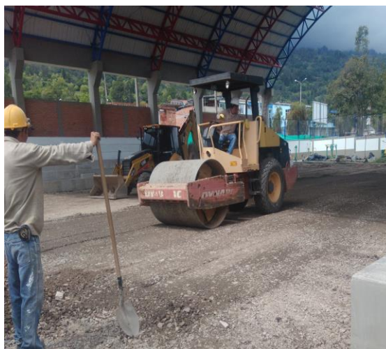
Ilustración 97 instalación de base
