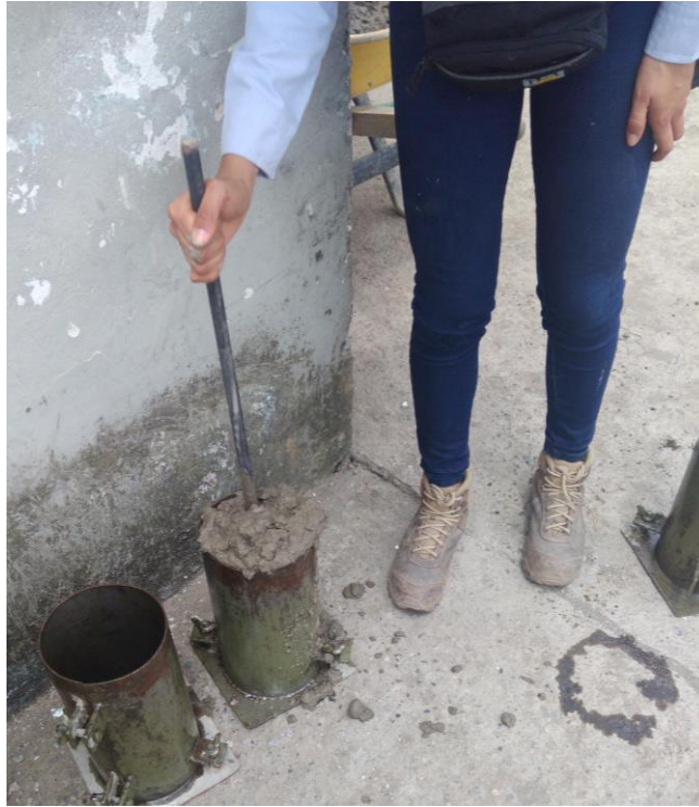
Ilustración 104 cilindros para prueba de resistencia concreto de columnas
