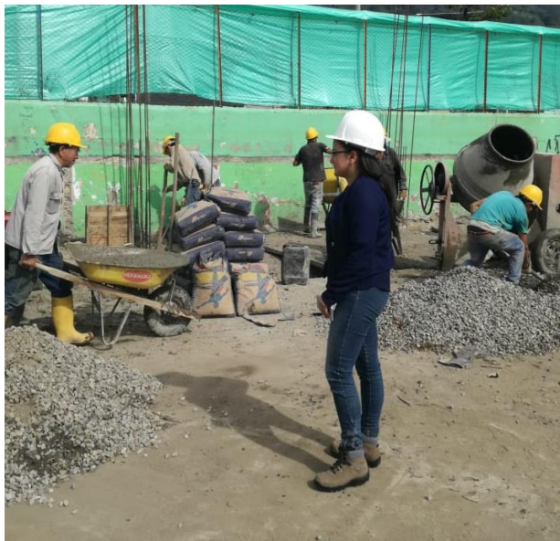
Ilustración 14 Elaboración de concreto
