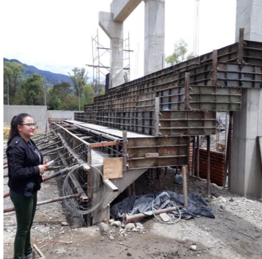
Ilustración 60 concreto de gradería
