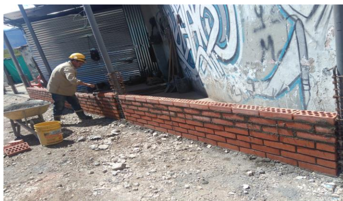
Ilustración 76 muro ladrillo a la vista
