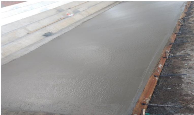
Ilustración 99 varillas de anclaje unión de losas
