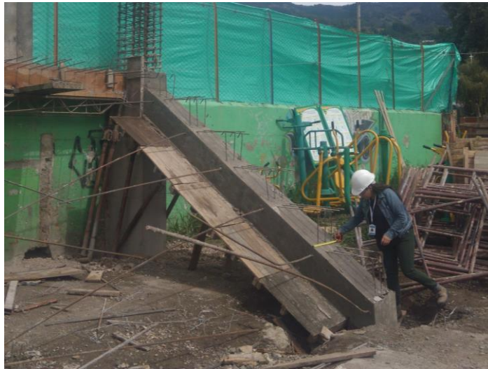
Ilustración 37 verificación de medidas
