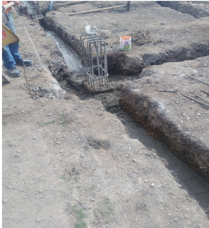
Ilustración 7 fundición de solados en vigas de cimentación
