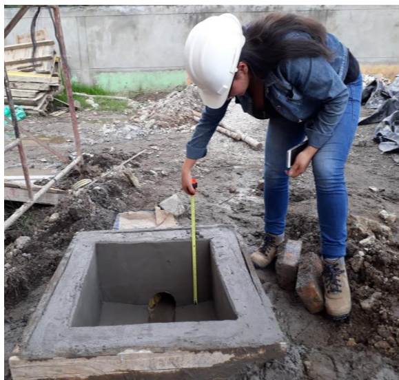
Ilustración 92 verificación de dimensiones
