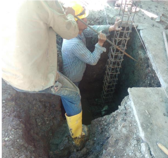
Ilustración 71 acero zapatas y columnetas
