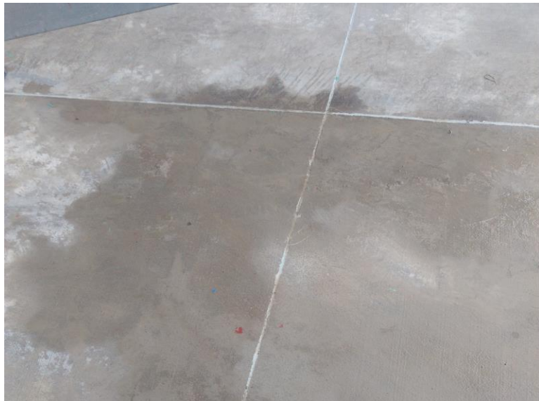
Ilustración 103 sello juntas de dilatación
