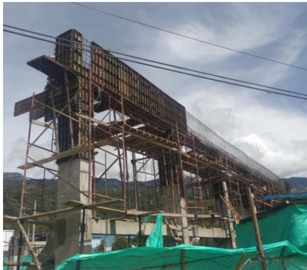
Ilustración 50 formaleta viga canal
