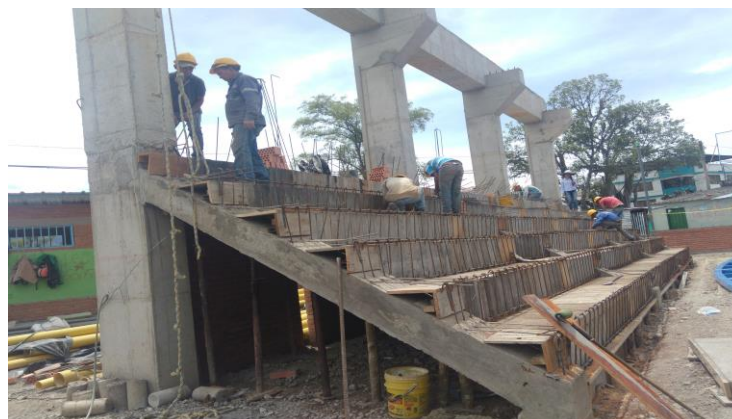
Ilustración 57 acero de refuerzo de gradería
