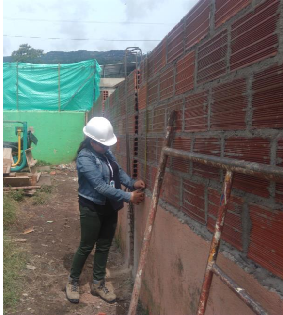
Ilustración 64 verificación de medidas muro
