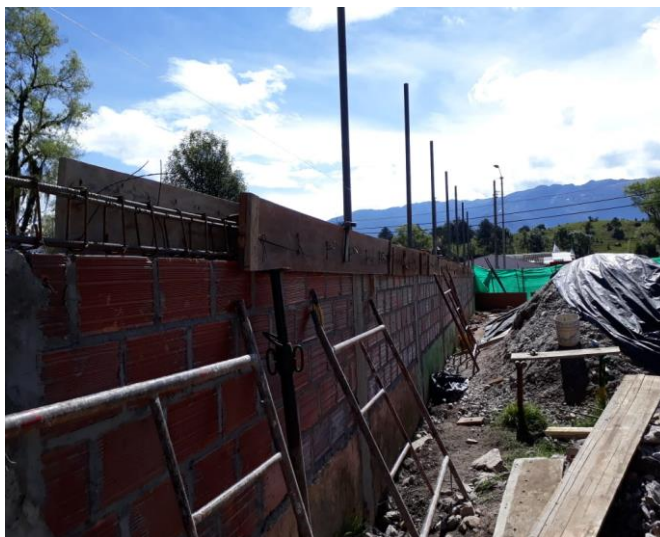
Ilustración 66 construcción de viga cinta y columnetas
