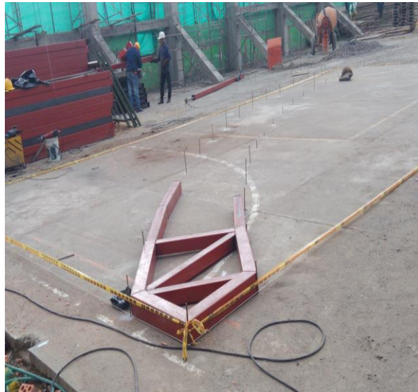
Ilustración 80 inicio armado de estructura metálica
