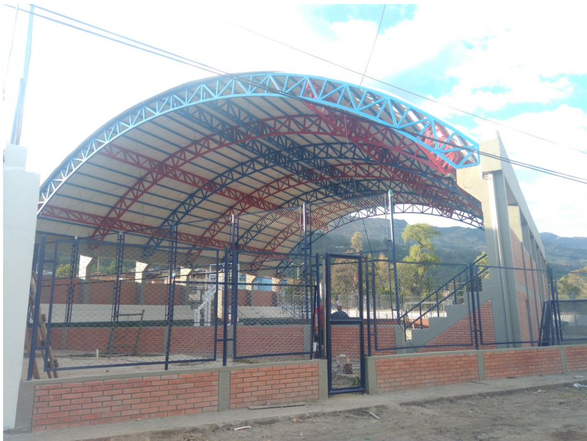
Ilustración 112 Estado final polideportivo Camellón
