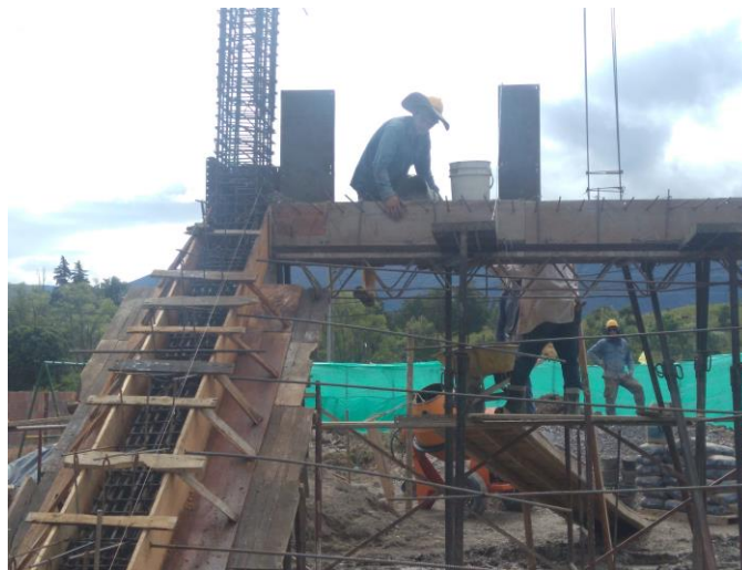
Ilustración 36 concreto viga aérea
