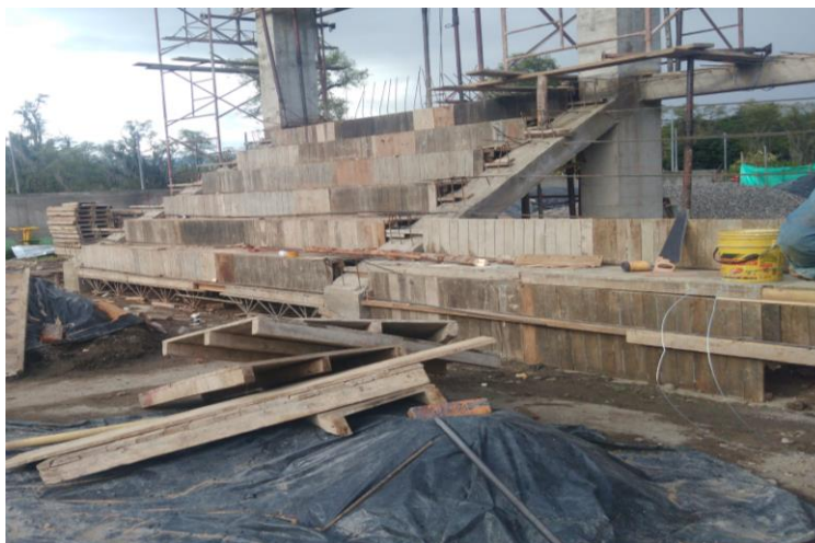
Ilustración 53 formaleta para gradería
