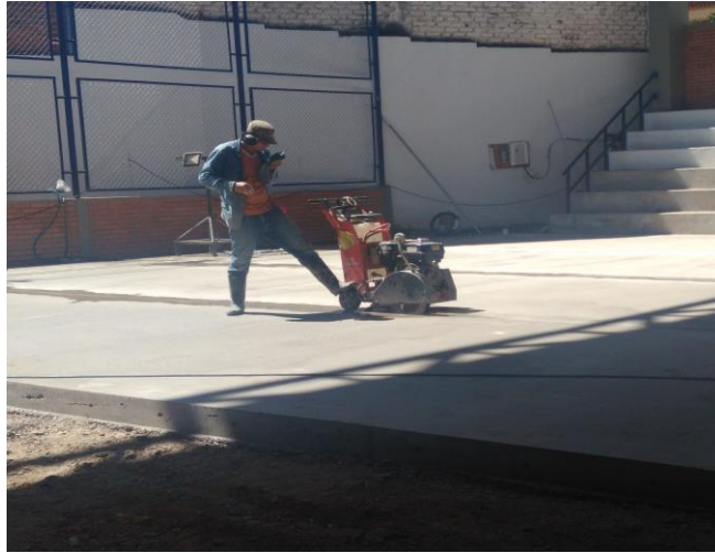
Ilustración 102 cortes longitudinales juntas de dilatación
