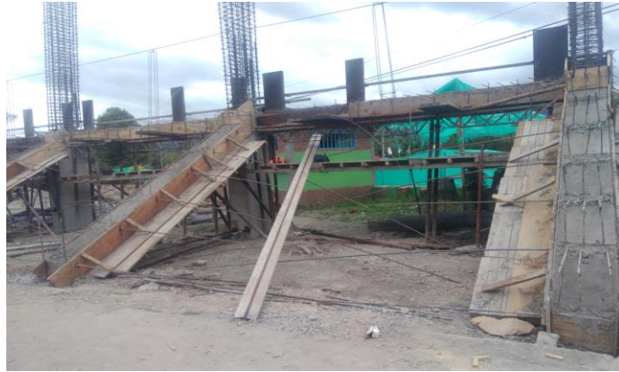
Ilustración 35 concreto de viga inclinada
