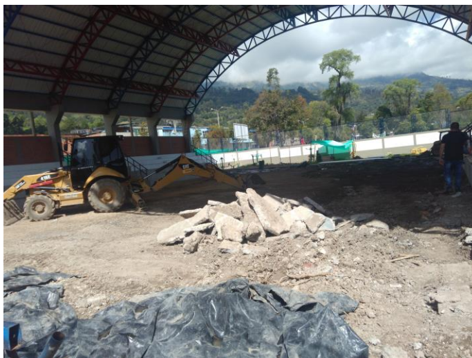
Ilustración 96 demolición placa de cancha
