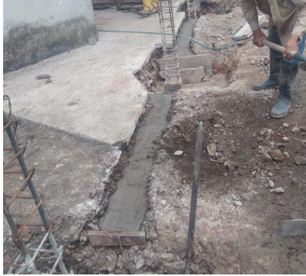
Ilustración 73 solado para viga de cimentación
