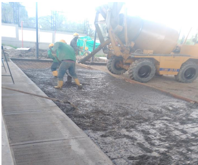
Ilustración 100 fundida de cancha
