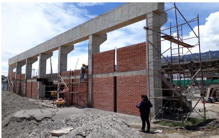
Ilustración 78 mampostería a la vista gradería
