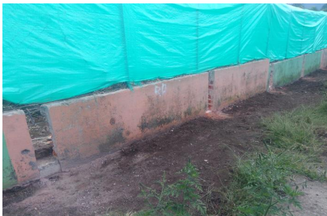
Ilustración 62 cortes realizados a muro de quebrada
