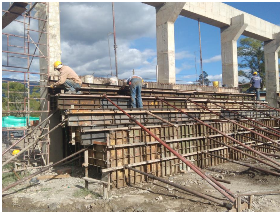
Ilustración 59 formaleta y puntales para gradería
