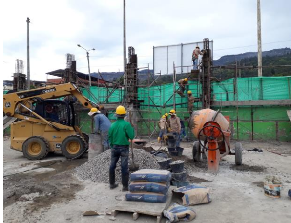
Ilustración 39 concreto para columnas
