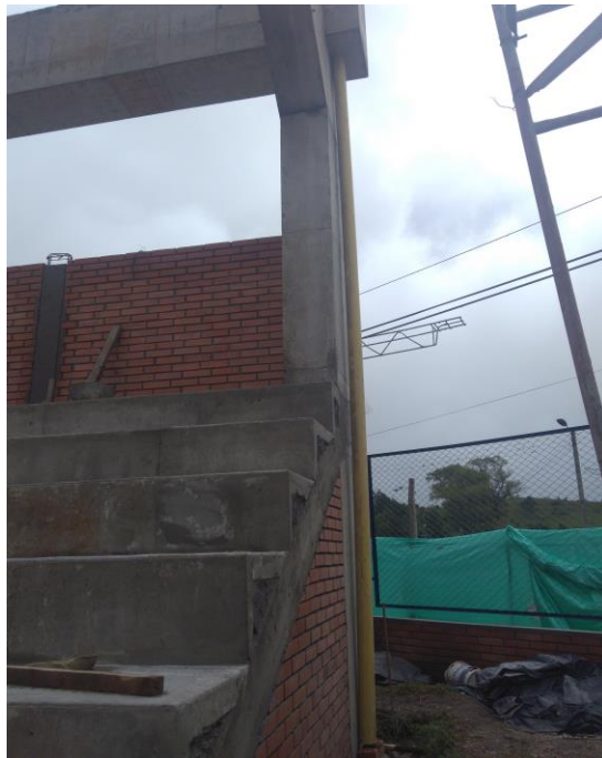
Ilustración 88 tubería de 4" bajantes
