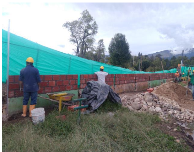
Ilustración 63 mampostería muro de quebrada
