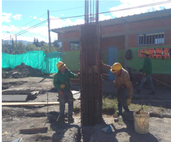
Ilustración 20 formaletas eje 1
