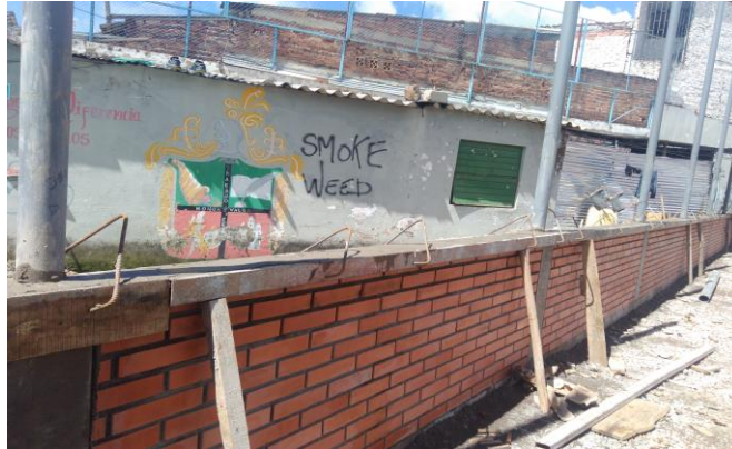
Ilustración 79 viga cinta y tubería de 3 pulgadas
