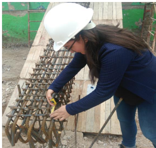
Ilustración 29 verificación de dimensiones
