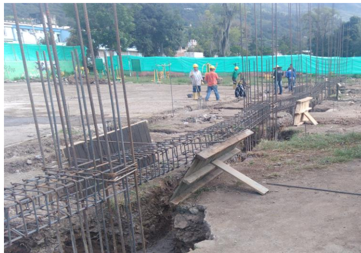
Ilustración 9 acero de viga de cimentación eje 1
