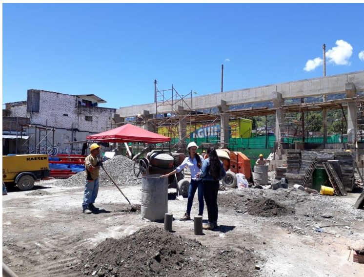
Ilustración 106 cilindros para prueba de resistencia concreto de gradería
