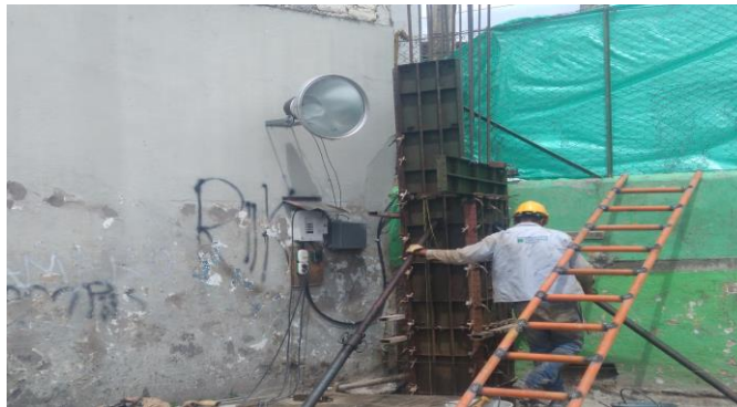
Ilustración 19 formaletas para columnas eje 2
