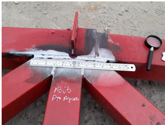
Ilustración 109 prueba de fluidos penetrantes a soldadura de estructura metálica
