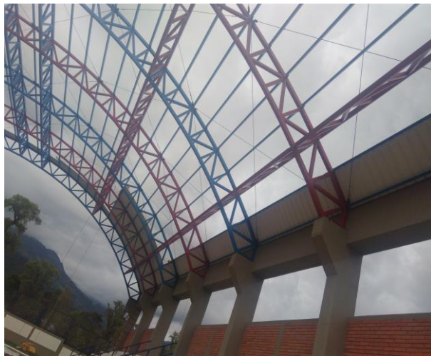
Ilustración 86 cubierta en termo acústica
