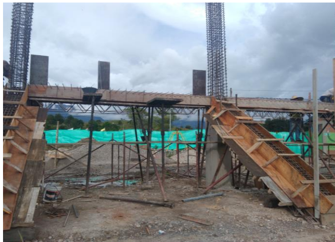
Ilustración 34 formaleta viga aérea
