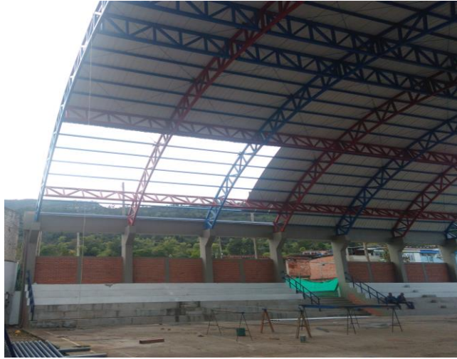
Ilustración 87 finalizado de instalación de cubierta
