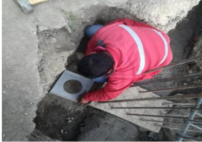
Ilustración 108 prueba de densidad en el terreno
