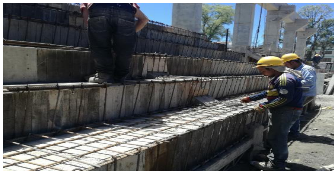
Ilustración 58 acero de gradería fuente propia
