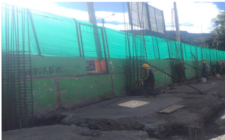
Ilustración 16 armado de acero columnas
