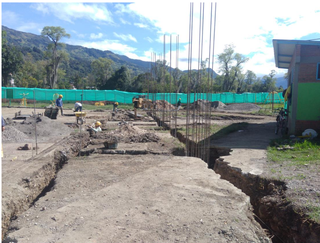
Ilustración 4 Estado de la construcción el primer día de la práctica, eje 1
