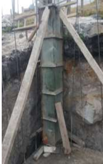
Ilustración 19 Formaleta para columna
