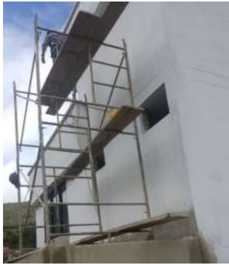
Ilustración 58 pañete exterior con impermeabilizante
