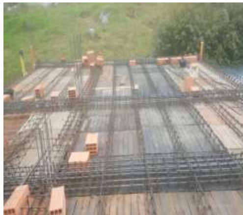
Ilustración 32 Vigas y viguetas
