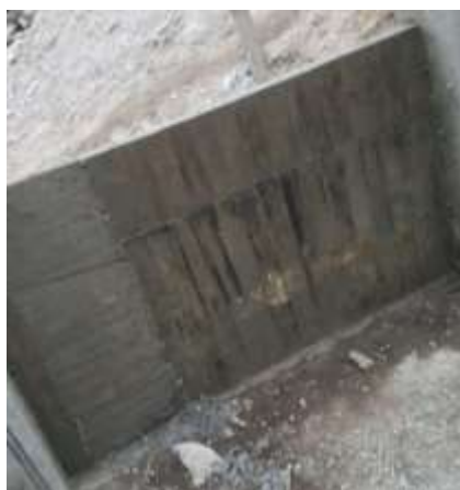
Ilustración 25 muro de contención fundido
