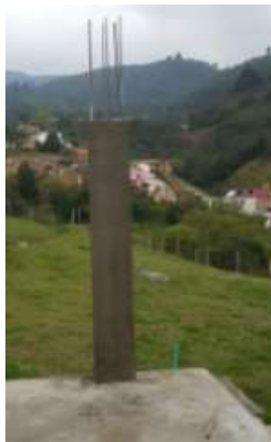
Ilustración 41 columna tipo 1 primera placa
