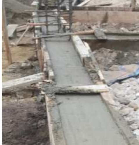
Ilustración 17 Viga de cimentación fundida
