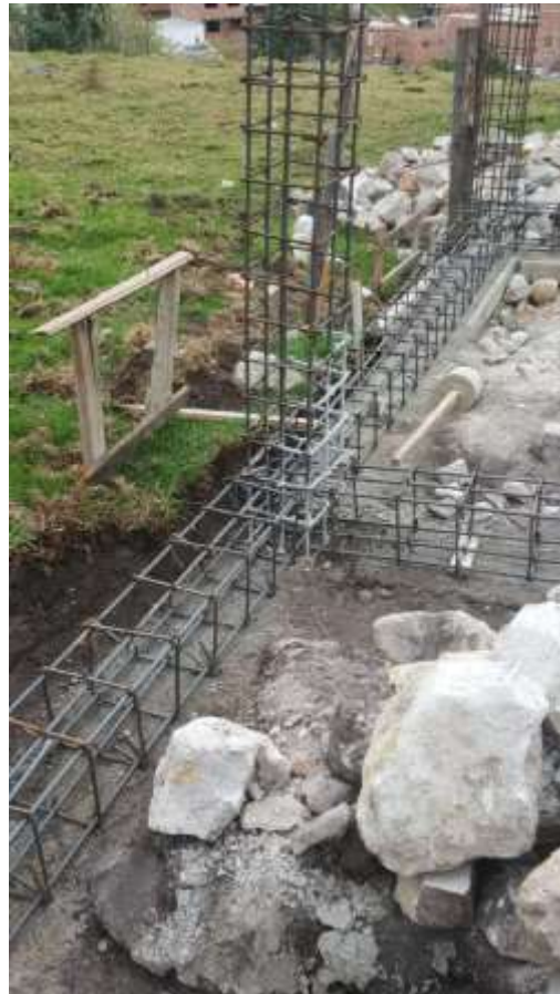
Ilustración 9 Vigas de cimentación
