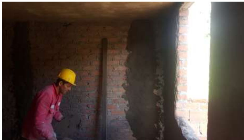
Ilustración 56 inicio de pañete
