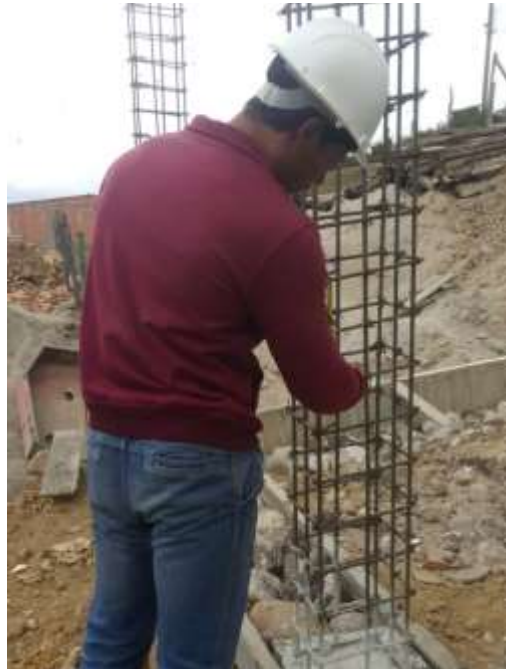
Ilustración 11 Acero de columnas tipo 1
