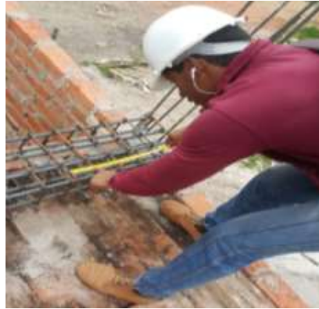
Ilustración 31 Verificación de estribos
