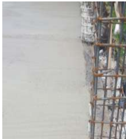
Ilustración 18 Placa de piso fundida
