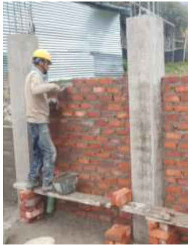
Ilustración 28 Muro en ladrillo macizo
