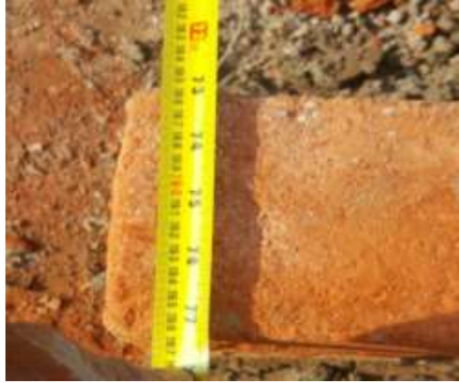
Ilustración 27 Verificación del ladrillo
