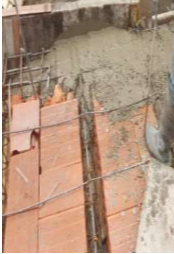
Ilustración 40 Fundición de escaleras
