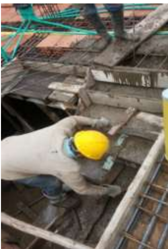
Ilustración 39 Fundición de escaleras
