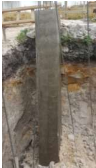
Ilustración 20 Columna fundida
