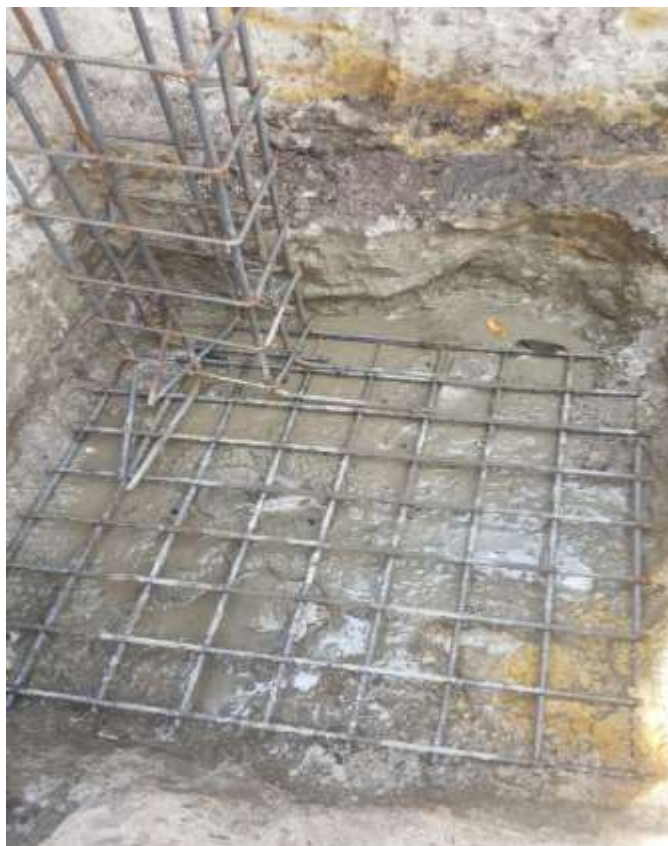
Ilustración 7 Detalles de zapatas Fuente: Documentos contractuales de la obra
