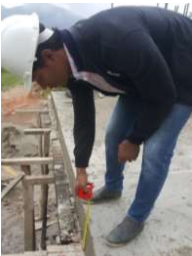
Ilustración 49 Espesor de la placa
