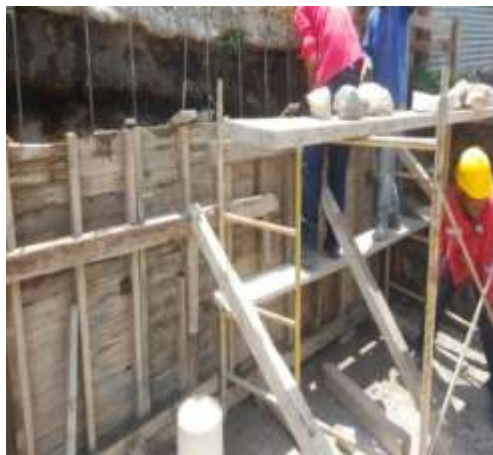
Ilustración 24 Fundición de muros de contención
