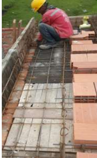
Ilustración 45 Acero viga canal
