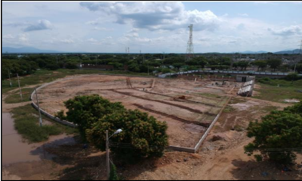
Ilustración 55. . Estado Final Cancha de Softbol.
