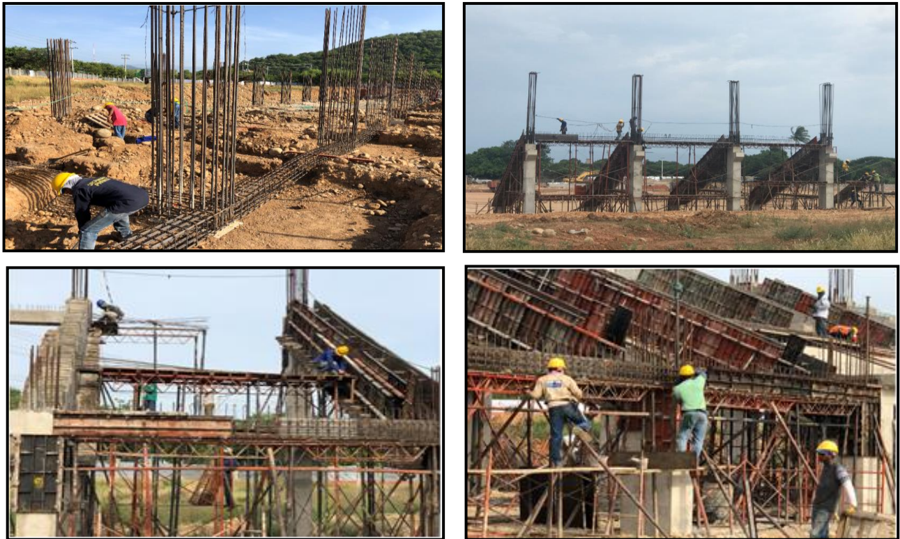
Ilustración 28. Acero De Refuerzo.
