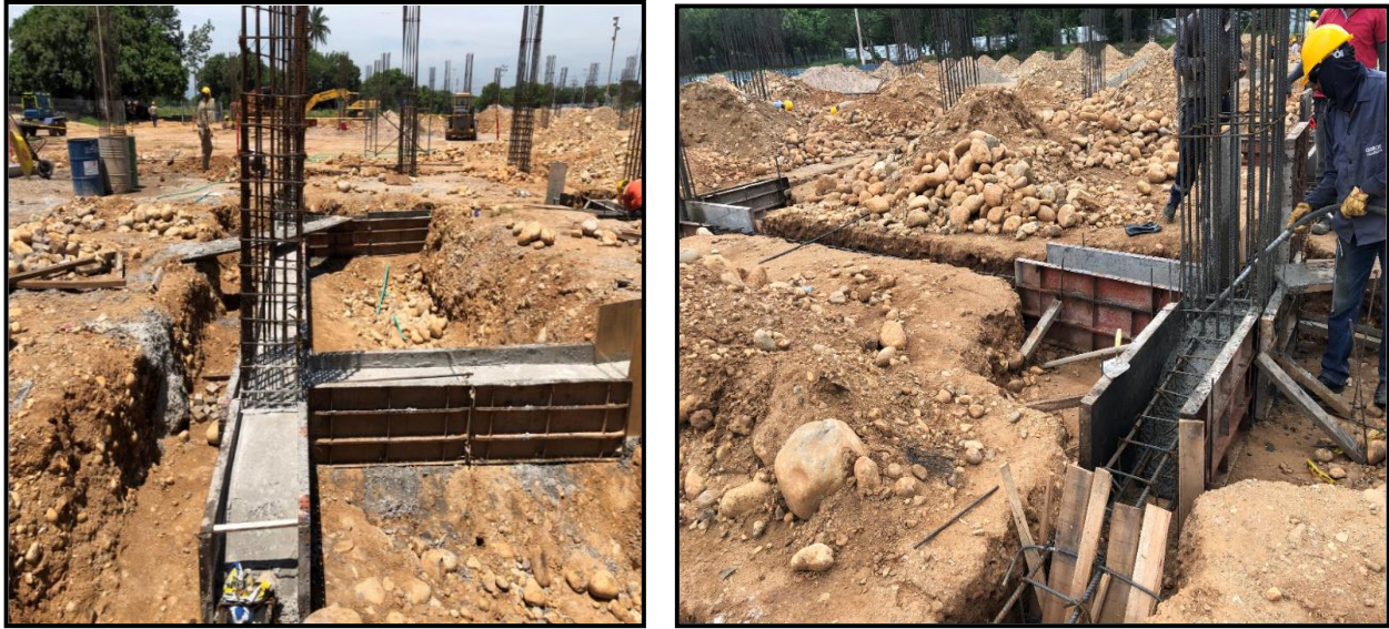
Ilustración 12. Vigas De Cimentación.
