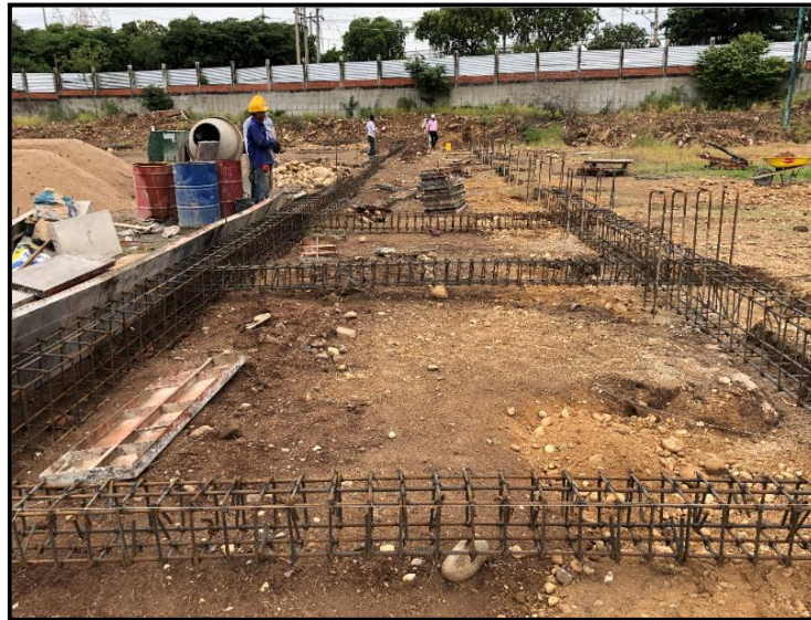
Ilustración 47. Acero de Refuerzo.
