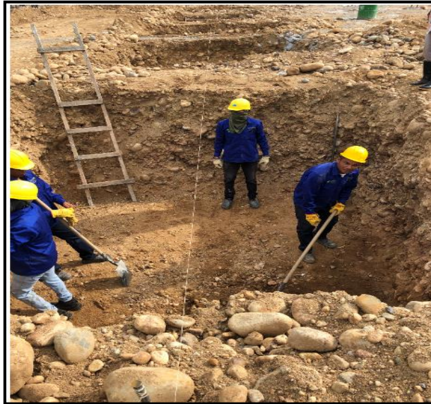
Ilustración 20. Excavación Para Zapatas.
