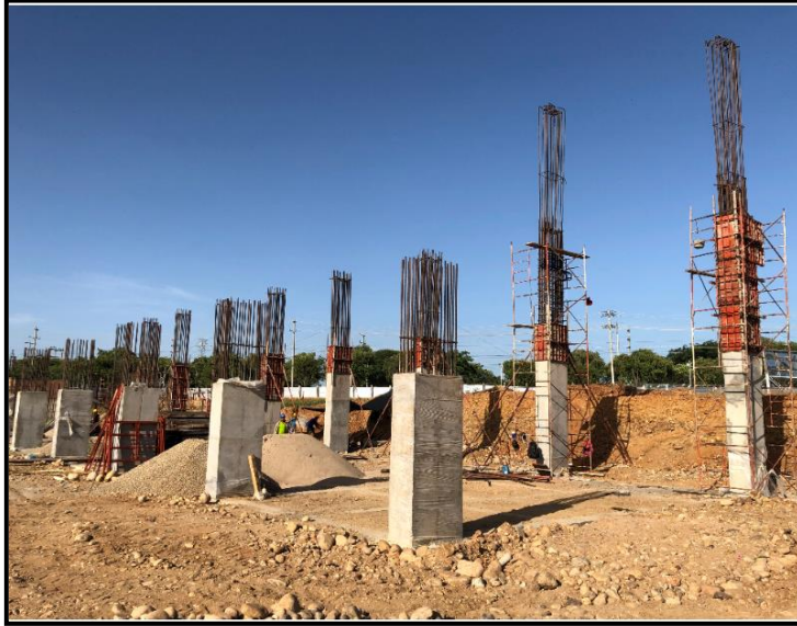
Ilustración 25. Columnas.
