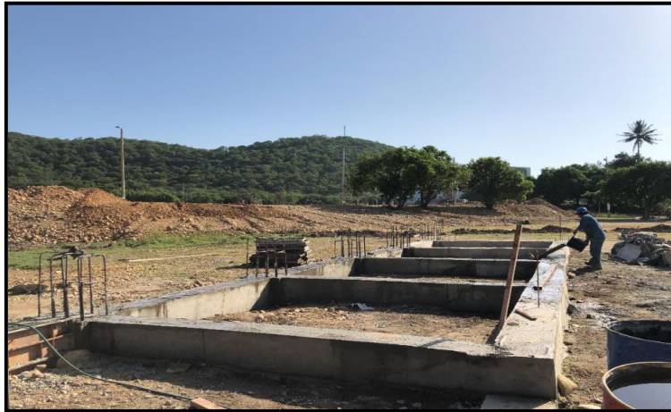
Ilustración 45. Vigas de Cimentación.
