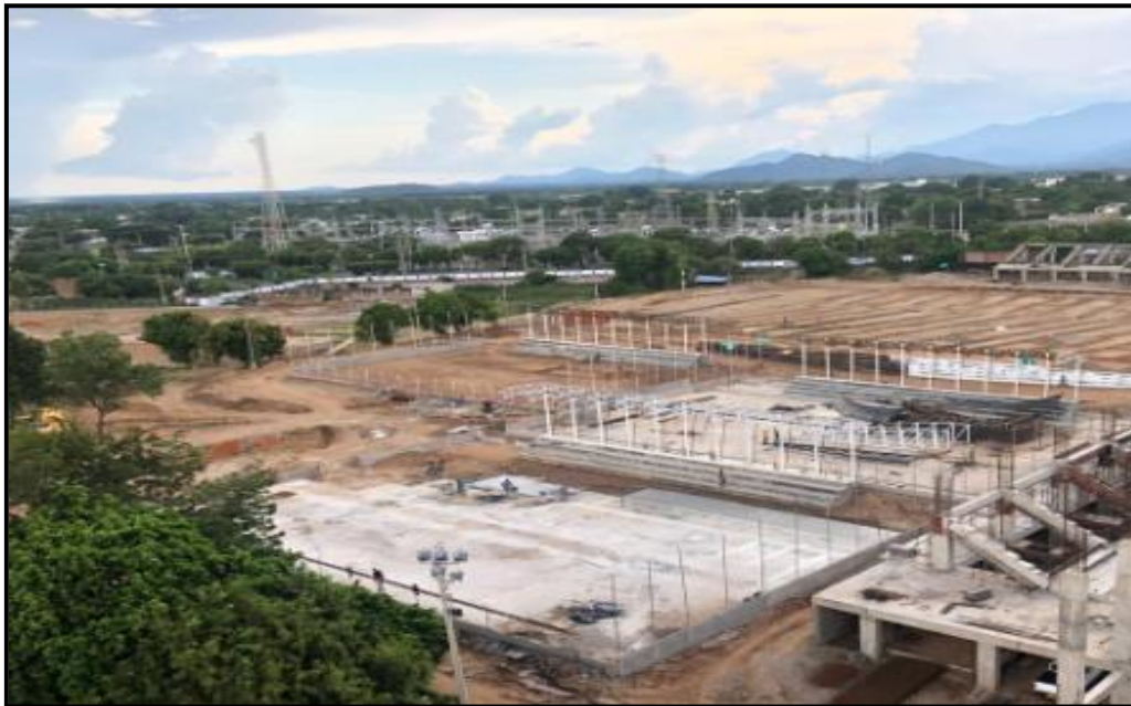
Ilustración 56. Estado Final Canchas Multifuncionales.
