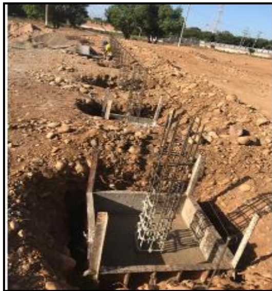
Ilustración 34. Zapatas.
