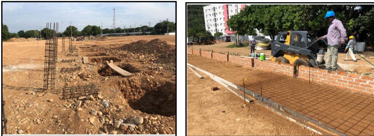
Ilustración 39. Acero De Refuerzo y Malla Elctrosoldada.
