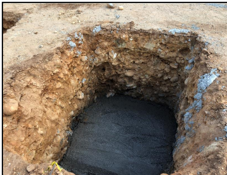
Ilustración 10. Solados e=0.05 mts.
