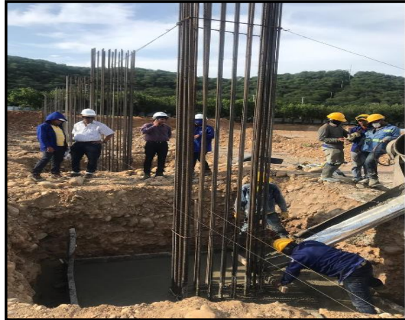
Ilustración 23. Zapatas Cuadradas.
