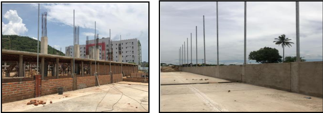
Ilustración 40. Mampostería y Pañete.
