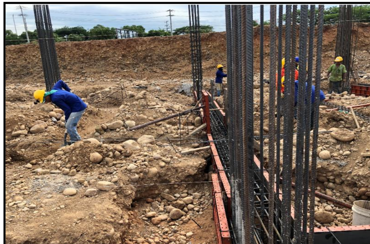
Ilustración 21. Excavación Para Viga De Cimentación.
