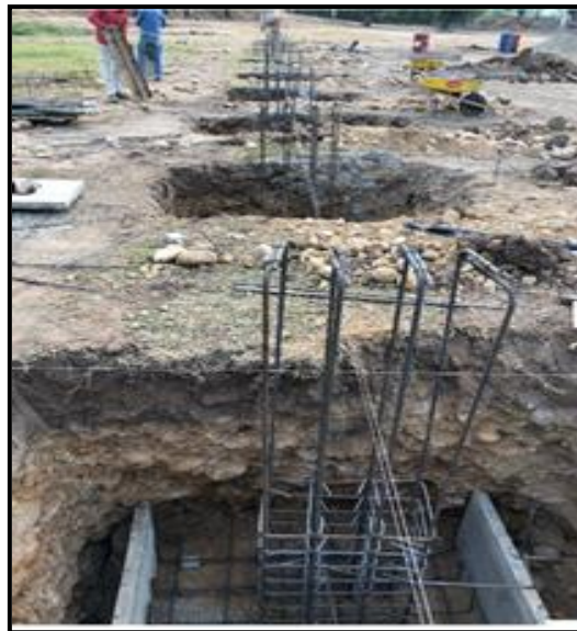
Ilustración 44. Zapatas.
