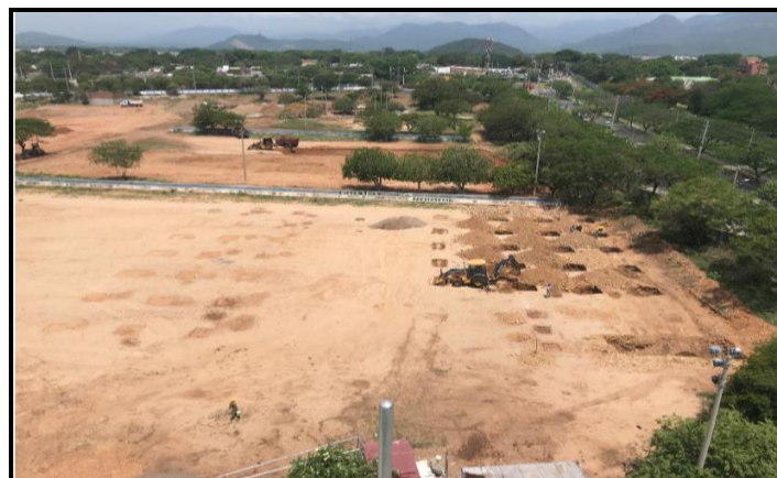
Ilustración 8. . Excavación Para Zapatas.
