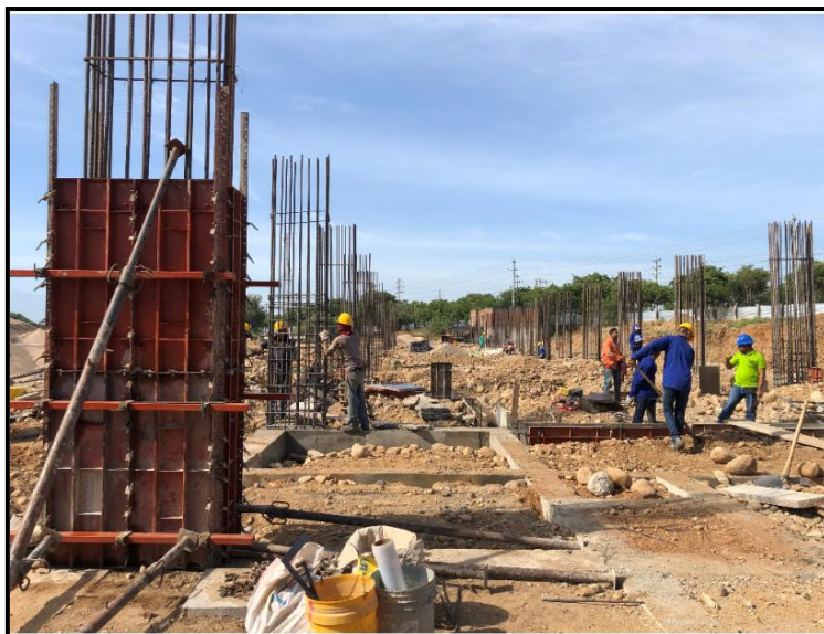
Ilustración 24. Vigas De Cimentación.
