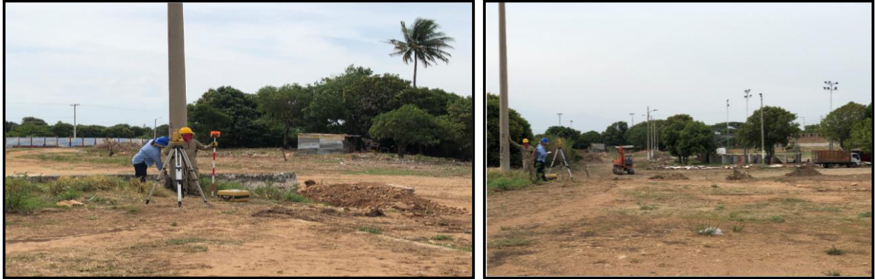
Ilustración 4. Localización y Replanteo.
