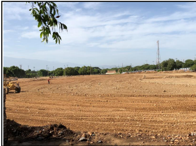
Ilustración 32. Compactación De Terreno.
