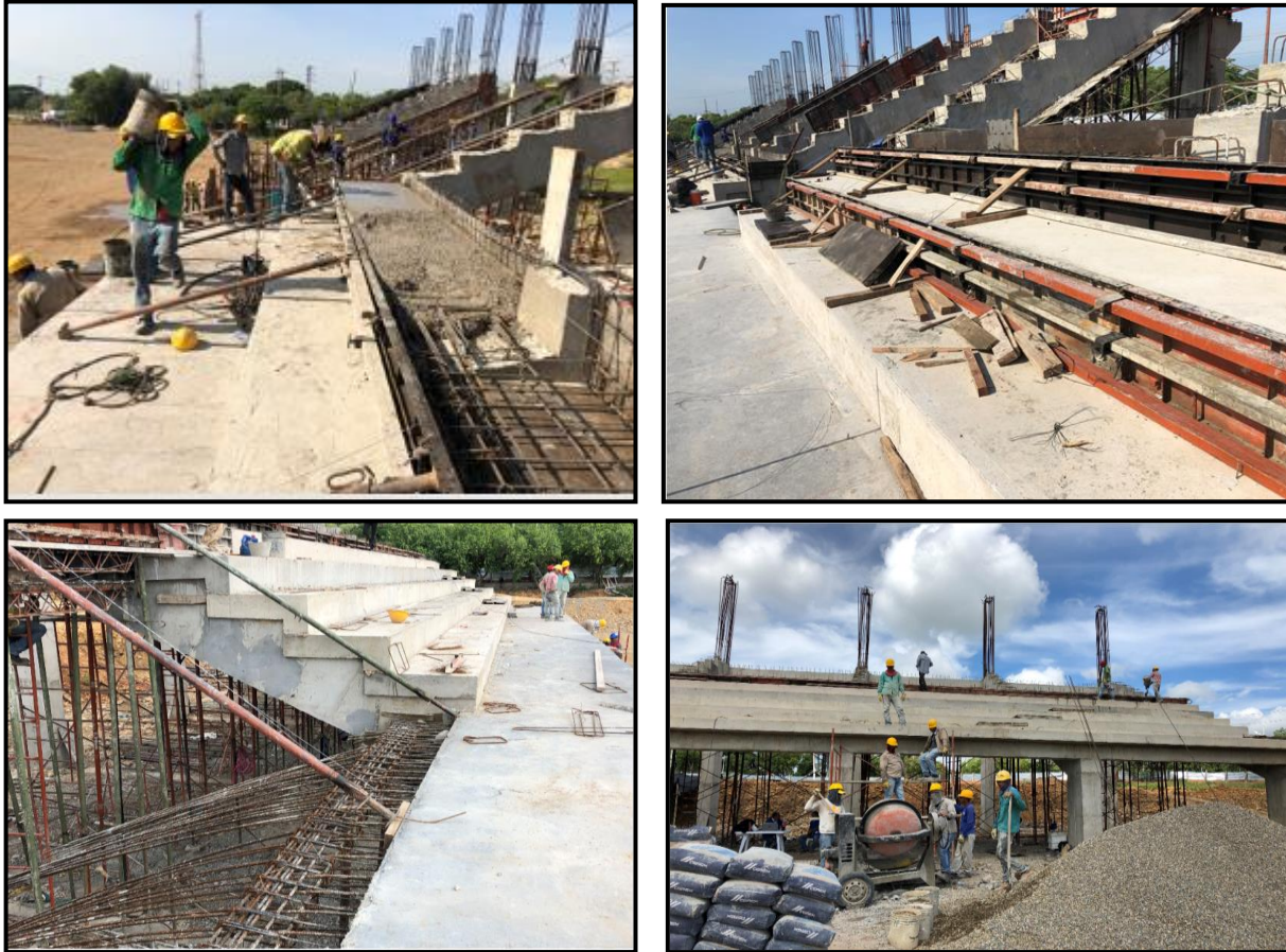
Ilustración 27. Pórticos y Placas Macizas.
