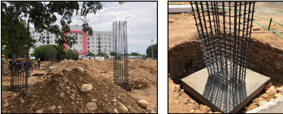
Ilustración 11. Zapatas Cuadradas.
