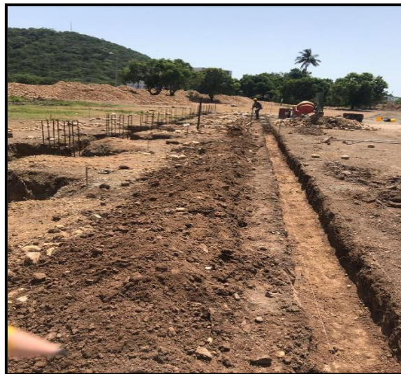
Ilustración 43. Excavación Para Vigas de Cimentación.
