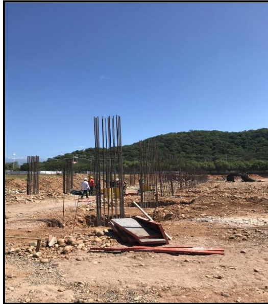
Ilustración 22. Solados e=0.05 mts.
