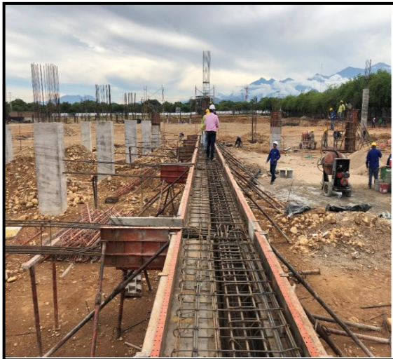
Ilustración 17. Acero de Refuerzo.
