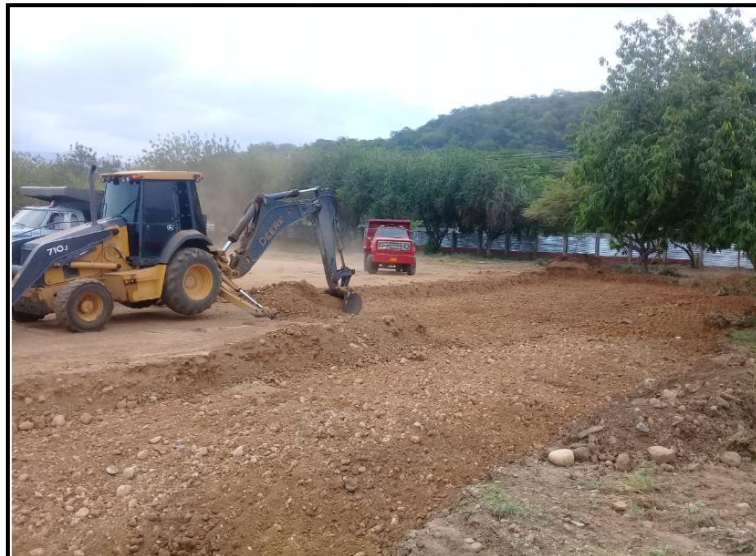
Ilustración 5. Corte y Nivelación del Terreno.
