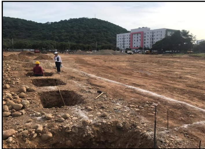
Ilustración 33. Excavación Para Zapatas
