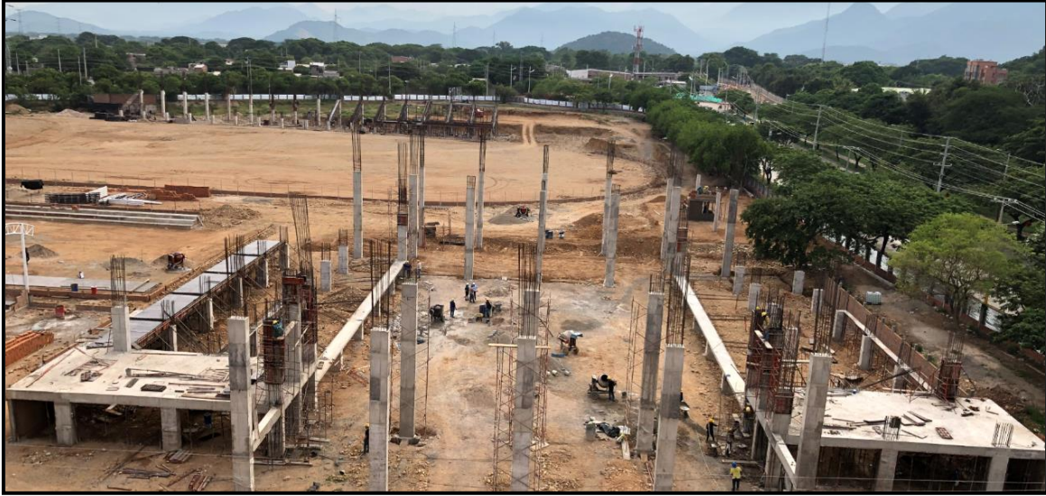
Ilustración 15. Pórticos y Placa Maciza.
