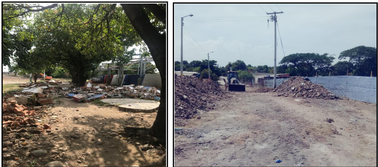
Ilustración 7. Demolición De Estructuras Existentes.
