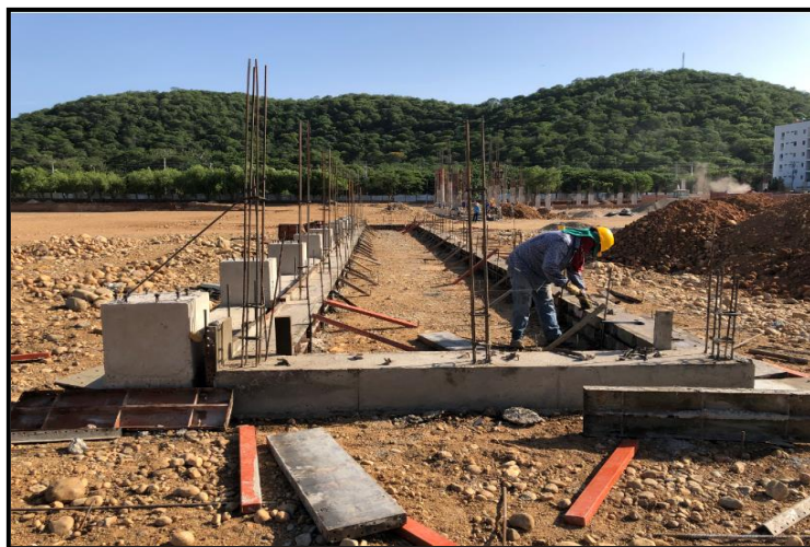
Ilustración 36. Viga De Cimentación.
