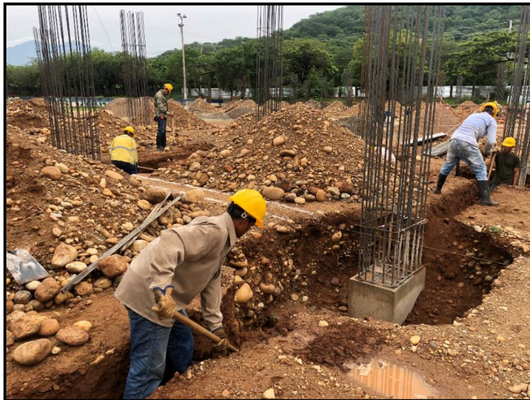
Ilustración 9. Excavación Para Viga De Cimentación
