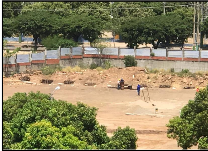
Ilustración 42. Excavación Para Zapatas.
