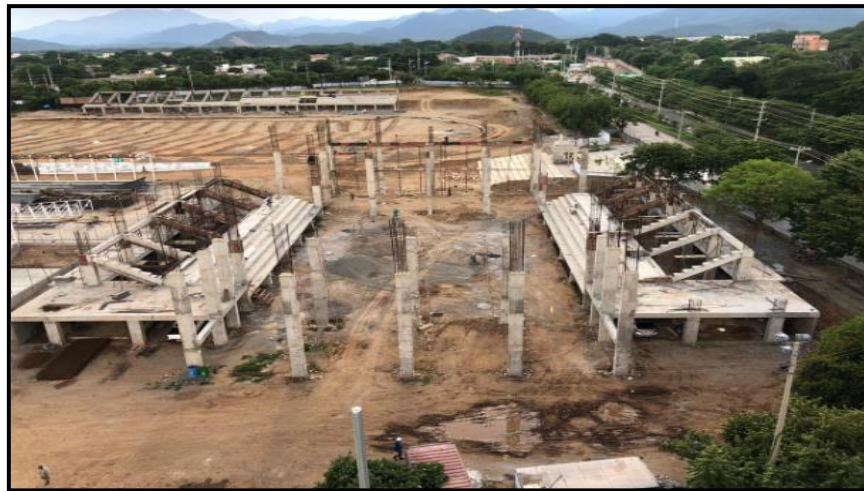
Ilustración 53. Estado Final Coliseo de Combate.
