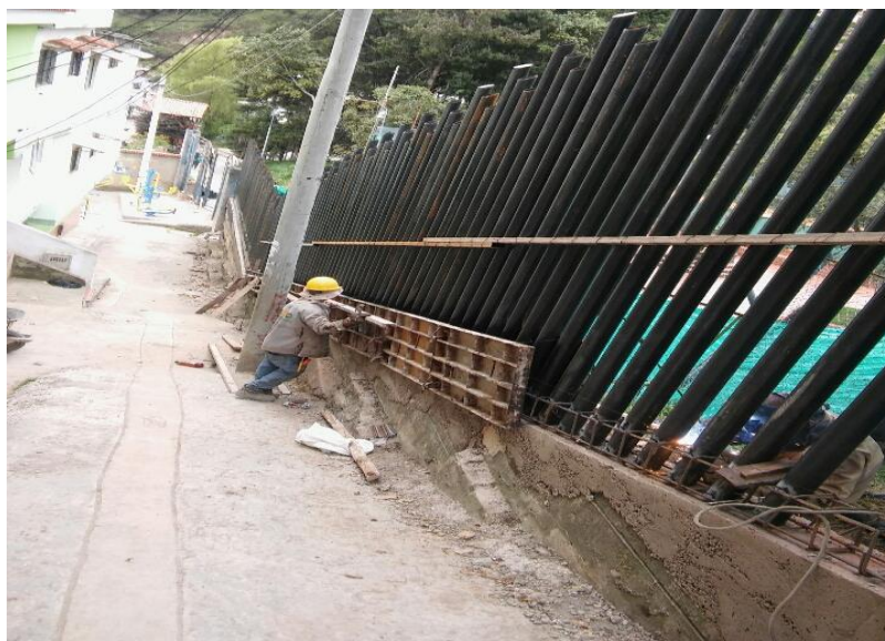
Ilustración 21. Cerramiento en tubo metálico y muro.
