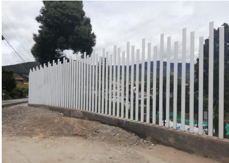
Ilustración 25. Tubería pintada con pintura epoxi para tubo galvanizado.
