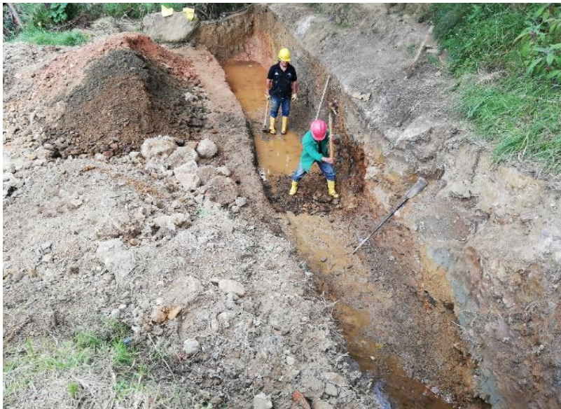
Ilustración 17. Excavación manual sin clasificar.
