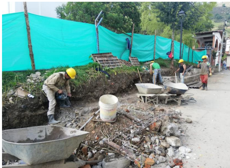
Ilustración 19. Retiro de sobrantes de muro.
