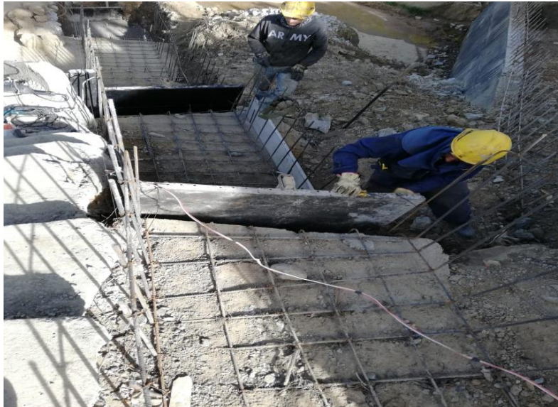
Ilustración 30. Construcción de disipador de energía para la conducción del agua lluvia y desagües del campus principal de la Universidad de Pamplona.
