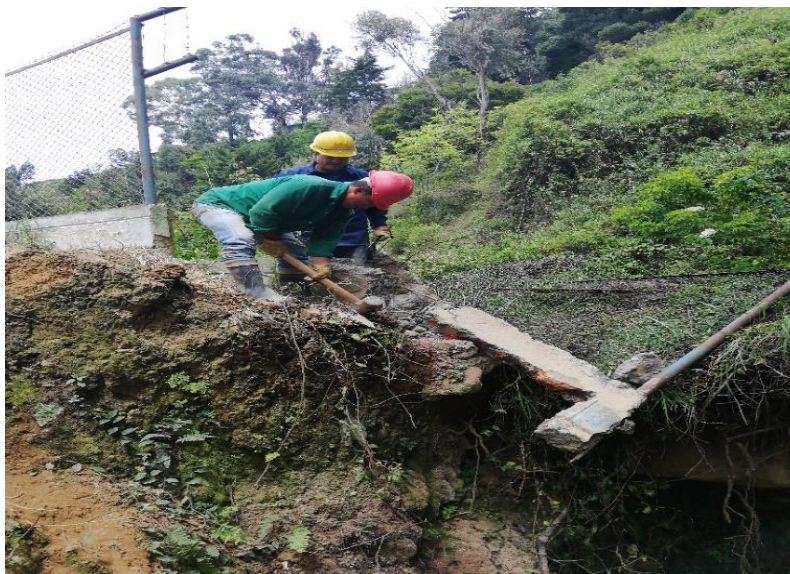
Ilustración 23. Restauración de malla existente.
