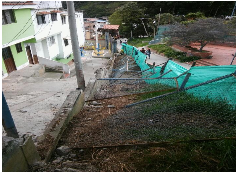
Ilustración 15. Desmante de reja metálica.
