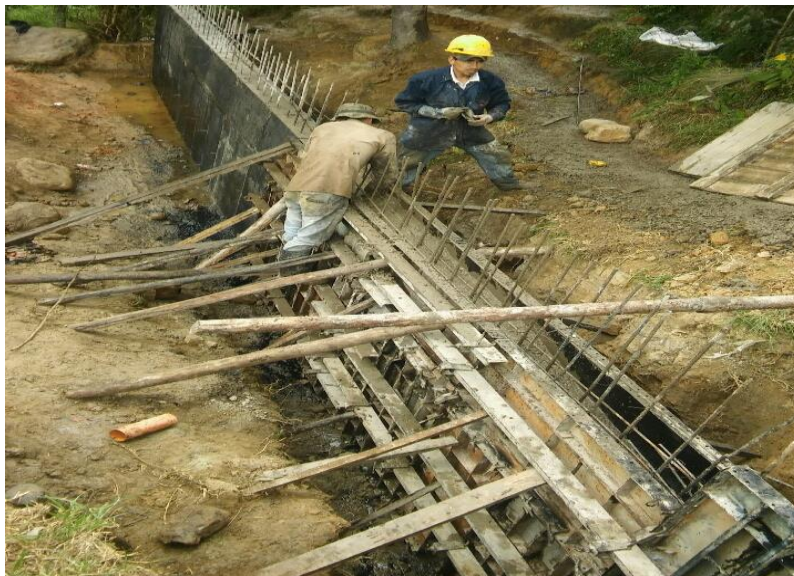
Ilustración 22. Muro en concreto reforzado.
