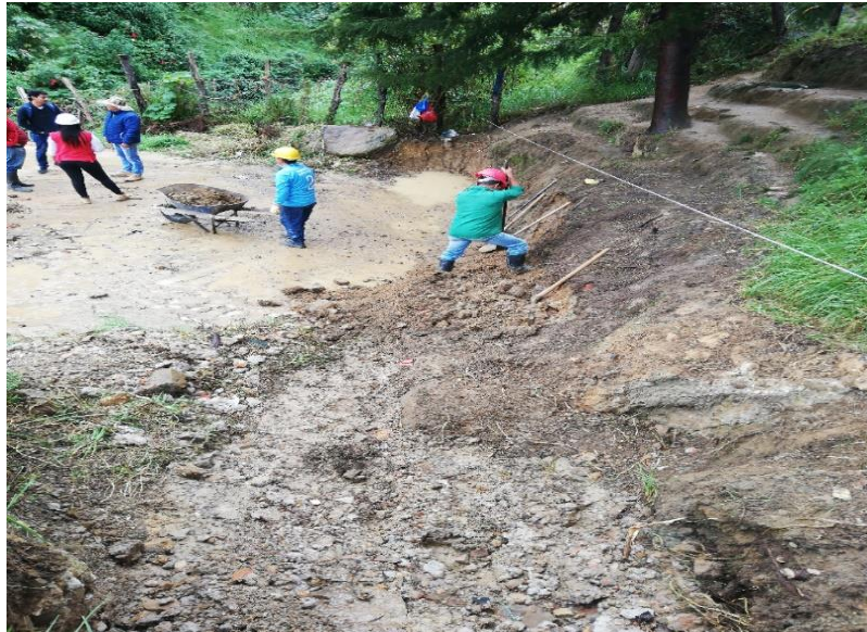
Ilustración 18. Retiro manual de material excavado.
