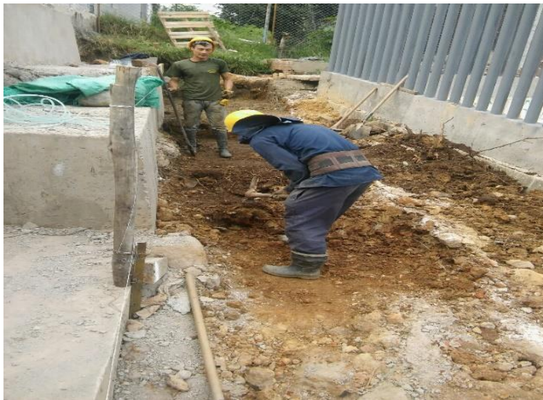
Ilustración 29. Construcción de disipador de energía para la conducción del agua lluvia y desagües del campus principal de la Universidad de Pamplona.
