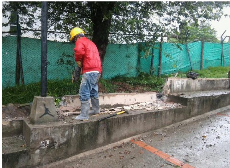
Ilustración 16. Demolición de muro existente.
