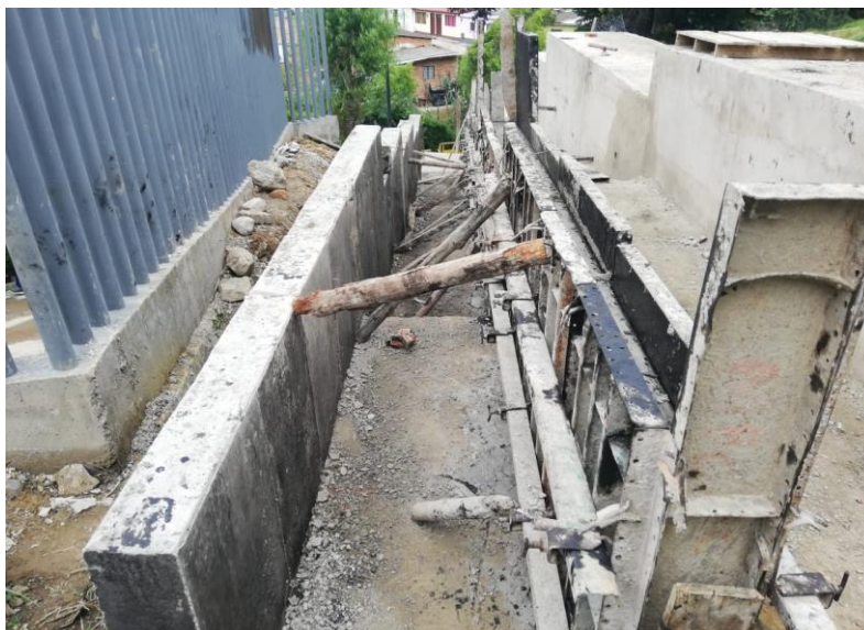
Ilustración 31. Construcción de disipador de energía para la conducción del agua lluvia y desagües del campus principal de la Universidad de Pamplona
