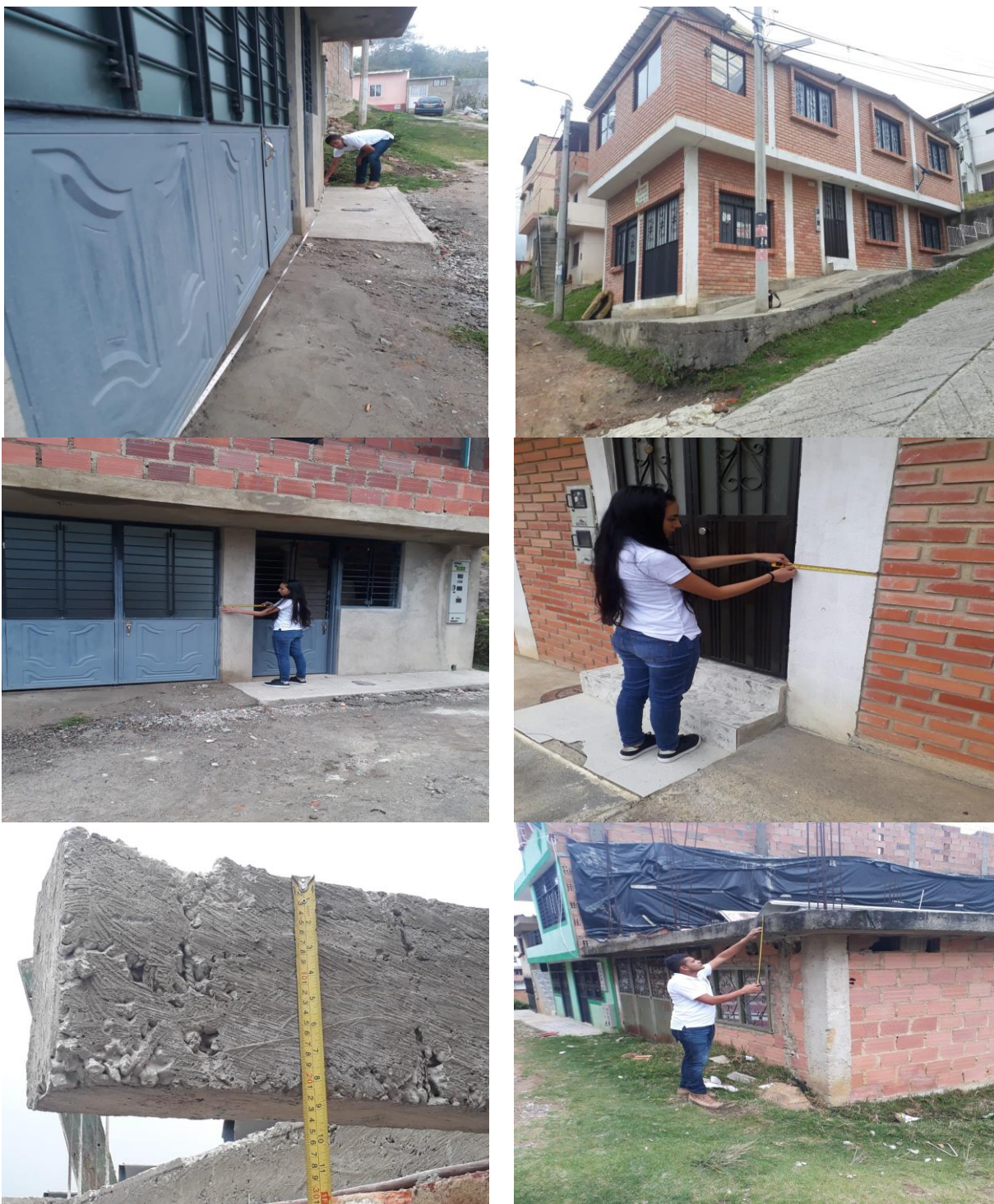
Figura 89. Toma de Medida de la Estructura
