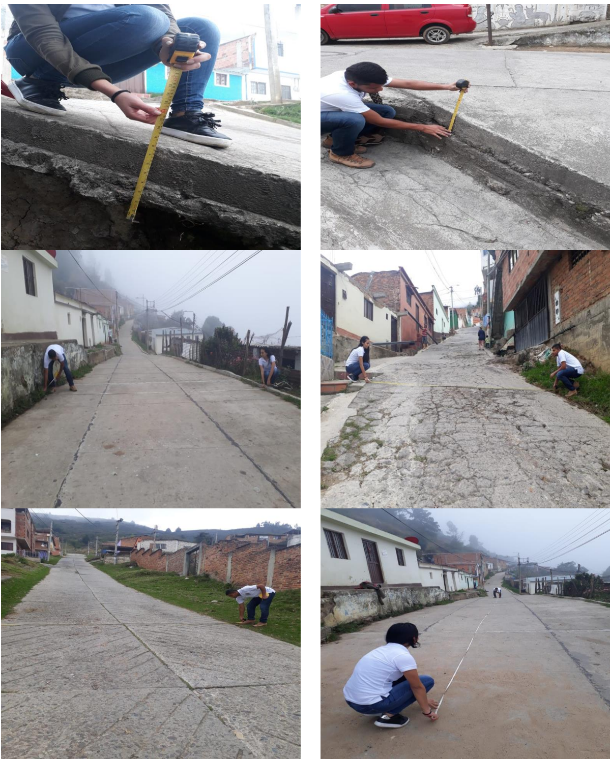
Figura 88. Toma de Medida del Pavimento Rígido
