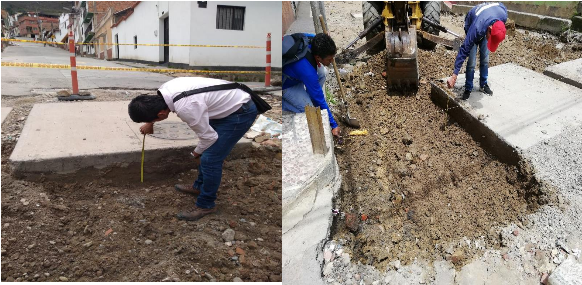
Ilustración 58. Toma de niveles
