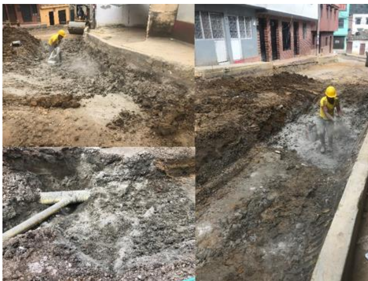
Ilustración 10. Relleno de estructuras
