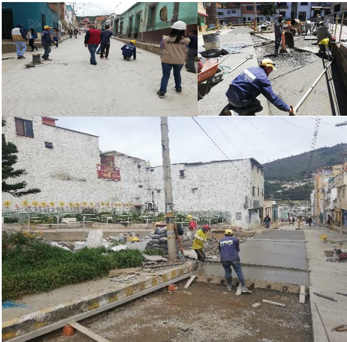
Ilustración 48. Entrega final de la obra
