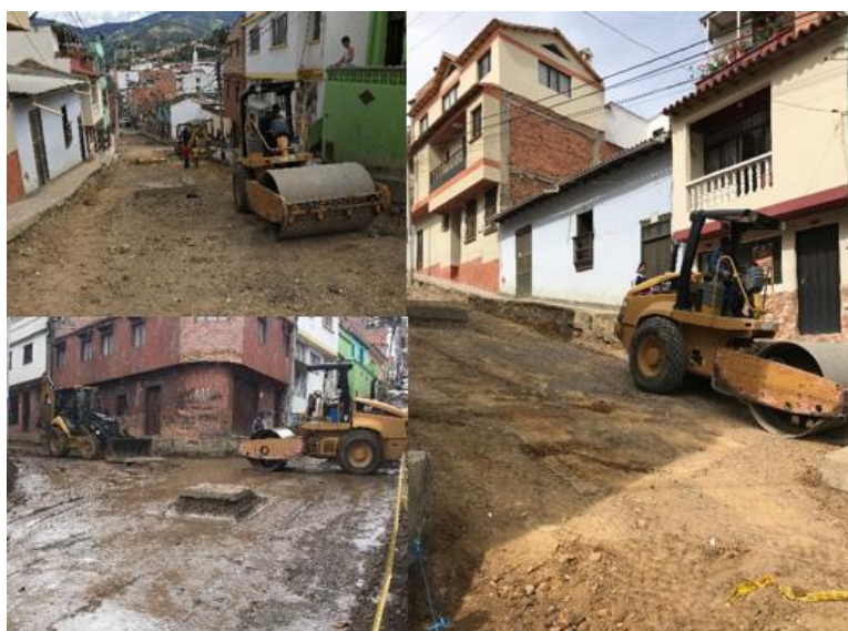
Ilustración 9. Conformación calzada
