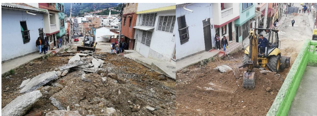
Ilustración 56. Excavación a maquina
