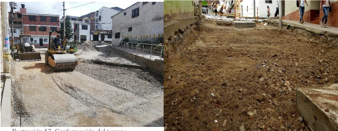
Ilustración 57. Conformación del terreno
