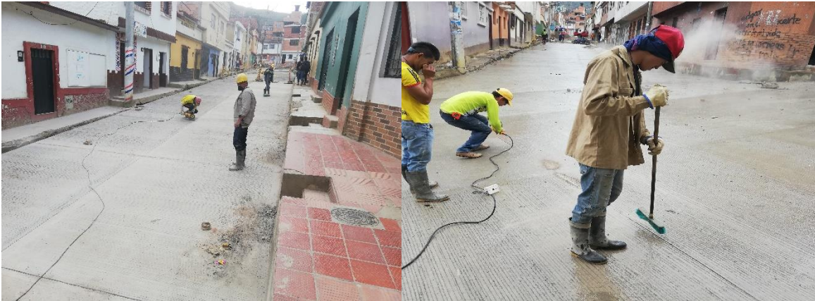
Ilustración 64. Corte y sellado de juntas
