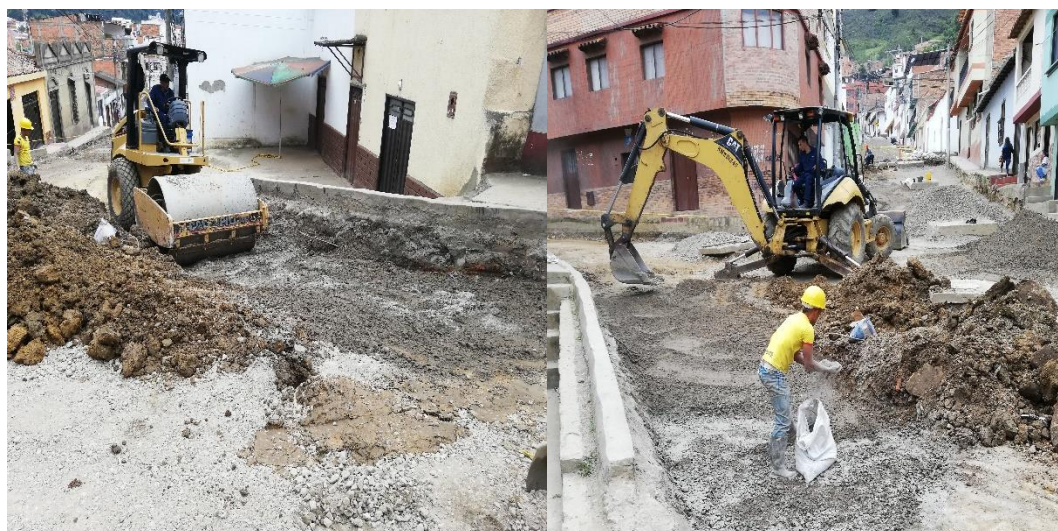
Ilustración 61. Estabilización de la subrasante
