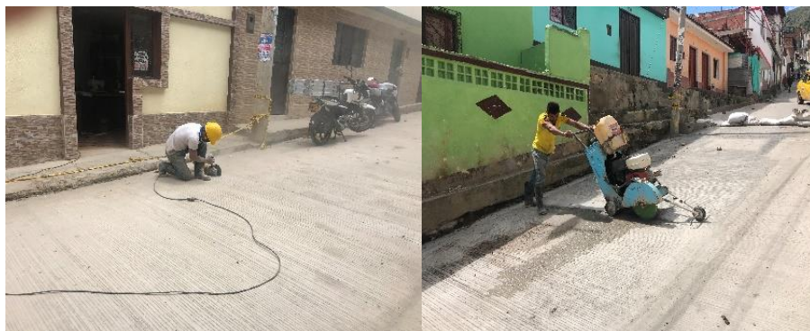
Ilustración 24. Corte y sellado de juntas de contracción.
