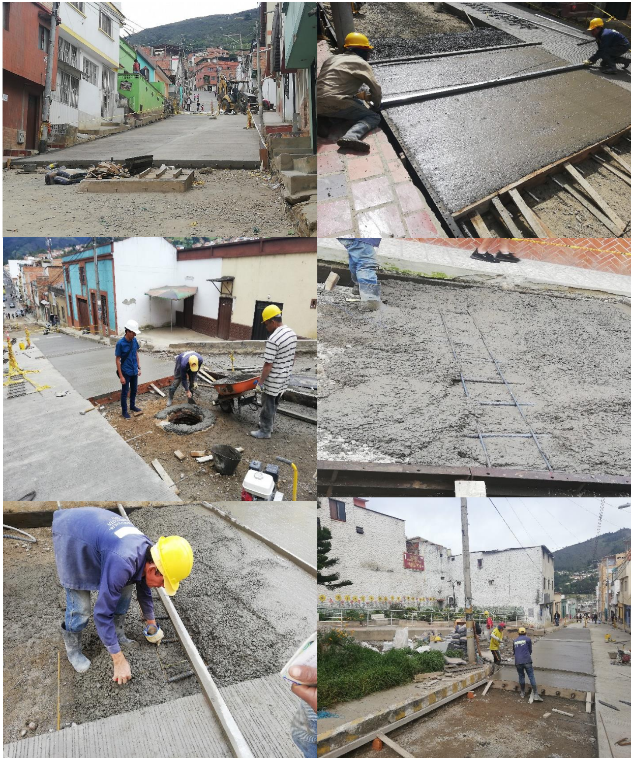
Ilustración 63. Vaciado de concreto
