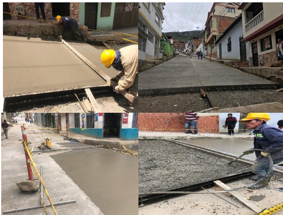
Ilustración 23. Pavimento rígido de 28 Mpa
