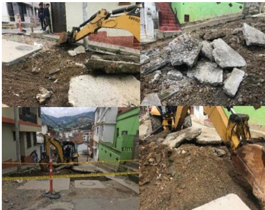
Ilustración 6. Demolición Pavimento con maquinaria pesada
