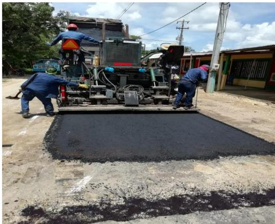
Figura 17. Postura del asfalto.
