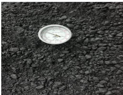
*Figura 16. Temperatura del asfalto.*
