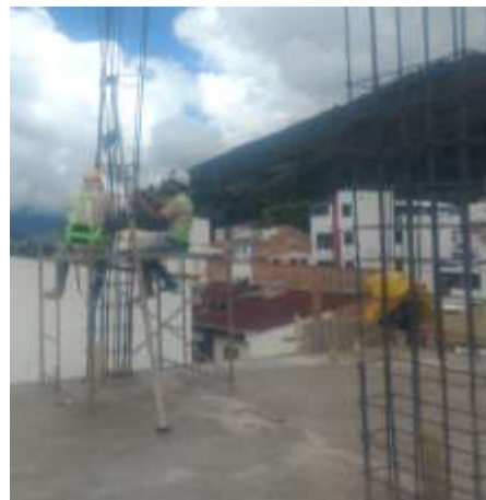
Armando acero de columnas.
