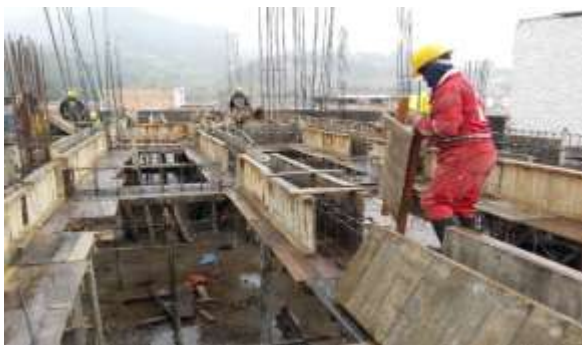
Encofrado de vigas.
