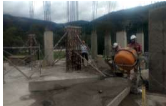
Encofrado de columnas.
