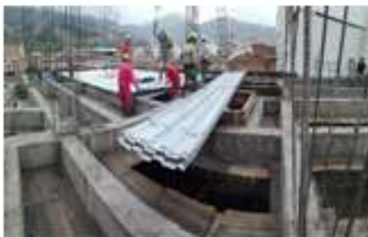
Láminas de metaldeck.
