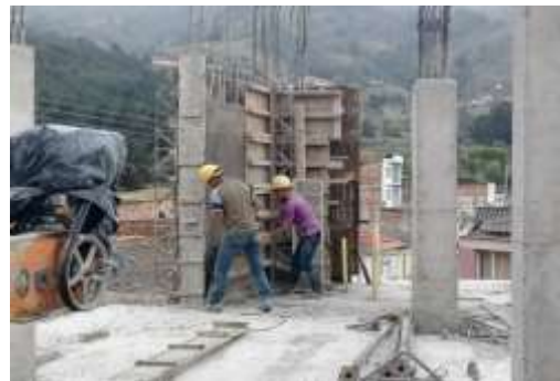
Encofrado de muros pantalla.
