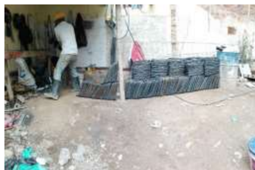
Figurando estribos en obra.
