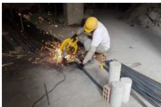
Figurando estribos en obra.
