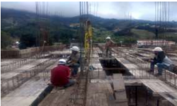
Armado de acero de elementos estructurales vigas.
