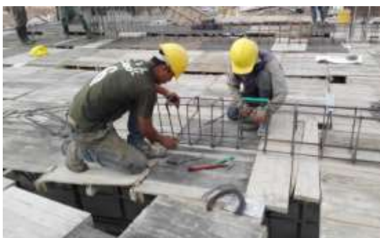
Armado de acero de elementos estructurales vigas.
