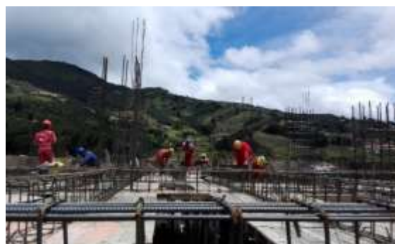
Armado de acero de elementos estructurales vigas.
