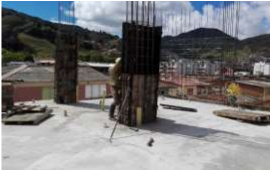
Encofrado de columnas.
