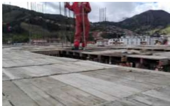
Cama de vigas nivelada.
