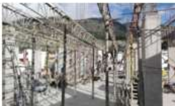
Armando cama de vigas.
