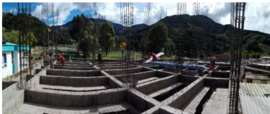
Elementos estructurales (vigas). (Fotografías tomadas en modo panorámica)
