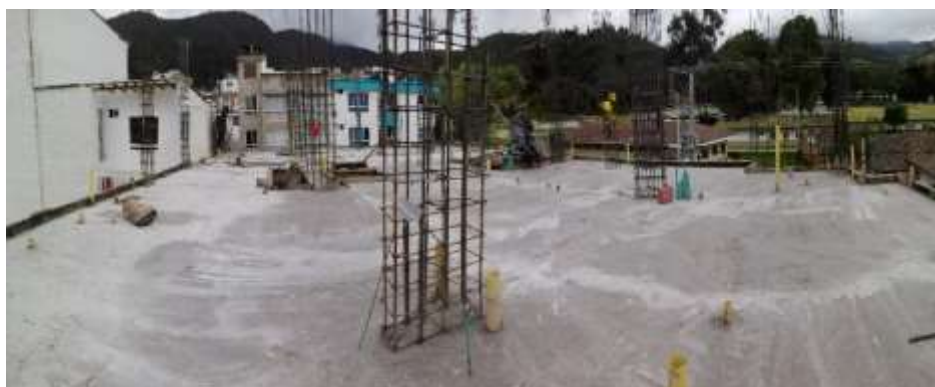
Elementos estructurales (Placas aligeradas). (Fotografías tomadas en modo panorámica)
