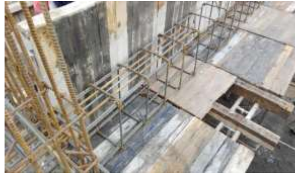
Armado de acero de elementos estructurales vigas.
