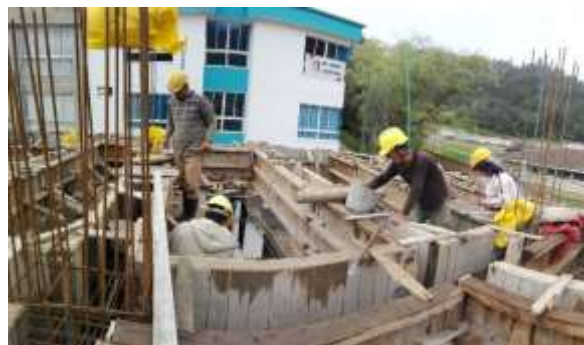
Encofrado de vigas.
