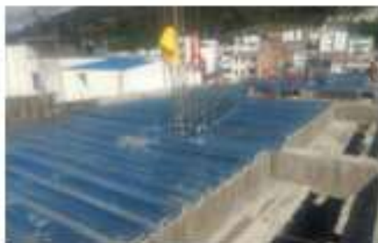
Colocación de Láminas de metaldeck.
