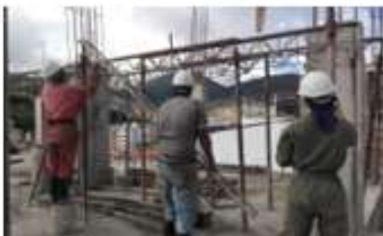
Armando cama de vigas.
