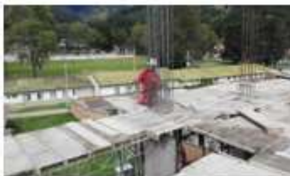
Armando cama de vigas.
