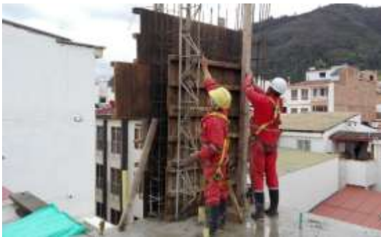
Encofrado de muros pantalla.
