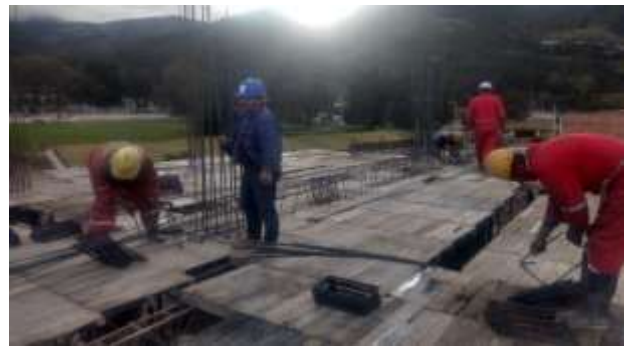
Armado de acero de elementos estructurales vigas.
