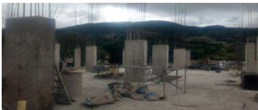
Elementos estructurales (Columnas). (Fotografías tomadas en modo panorámica)
