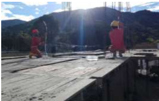
Cama de vigas nivelada.
