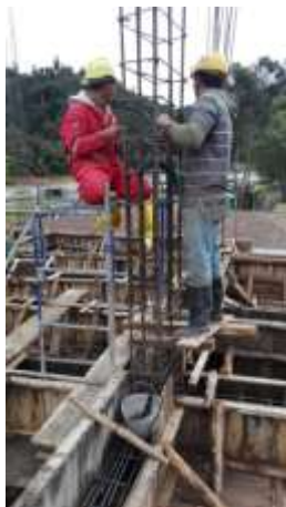
Armando acero de columnas.
