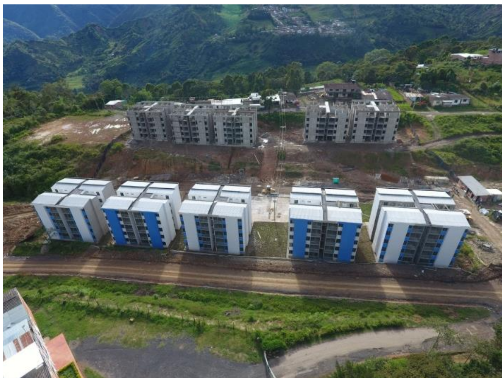
Apéndice 52. Avance de la obra Santa Eduvigis.
