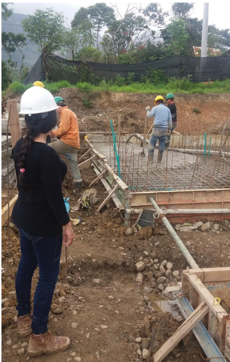
Apéndice 47. Reconocimiento de las instalaciones y personal de la obra.
