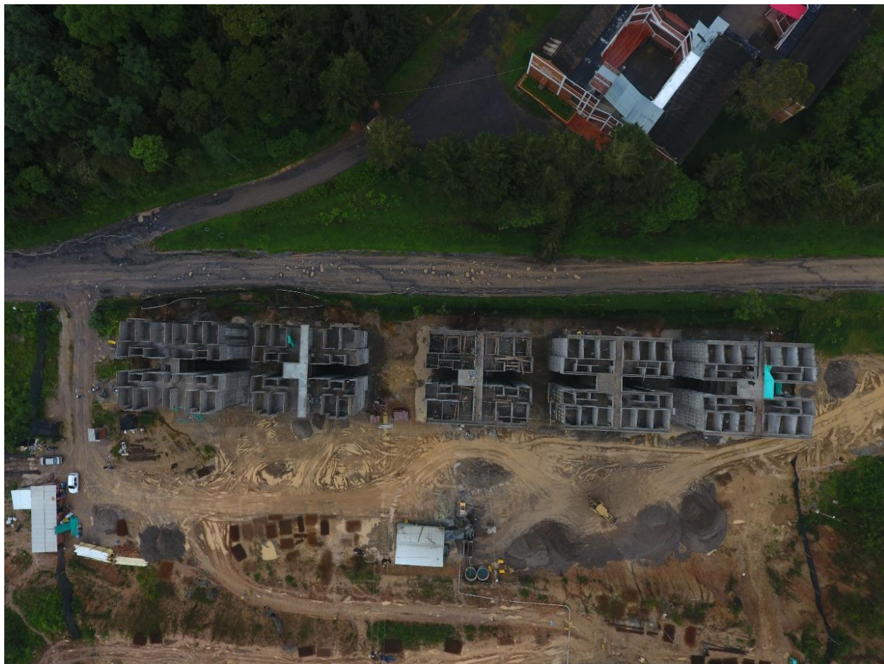
Apéndice 51. Estado de la obra al inicio de las pasantías.
