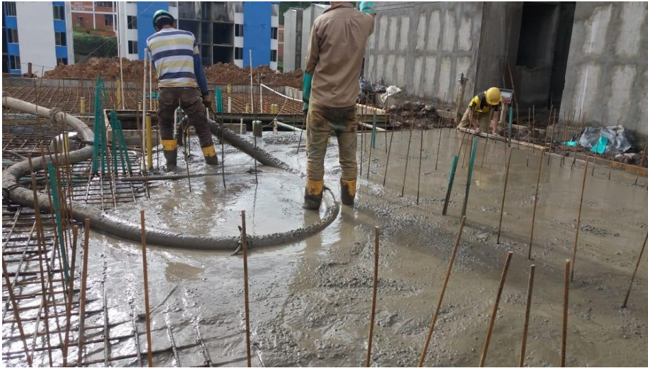
Apéndice 48. Fundida de cimentación
