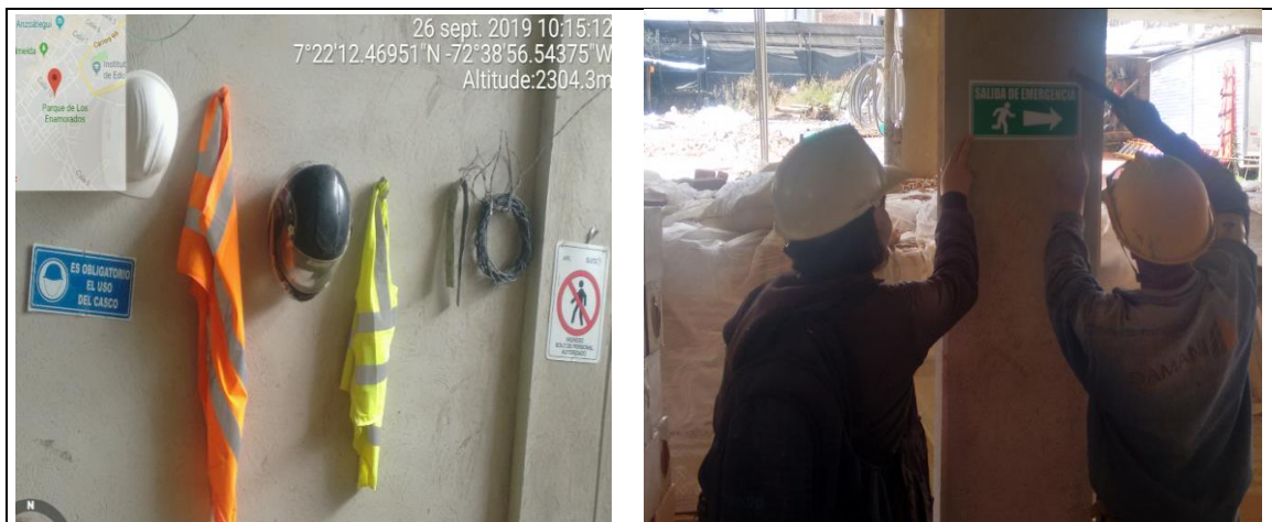
Ilustración 47. Identificación de Señalización en Obra e Instalación de las mismas.
