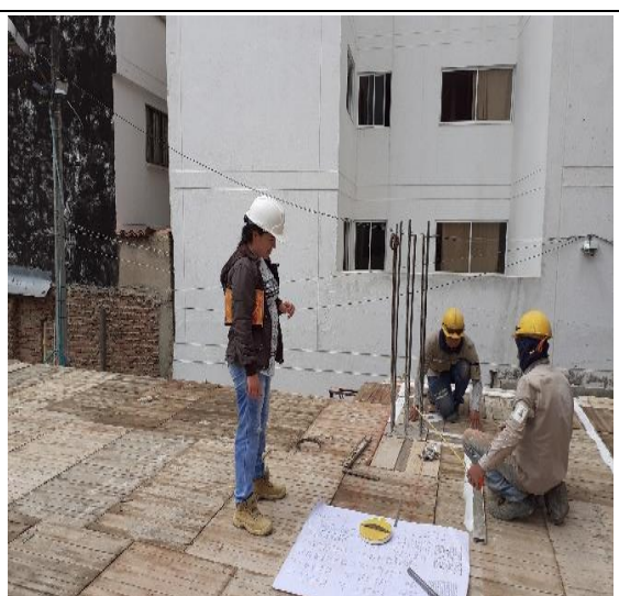
Ilustración 36. Armado de Encofrado para Primer Placa Aligerada.
