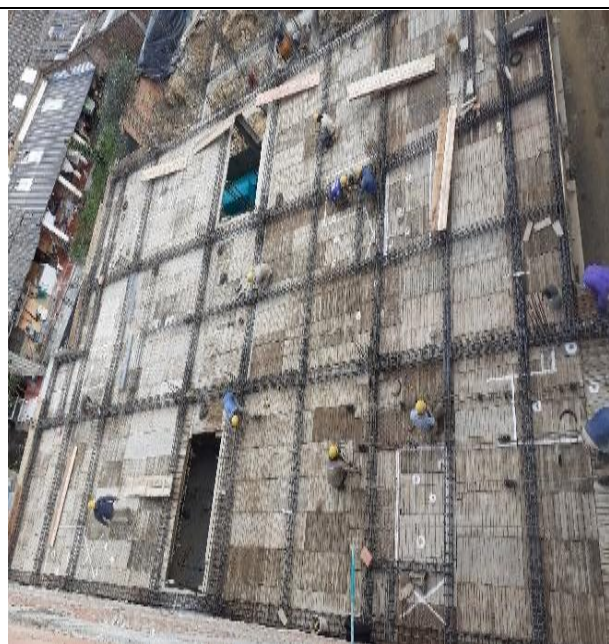
Ilustración 39. Armado de Canasta para Vigas y Viguetas en Placa Aligerada.
