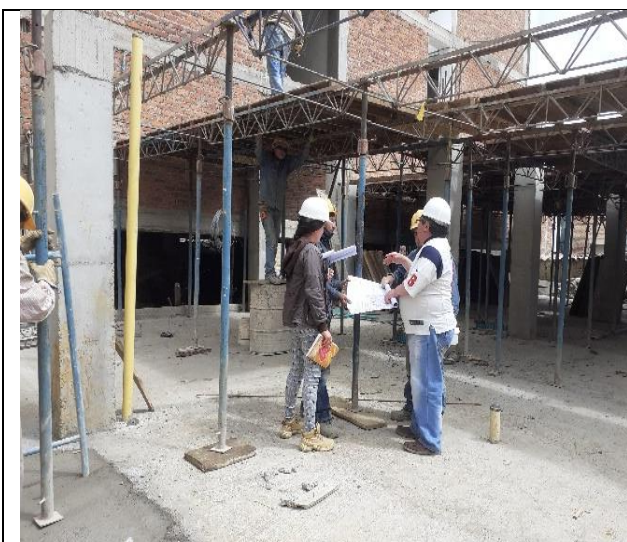
Ilustración 35. Armado de Encofrado para Primer Placa Aligerada.
