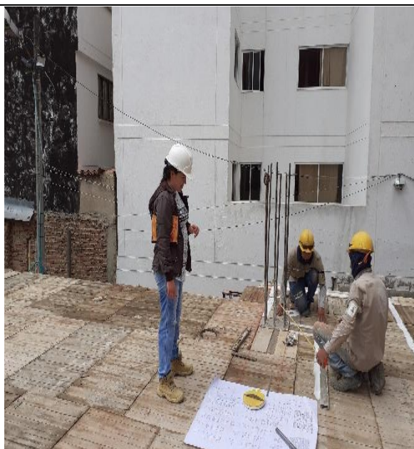
Ilustración 38. Replanteo y Ubicación de Puntos Sanitarios "primera Placa Aligerada".
