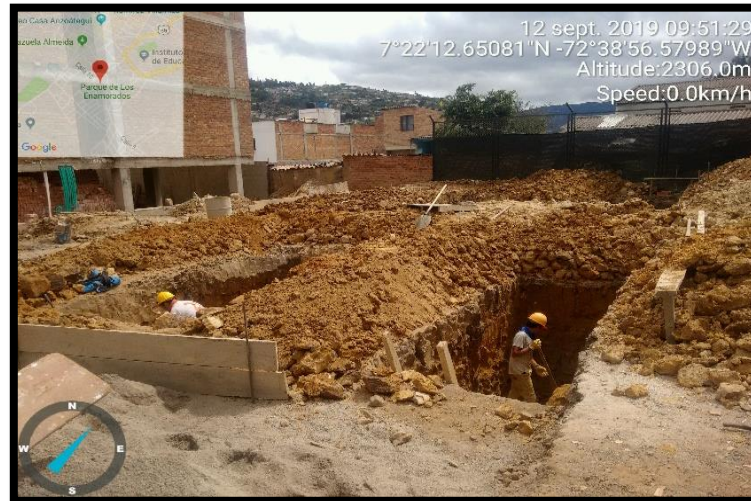
Ilustración 27. Excavación Manual de Zapatas.
