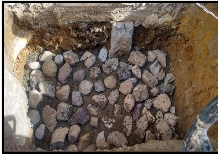
Ilustración 29. Concreto ciclópeo torre (3)
