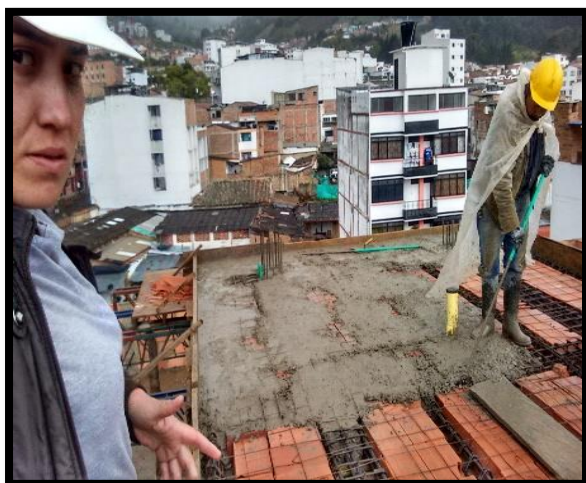
Ilustración 5. Fundida de Placa Aligerada para tanque Aéreos
