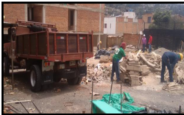
Ilustración 25. Limpieza de Terreno.
