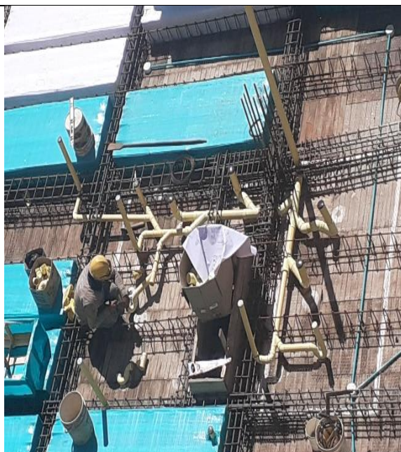
Ilustración 40. Ubicación e Instalación de Tubería Sanitaria en Placa
