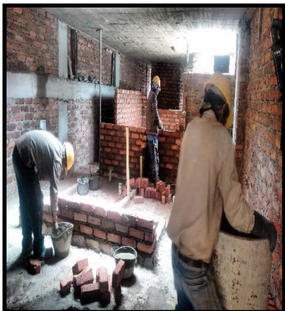
Ilustración 7. Levantamiento de Muro en ladrillo cocido
