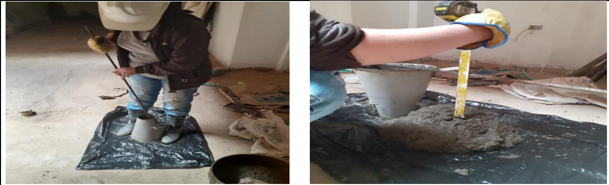
Ilustración 22. Ensayo en Campo Comprobación de Asentamiento
