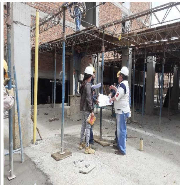
Ilustración 37. Armado de Encofrado para Primer Placa Aligerada.
