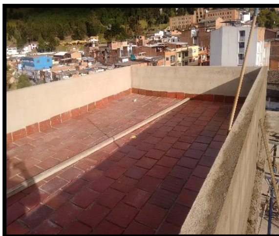
Ilustración 6. Placa Aligerada para Tanque Aéreos terminada
