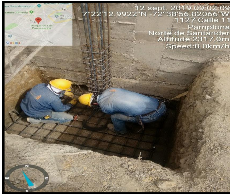
Ilustración 30. Detalle en sitio de zapatas
