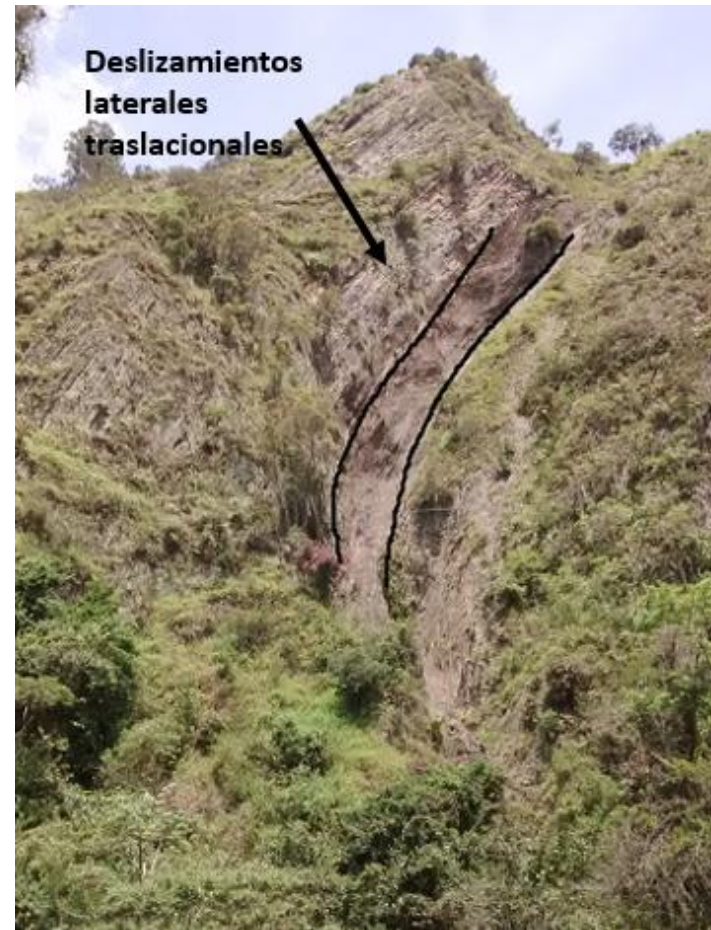
Imagen 6. Deslizamiento traslacional activo
