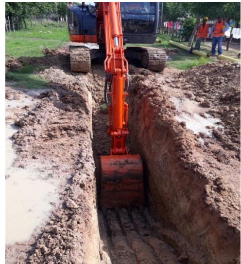
Figura 9. Excavaciones para la instalación de la red de alcantarillado.
