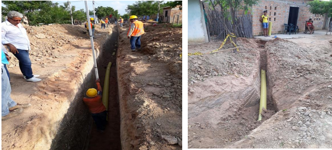
Figura 10. Tubería red principal y acometida. Fuente Autor.( J MENA)
