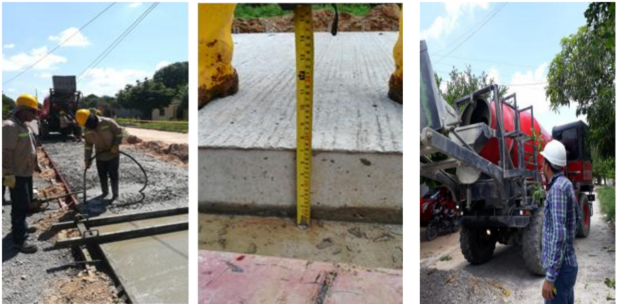
Figura 17: Pavimento en concreto de 3500PSI. Fuente autor (J MENA)
