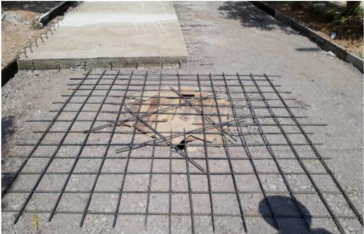
Figura 18: Acero de refuerzo Corrugado. Fuente (J MENA)
