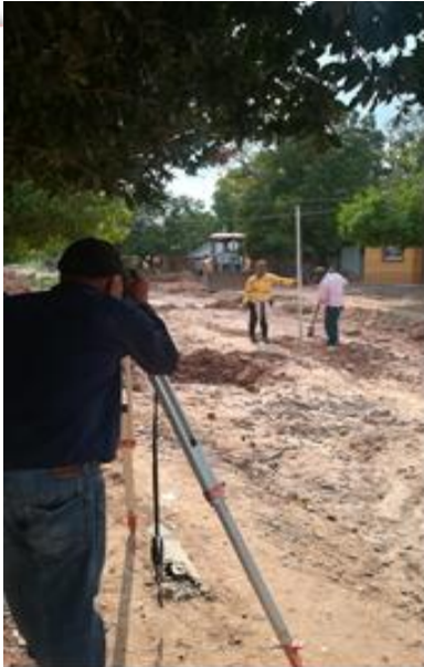
Figura 14 Localización y replanteo topográfico. Fuente: autor ( J MENA )
