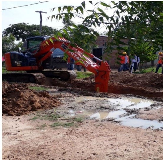
Figura 9. Excavaciones para la instalación de la red de alcantarillado.
