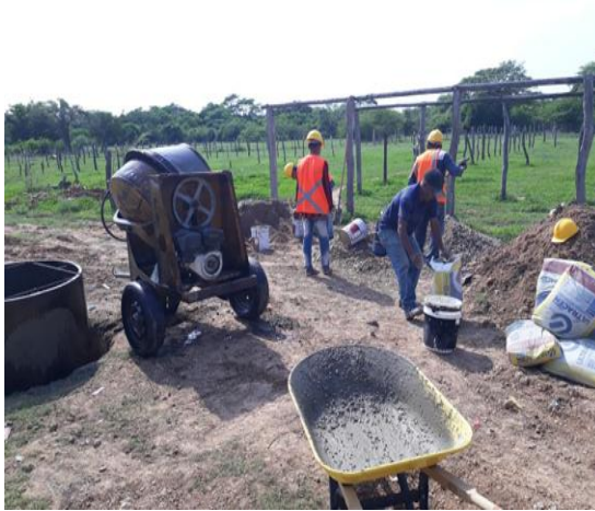
Figura12. Fundida de pozos de inspección y cajillas. Fuent: autor (J MENA )
