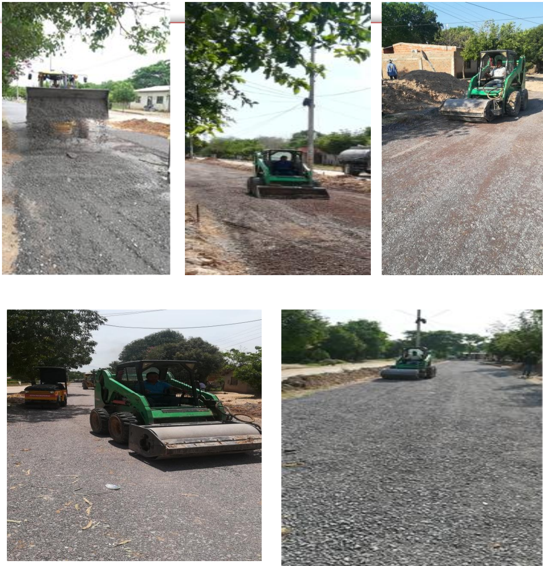
Figura 16. Afirmado base granular. Fuente Autor (JMENA)
