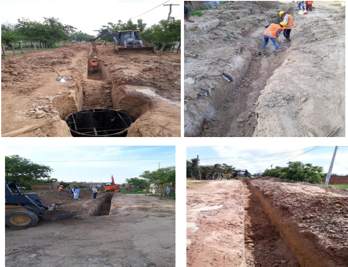
Figura 11. Relleno de tramos excavados. Fuente: Autor (J MENA )
