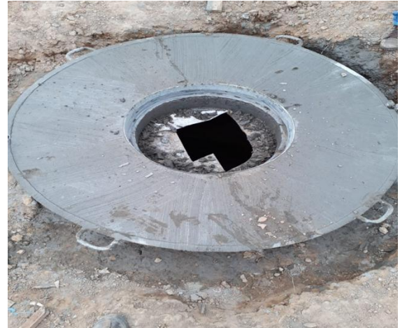
Figura12. Fundida de pozos de inspección y cajillas. Fuent: autor (J MENA )
