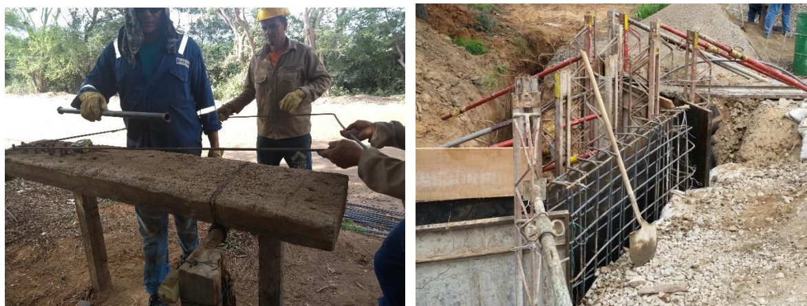
Figura 10: Figuración y aramado de acero
