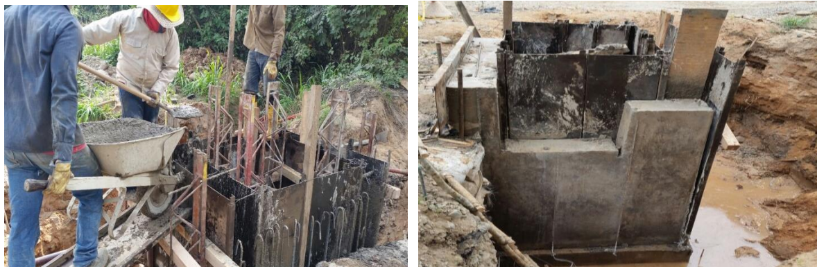
Figura 11: Fundida de concreto
