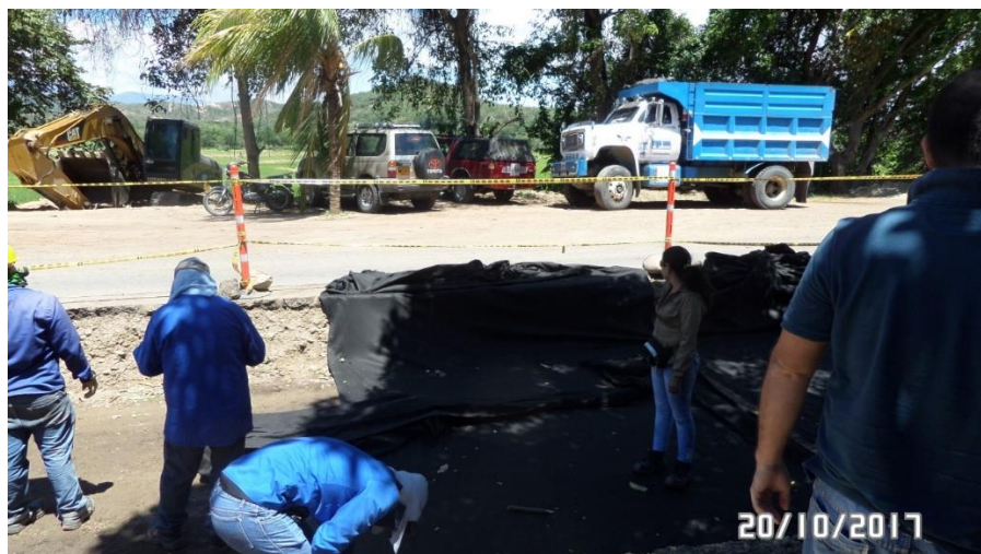
Figura 18: Colocación de geotextil
