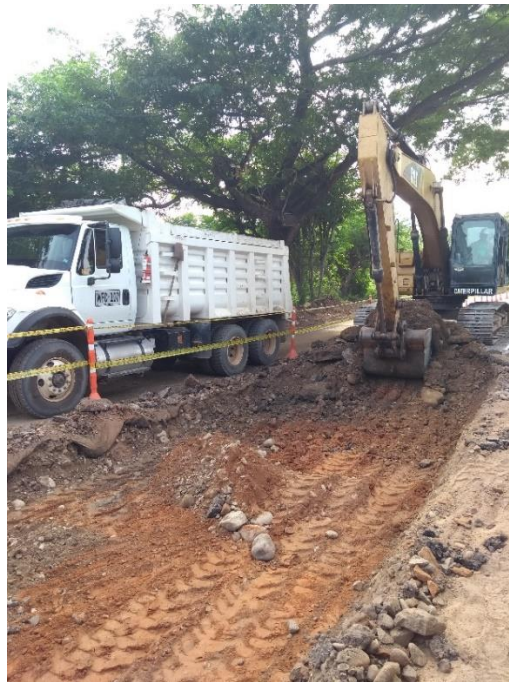
Figura 15: Excavación y carga de tierra
