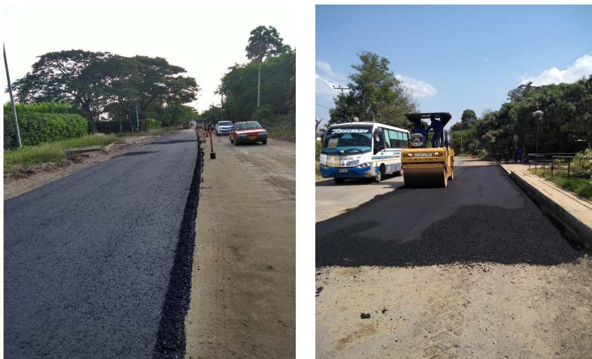
Figura 26: Carpeta de asfalto
