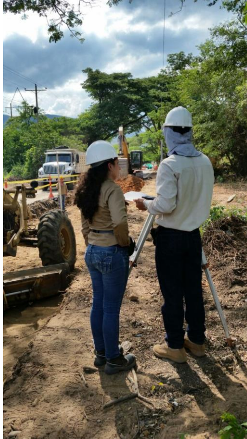
Figura 6: Chequeo de excavación
