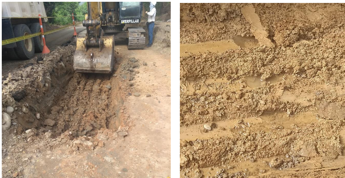
Figura 16: Fallo o colchón en el terreno
