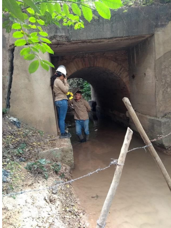
Figura 12: Medición del puente
