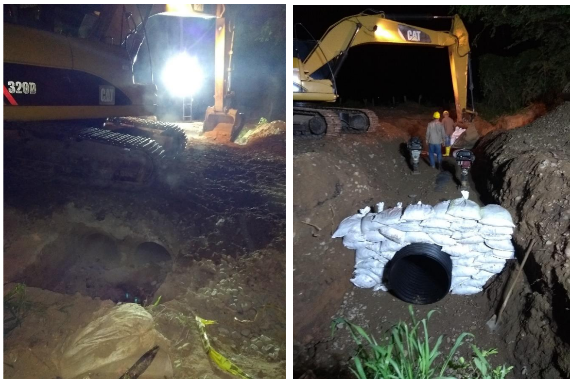
Figura 9: Demolición de alcantarilla existente y colocación de tubería de la nueva alcantarilla
