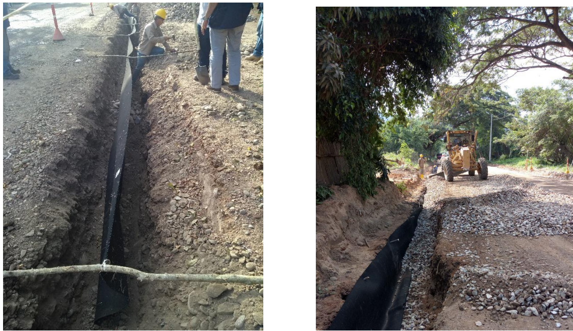
Figura 13: Colocación de filtros y relleno con material seleccionado
