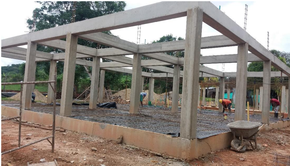
Foto 17. Vaciado Vigas Aéreas (25x35)
