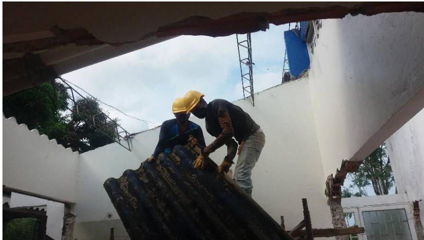
Foto 2. Desmonte y Demolición de Estructura existente en el sitio
