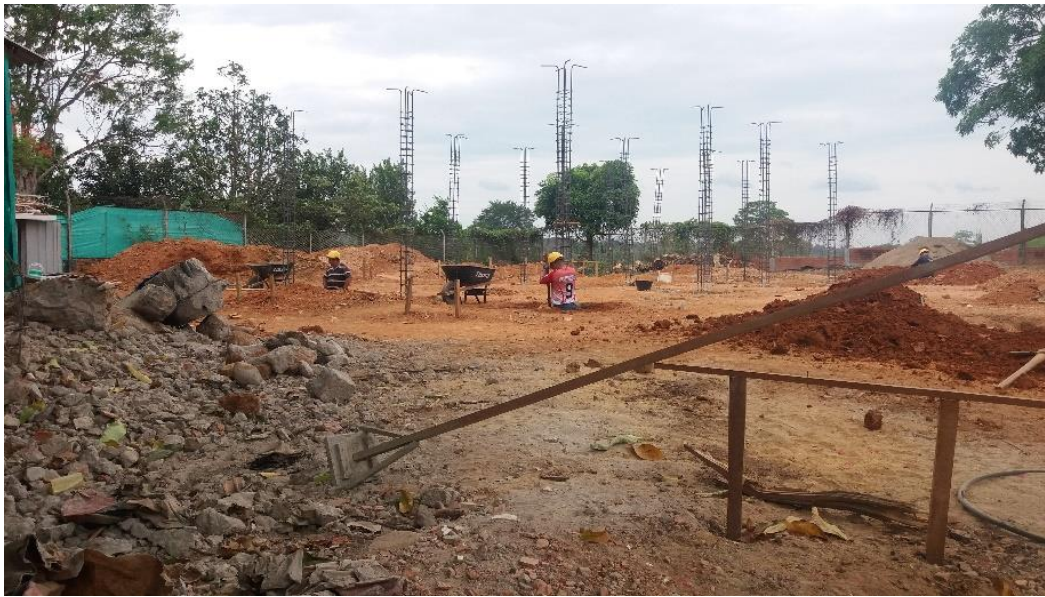
Foto 9. Instalación de Castillos
