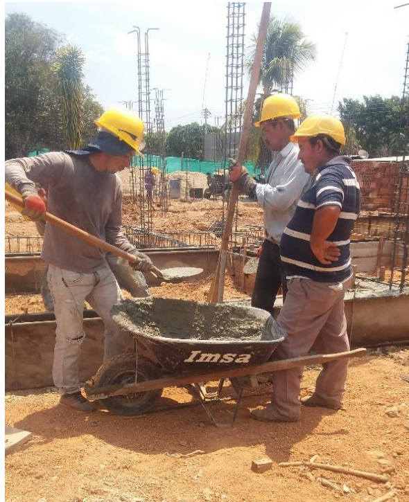
Foto 12. Vaciado Vigas Cimentación (25x40)
