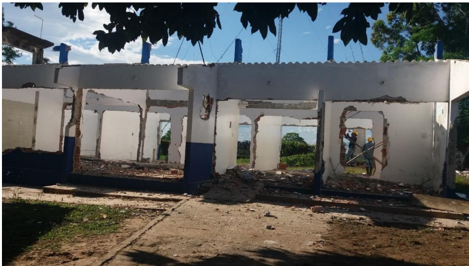
Foto 3. Desmonte y Demolición de Estructura existente en el Sitio
