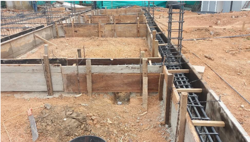
Foto 11. Figurado Acero Vigas de Cimentación
