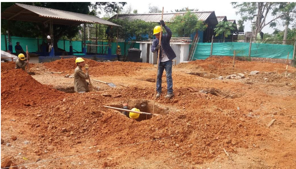
Foto 8. Excavaciones para Zapatas
