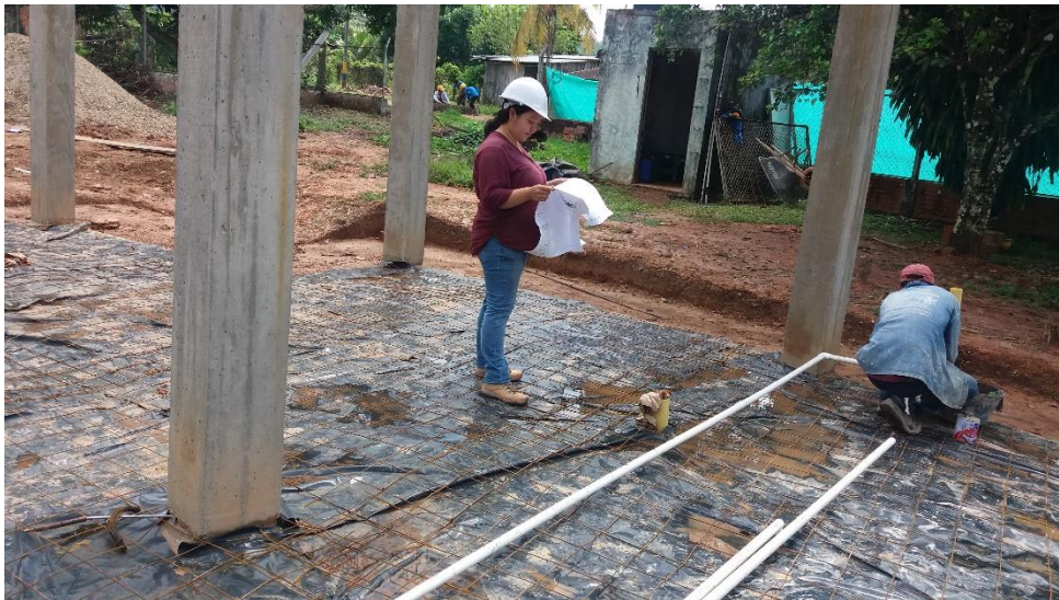
Foto 14. Instalación Tubería Hidráulica
