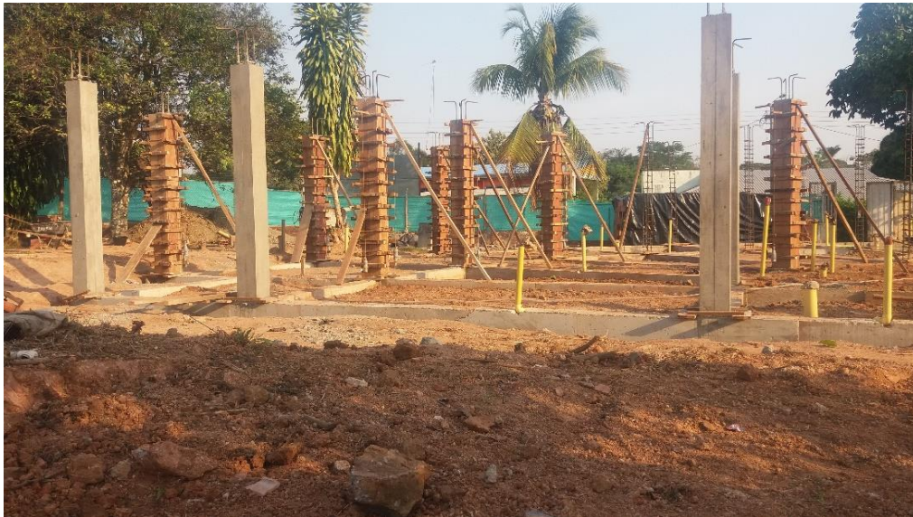
Foto 13. Vaciado Columnas (25x25)
