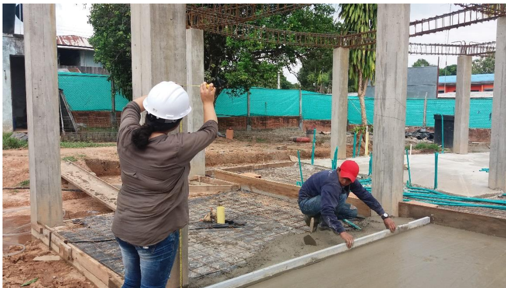
Foto 15. Vaciado Placa Piso (E=10cm)
