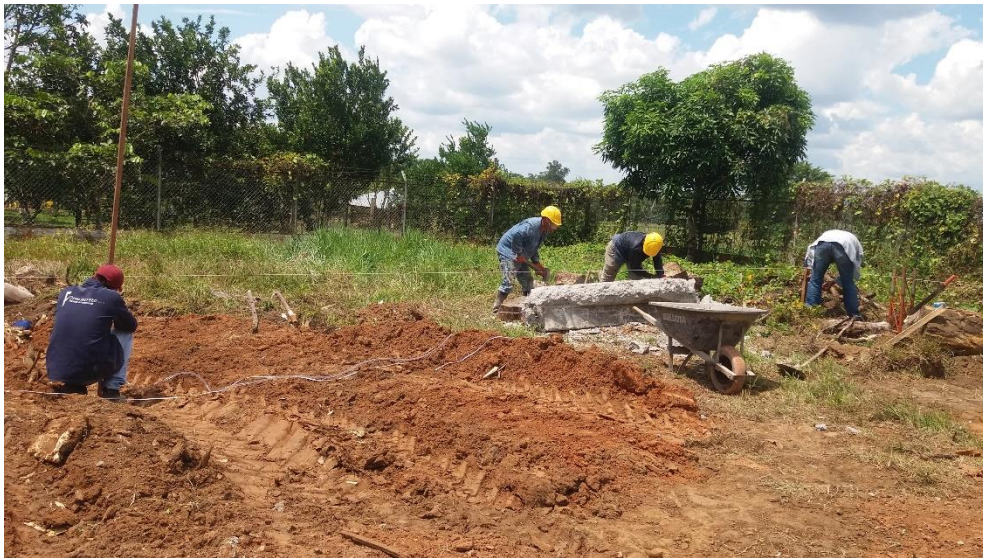
Foto 7. Localización y Replanteo
