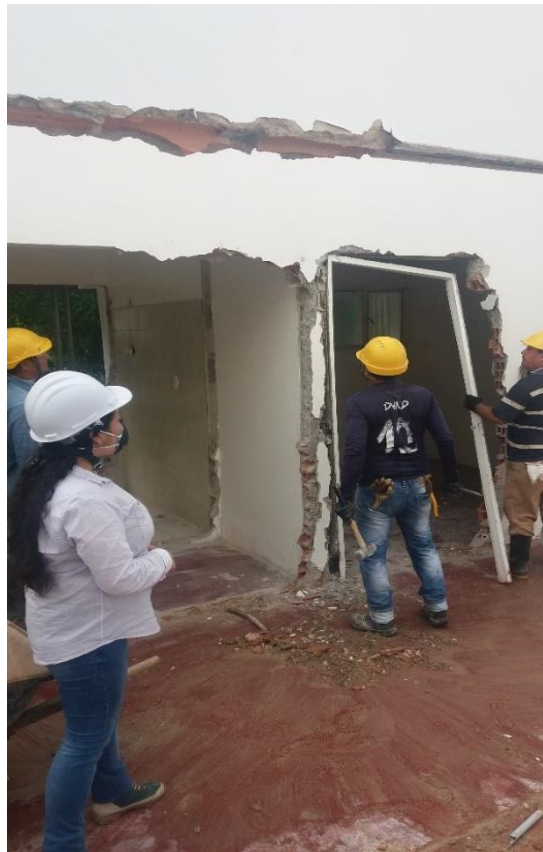
Foto 1. Desmonte y Demolición de Estructura existente en el sitio
