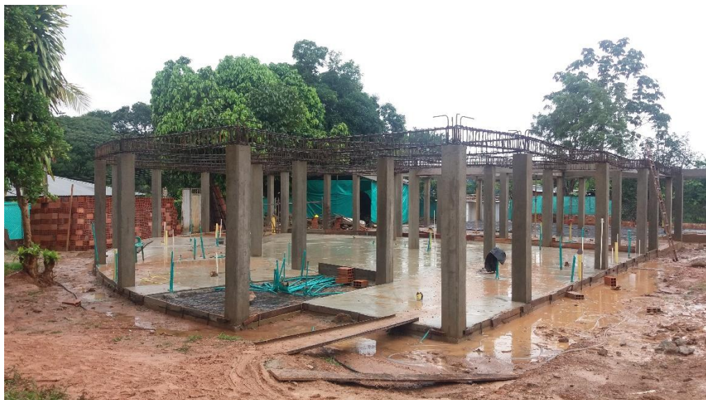
Foto 16. Acero Vigas Aéreas
