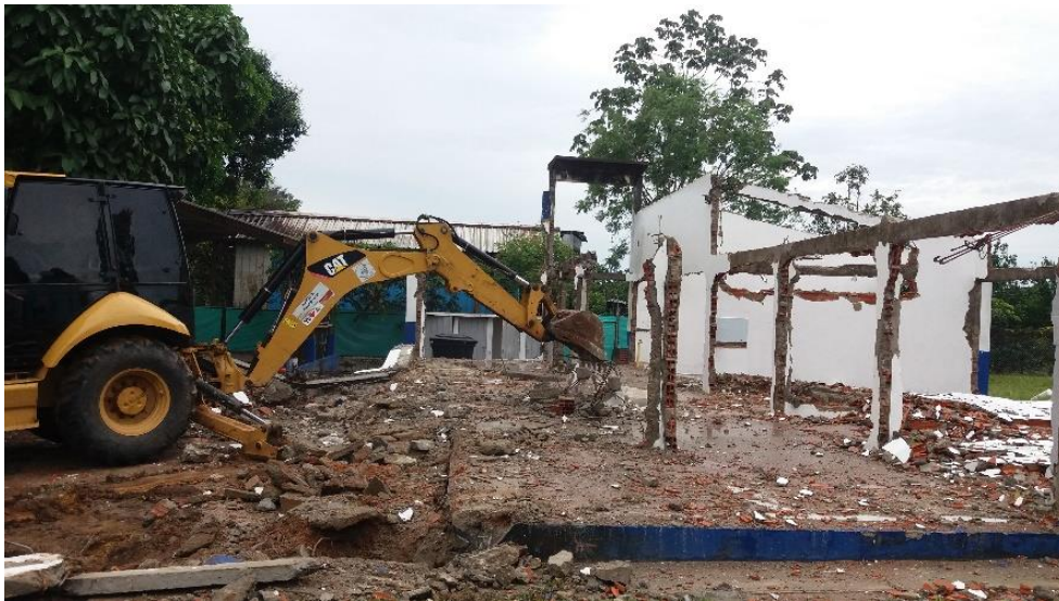
Foto 5. Demolición con Retroexcavadora
