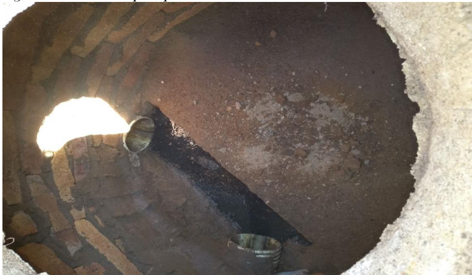
Figura 8. Construcción de pozos.
