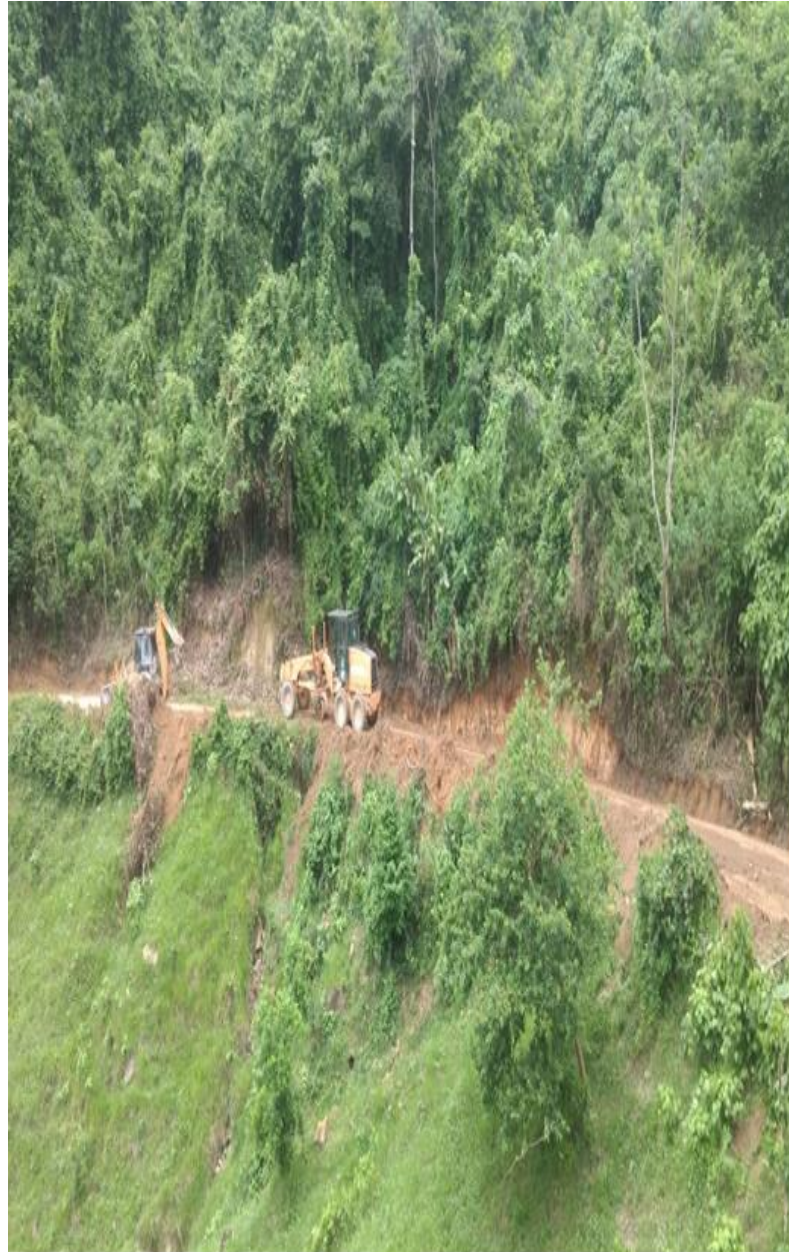
Figura 13. Vista perfil trabajo en obra.
