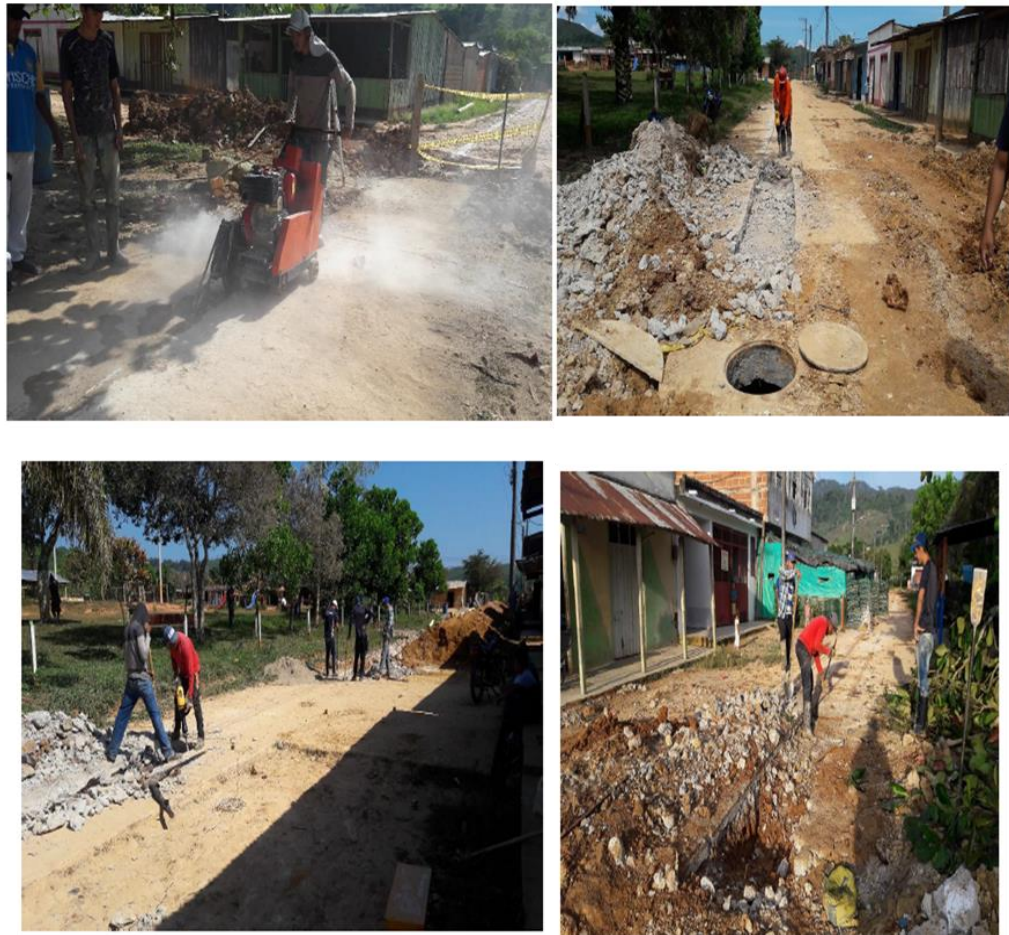
Figura 4. Demolición de capa de pavimento existente.
