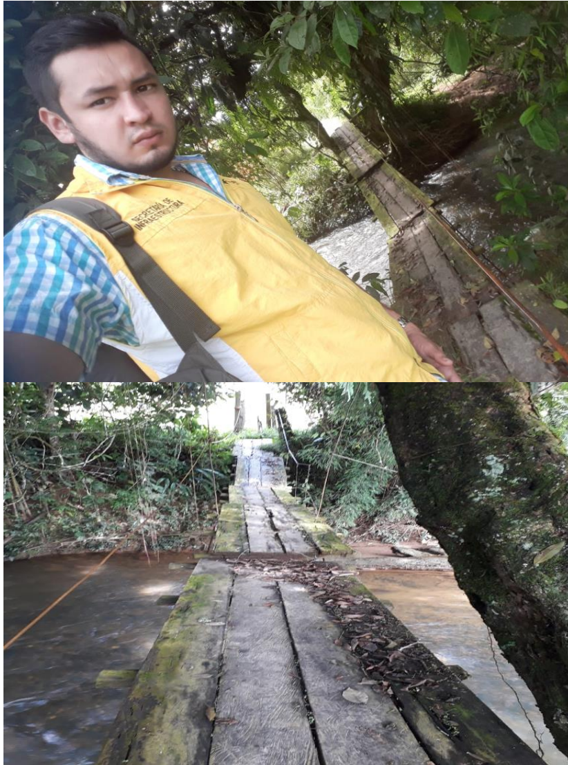
Figura 18. Puente colgante corregimiento de villalflor.
