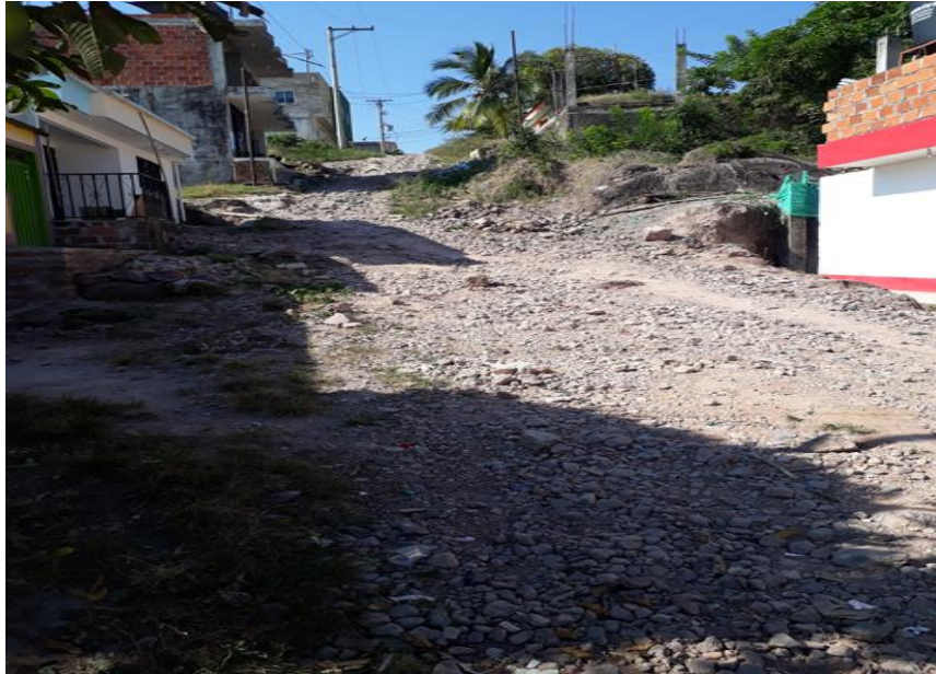
Figura 15. Tramo de vía sector la loma sin pavimentar.
