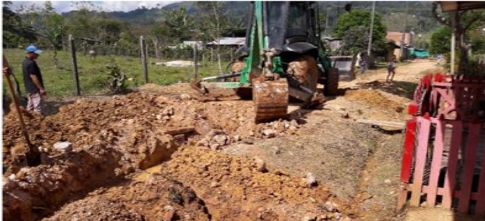
Figura 5. Excavación para la colocación de tubos.
