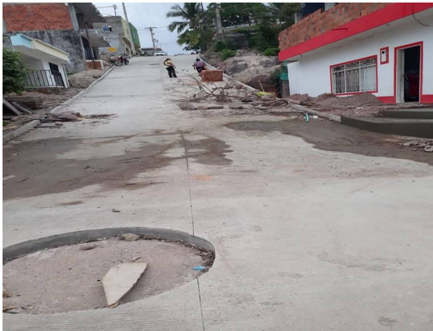
Figura 16. Tramo de vía sector la loma pavimentado.
