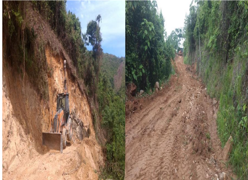
Figura 11. Mejoramiento de la vía de acceso.
