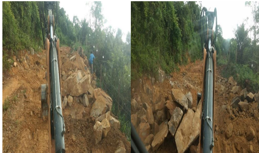
Figura 12. Demolición de roca y adecuamiento del terreno.
