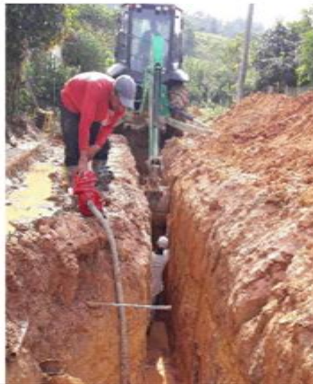
Figura 6. Colocación de la tubería.
