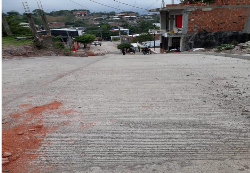
Figura 17. Tramo de vía sector la piladora pavimentado.
