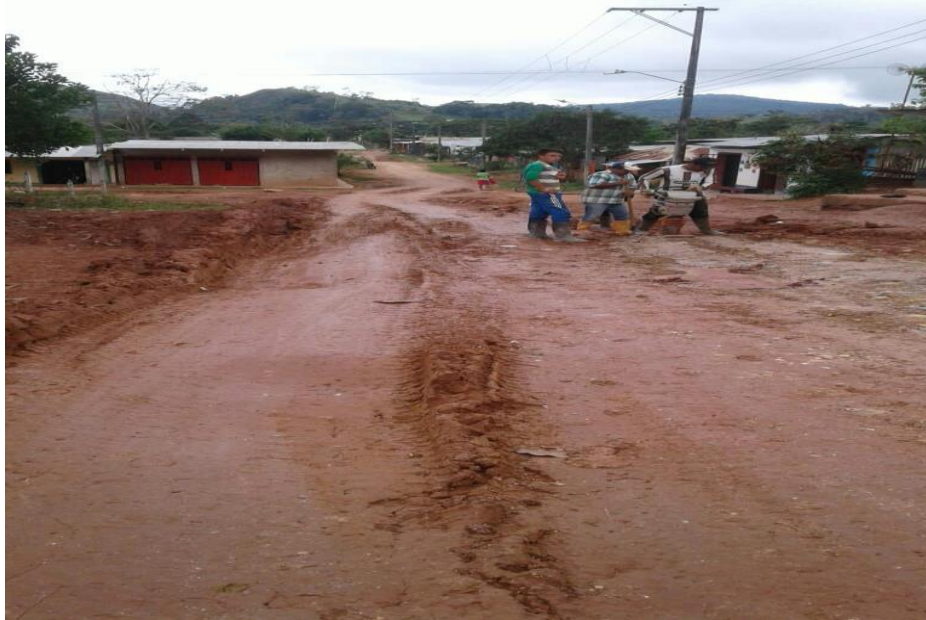
Figura 9. Relleno y compactación en las vías.
