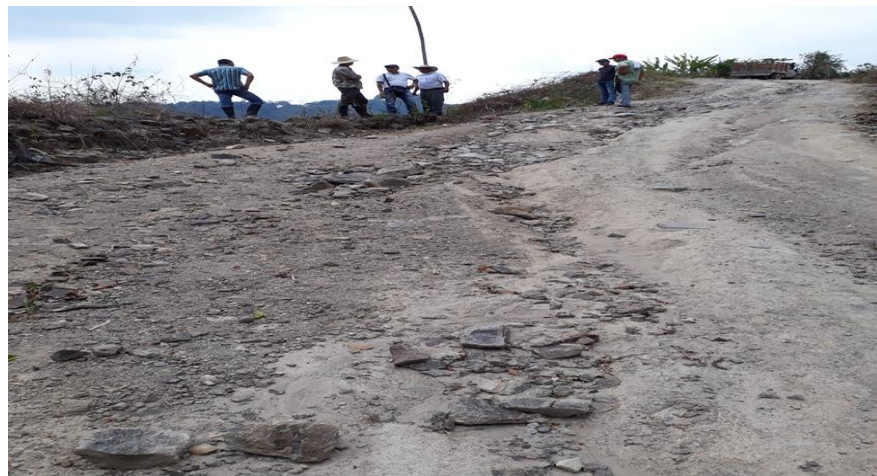
Figura 10. Visita de reconocimiento a lugar de la obra placa huella.
