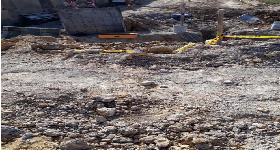
Figura 7. Excavación para pozos.
