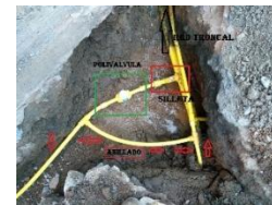
Ilustración 23. Instalación de la silleta y la polivalvula.
