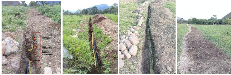
Ilustración 13. Proceso de instalación de tubería.
