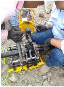
Ilustración 20. Calentamiento de tubería con la plancha.
