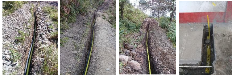
Ilustración 9. Excavaciones para domiciliarias con tubería de 2", 1", 3/4", y 1/2".
