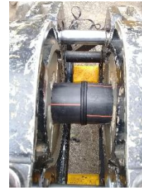
Ilustración 21. Pega final de la tubería.
