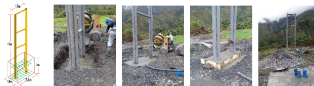
Ilustración 34. Construcción de la columna H.
