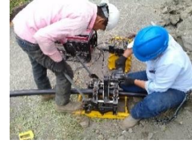
Ilustración 19. Biselada de la tubería.
