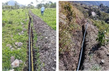
Ilustración 8. Excavaciones con tubería de 3" y 2".
