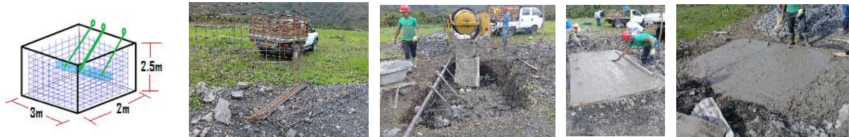
Ilustración 35. Construcción del muerto.
