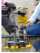
Ilustración 18. Tubería alineada en el equipo.
