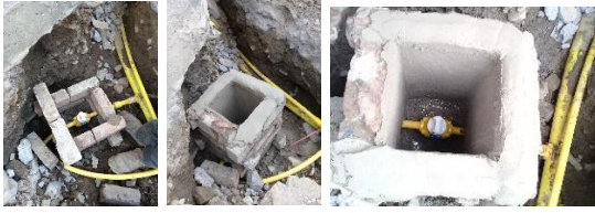
Ilustración 24. Construcción caja de polivalvula.
