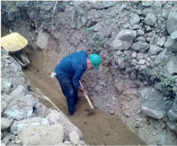
Figura 19. Suministro de Colchón de arena para proteger la tubería
