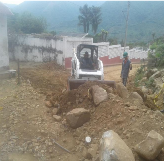
Figura 24. Rellenos y compactación de excavaciones
