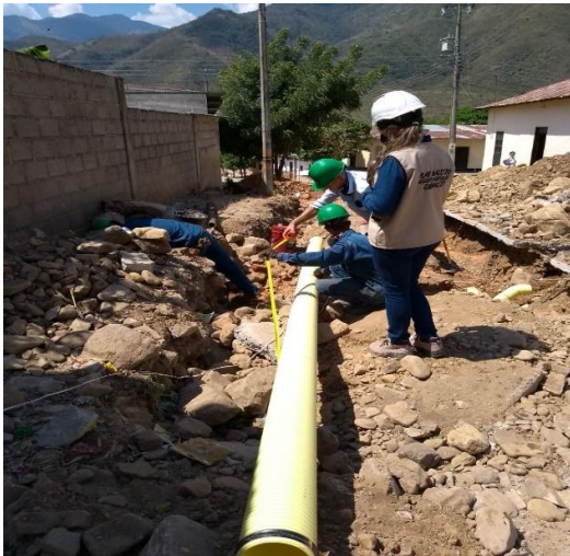
Figura 20 Instalación de tubería de acueducto
