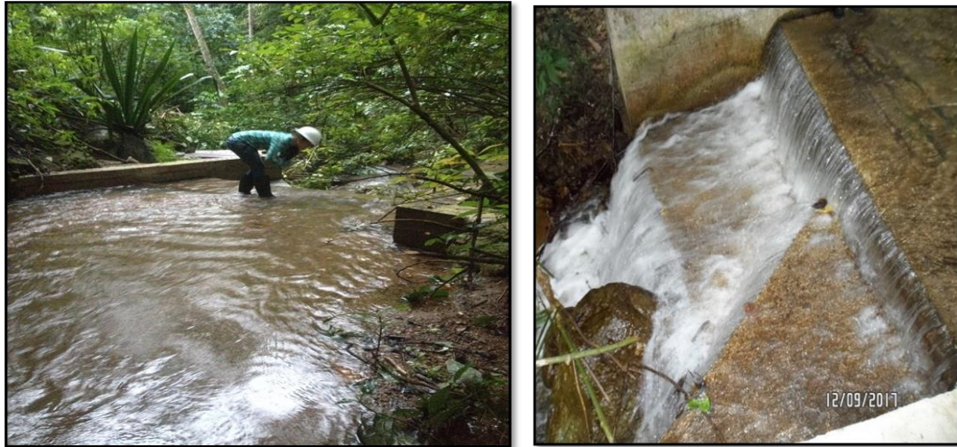
Figura 12. Reconocimiento de las estructuras hidráulicas existentes Bocatoma, desarenador
