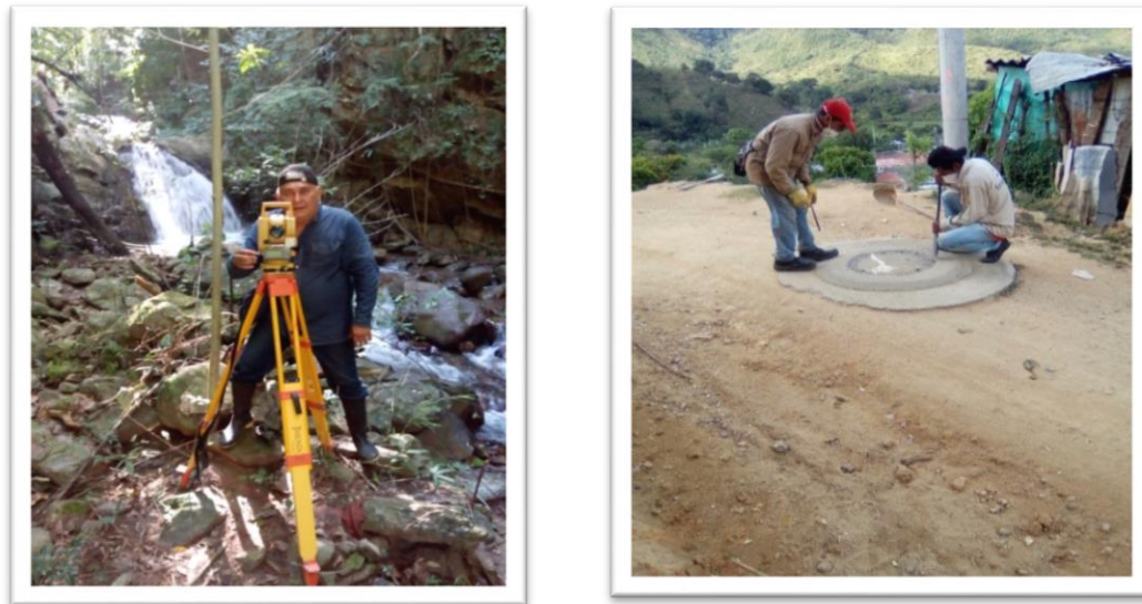
Figura 13. Localización y replanteo de redes, levantamiento topográfico
