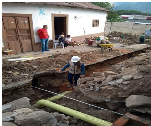
Figura 18. Excavación Manual en roca
