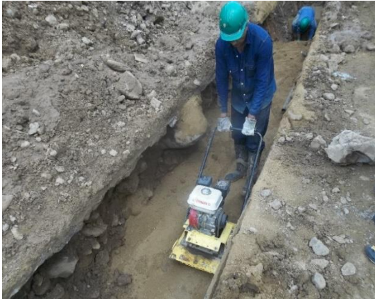
Figura 24. Rellenos y compactación de excavaciones
