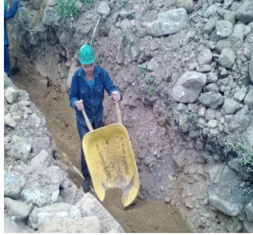
Figura 19. Suministro de Colchón de arena para proteger la tubería
