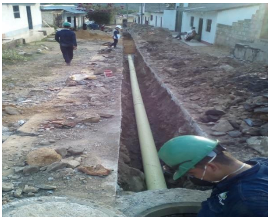
Figura 21. Instalación de tubería de Alcantarillado
