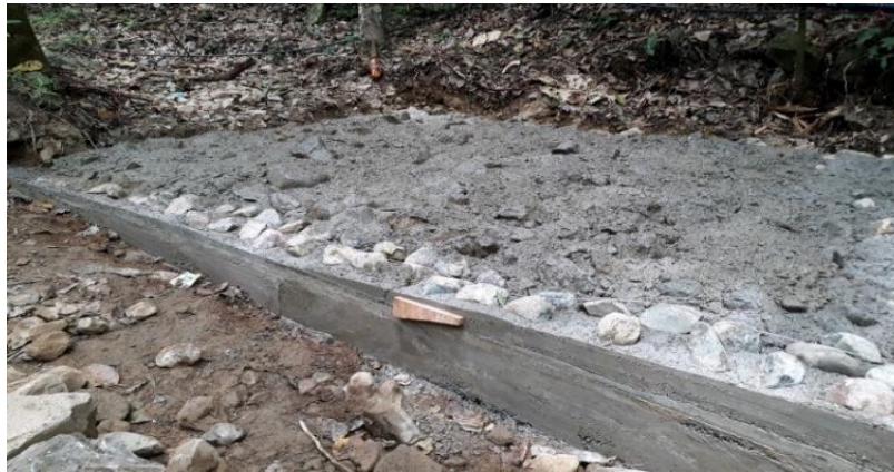
Figura 27. Construcción del desarenador
