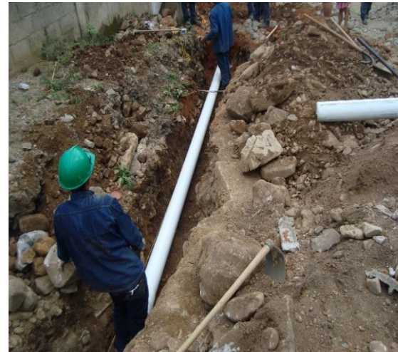
Figura 19. Suministro de Colchón de arena para proteger la tubería
