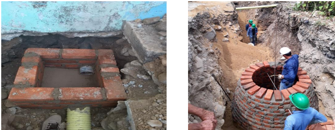
Figura 23. Construcción de Cajas de inspección y pozos de inspección
