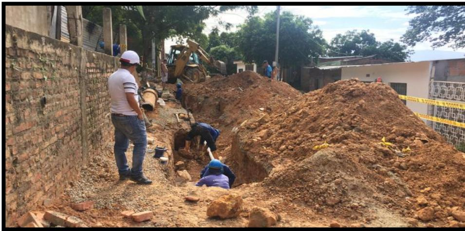
Gráfico No.21 Instalación tubería de  $\varnothing$  3" paralelo a tubería matriz de  $\varnothing$  20" barrio Carora
