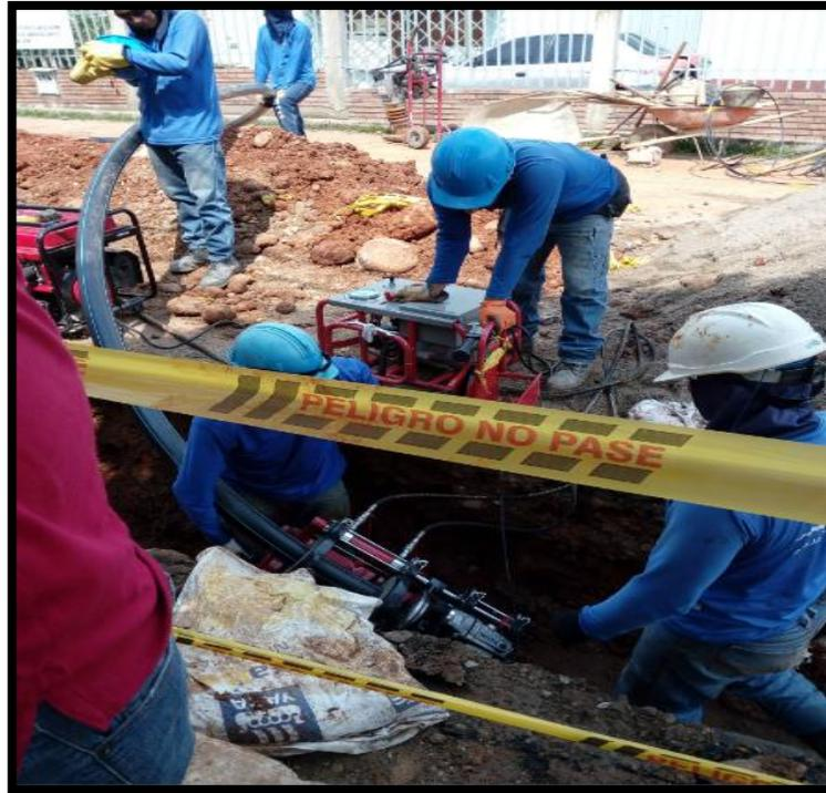
Gráfico No.22 Instalación tubería de  $\varnothing 3''$  en polietileno por proceso de termo fusión, barrio Bella Vista
