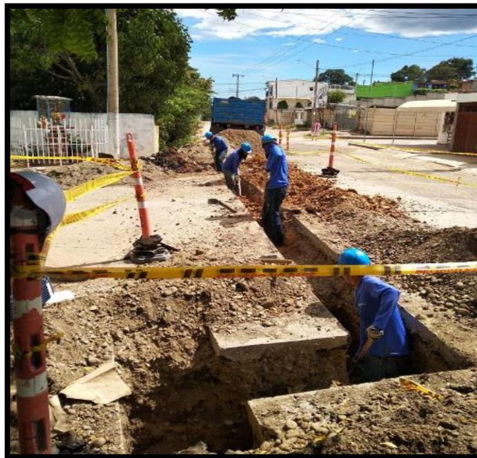
Gráfico No.25 Excavación manual según ancho de corte, barrio Santander
