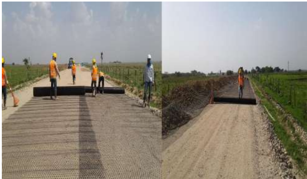
Figura 5. Registro fotográfico de la colocación de la geomalla.
