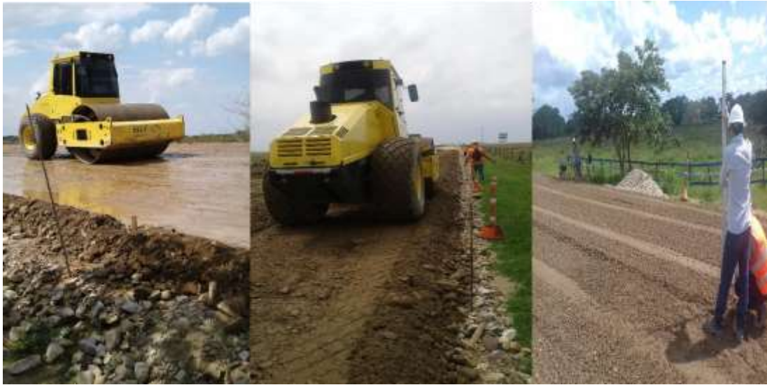
Figura 6. Registro fotográfico de supervisión del extendido, humectado y compactado de las capas del pavimento. Fuente Autor.
