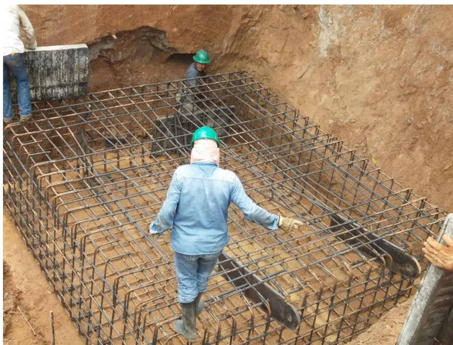
Figura 30: Amarre de acero muerto, zona dos (Fuente: Autor)
