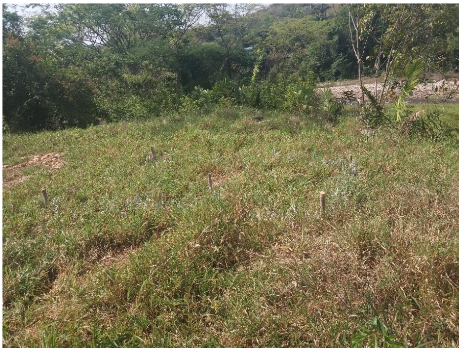
Figura 15: Localización y replanteo zapata torre, zona dos (Fuente: Autor)
