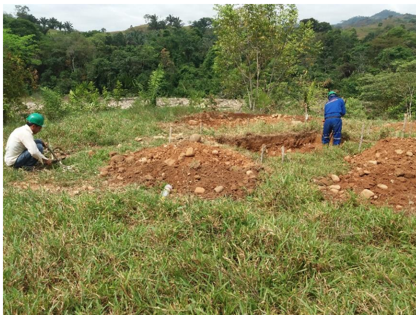
Figura 19: Excavación Zapata torres, zona dos (Fuente: Autor)
