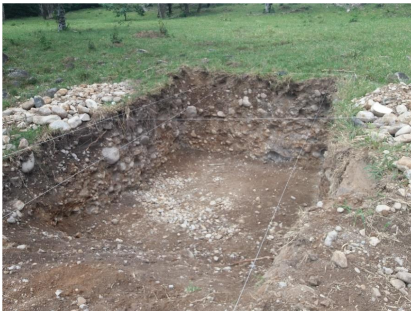
Figura 18: Excavación muerto, zona uno (Fuente: Autor)
