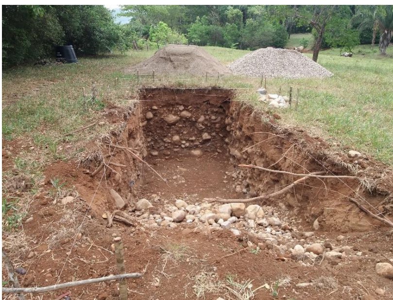
Figura 17: Excavación zapata torre, zona uno (Fuente: Autor)
