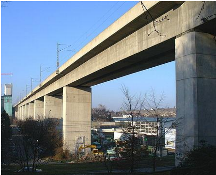
Figura 4:viaducto ferroviario en Stuttgart Cannstatt (Fuente: Google maps)
