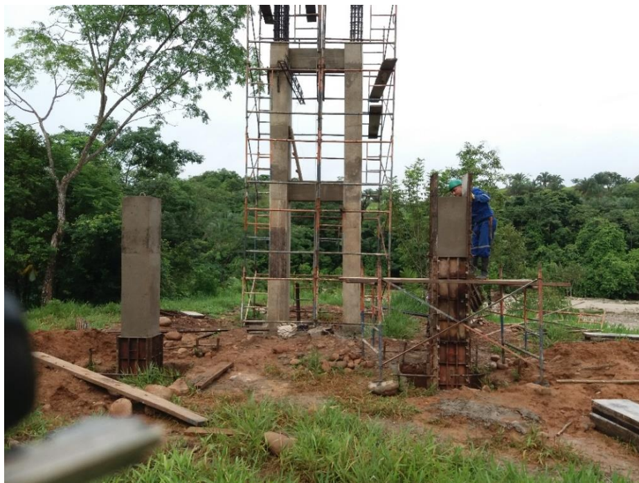
Figura 46: Columnas Cortavientos, zona dos (Fuente: Autor)
