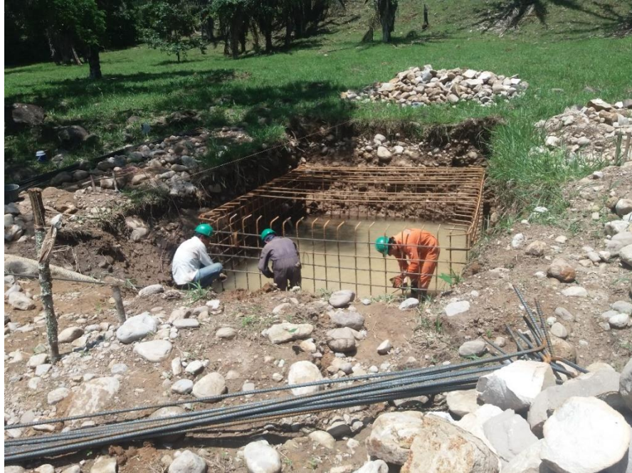
Figura 27: Amarre de acero muerto, zona uno (Fuente: Autor)
