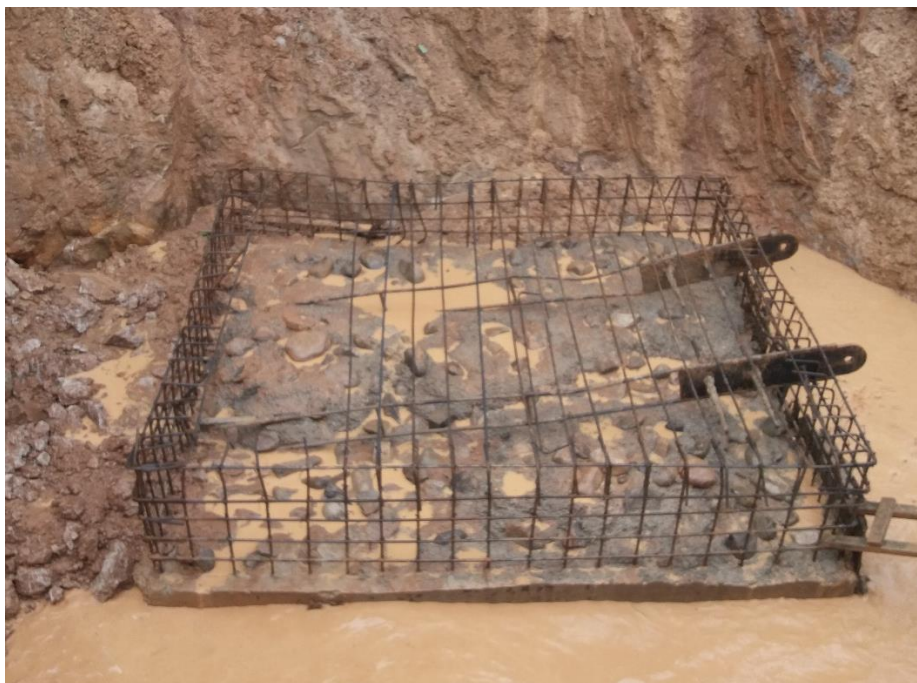
Figura 53: Limpieza y amarre de acero muerto, zona dos (Fuente: Autor)
