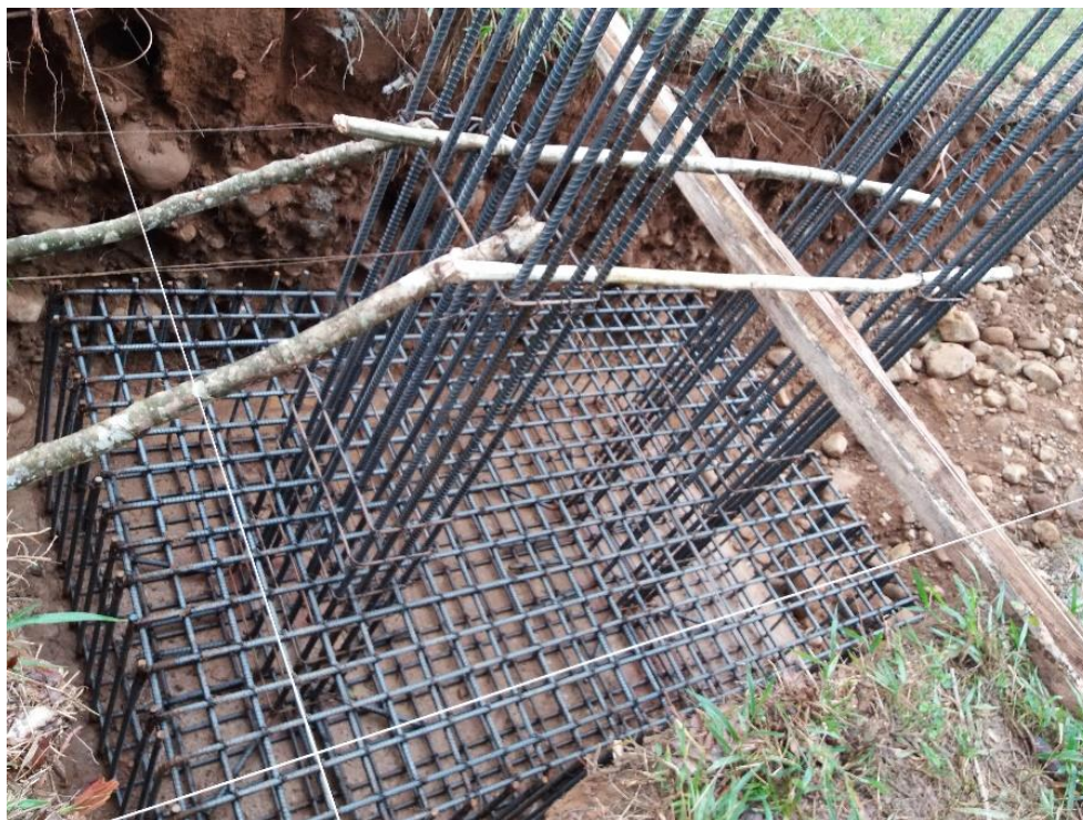
Figura 21: Amarre de acero zapata torre, zona uno (Fuente: Autor)
