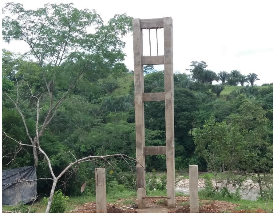
Figura 48: Torre Zona dos terminada (Fuente: Autor)
