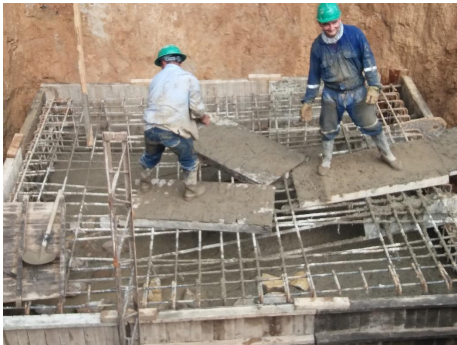
Figura 31: Fundición muerto, zona dos (Fuente: Autor)
