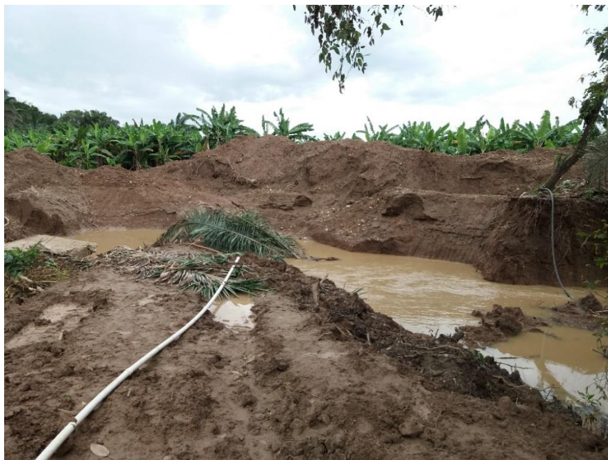
Figura 69: Desviación del cauce por excavación costado derecho (Fuente: Autor)
