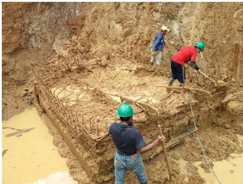
Figura 50: Retiro manual de lodo, muerto zona dos (Fuente: Autor)
