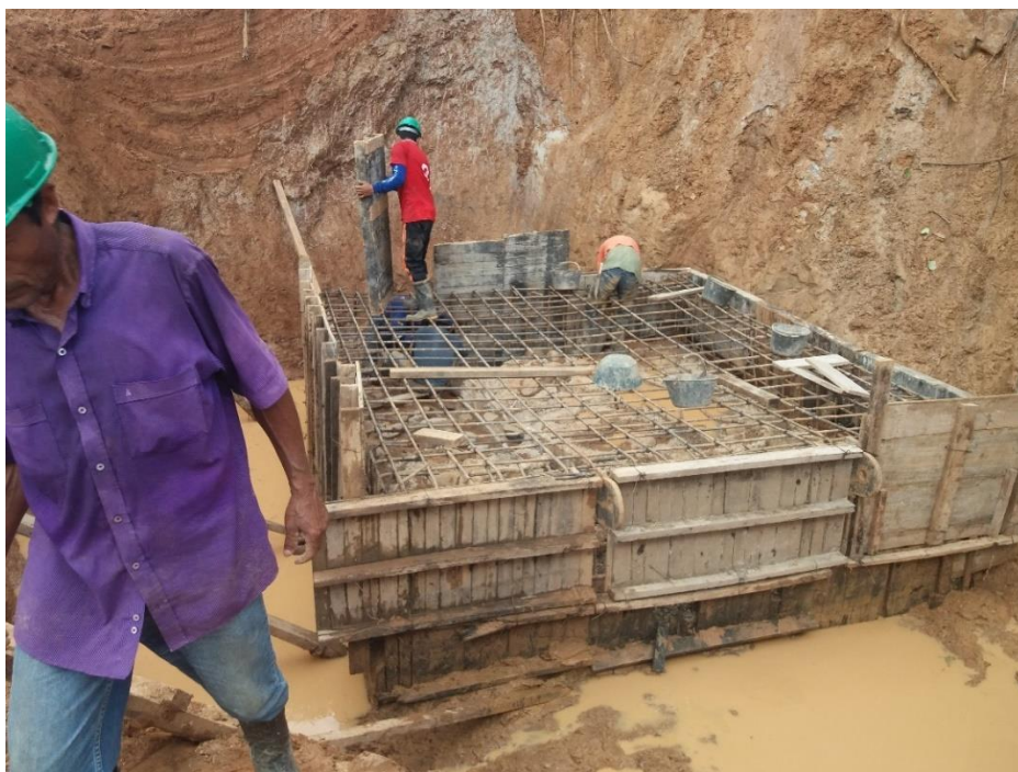
Figura 54: Formaleta, muerto zona dos (Fuente: Autor)
