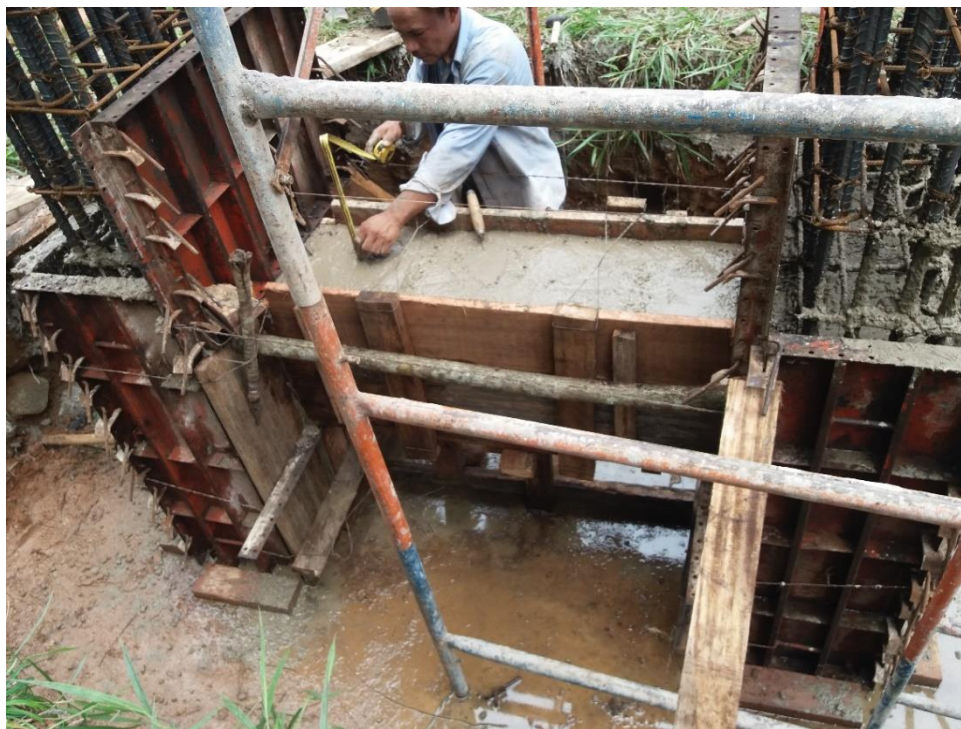
Figura 38: Fundición primer pórtico torre de la zona uno (Fuente: Autor)
