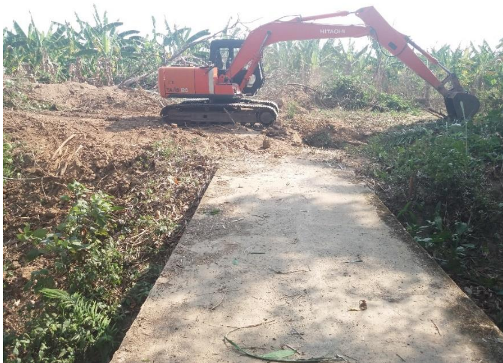
Figura 66: Excavación mecánica costado izquierdo del caño (Fuente: Autor)
