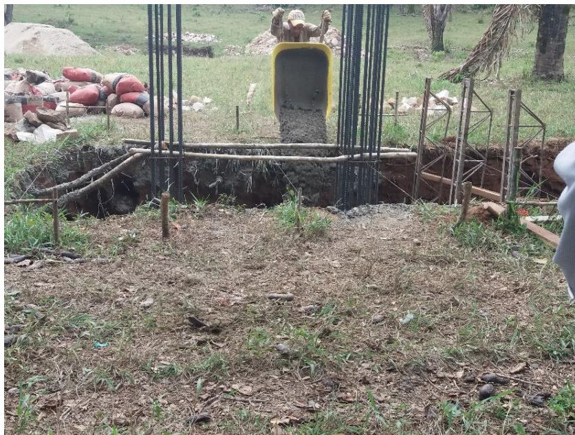
Figura 23: Fundición Zapata, zona uno (Fuente: Autor)
