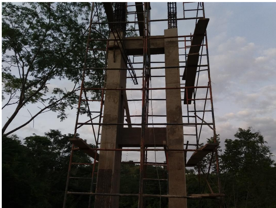
Figura 45: portico dos, torre zona dos (Fuente: Autor)
