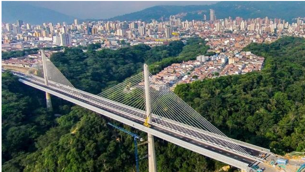
Figura 8: viaducto Bucaramanga (Fuente: Google maps)
