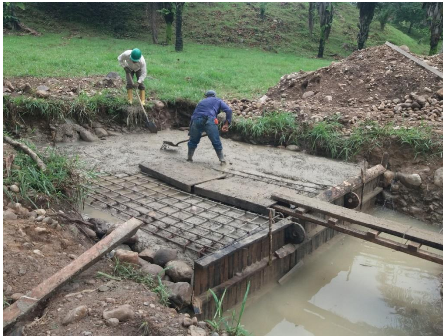
Figura 28: Fundición de muerto, zona uno (Fuente: Autor)
