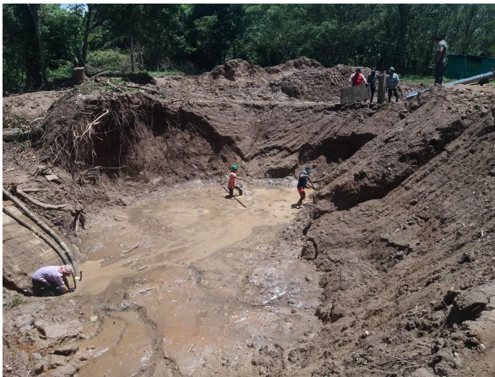
Figura 70: Capa de suelo a 6 metros de excavación, costado izquierdo (Fuente: Autor)
