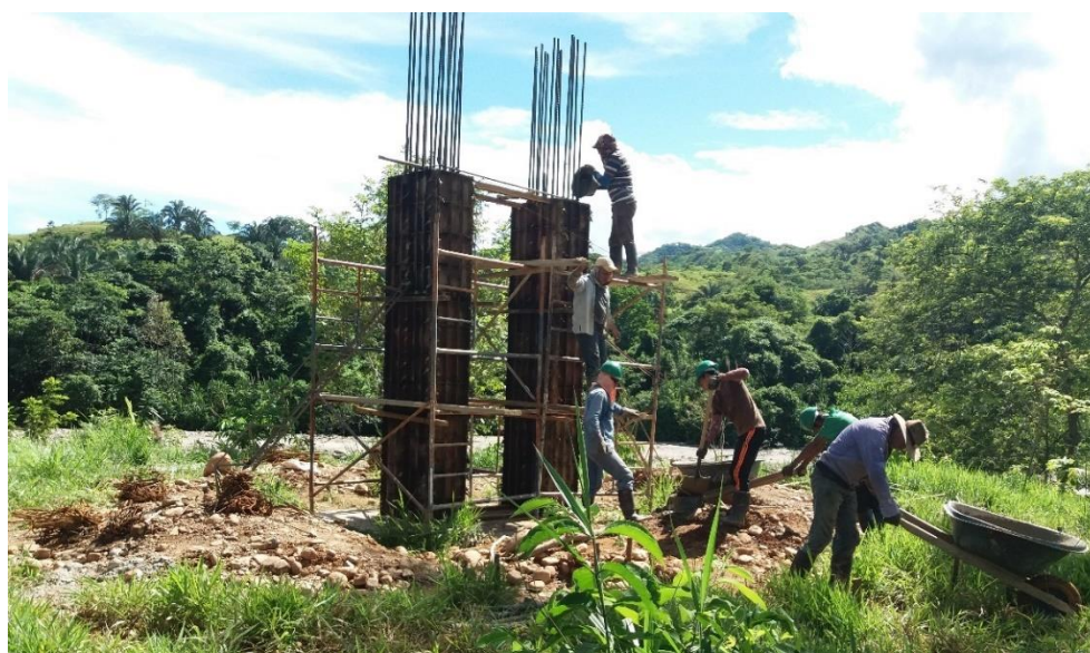
Figura 43: Fundición pórtico uno, torre zona dos (Fuente: Autor)
