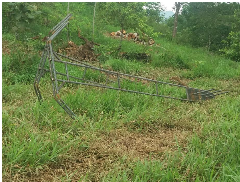
Figura 26: Anclajes para muertos (Fuente: Autor)
