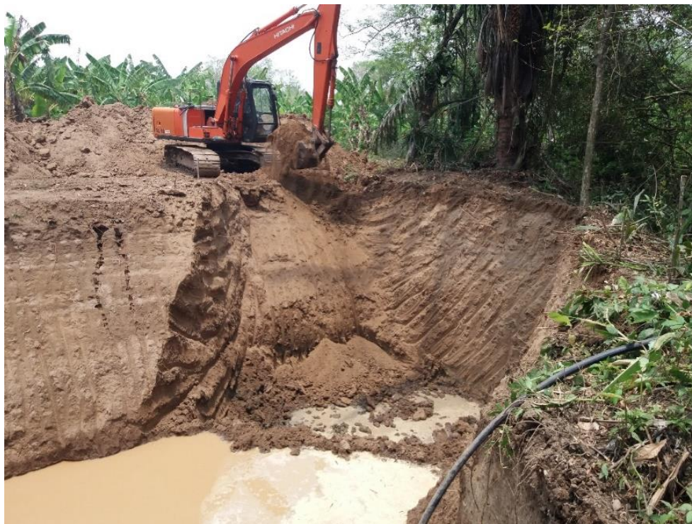
Figura 65: Excavación mecánica costado derecho del caño (Fuente: Autor)
