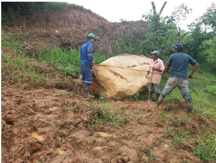
Figura 51: Trabajo de desdoblar el acero afectado para el muerto zona dos (Fuente: Autor)
