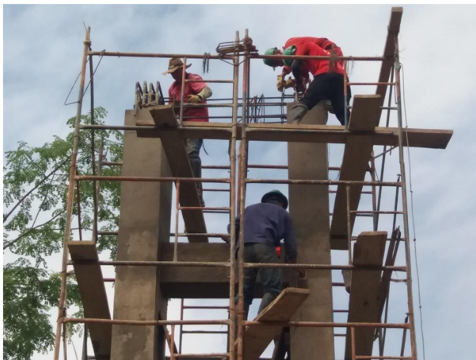
Figura 47: Amarre de acero, torre zona dos (Fuente: Autor)
