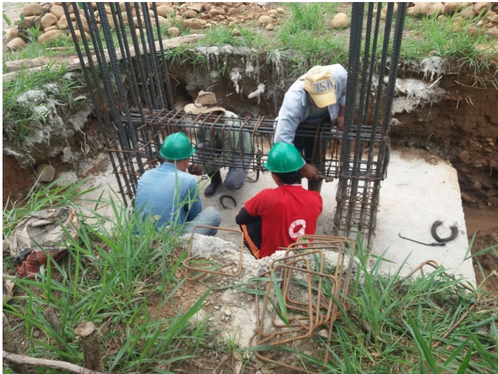
Figura 37: Amarre de acero primer pÓrtico torre, zona uno (Fuente: Autor)
