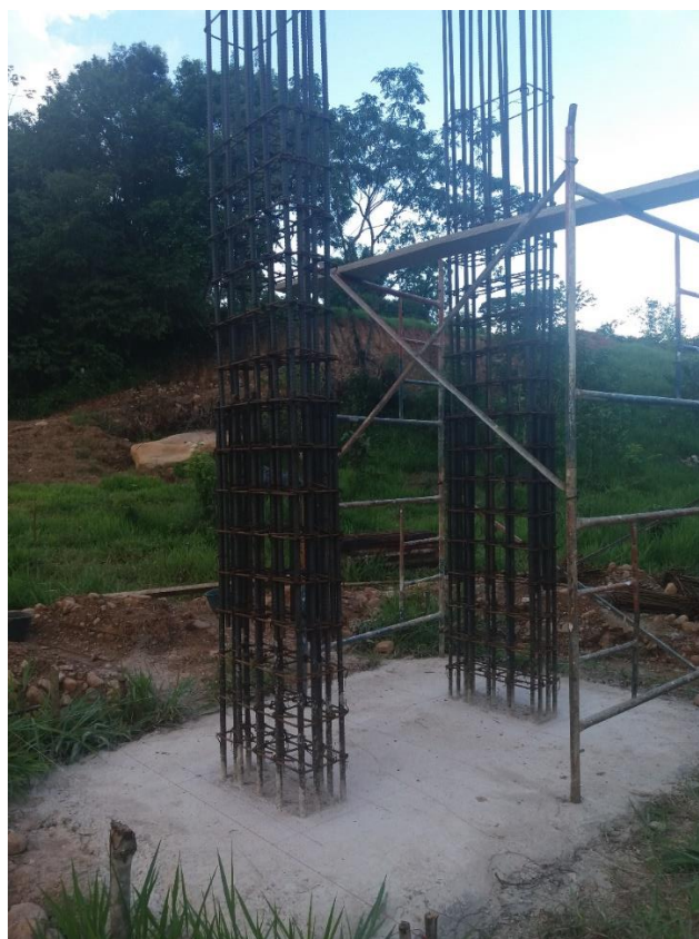
Figura 42: Acero pórtico uno, torre zona dos (Fuente: Autor)
