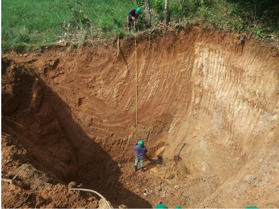
Figura 20: Excavación del muerto, zona dos (Fuente: Autor)
