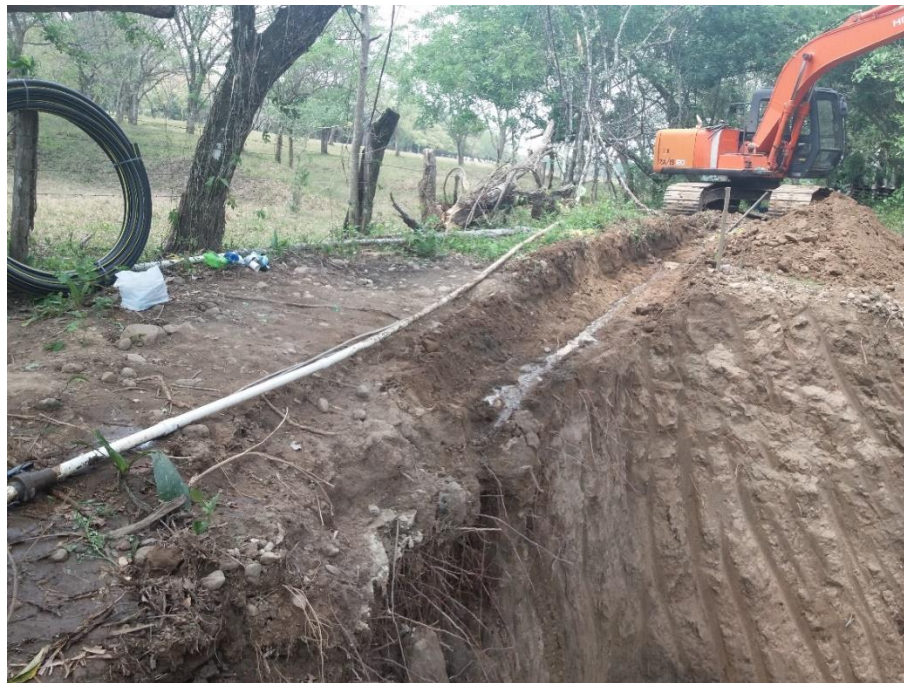
Figura 67: Desviación de línea de acueducto (Fuente: Autor)
