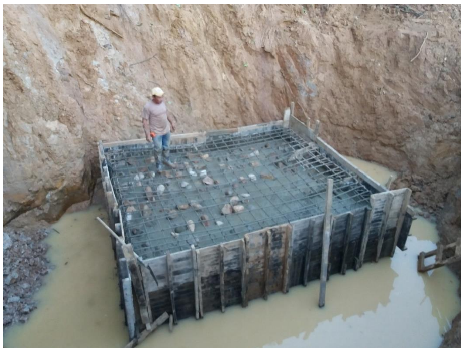
Figura 55: Fundición muerto zona dos (Fuente: Autor)
