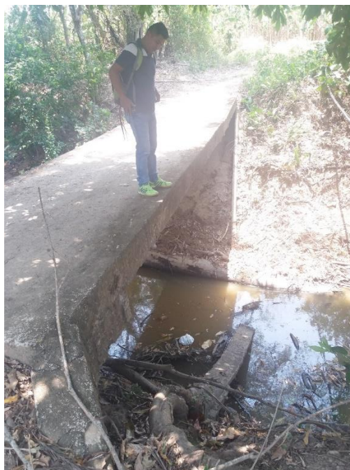
Figura 62: Placa existente en el sitio de la obra (Fuente: Autor)
