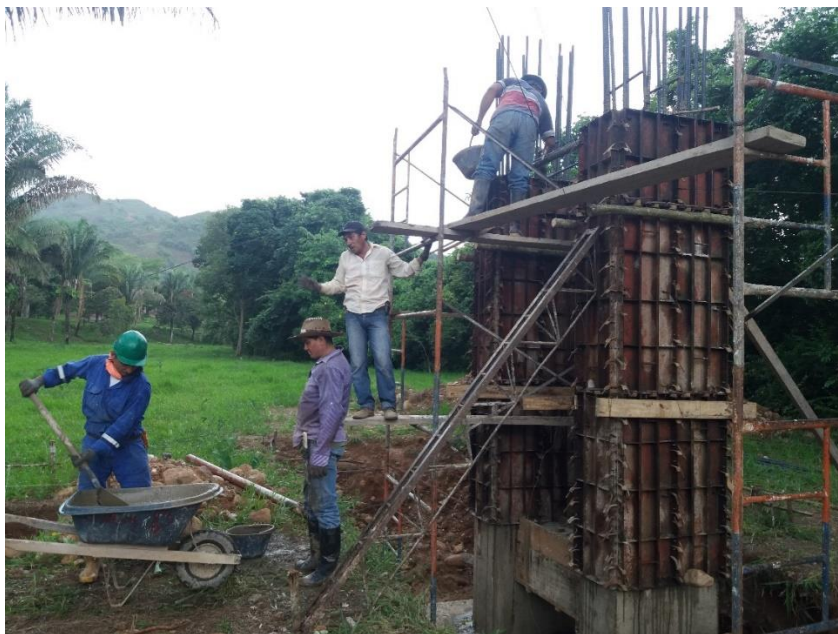
Figura 40: Fundición Columnas Pórtico dos, torre zona uno (Fuente: Autor)
