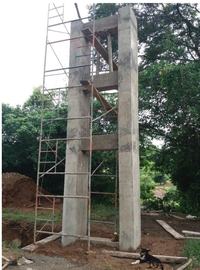
Figura 41: Torre zona uno terminada (Fuente: Autor)
