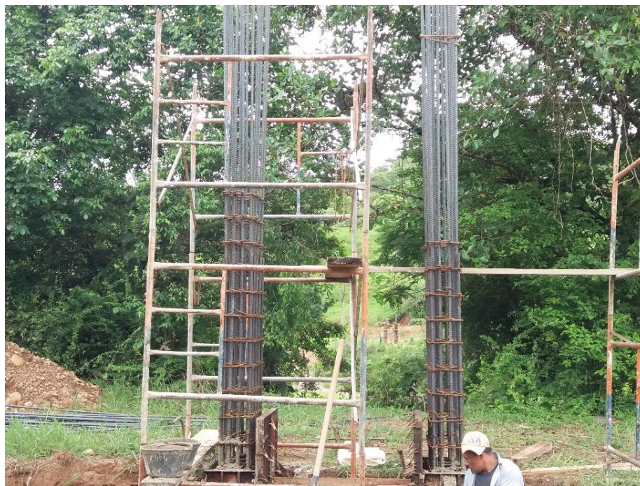
Figura 39: Acero pórtico dos, torre zona uno (Fuente: Autor)
