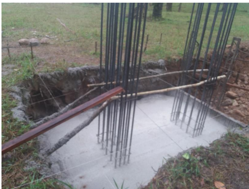
Figura 24: Zapata fundida, zona uno (Fuente: Autor)
