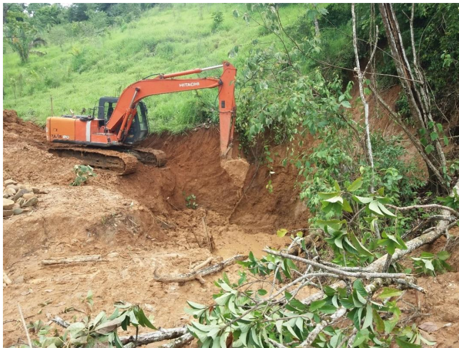
Figura 49: Retiro mecánico de lodo, muerto zona dos (Fuente: Autor)
