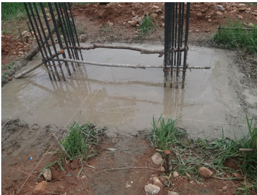
Figura 25: Zapata fundida, zona dos (Fuente: Autor)
