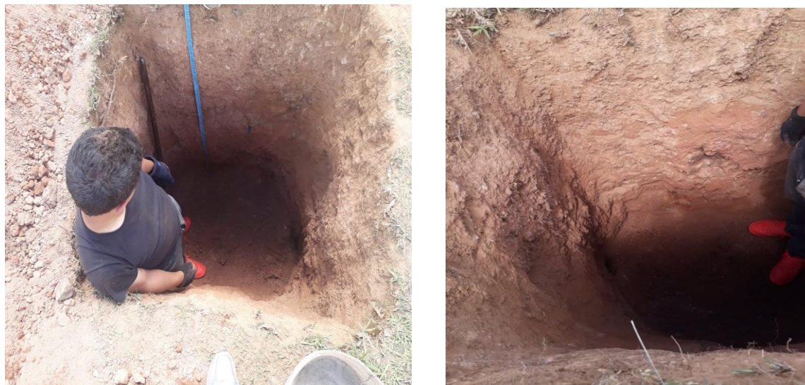
Figura 9. Elaboración de apiques en el área de estudio.
