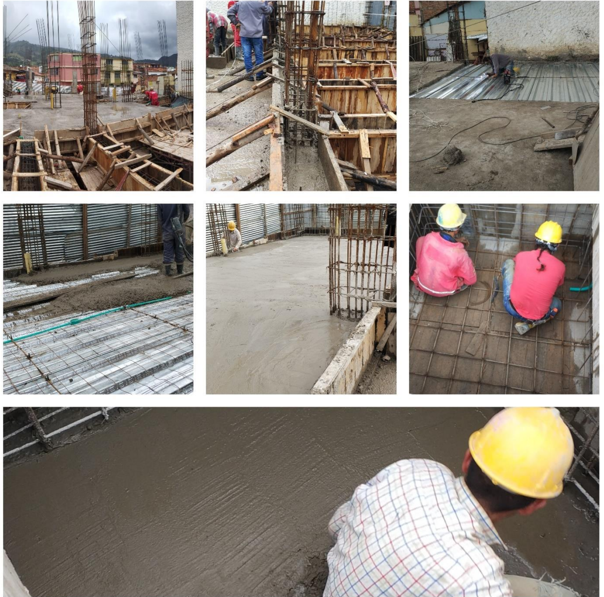
Ilustración 15 Construcción placa faltante 2 y placa 3 de nivel 1 y base para ascensor.
