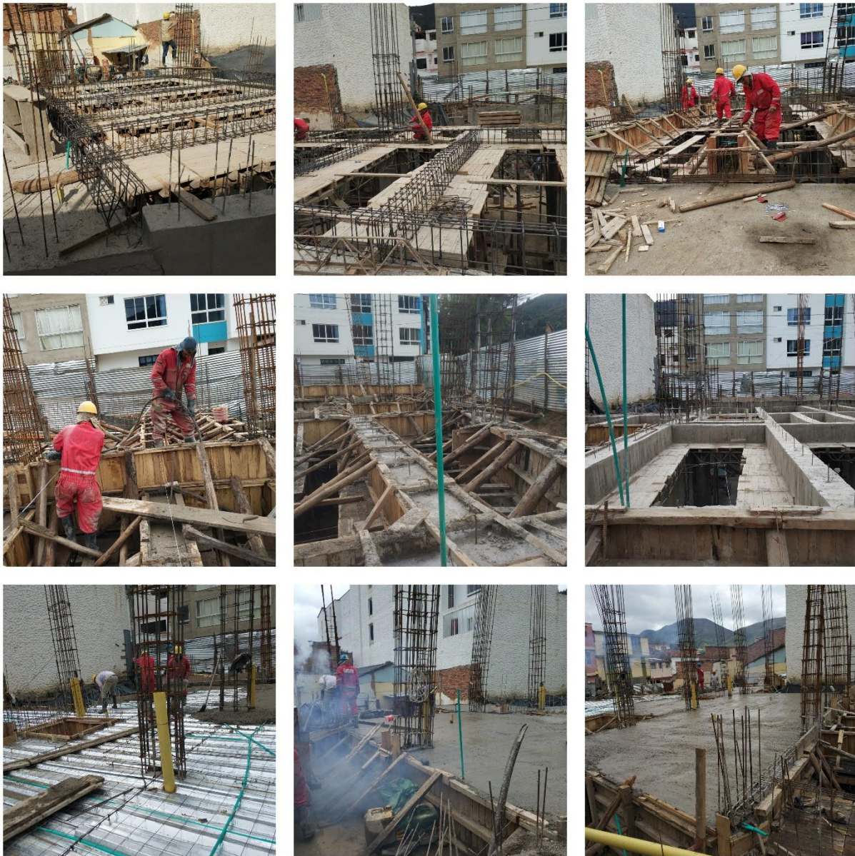
Ilustración 14 Construcción de formaleta, colocación acero respectivo y vaciado de concreto para vigas, placa 2 de nivel 1.
