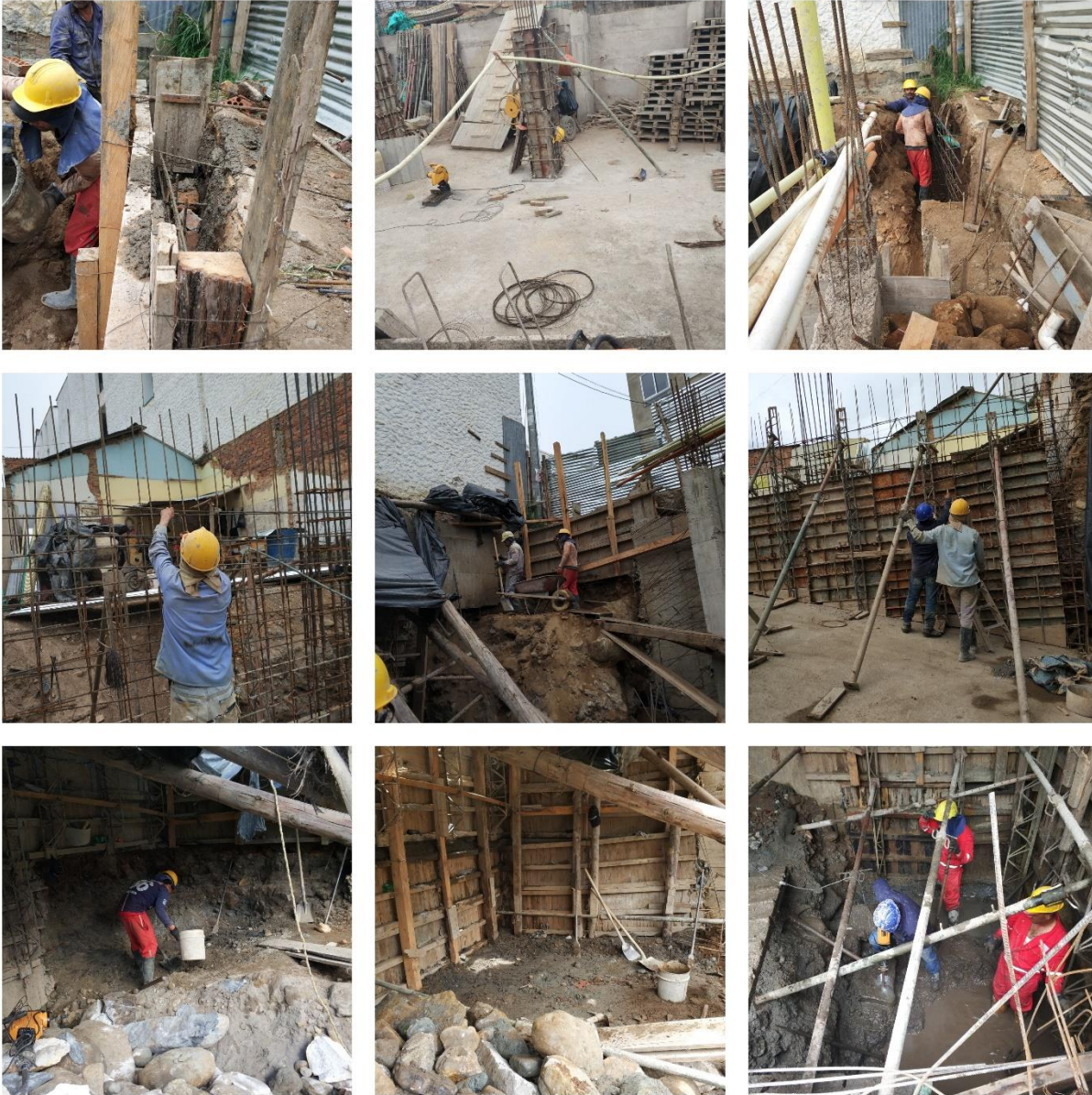
Ilustración 11 Amarre acero, formaleta y fundida de muros pantalla y columnas, excavación zapata z3.
