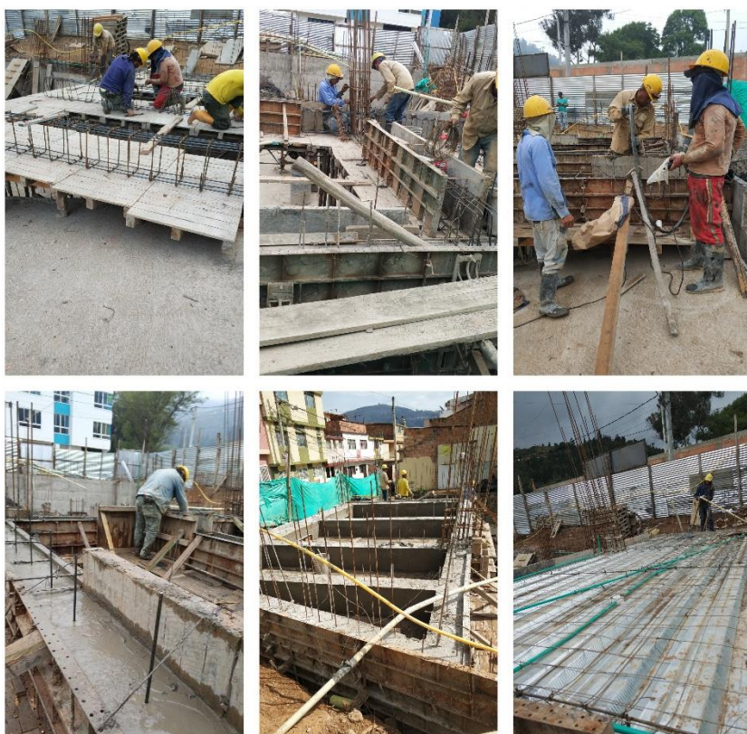
Ilustración 13 Construcción primera placa, nivel 1.
