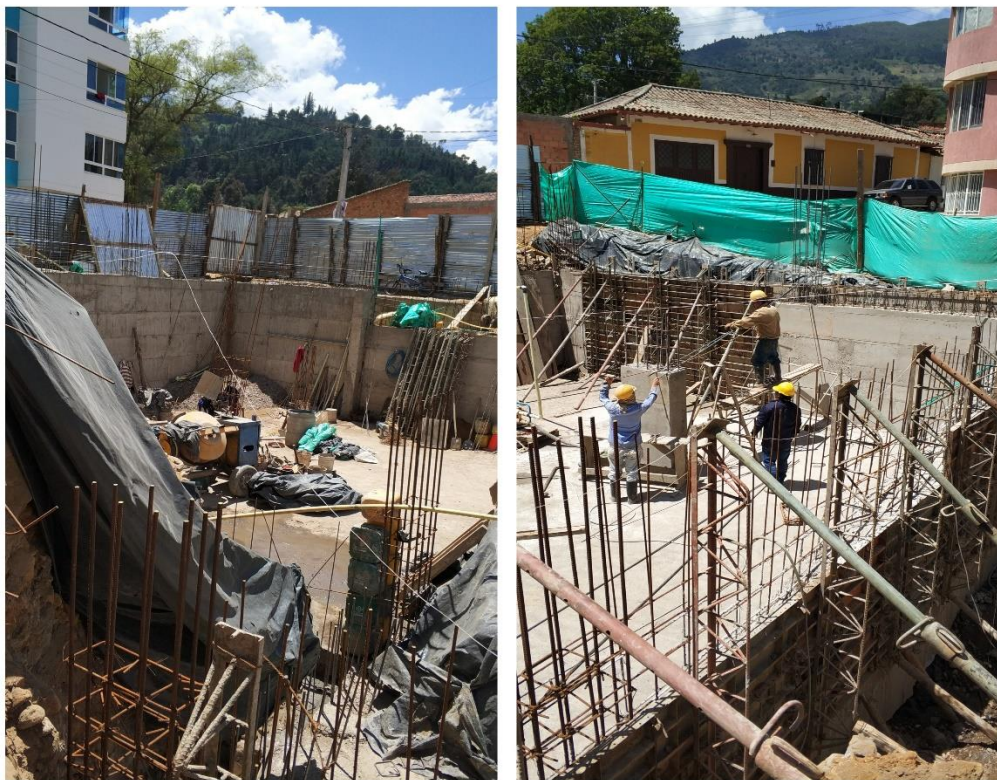
Ilustración 7 Estado de la obra al iniciar pasantías. Fuente. Autor.
