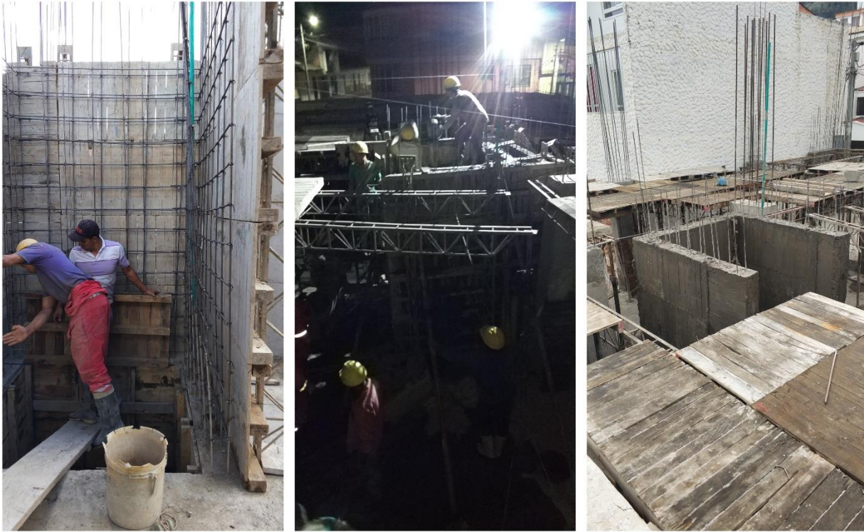
Ilustración 17 Armado de acero y confinamiento para pantallas de ascensor.
