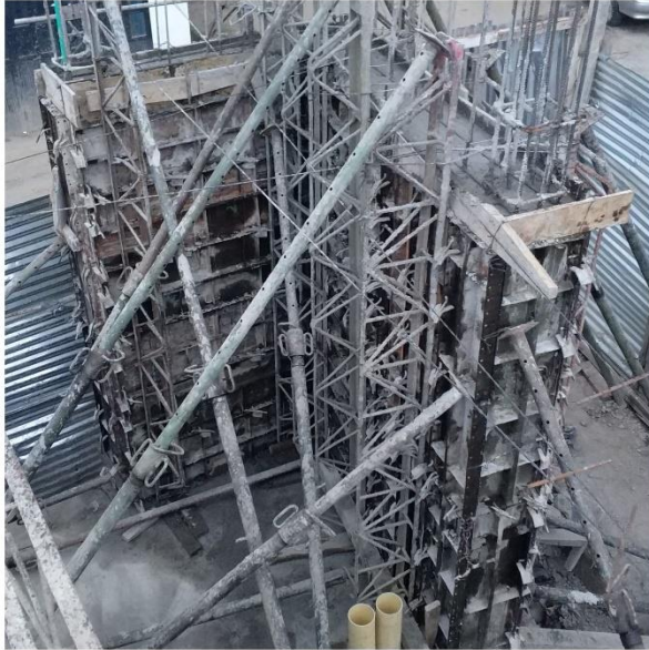
Ilustración 18 Armado de acero y formaleta para pantallas esquineras de edificio.
