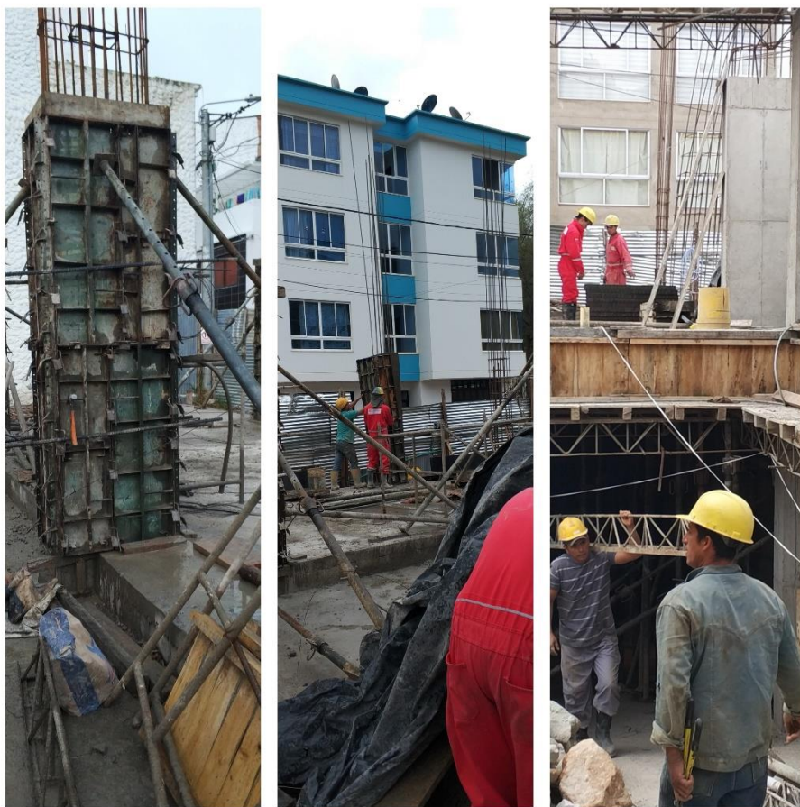
Ilustración 16 Armado y fundida de columnas de nivel 1.
