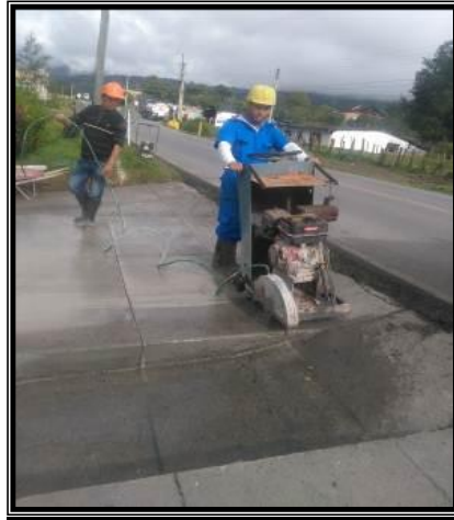
Foto 162. Corte placa en concreto
