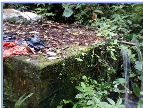
Foto 117. Tanque de almacenamiento-Alemania
