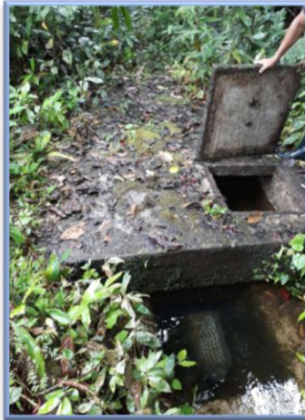
Foto 91. Desarenador- Bajo corazón
