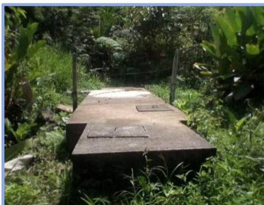
Foto 107.Desarenador Arroyo la Cristalina-Inspección Puerto Limón
