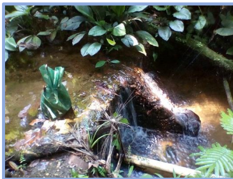
Foto 121. Bocatoma de la quebrada Sabaleta-Cabildo Indígena campo Alegre
