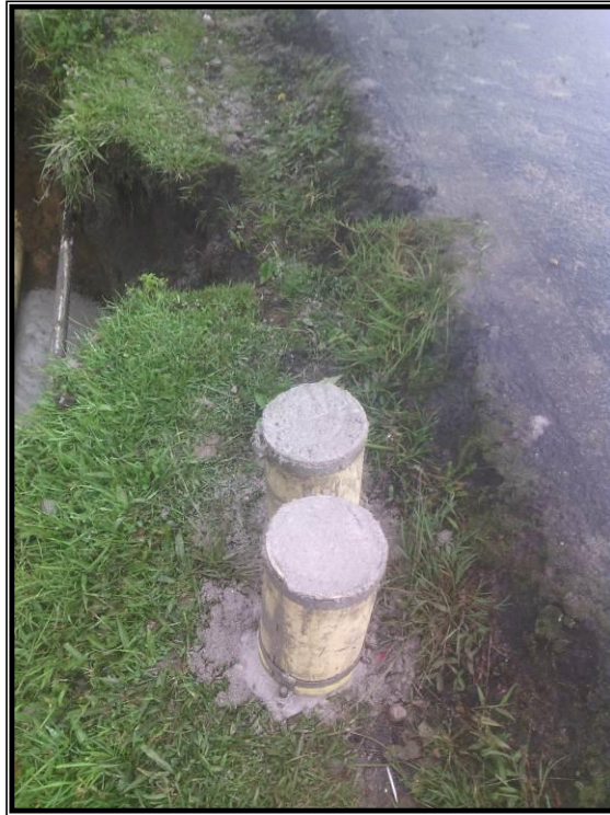
Foto 172. Cilindros para pruebas de concreto
