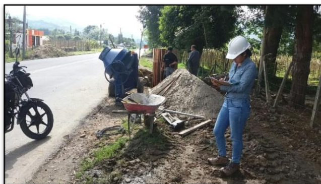
Foto 175. Encofrado cámara de Inspección
