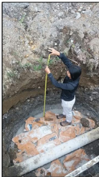
Foto 174. Cámara de inspección 2
