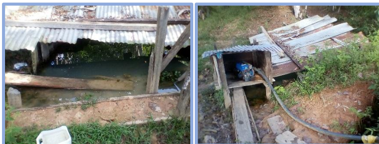
Foto 146. Pozo excavado-Inspección el gallinazo.
