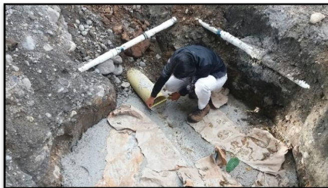
Foto 173. Cámara de inspección 1
