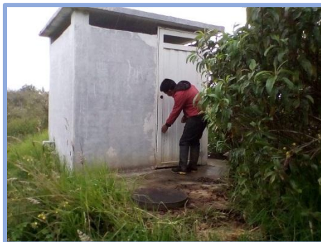
Foto 130. Tanque de almacenamiento-Wilkipamba
