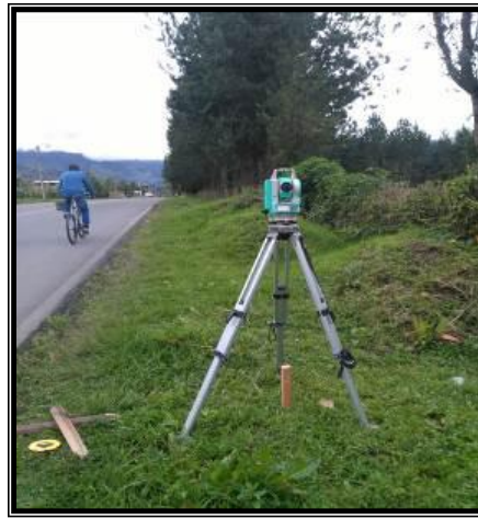
Foto 161. Localización y replanteo
