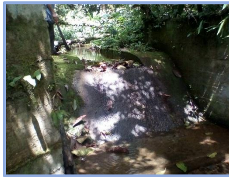
Foto 108. Bocatoma quebrada El Picudo-Inspección Puerto Limón
