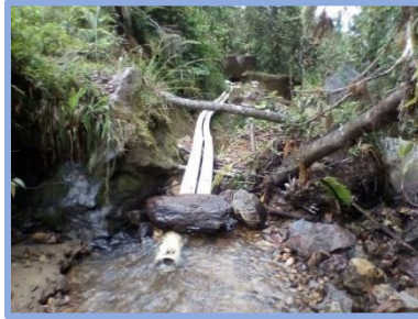
Foto 128. Bocatoma quebrada Samanoy-Wilkipamba
