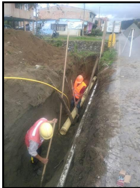
Foto 167. Instalación tubería 8"
