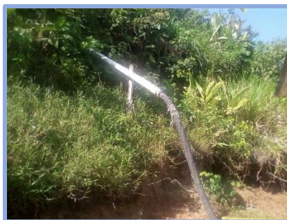
Foto 151. Tubería de aducción-José María
