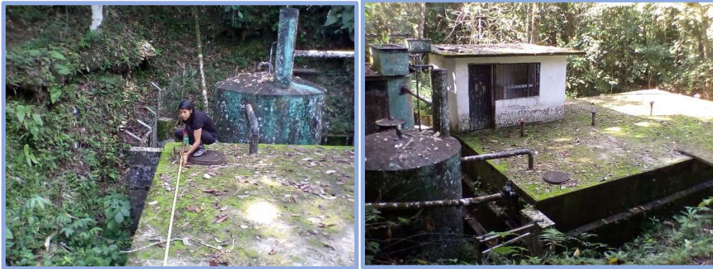
Foto 110. Tanque de almacenamiento-Inspección Puerto Limón
