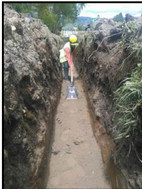
Foto 165. Relleno material seleccionado; cama de arena
