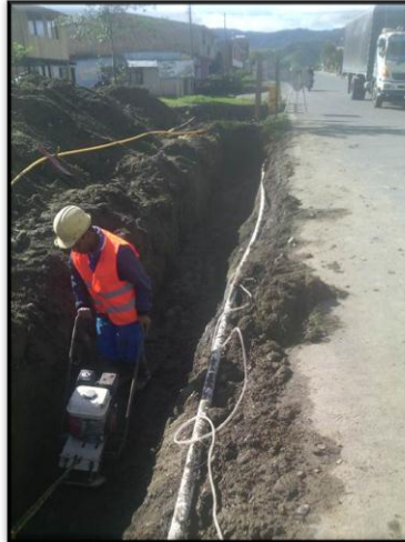
Foto 166. Relleno con material seleccionado
