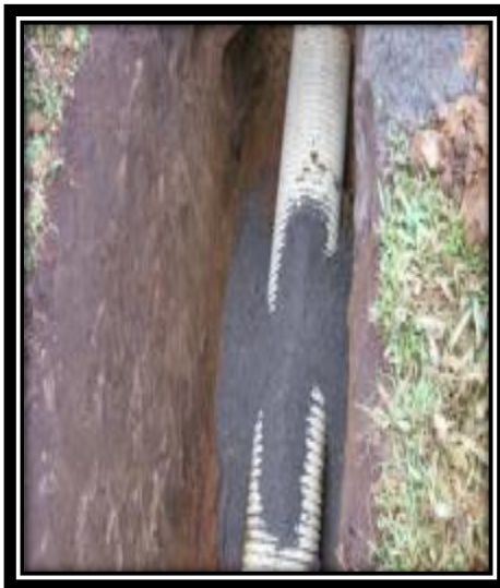
Foto 168. Relleno con material seleccionado para atraque
