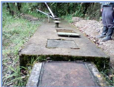
Foto 125. Desarenador-Veredas de San Francisco
