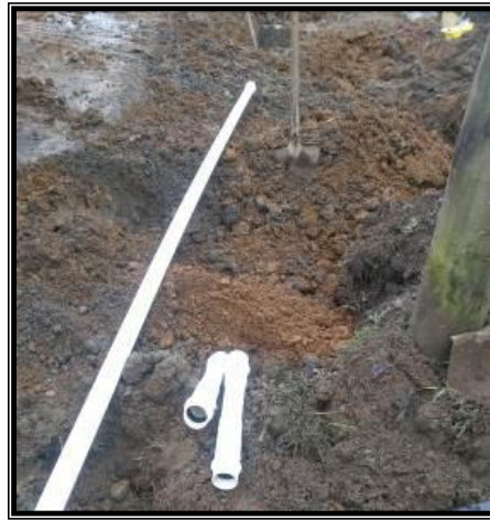
Foto 163. Reposición tubería de acueducto de 2"
