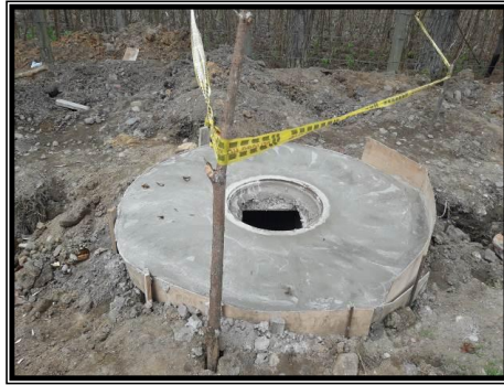
Foto 176. Cámara de inspección fundida
