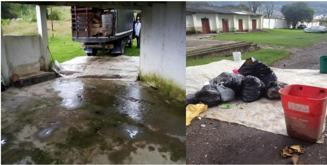
Figura 7. Área de Concreto-Plástico
