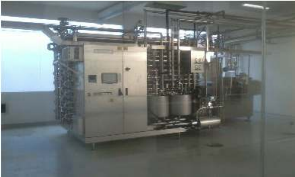
Figura 8. Planta de homogenización UHT
