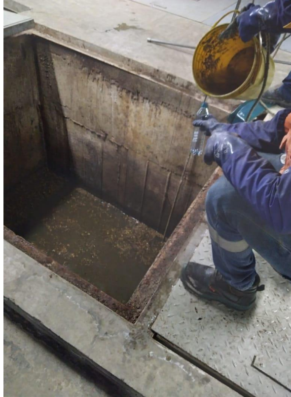
Figura A5. Fotografía de vista inferior del tanque de almacenamiento del sótano 4.
