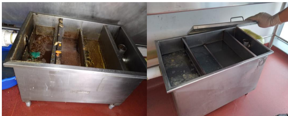
Figura A1. Fotografía de las trampas de grasas del Outsourcing Salamanca.
