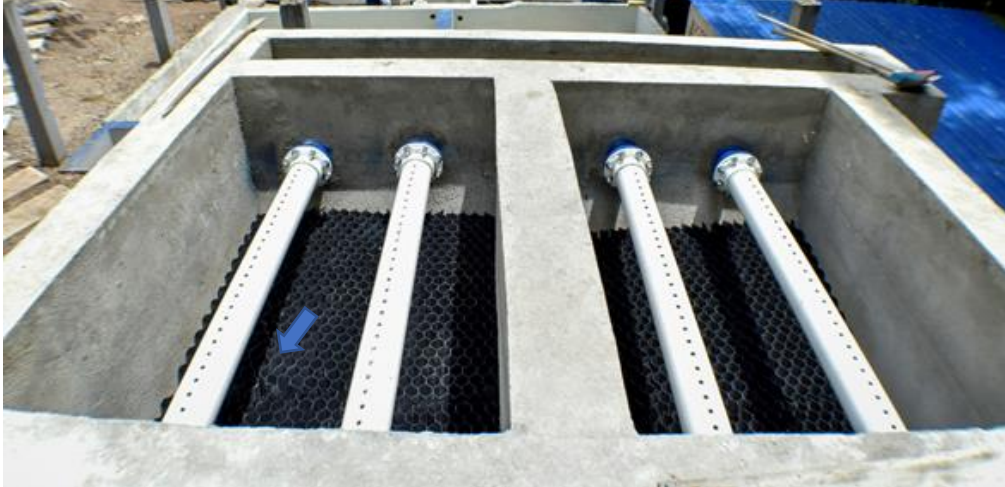
Figura 15. Sedimentador Laminar
