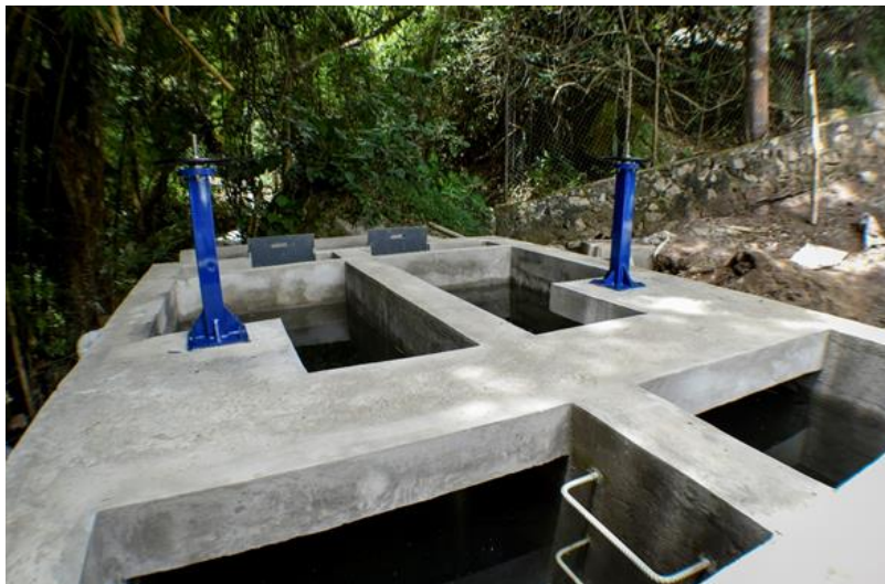
Figura 10. Estructura del Desarenador
