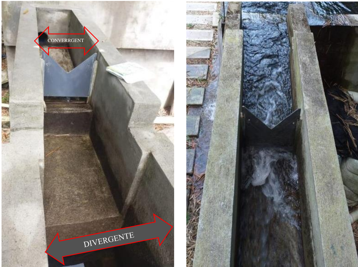
Figura 11. Tubería de Ingreso y Canaleta Parshall
