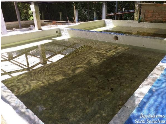
Figura 16. Filtro Rápido de Flujo Ascendente
