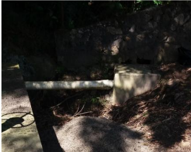
Figura 9. Canal de Ingreso al Desarenador
