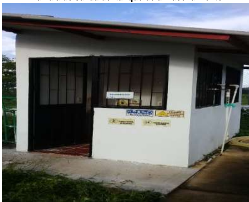
Caseta de desinfección
