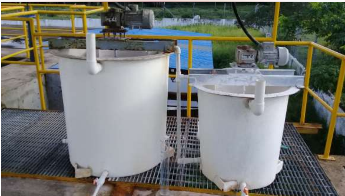
Preparación de sulfato de aluminio y cal
