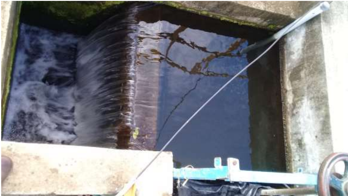
Cámara de entrada- Vertedero de excesos
