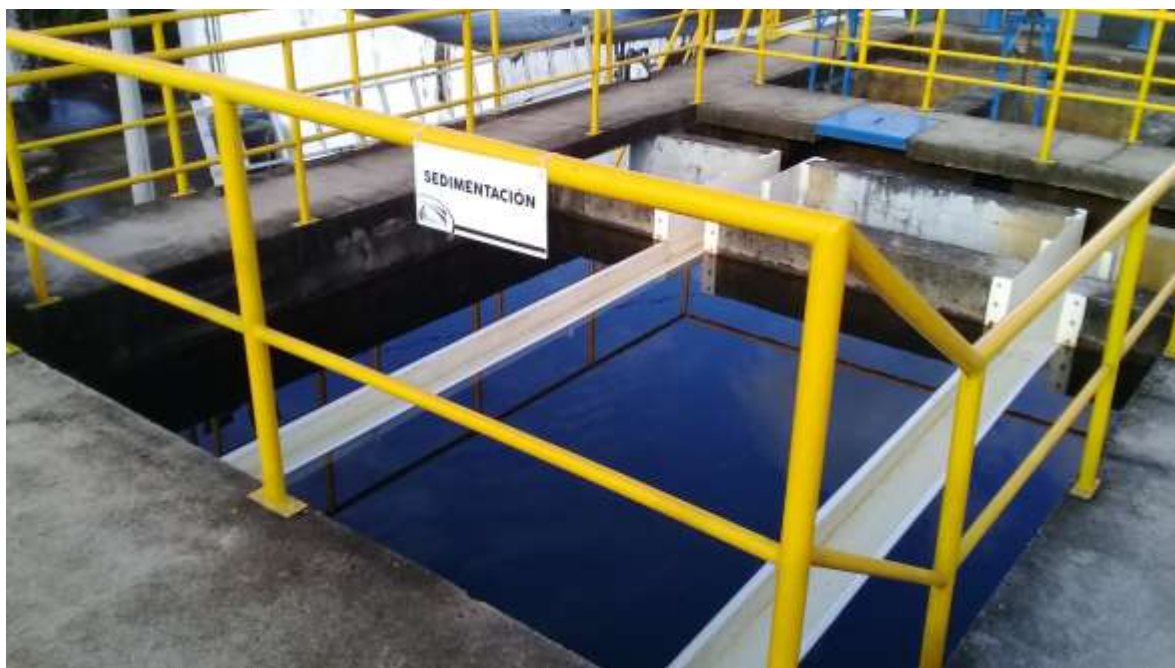
Sedimentador izquierdo
