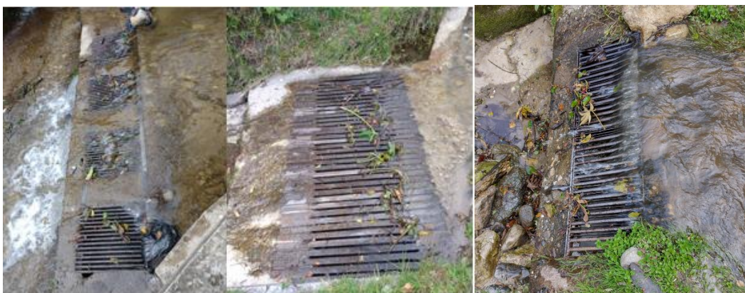
Figura 4. Estructura de la captación.
