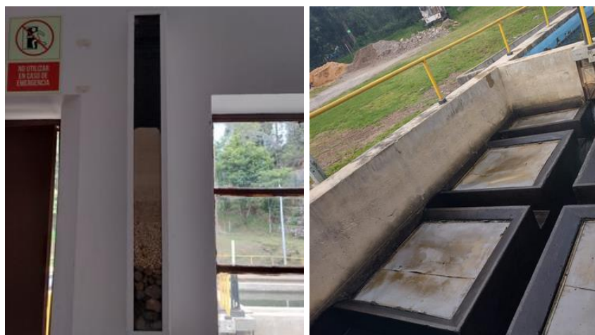
Figura 15. Material que conforman los filtros.
