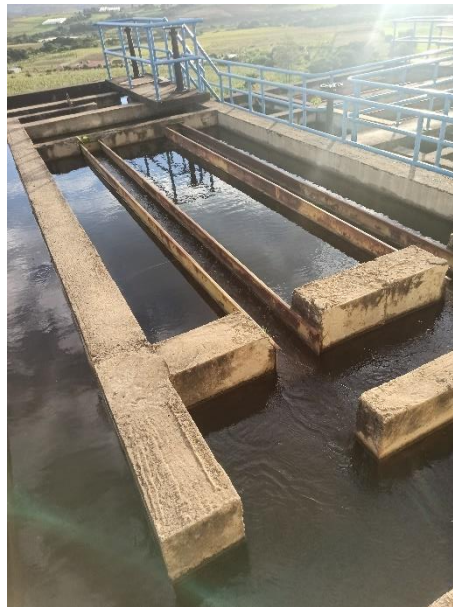
Figura 11. Unidad de pre-sedimentación planta Santa Lucía (Autor).
