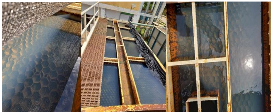
Figura 19 Unidad de sedimentación 15 días después de instalar la polisombra
