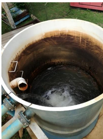
Figura 13 Estado actual del Tanque de Balance hidráulico
