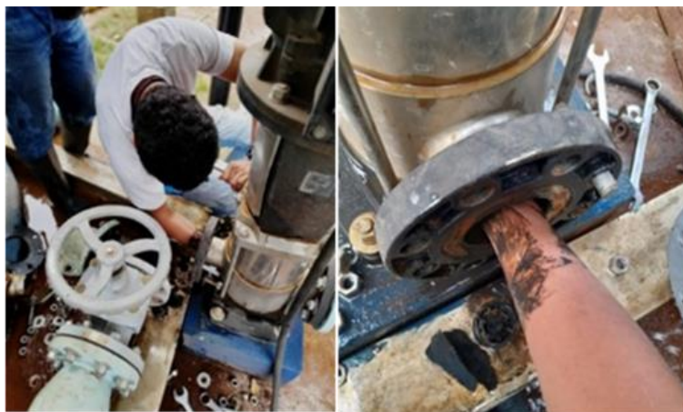
Figura 21 Mantenimiento a la unidad a la bomba del tanque de balance hidráulico.
