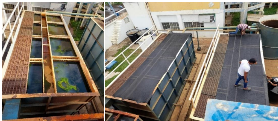
Figura 18 Polisombra en la superficie de la unidad de sedimentación para evitar la proliferación de algas
