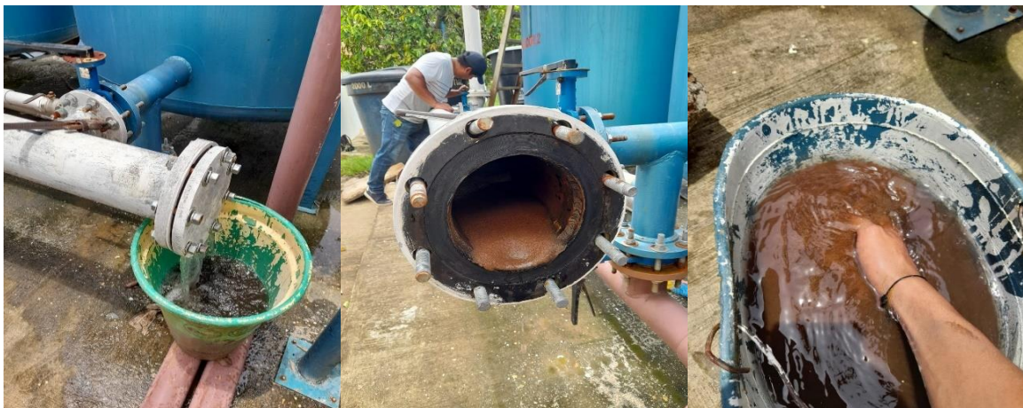
Figura 29 Limpieza de tubería que conduce al almacenamiento del agua tratada.
