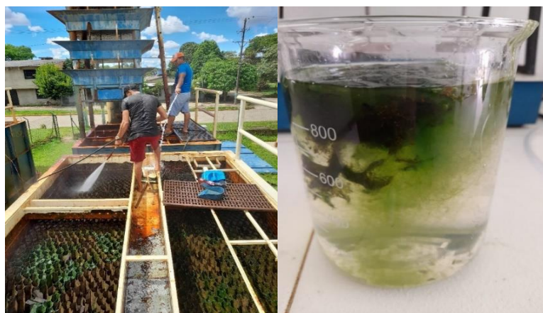
Figura 12 Proliferación de cianobacterias y algas verdes filamentosas en unidades de sedimentación.
