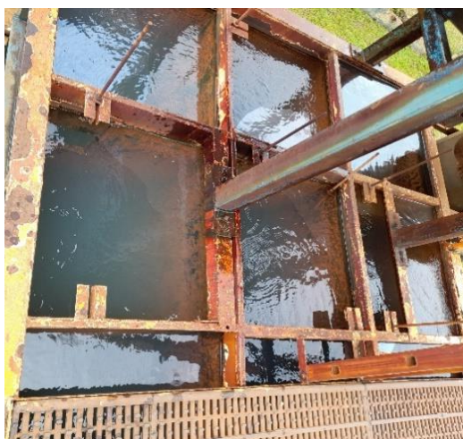
Figura 9 Floculador de flujo helicoidal
