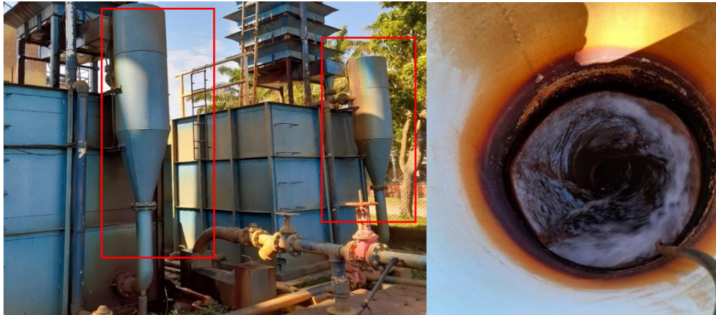
Figura 7 Conos de mezcla rápida y adición de reactivos en el tratamiento del agua
