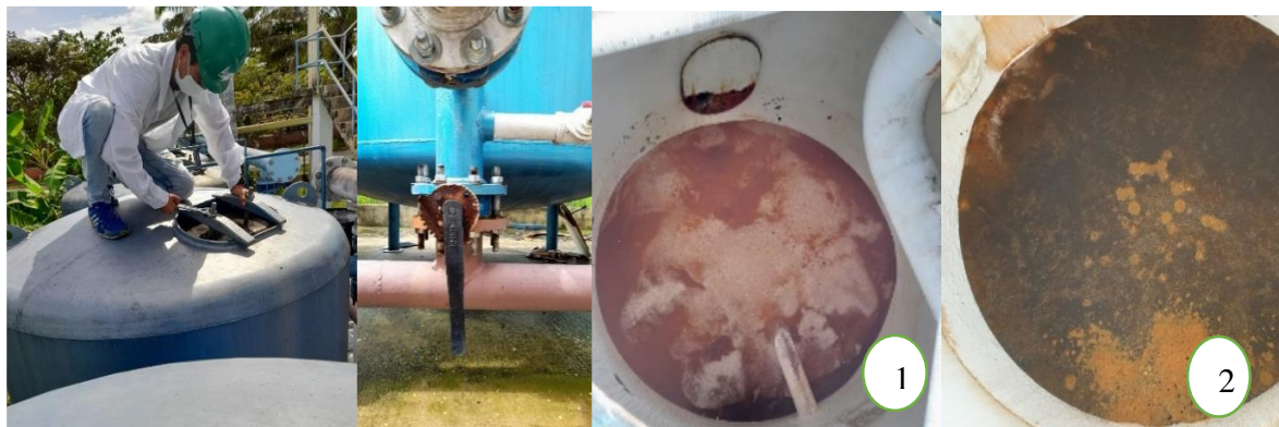
Figura 23 Desfogue controlado de la unidad
