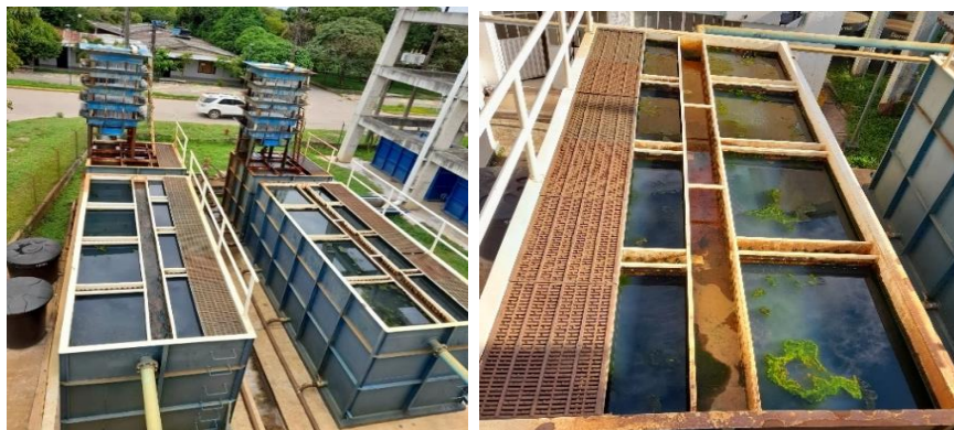
Figura 11 Vista superior de unidades de sedimentación
