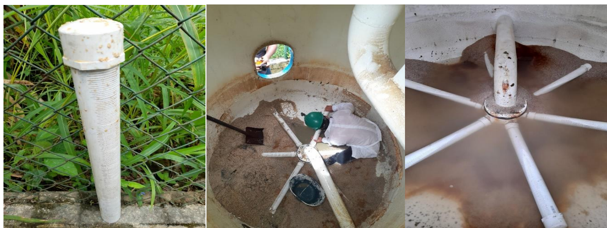
Figura 26 Fuga subsanada del intercambiador iónico 1
