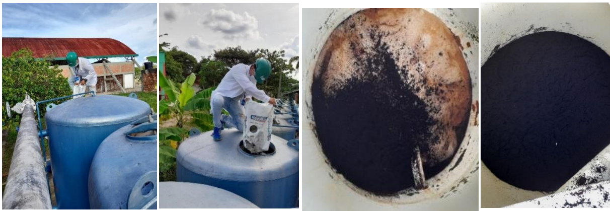
Figura 33 Llenado de cada uno de los tanques con la nueva resina catiónica
