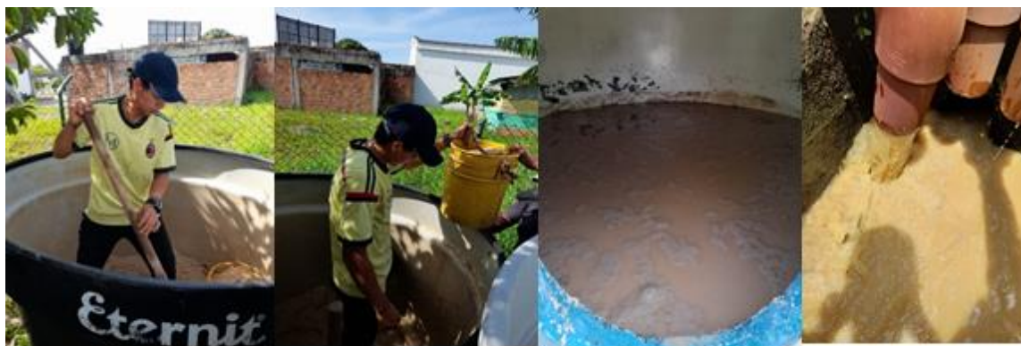
Figura 30 Llenado de la unidad de intercambio iónico
