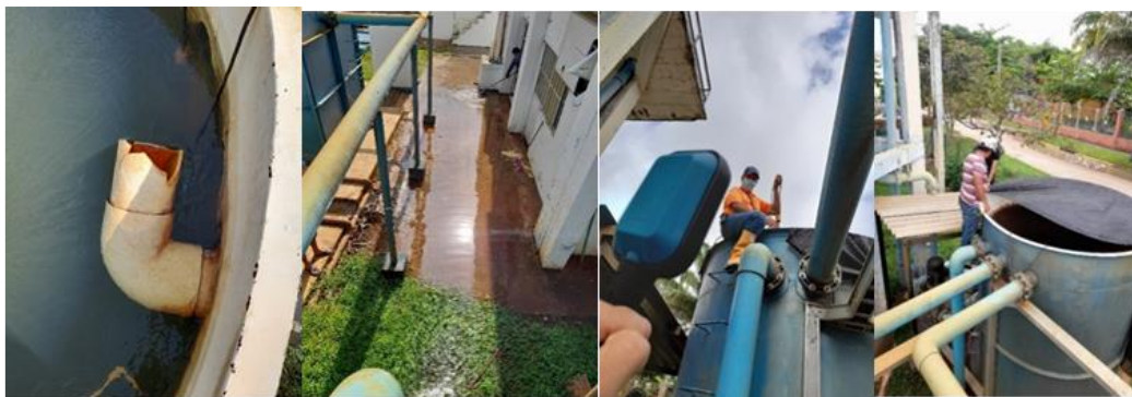
Figura 20 Controlador de nivel y polisombra para la unidad del tanque de balance hidráulico.
