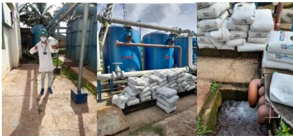
Figura 32 Acondicionamiento de la unidad para adicionar la resina.
